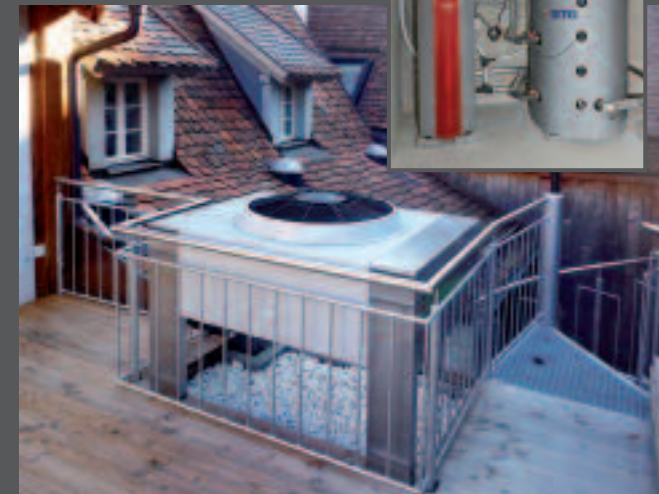
Splitverdampfer einer Luft-Wasser-Wärmepumpe
