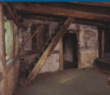
Die Diele im Obergeschoss, 2004 Der Wandschrank von 1475 wurde später von einer Treppe ins Dachgeschoss verdeckt. Der Wandputz mit den Malschichten aus der Bauzeit wurde bereits von einem Restaurator gesichert.
