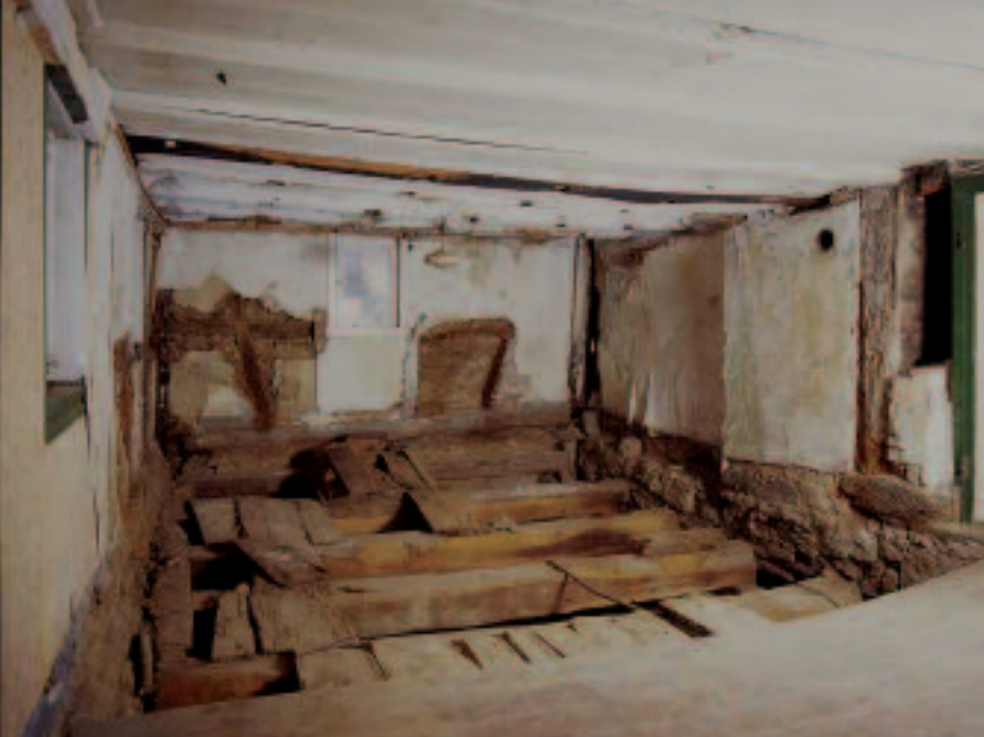
Blick in Stube und Kammer bei Beginn des Umbaus, 2004 Im Vordergrund ist die mit Brettern verkleidete Decke der Stube zu sehen. Ein neuerer Fußboden wurde zum Teil entfernt und zeigt die handgebeilten Fußbodenbretter und Deckenbalken von 1457/58.
