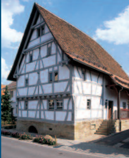
Firstständerhaus von Norden, 2008 Das Firstständerhaus nach der Sanierung. Wieder hergestellt wurde der Schwebgiebel der Erbauungszeit. Wegen der Straße musste der Kellerabgang von 1781 zu einem Fenster vermauert werden.
