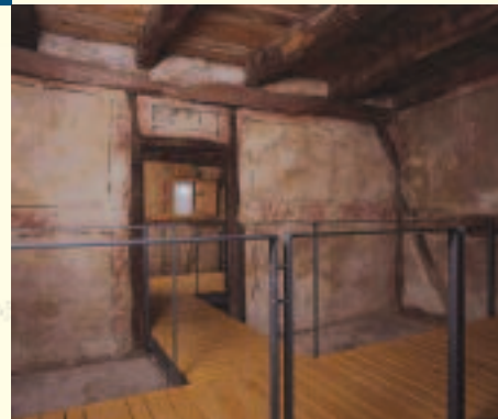
Kammer im Oberge- schoss, 2008 Die Kammer wurde 1671 mit einer Fachwerkbe- malung versehen. Gut zu erkennen sind die imitier- ten Balken, die auf den Putz gemalt wurden. Ein Steg stabilisiert das Gebäude, reduziert die Besucherzahl und schont den empfindlichen Fußboden.
