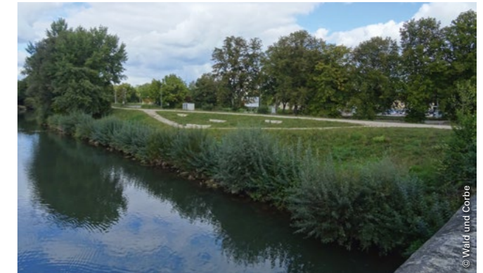
Hochwasserschutzmauer links des Neckars in Wendlingen/Neckar
