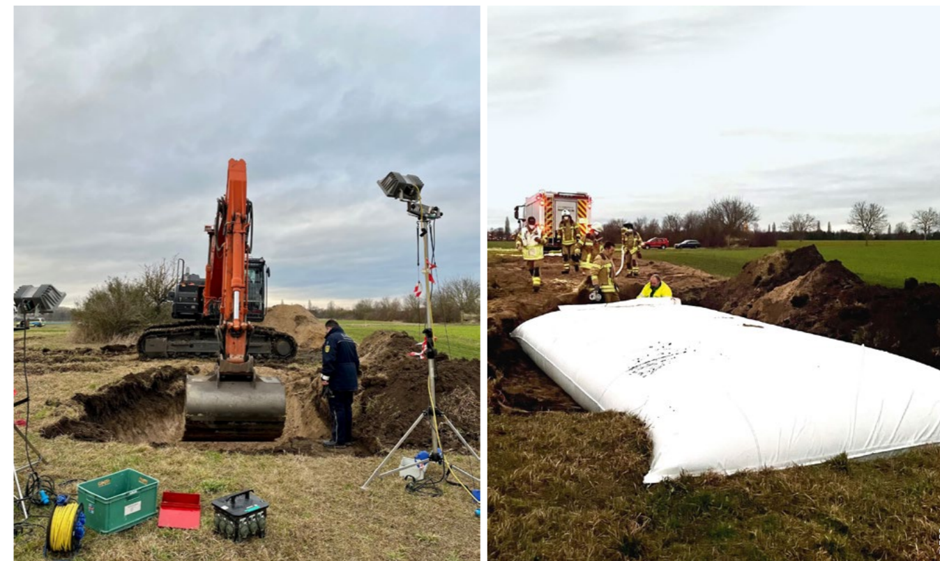
Die Arbeiten für eine sichere Sprengung der amerikanischen Fliegerbombe brauchen Know-how und gingen Hand in Hand
