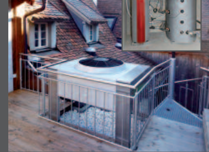
Splitverdampfer einer Luft-Wasser-Wärmepumpe
