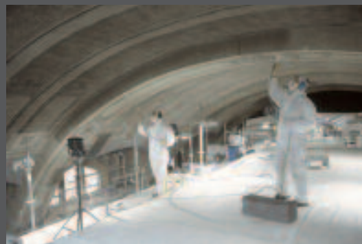
Hockenheim, Stadtkirche St. Georg, Innengerüst mit Abdeckung während der Reinigung der Raumfassung
