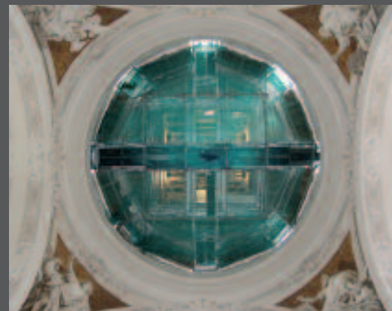
Weingarten, Basilika, Brückengerüst in der Kuppel zur weiteren Nutzung des Kircheninnenraums
