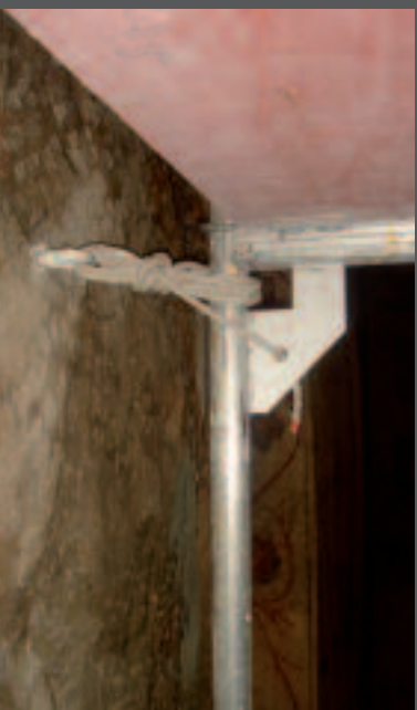
Unsachgemäße Verankerung eines Innengerüsts in den gotischen Wandmalereien
