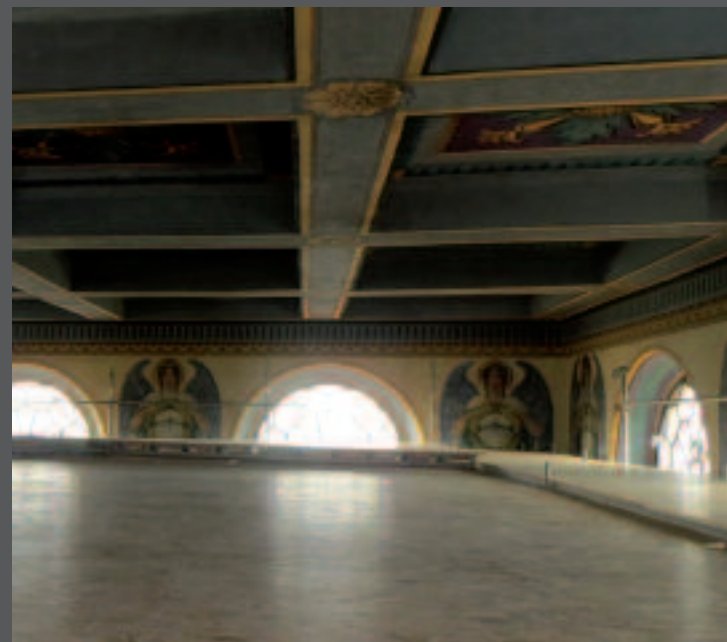
Pforzheim, Hauptfriedhof, Aussegnungshalle, Gerüstplattform mit OSB-Platten
