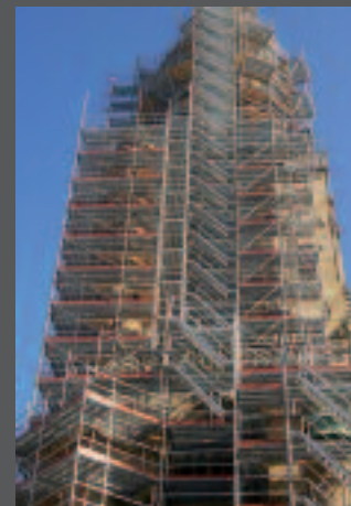
Heilbronn, St. Kilian, Außengerüst
