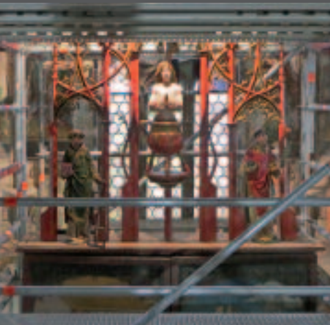
Stuttgart-Mühlhausen, St. Veit, Gerüstbau am Hochaltar
