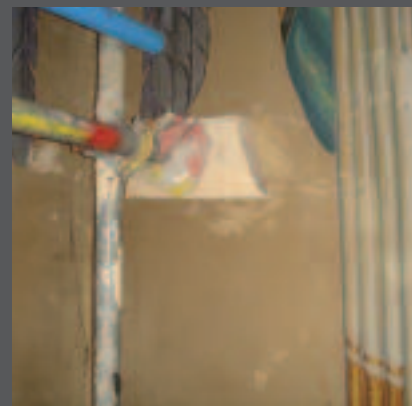
Unsachgemäße Abpolsterung eines Gerüsts an hochempfindlichen Wandmalereien
