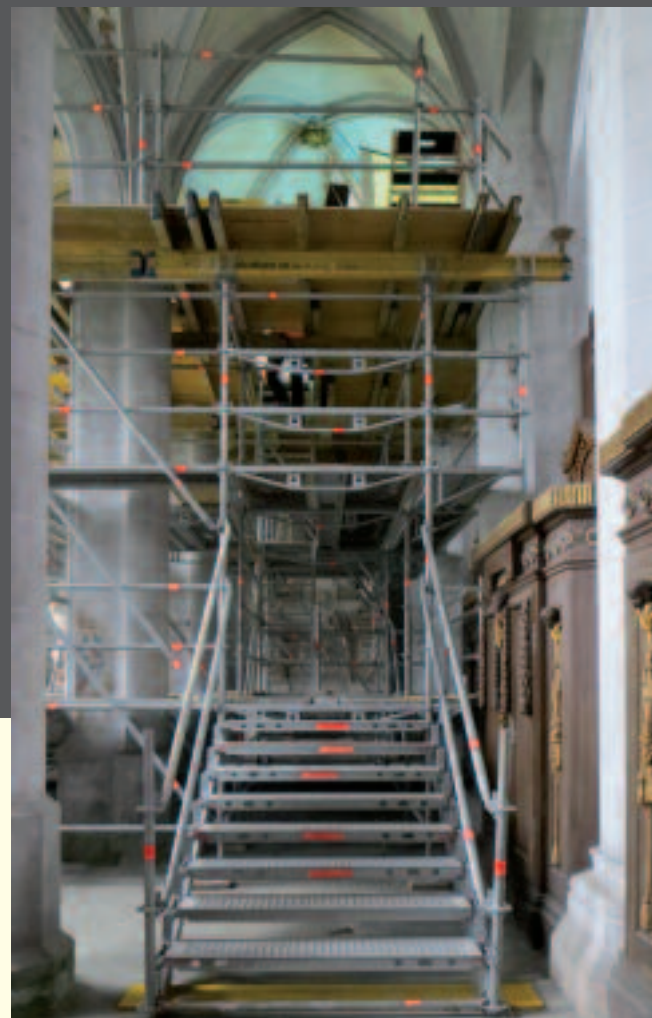
Salem, Münster, Gerüstaufgang
