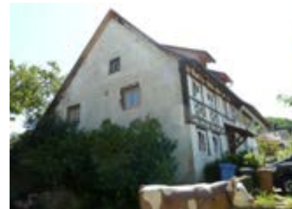
Nordwestansicht des ehemaligen Wohnteils
