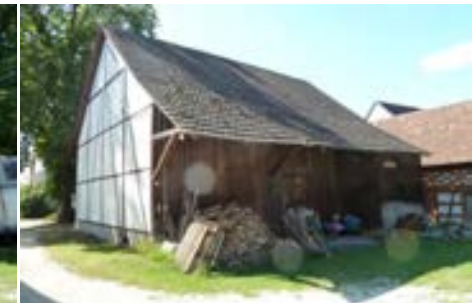
Südostansicht der Scheune
