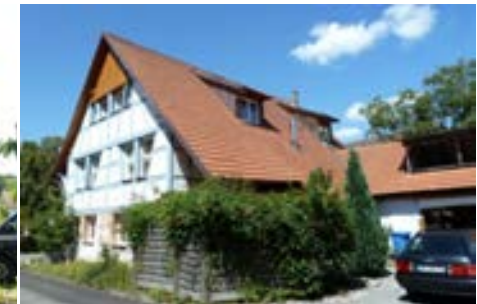
Südostansicht des ehemaligen Stallteils
