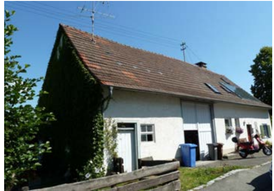
Südwestansicht mit Ökonomieteil links und Wohnteil rechts
