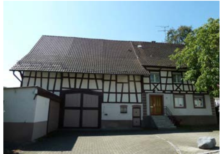
Nordansicht mit Ökonomieteil links und Wohnteil rechts
