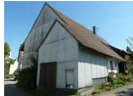
Nordwestansicht mit rückwärtigem Anbau
