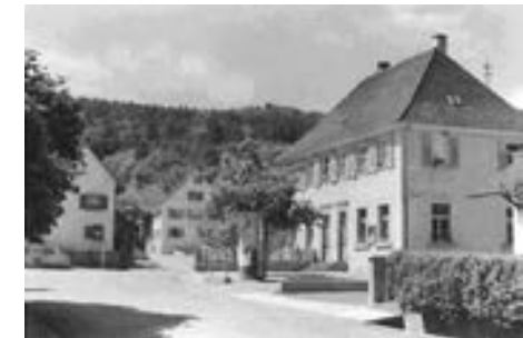
Nordostansicht vor dem Umbau 1960
