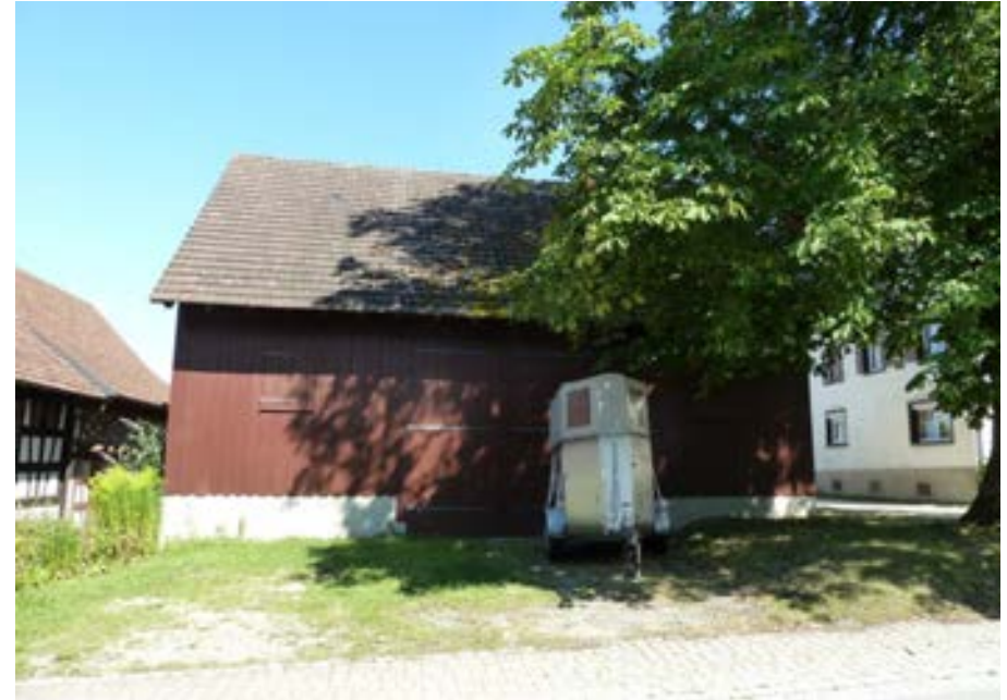
Westansicht der Scheune mit mittig angeordnetem, zweiflügeligem Holztor
