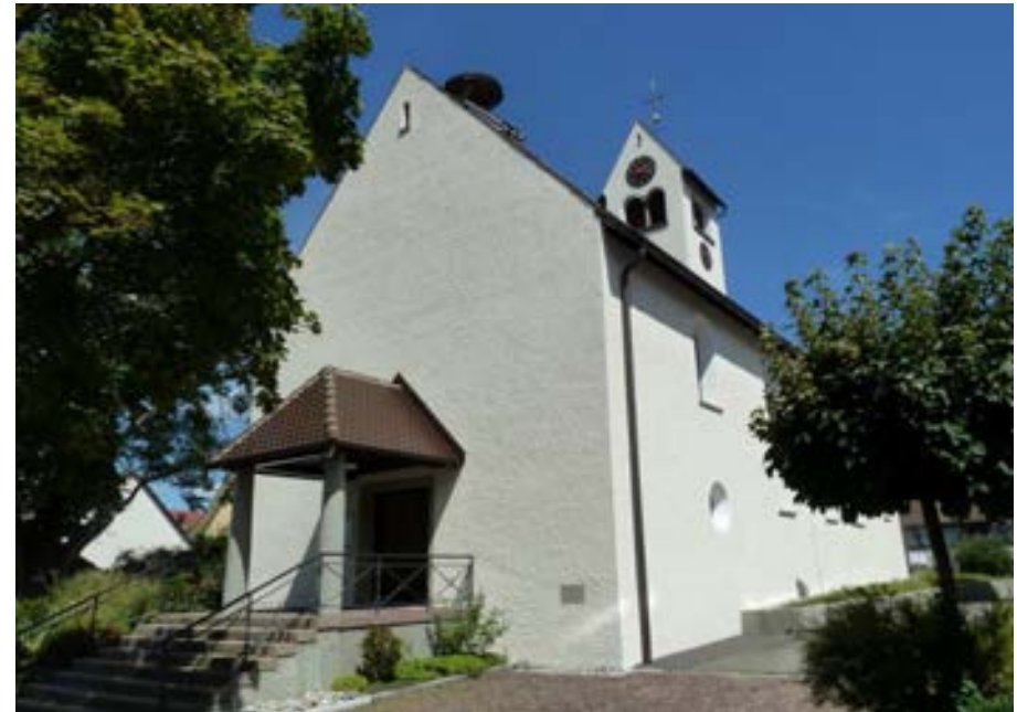
Südwestansicht der Kirche
