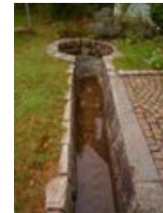
Vor der Schienerbergstraße 24 ist der Bachlauf noch sichtbar, danach verläuft er unterirdisch
