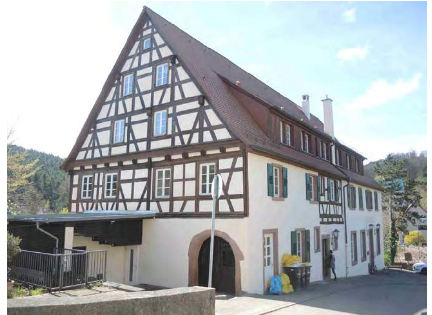
Ansicht des Gasthauses von Nordosten
