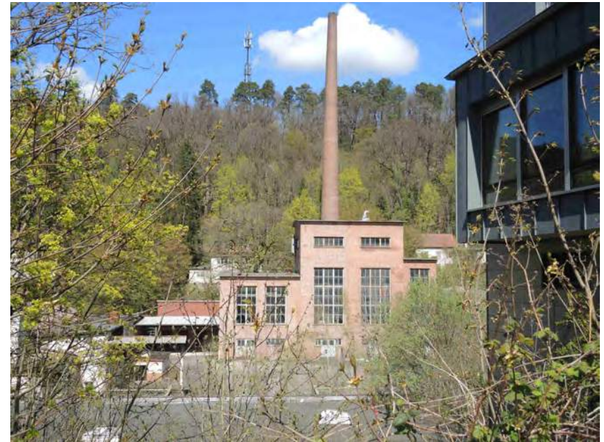
Ansicht der ehemaligen Papierfabrik von Süden (Blick auf das Neue Kesselhaus)
