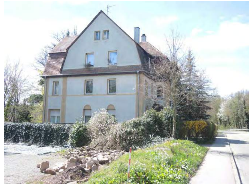
Ansicht des Wohnhauses von Nordosten
