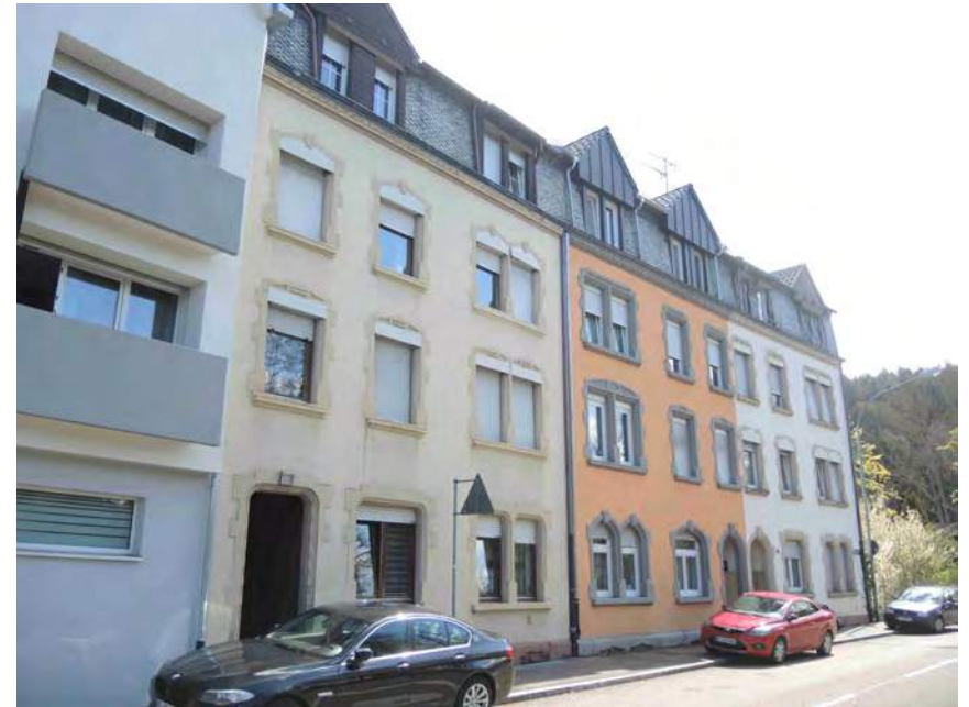
Ansicht des Reihenwohnhauses von Nordwesten
