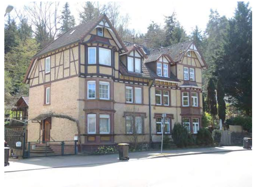
Ansicht des Doppelwohnhauses von Norden
