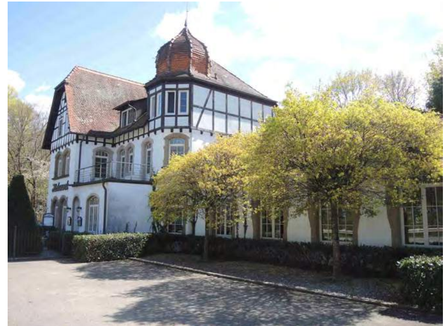
Ansicht des Gasthauses von Nordwesten
