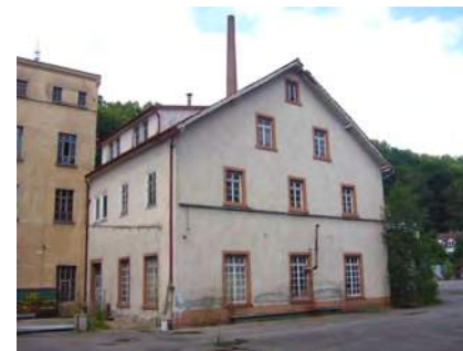
Ansicht des alten Kesselhauses
