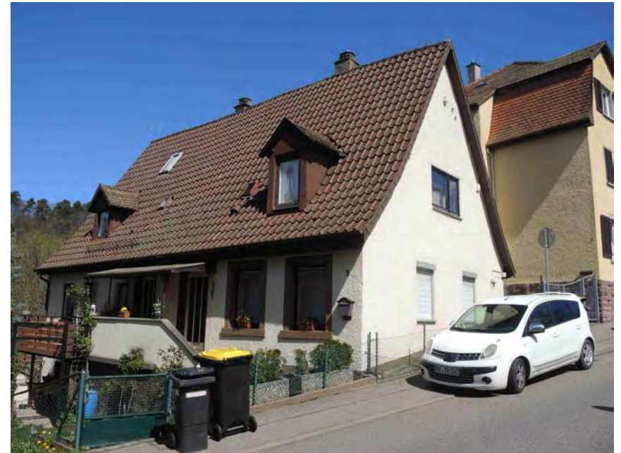
Ansicht des Doppelwohnhauses von Südwesten
