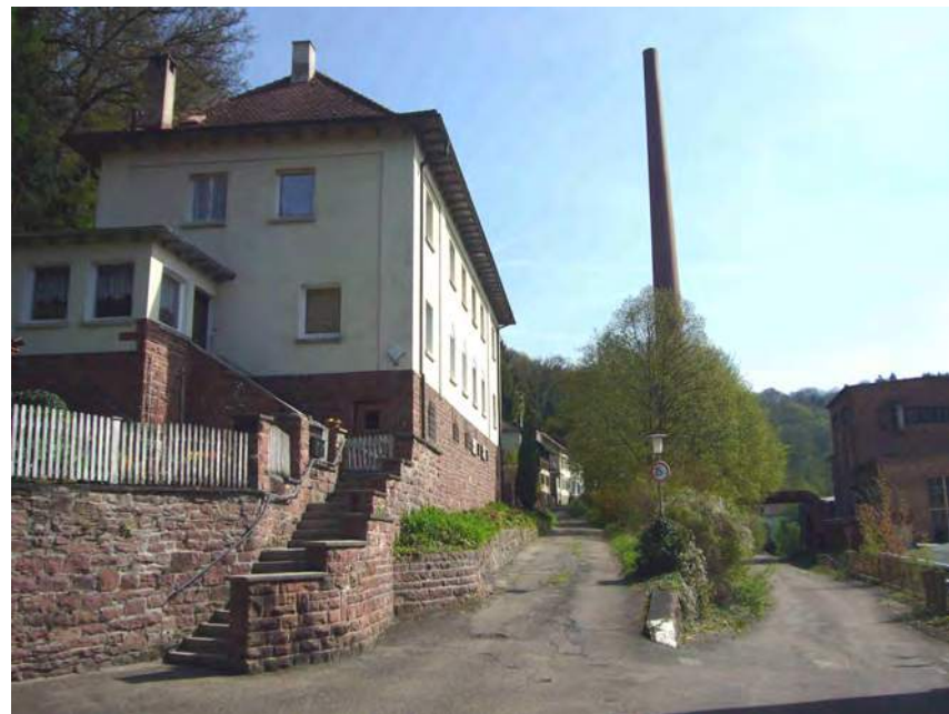
Ansicht des Doppelwohnhauses 221/223 von Südwesten
