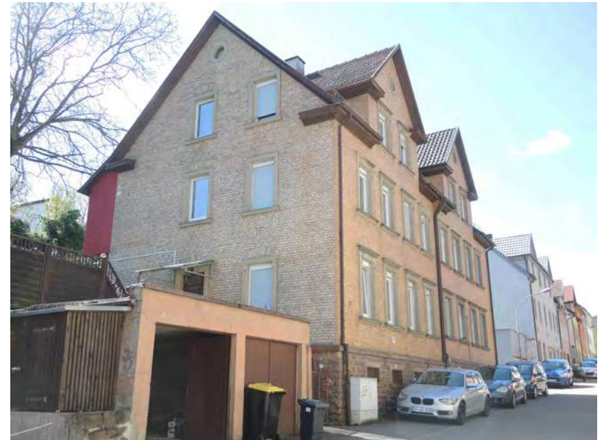
Ansicht des Doppelwohnhauses von Nordosten
