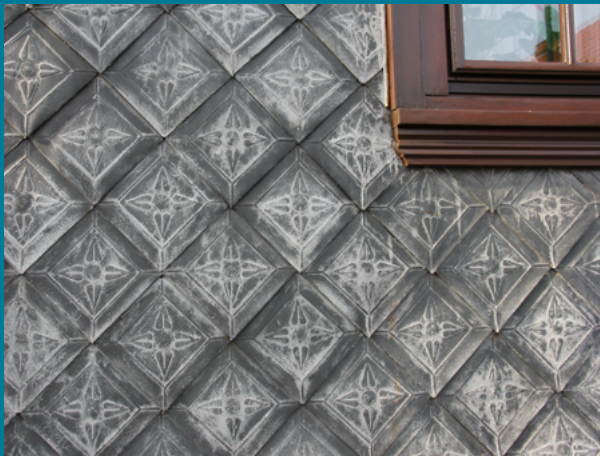
oben: Großburschla: historischer Blechbehang rechts: Altenburschla: Evangelische Kirche am Anger
