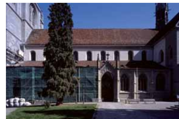
3a Konstanz, Münster. Ansicht von Süden. Das aus dem 11. Jahrhundert stammende Langhaus erhielt 1238/39 einen neuen Dachstuhl, für den die bis heute hier verlegten großformatigen Rechteckschnitte angefertigt wurden. Die Ziegel auf der Südseite sind mit einer transparenten, leicht gelblichen Bleiglasur versehen, die dem Dach einen goldbraunen Glanz verleihen.
