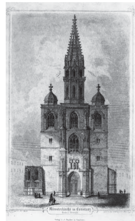
3 Die Abbildung zeigt die Westfassade des Münsters um 1853 kurz vor Abbruch der Hauben durch Heinrich Hübsch um 1855/1856 (a) und Aufbau der je vier großen und kleinen Fialen als optische Überleitung auf den hohen Mittelurm.
