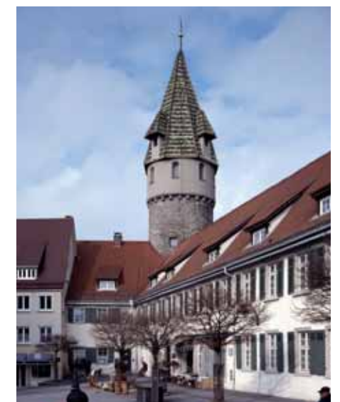
4 Ravensburg, Grüner Turm, Ansicht von Osten. Zustand nach der Sanierung der Dachhaut.
