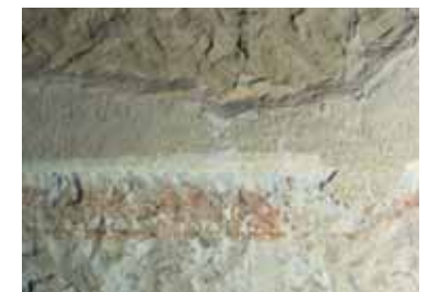
5 Nahtstelle von grauem Verputz über einem aufgemalten braunroten Band.
