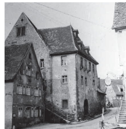
5 Fotografie um 1950 von E.Meyer. Zu erkennen sind noch Gaupen und die Natursteinfassade mit den profilierten Fensteröffnungen im Osten des Gebäudes
