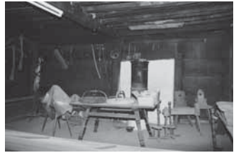
9 Veringenstadt, Rathaus. Innenansicht der kleinen Bohlenstube im zweiten Obergeschoss, Blick nach Süden. Innerhalb der geschlossenen Bohlenwand ist ein Wandfeld als Feuerungswand für einen Hinterladerofen ausgemauert.
