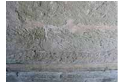
3 Im unteren Bereich Abarbeitung des Sockels mit Spitz Eisen. Oben die Überarbeitung mit dem groben Zahneisen.
