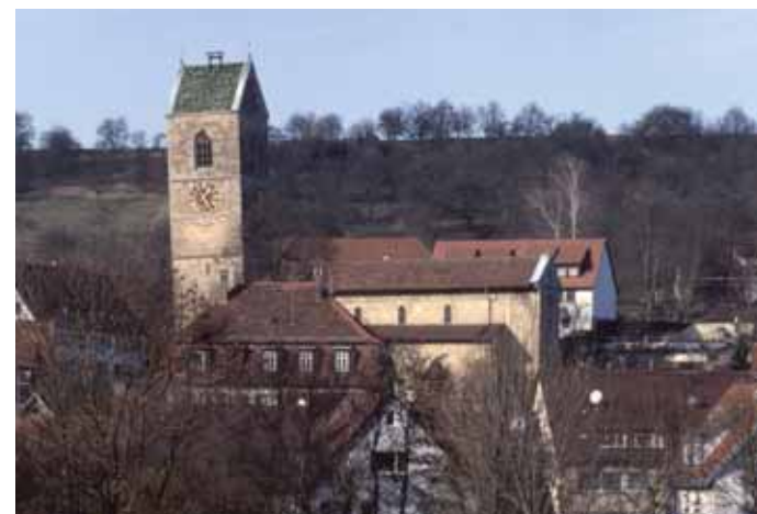
1 Neckartailfingen, Ansicht von Süden. Auf dem Dach des Mittelschiffs sind noch die großformatigen mittelalterlichen Dachziegel verlegt. Das zugehörige Dachwerk ist dendrochronologisch auf das Jahr 1111 datiert.
