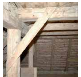
11 Verblattete Kopfbänder im Dach
