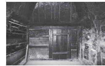
8 Veringenstadt, Rathaus. Heiz- und späterer Küchenraum mit großem Rauchfang im zweiten Obergeschoss, Blick nach Osten. Durch die Ostwand (Mitte) wurde der Küchenraum nachträglich vom Flur abgetrennt. Links Bohlenwand der kleinen Stube, rechts ausgemauerte Feuerungswand der großen Bohlenstube.
