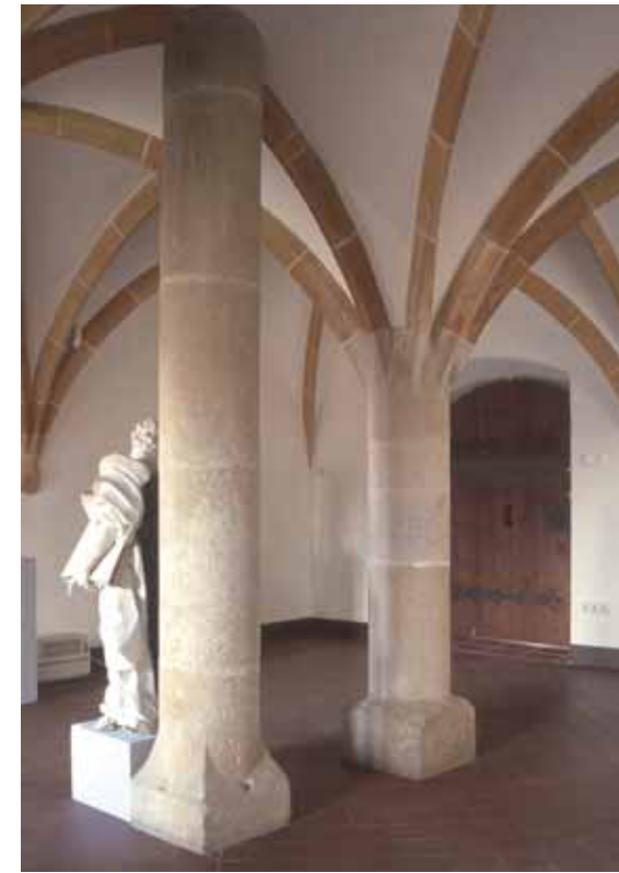
2 Riedlingen, Wochenmarkt 3. Erdgeschoss, Blick in das Innere des so genannten Refektoriums mit seinem spätgotischen Kreuzrippengewölbe. Die vordere Steinsäule wurde nachträglich zur Unterstützung des mittelalterlichen Deckengebälkes eingezogen.
