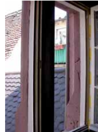
5 Gotisches Fenstergewände von 1435; als Baumaterial ein wieder verwendeter Grabstein (Buchstabe „R“ und Wappen).
