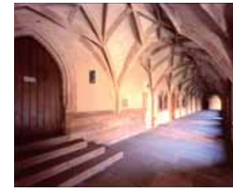
4 Alpirsbach, Blick in den Ostflügel des Kreuzgangs. Die Dienste und Rippenanfänger wurden mit der Kreuzgangaußenwand versetzt, jene der Binnenwand erst kurz vor der Ausführung der Gewölbe. Letztere wurden nach einer Planänderung höher angebracht, so dass der Kreuzgangflügel einen asymmetrischen Querschnitt erhielt. Die Planänderung dürfte in Problemen mit dem Baugrund begründet sein.
