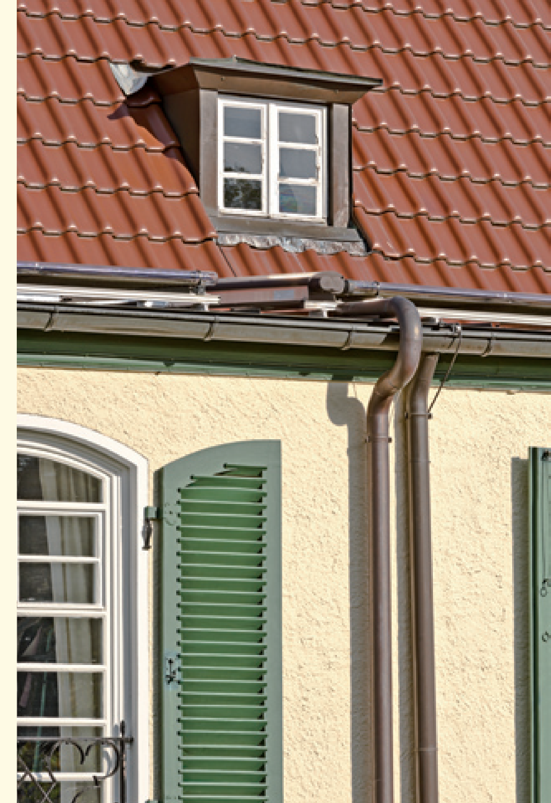
Installationsführung in einem „Schein“-Fallrohr
