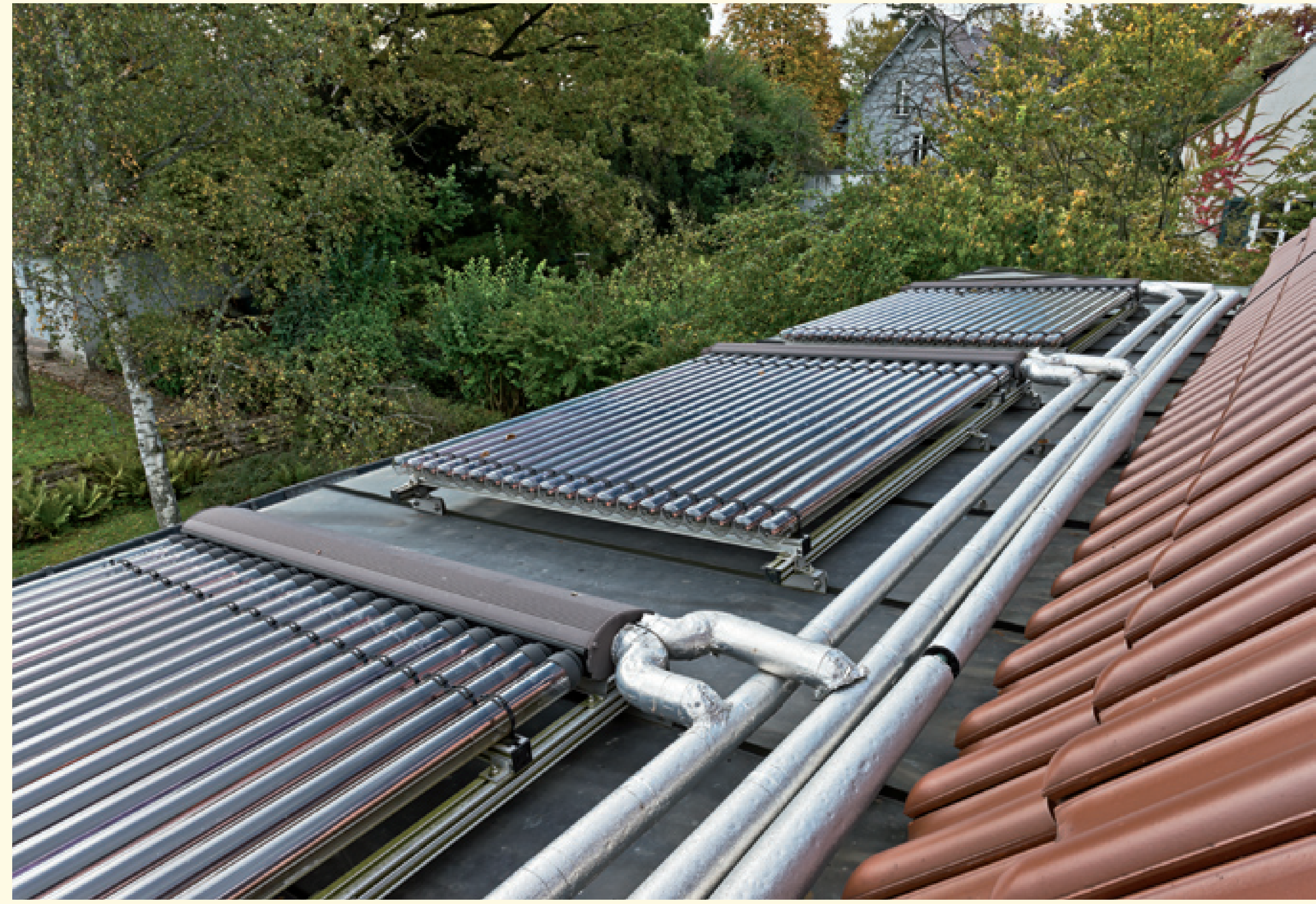
Blick auf das südlich angeschleppte Flachdach mit der Kollektoranlage
