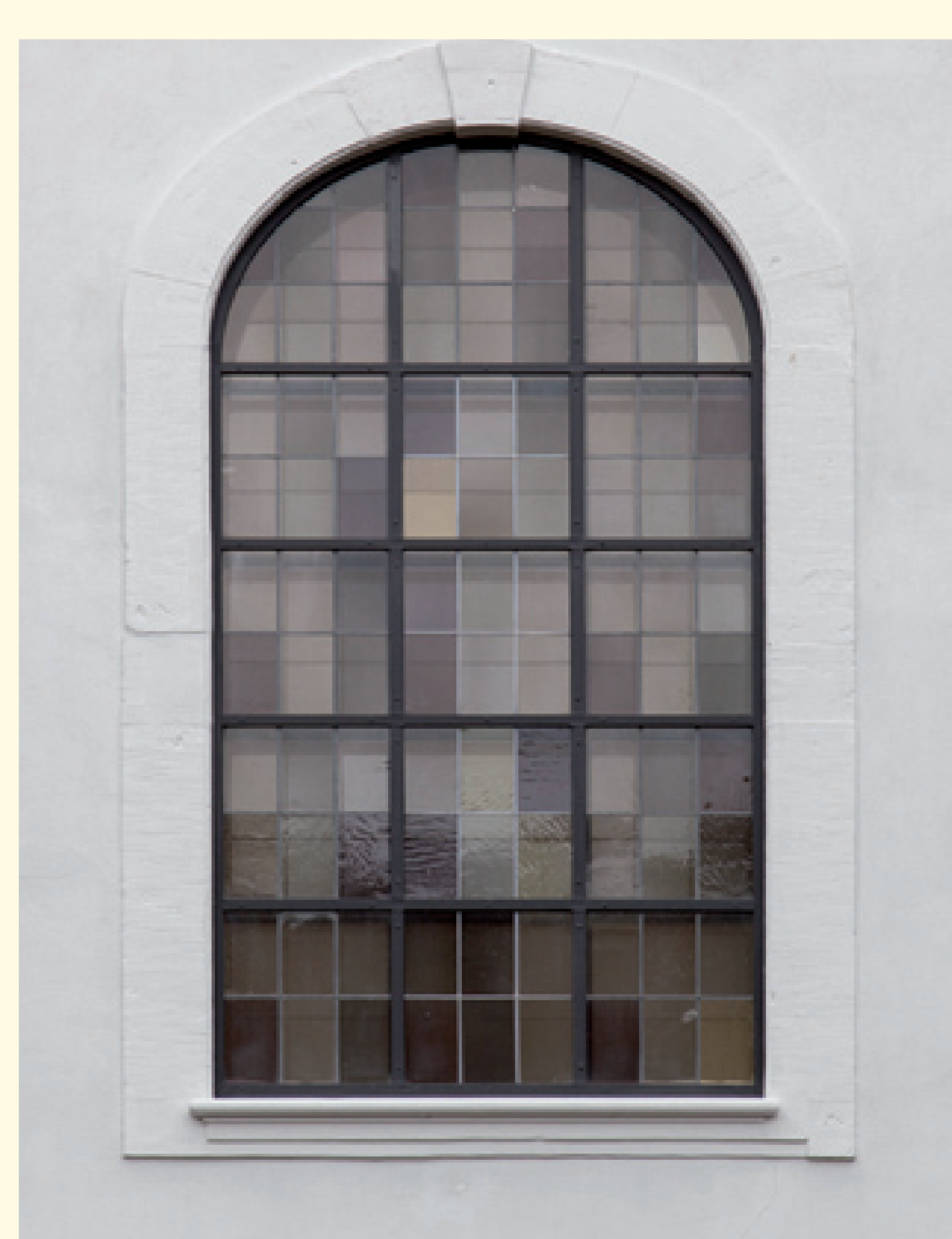
Luftkollektoren in den Kirchenfenstern
