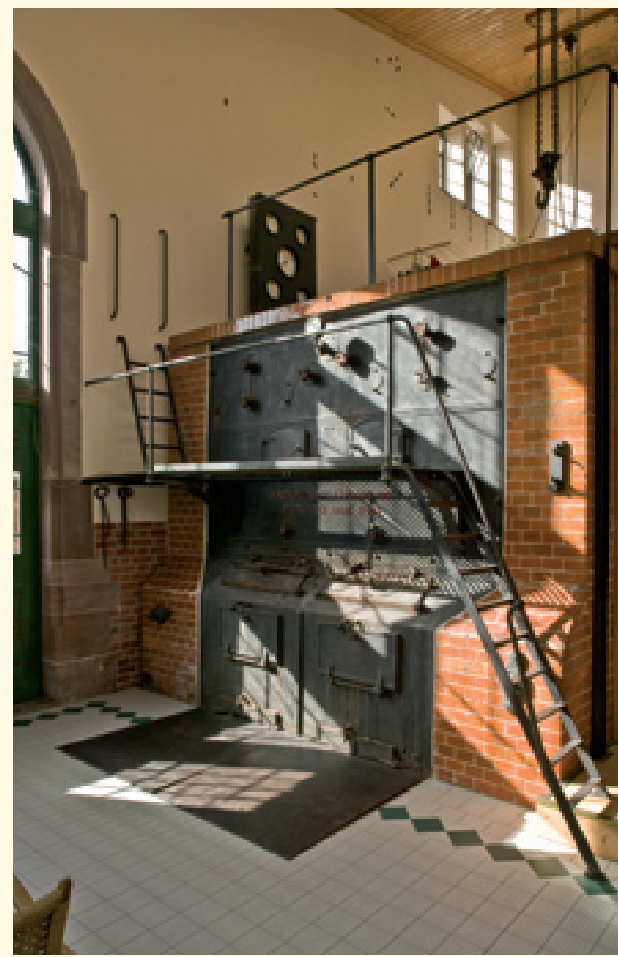
Bauzeitlicher Brennkessel nach der Restaurierung
