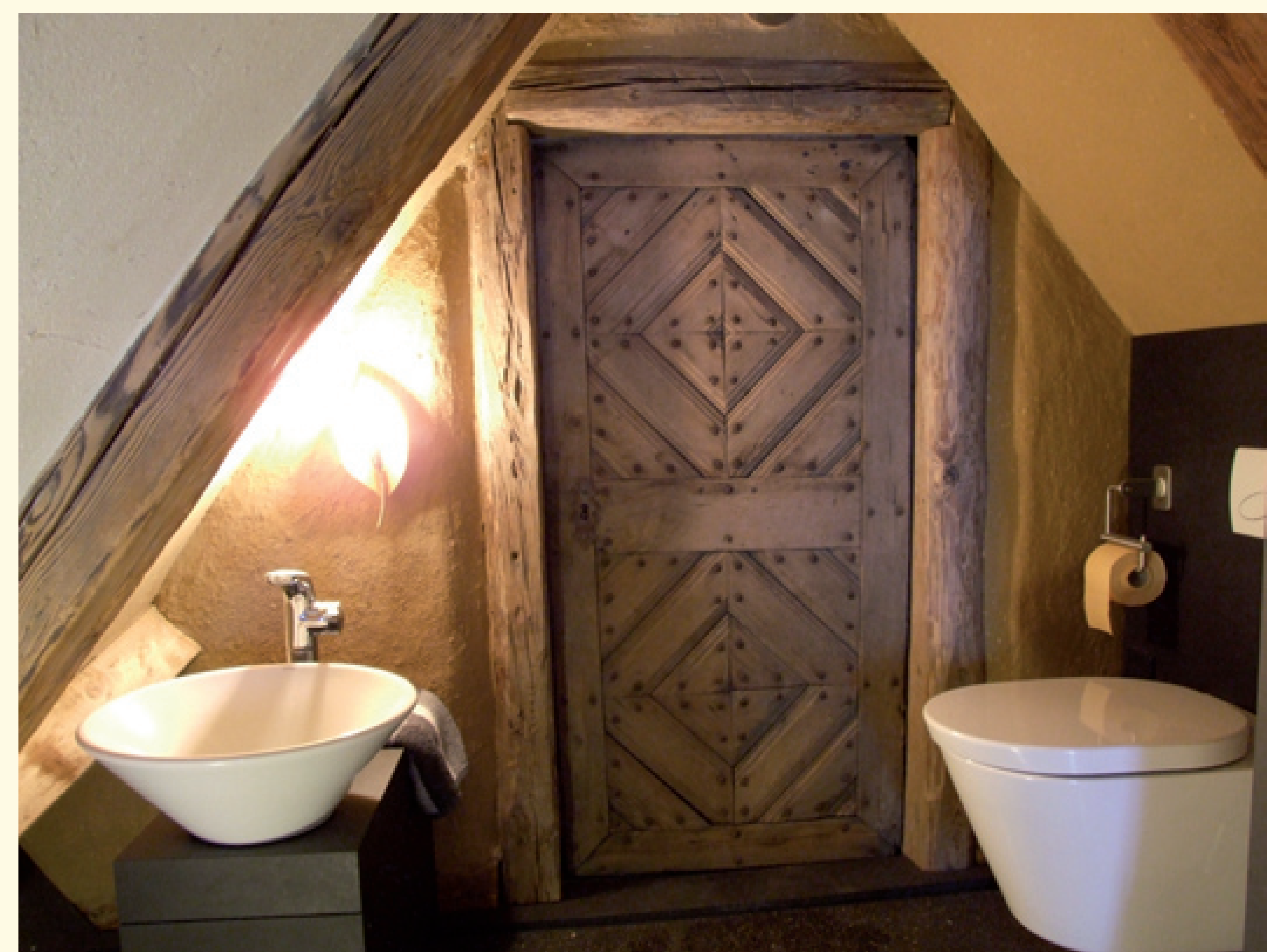
Lehmbauwände im Dachspitz
