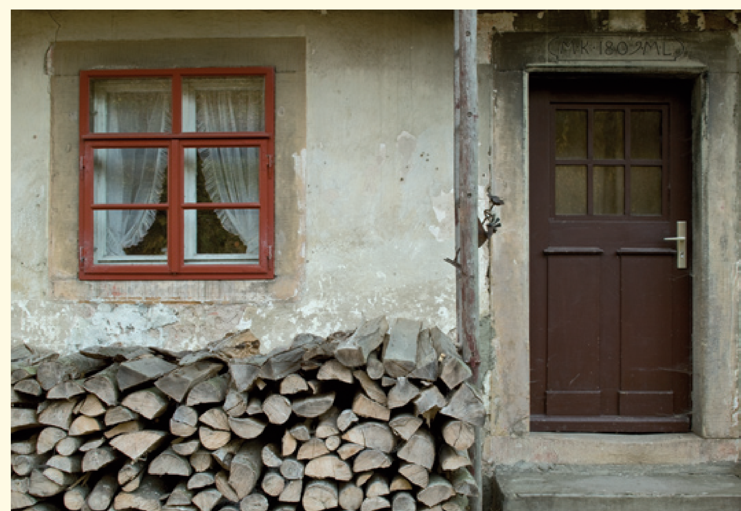
Einfachverglaste Außenfenster wurden zu Kastenfenstern nach innen ergänzt
