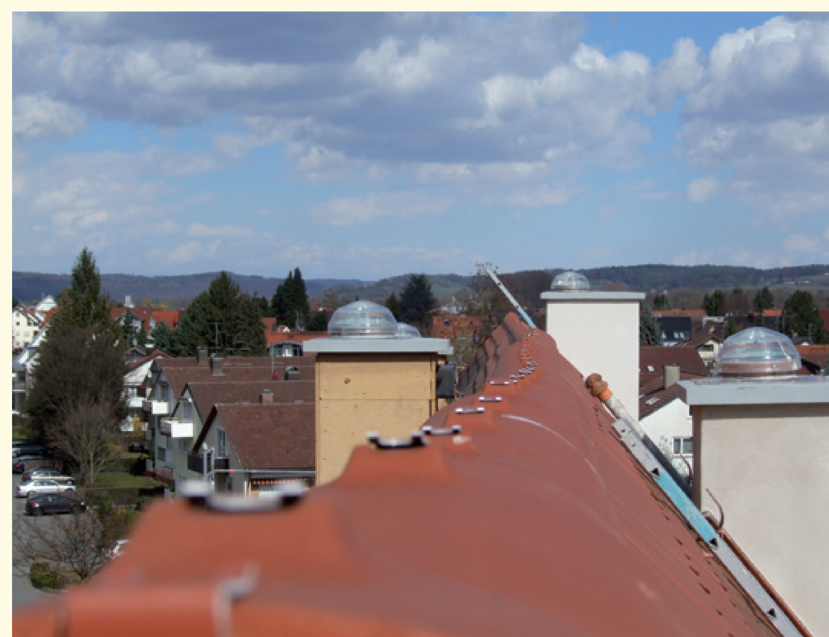
Kunststoffkuppeln der Lichtkammine
