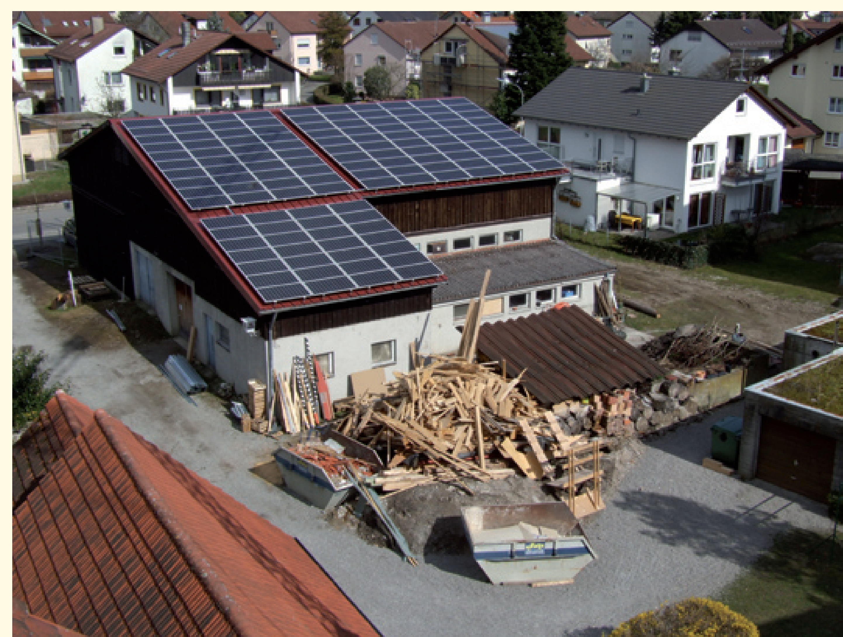
Scheunengebäude mit Photovoltaikanlage
