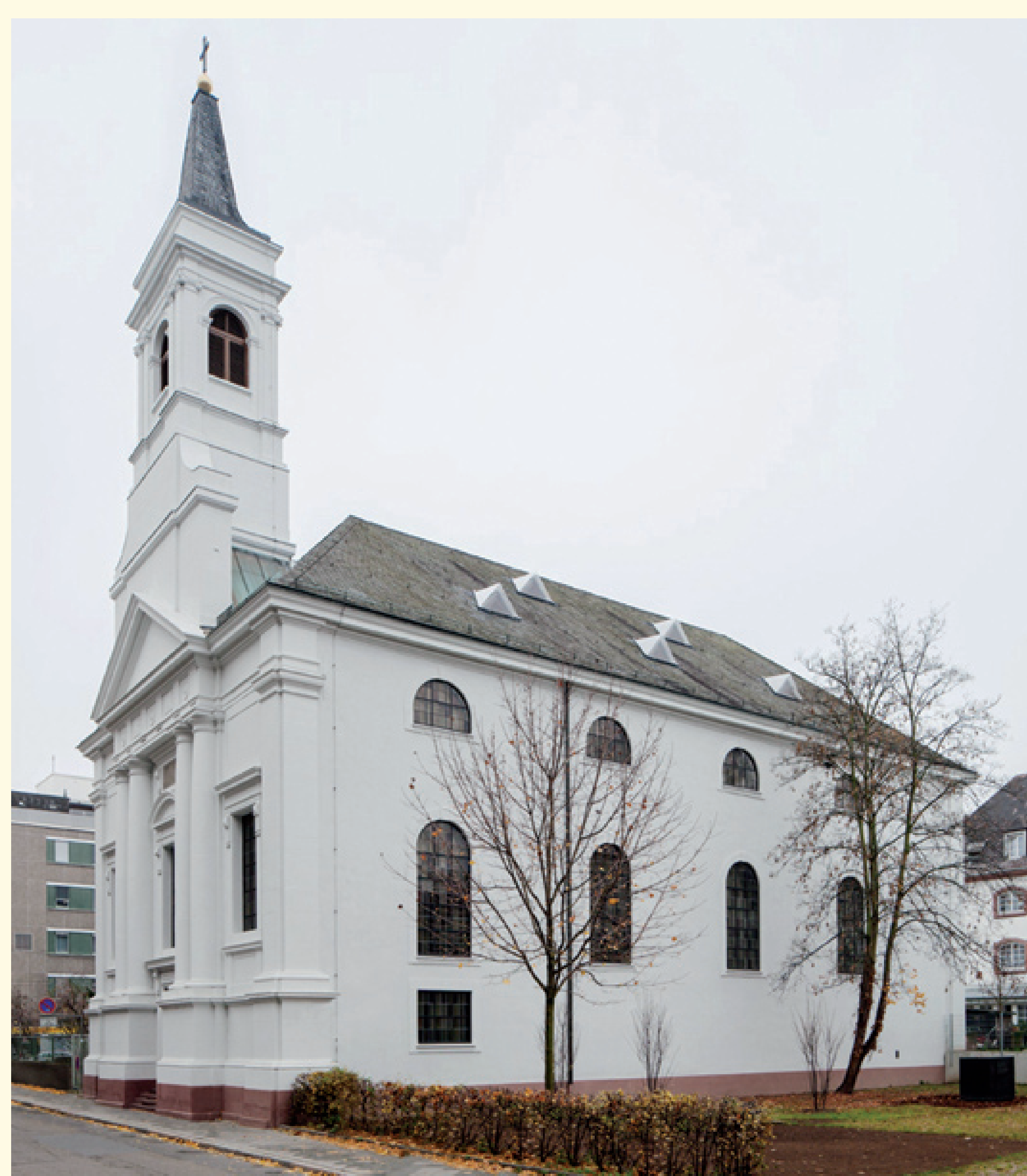
Frühklassizistischer Saalbau mit Fassadenturm
