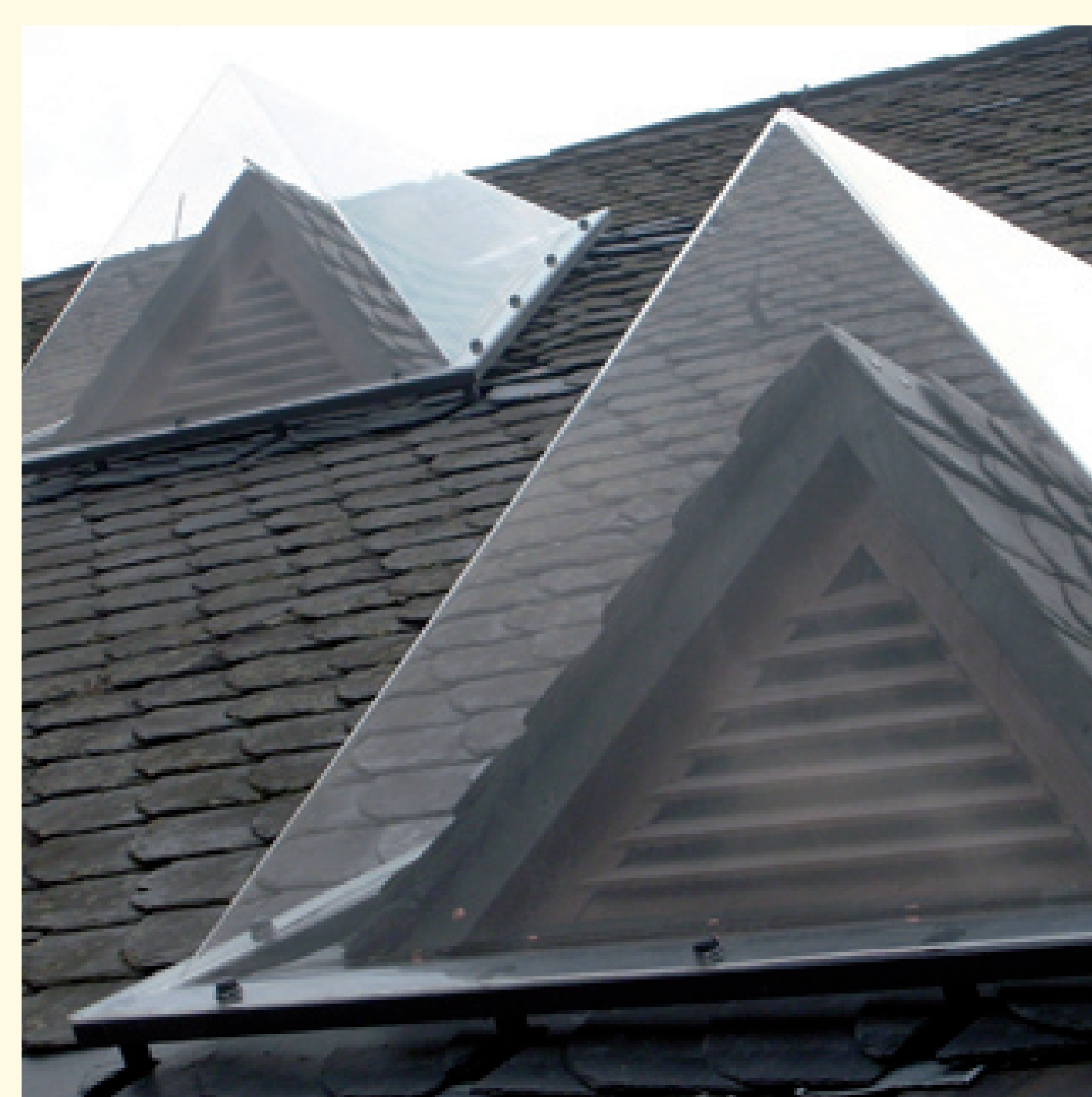
Luftkollektoren über den Dreiecksgauben der Süddachfläche
