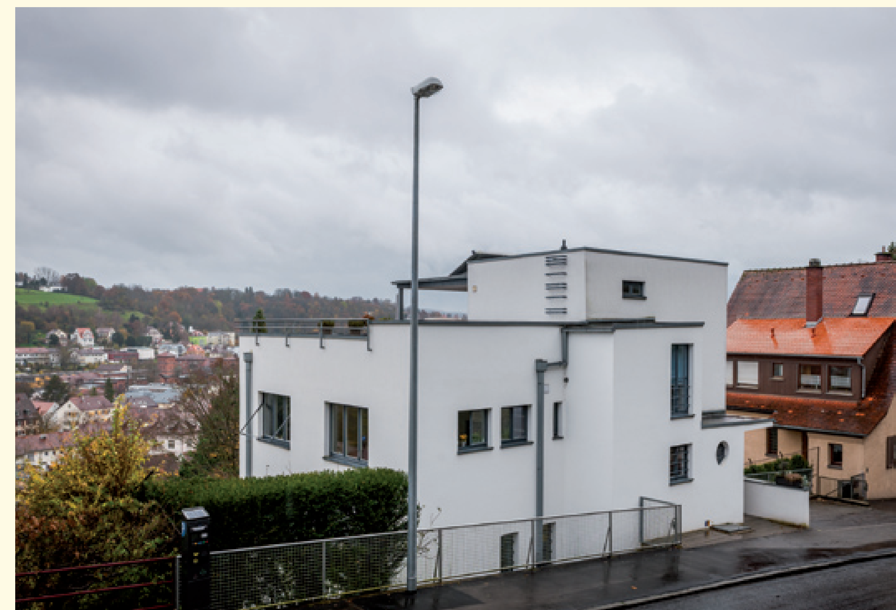
Blick talwärts mit minimaler Einsicht der Flachdachfläche
