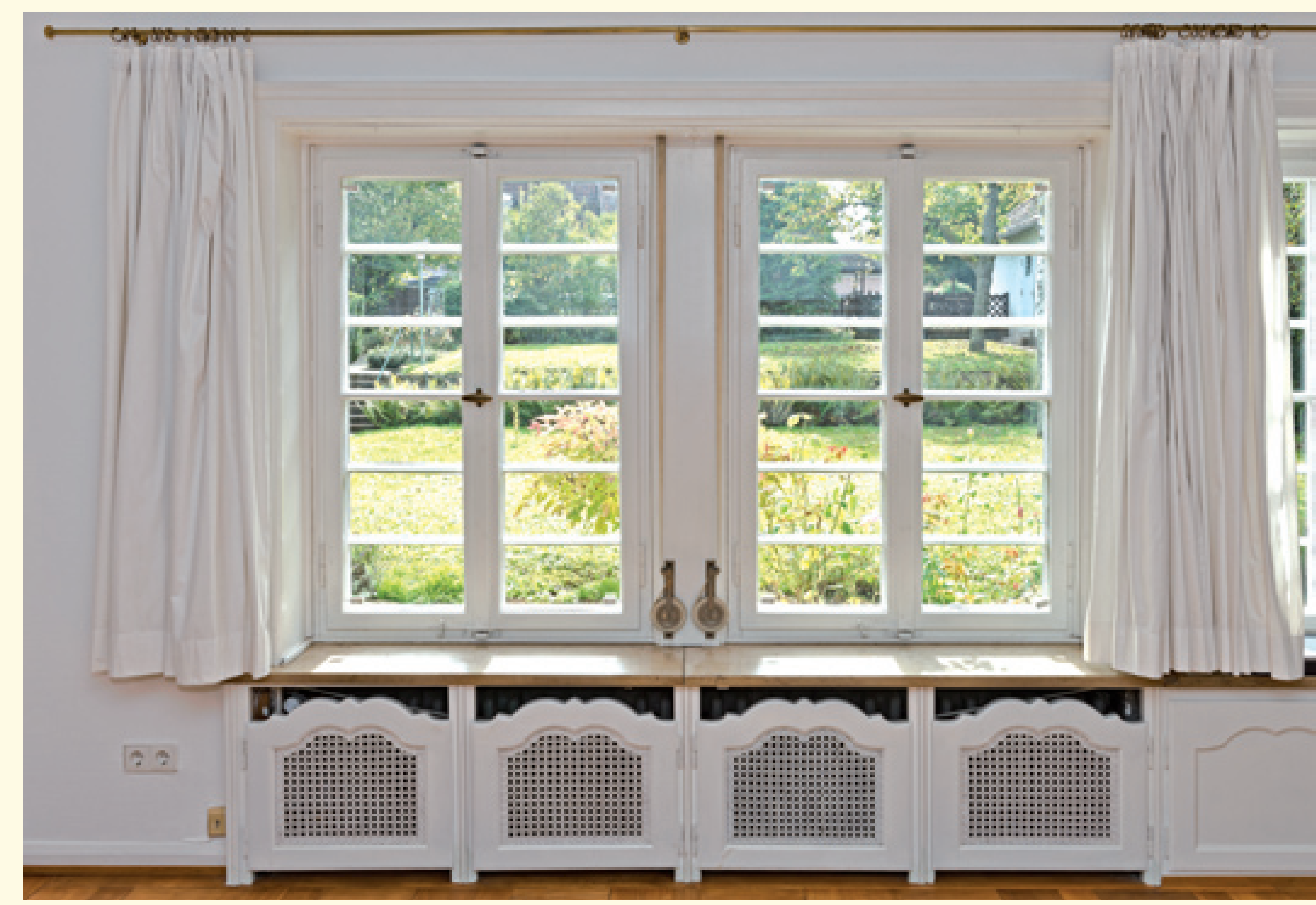
Bauzeitliche Holzfenster im Wohnraum
