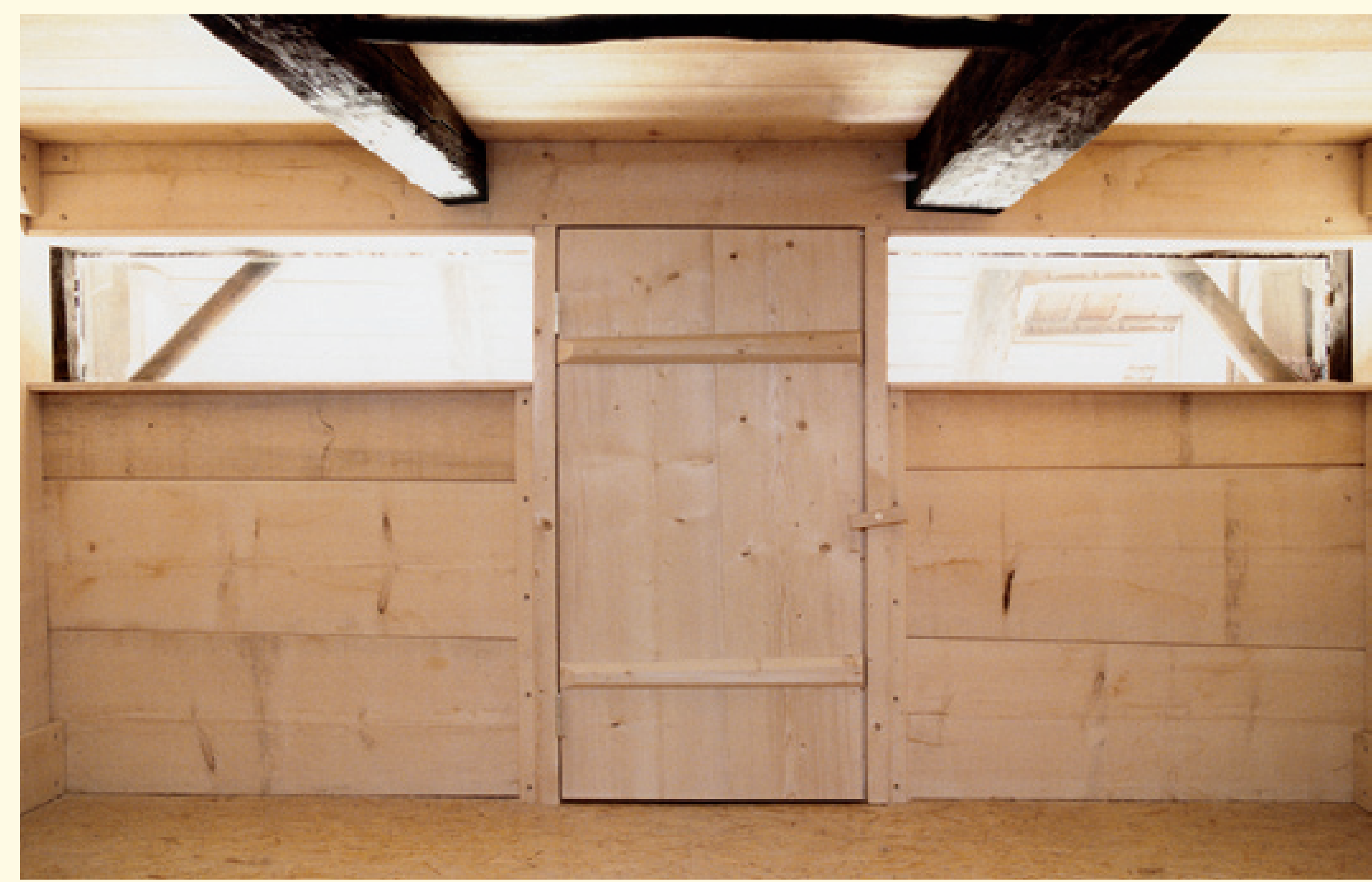
Die bestehenden Außenwände der Obergeschosse wurden mit Holzbohlen innen aufgedoppelt
