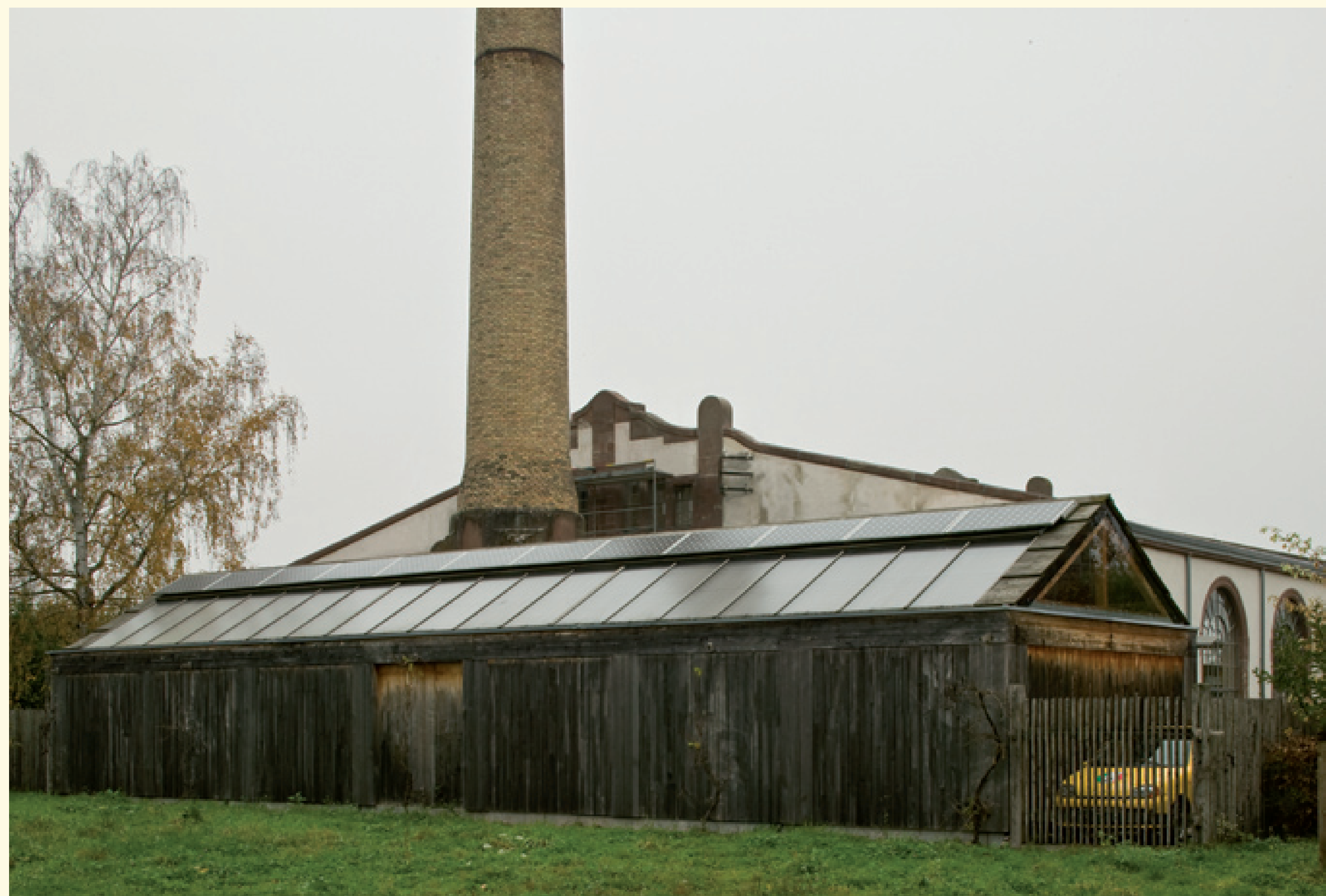
In unmittelbarer Nähe zum Baudenkmal wurden auf dem neu errichteten Carport eine solarthermische und eine Photovoltaikanlage installiert.
