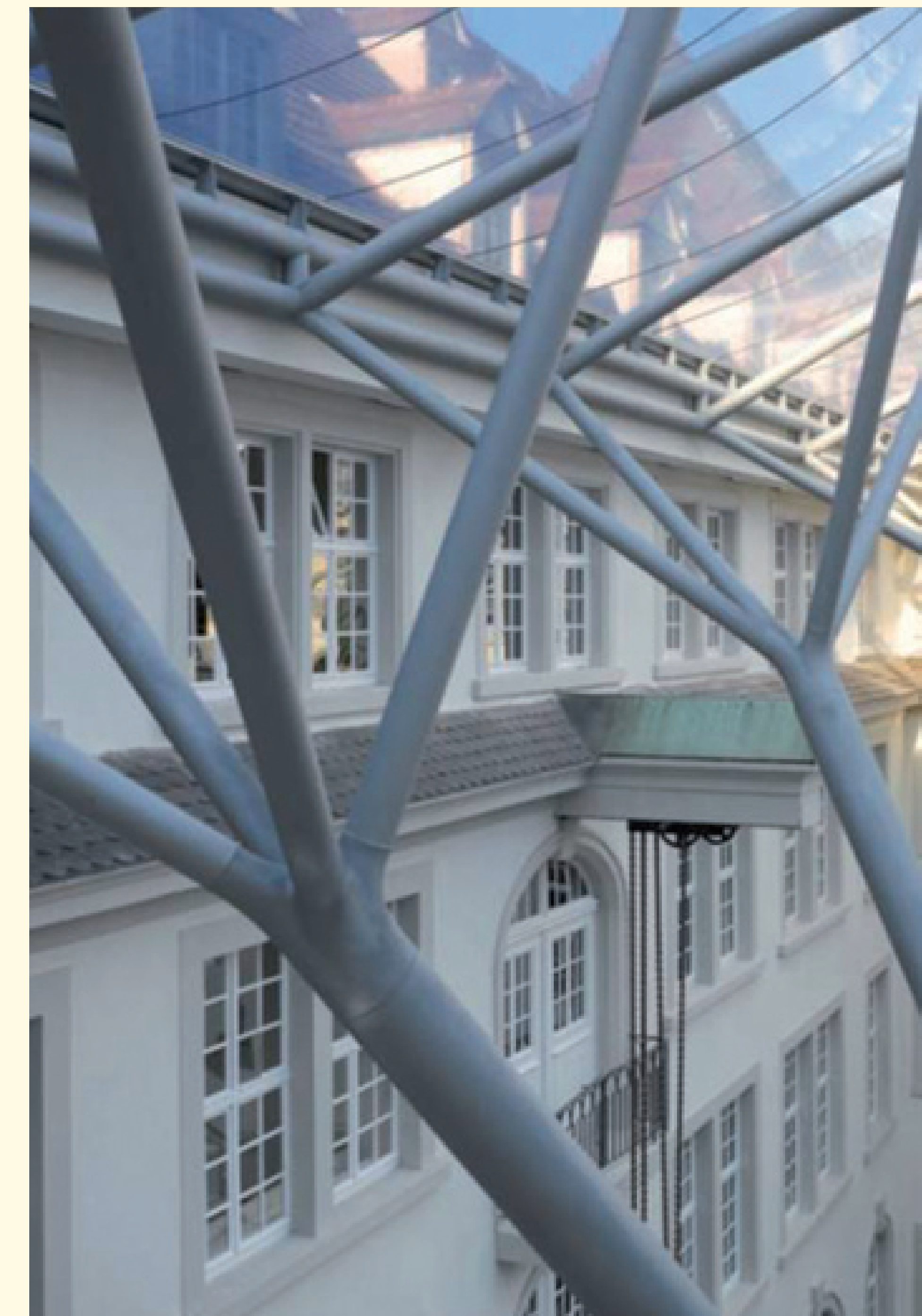
Anschluss der Überdachung an die Traufe
