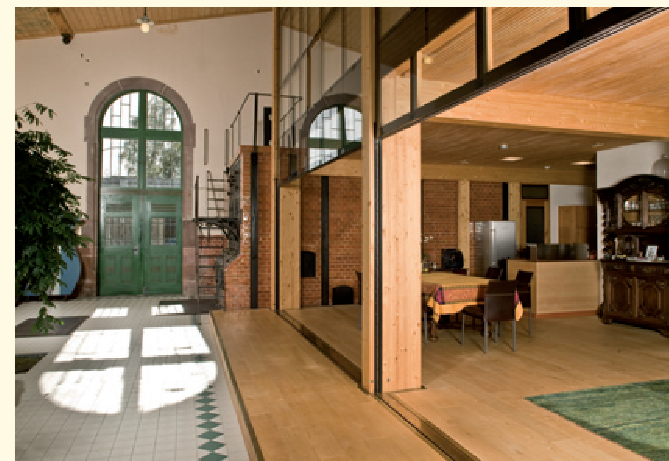
Das „Haus im Haus“-Konzept ermöglicht eine vom denkmalgeschützten Bestand unabhängige energetische Bewirtschaftung
