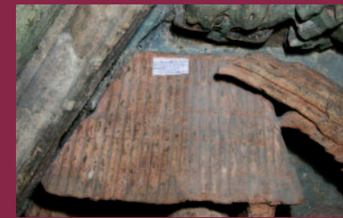
Mittels Mikroporenschwämmn gereinigte Fläche im Bereich des Tympanons
