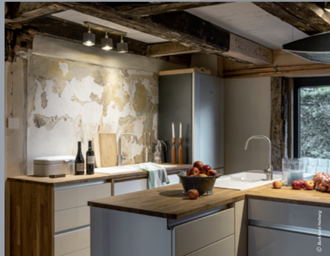
Selbst in Nassbereichen, wie z. B. in einer Küche, lassen sich historische Putzschichten erhalten.
