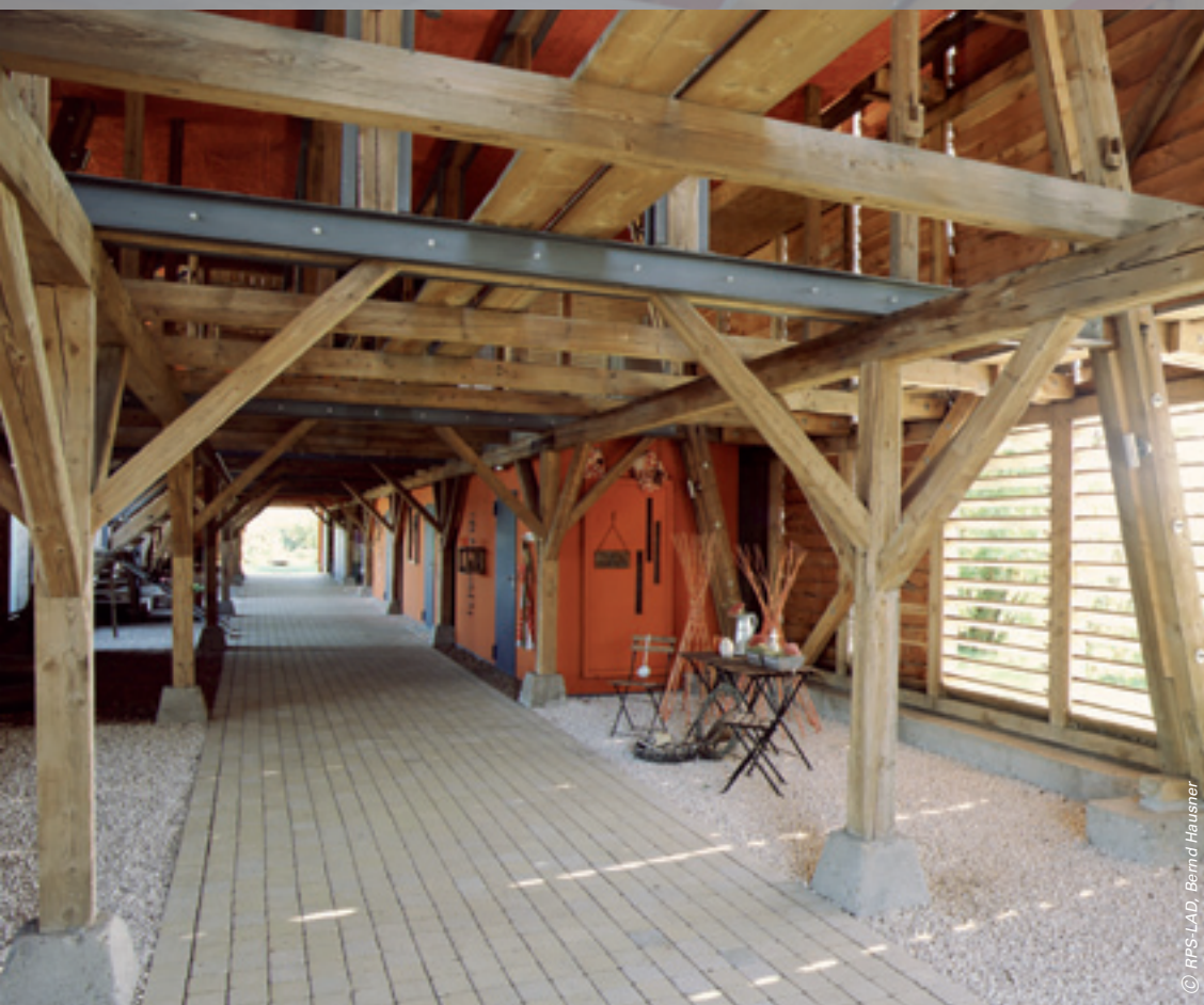
Blick ins Erdgeschoss, in dem die Großräumigkeit der Tabakscheune noch gut ablesbar ist
