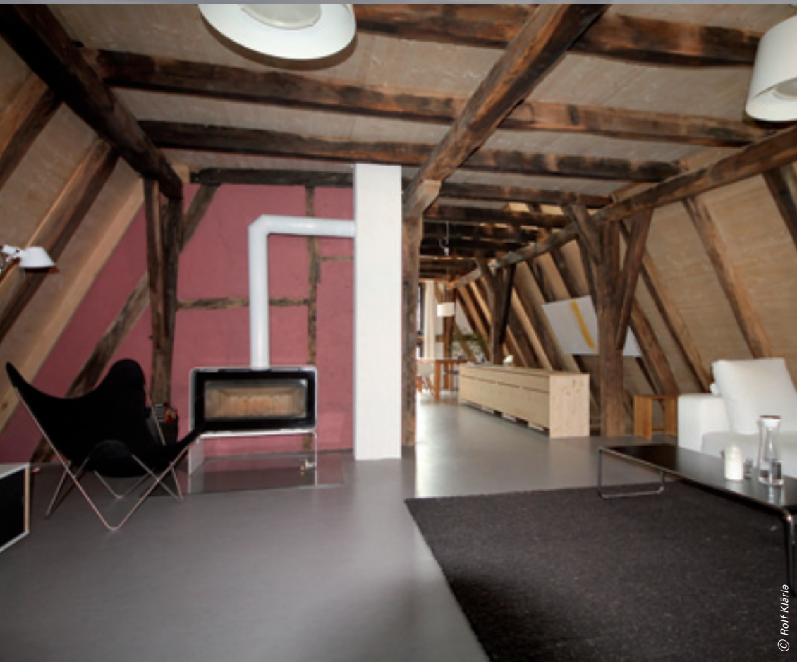
Sichtbares mittelalterliches Dachtragwerk in Bad Mergentheim
