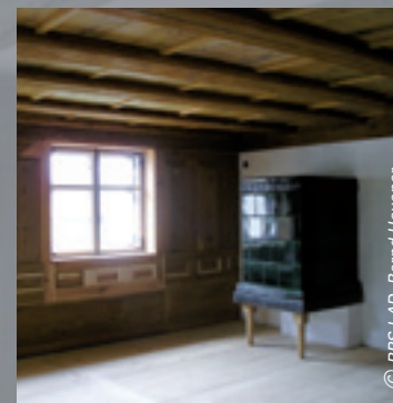
Wand- und Deckentäfer nach der Sanierung und der aufgearbeitete Kachelofen
