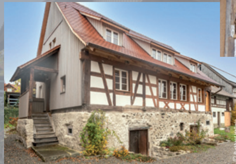
Wohnhaus in Öhningen-Wangen mit historischem Hauseingang und additiv hinzugefügten Gaupen
