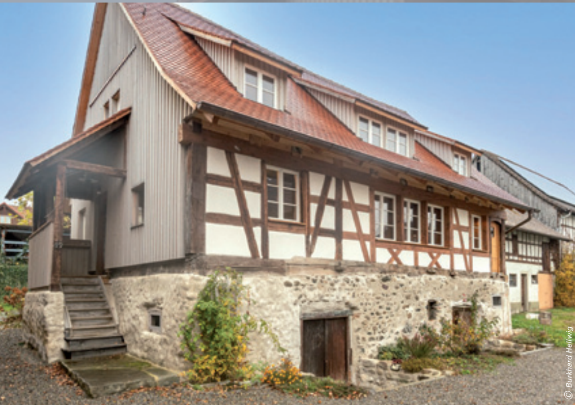
Winkelgehöft in Öhningen-Wangen am Bodensee mit den restaurierten Bestandsfenstern und dem Keller aus dem 12. Jahrhundert
