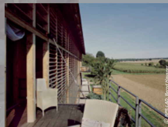
Einen unverstellten Blick ins Grüne eröffnen die neuen Balkone an der Fassade.
