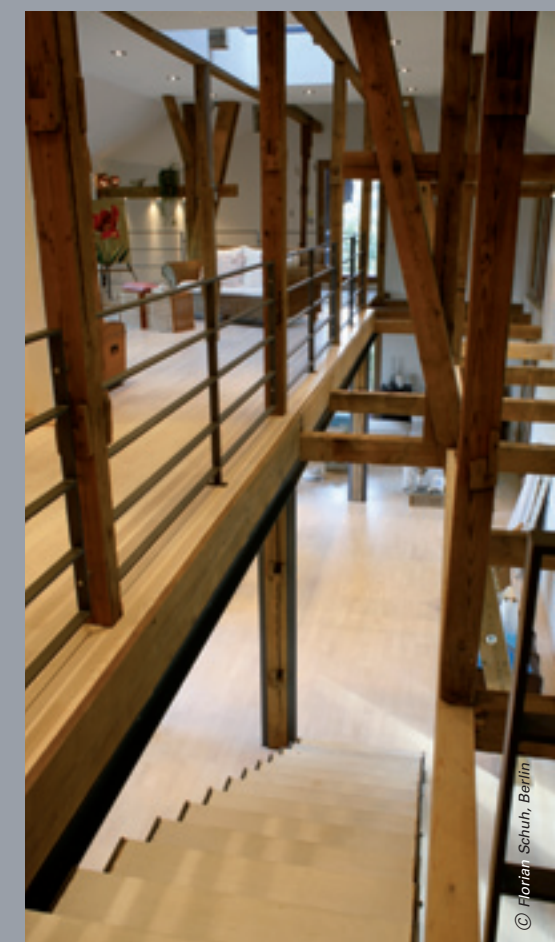
Das Traggerüst zur Trocknung der Tabakpflanzen ist im Innenraum noch deutlich zu erkennen.
