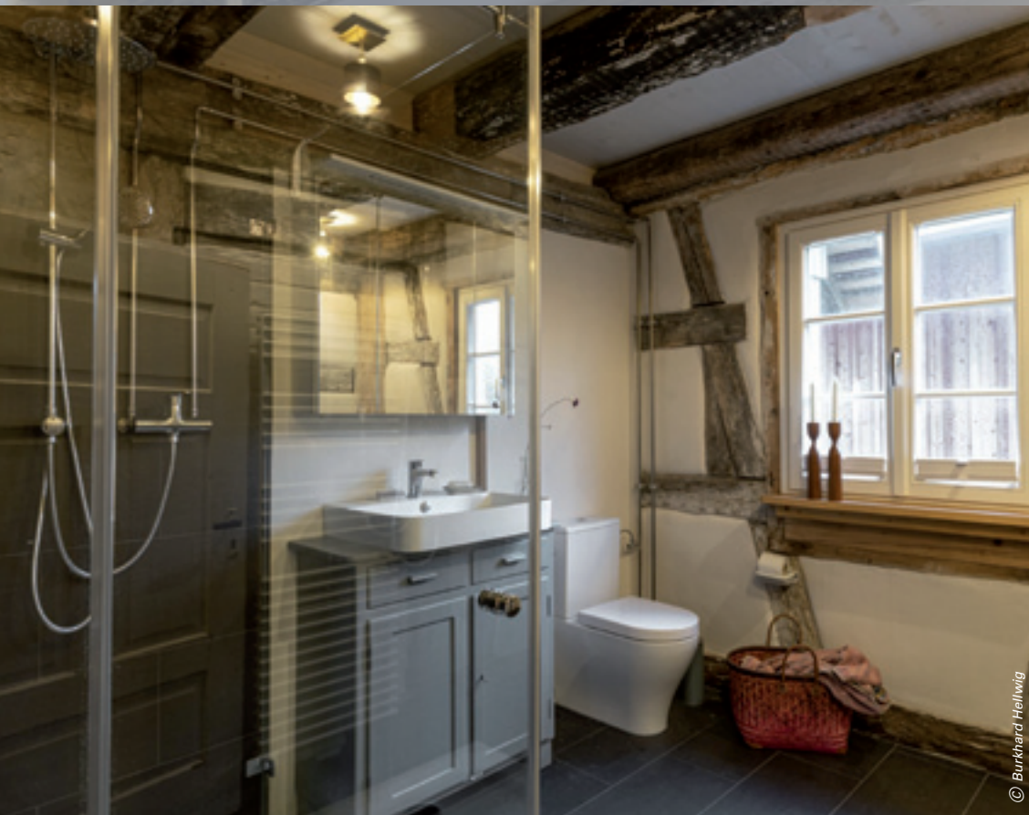
Das neue Bad mit Sichtfachwerk und Lehmputzkissen
