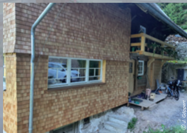
Ansicht von Nordwesten mit neuer Lärchenschindeldeckung
