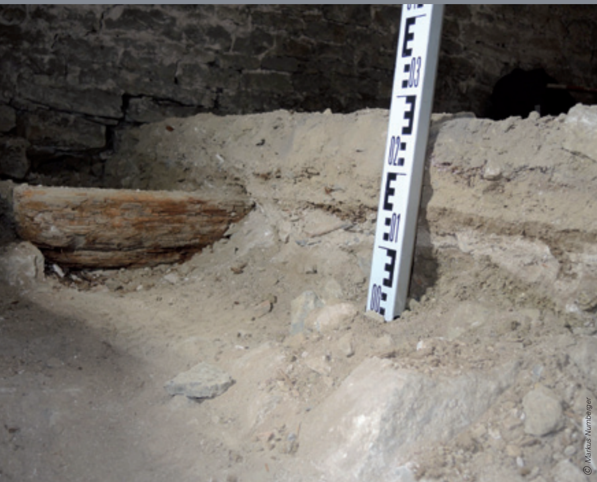
Bauteilöffnung bzw. Sondage einer Kellerdecke als Teil der Bestandserhebung
