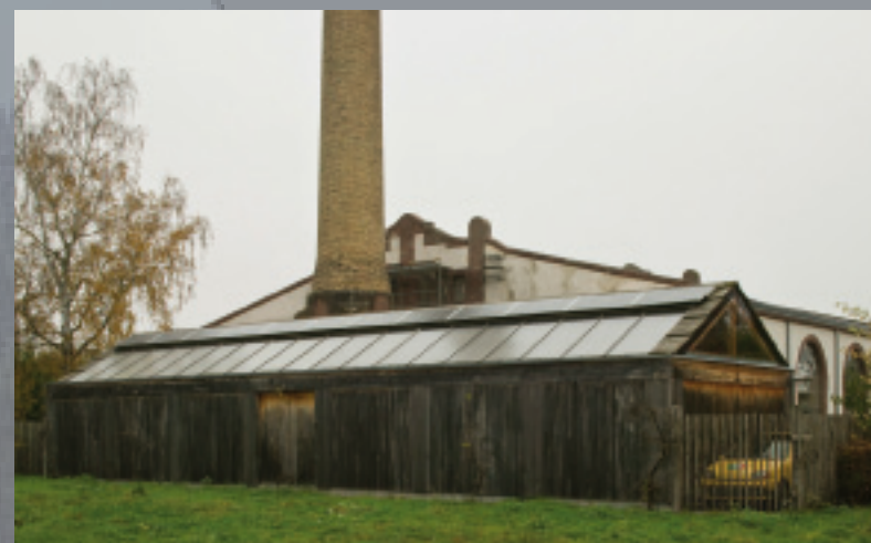
Solaranlagen können denkmalverträglich auf Nebengebäuden installiert werden
