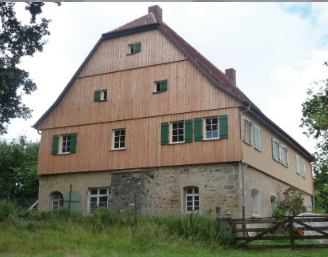
Das Erdgeschoss des Wohnhauses wurde mit einer Innendämmung versehen, die Fenster wurden repariert. Das Obergeschoss erhielt unter der neuen Holzschalung eine Außendämmung und die Fenster wurden erneuert. Die letzte Geschossdecke erhielt im Dach eine Dämmung. Das gesamte Haus bekam eine neue Heizungsanlage.
