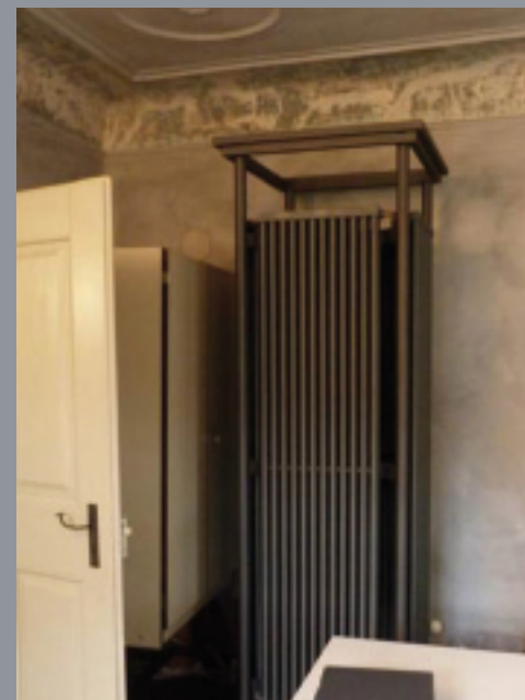
In vielen Denkmälern fällt der Brüstungsbereich für die Montage von Heizkörpern aus, da diese Flächen zum Beispiel mit hölzerner Ausstattung belegt sind. Das stellt für Heizungsbauer eine Herausforderung in der Zusammenführung heiztechnischer Bedingungen mit gestalterischem Anspruch dar.
