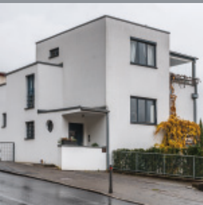
Wohnhaus der 1930er Jahre, Sanierung der Fenster und Ergänzung zu Verbundfenstern, neue Heizanlage und Einsatz einer solarthermischen Anlage auf der Terrassenüberdeckung
