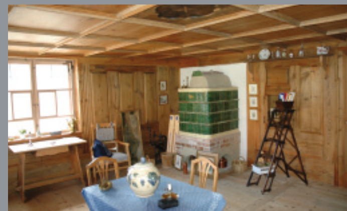
Die Möglichkeiten von Innen- oder Außendämmungen können durch die Architekturgestalt eingeschränkt sein. Holztäfer im Inneren lassen in aller Regel keine Innendämmung zu.
