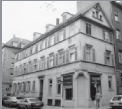
Anders stellt sich die Sanierung des Wohn- und Geschäftshauses dar, das durch die energetische Modernisierung Substanz, Erscheinungsbild und letztlich seine Denkmaleigenschaft verloren hat.
