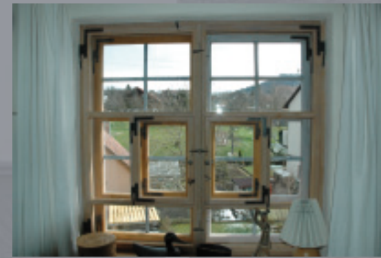
Wohnhaus mit Außendämmung in den Obergeschossen und reparierten Bestandsfenstern, die nach innen zu Kastenfenstern ergänzt wurden
