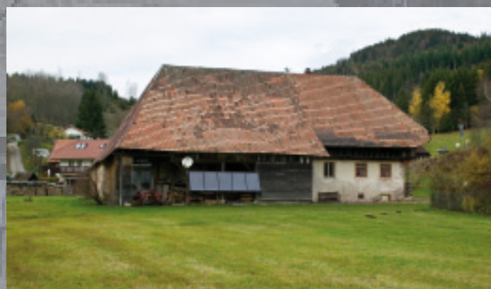
Solaranlagen können nicht nur in Dächer integriert, sondern auch als selbstständige Elemente den Gebäuden vorgestellt oder als Wandanlagen geplant werden.
