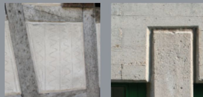
Bauwerke, deren typische Erscheinungsweise sich auf die Struktur des Sichtbetons oder des Putzes stützt, sollten keine Außendämmung erhalten.
