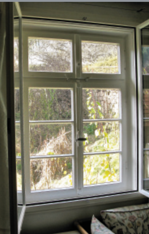
Ergänzung eines einfachverglasten Einfachfensters zum Kastenfenster mittels eines isolierverglasten zweiflügligen ungeteilten Innenfensters.
