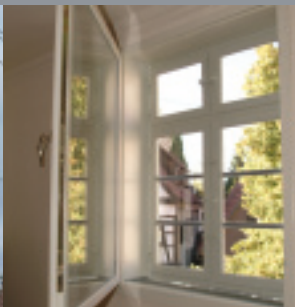
Historisches Einfachfenster mit isolierverglastem Kastenfenster
