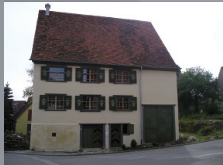
Wohnhaus mit Außendämmung in den Obergeschossen und reparierten Bestandsfenstern, die nach innen zu Kastenfenstern ergänzt wurden
