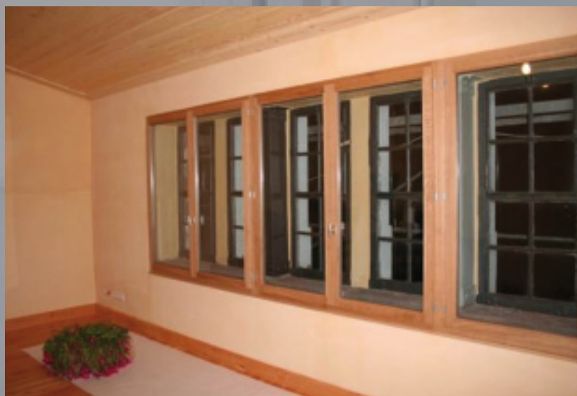
In vielen Denkmälern fällt der Brüstungsbereich für die Montage von Heizkörpern aus, da diese Flächen zum Beispiel mit hölzerner Ausstattung belegt sind. Das stellt für Heizungsbauer eine Herausforderung in der Zusammenführung heiztechnischer Bedingungen mit gestalterischem Anspruch dar.
