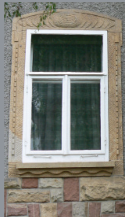
Fassaden der Jahrhundertwende (19./20. Jh.) erhalten ihre Gestalt häufig über eine Komposition verschiedener Baustoffe wie Putz, Natur- und Kunststein.
