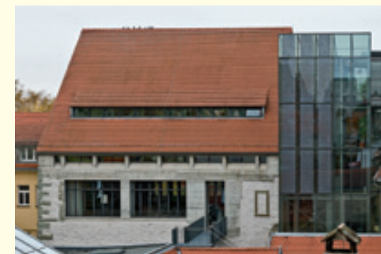
Semitransparente Photovoltaikanlage in einem neu errichteten Erschließungsturm
