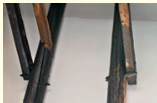
Aufsparrendämmung auf dem verblatteten Dachstuhl
