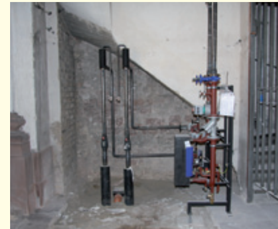
4 Fernwärmeübergabe unter der Empore
