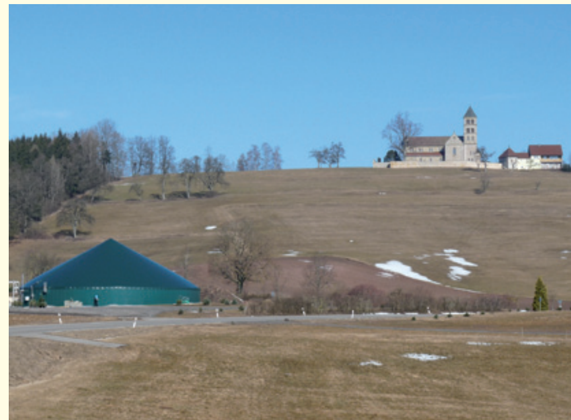
Störung des denkmalrelevanten Umgebungsbereiches durch eine Biogasanlage
