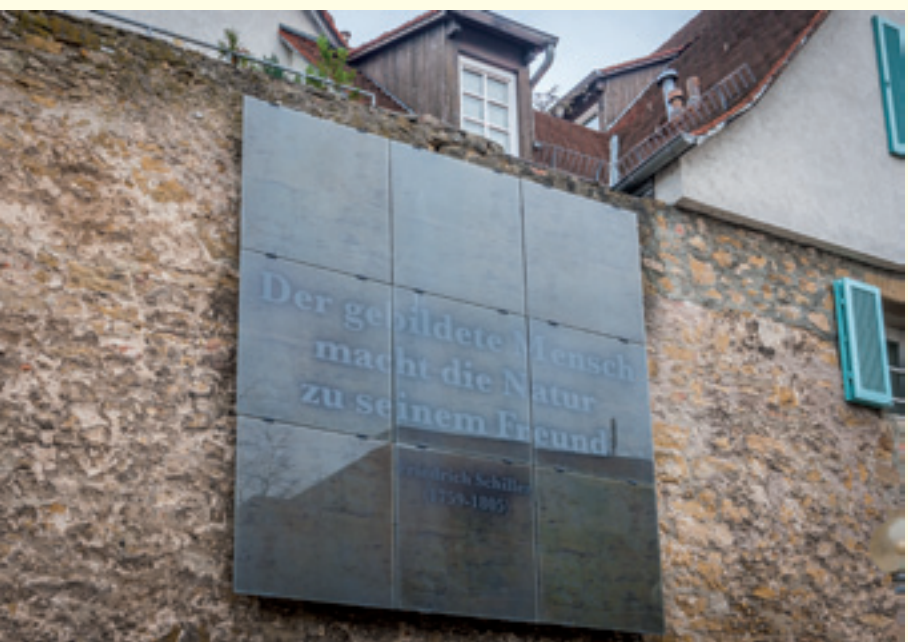
Denkmalgeschützte Stadtmauer mit Dünnschicht-Photo- voltaikanlage
