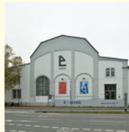
Markant an der Maschinenhalle ist das mehrfach geknickte, auf den Nordseiten in Titanzink gedeckte Dach.
