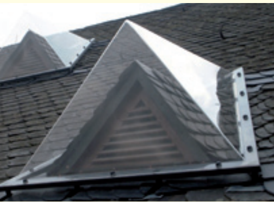
Luftkollektoren über den Dreiecksgauben der Süddachfläche
