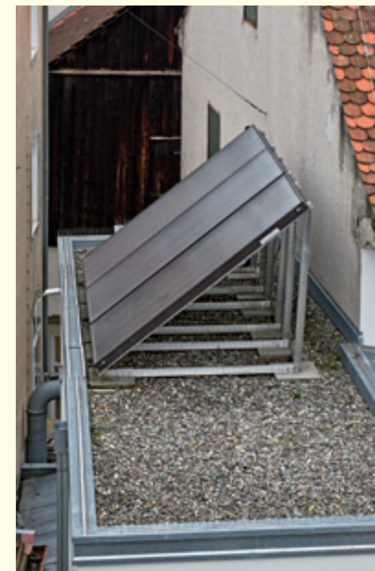
Solarthermischer Flachkollektor
