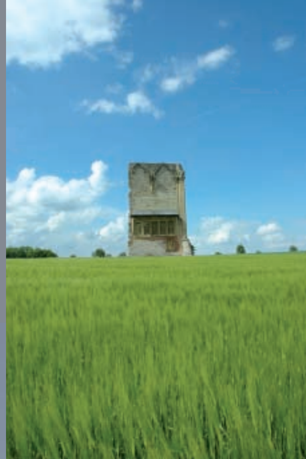
Oberirdisch erhaltener Rest der nördlichen Seitenwand des gotischen Chors.
