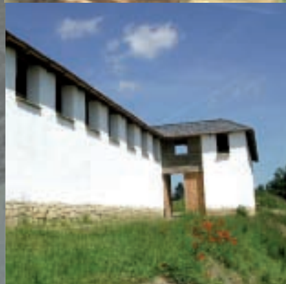
Um die Jahrtausendwende wurde auf dem Plateau das Freilichtmuseum Heuneburg eingerichtet und Teile der ehemaligen Bebauung, darunter ein Abschnitt der kalkverputzten Lehmziegelmauer, rekonstruiert.
