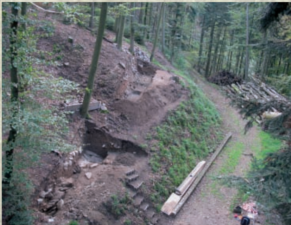
Bei der Anlage eines Forstweges wurden die Befestigungen des „Kügeleskopf“ (Ortenberg, Ortenaukreis) angeschnitten. Bei Nachgrabungen wurde der in den Fels eingetiefte Graben freigelegt.
