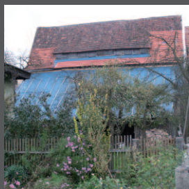
Notsicherung durch Abstützen und Abdecken.
