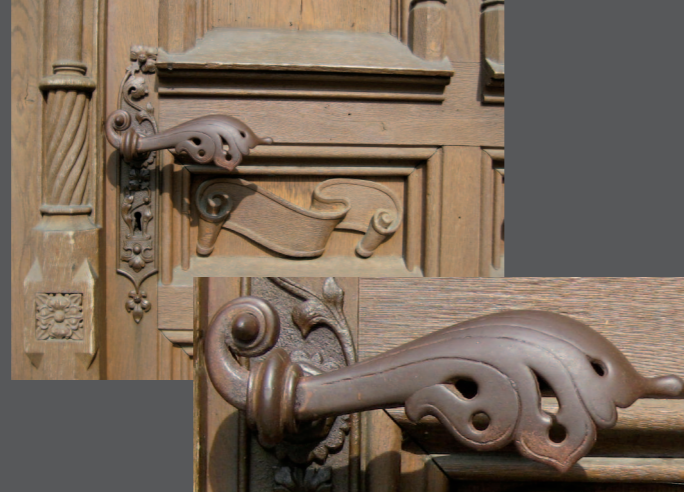
Stählerner Türdrücker vom Salemer Münster mit dichter, passiver brauner Korrosionsschicht.
