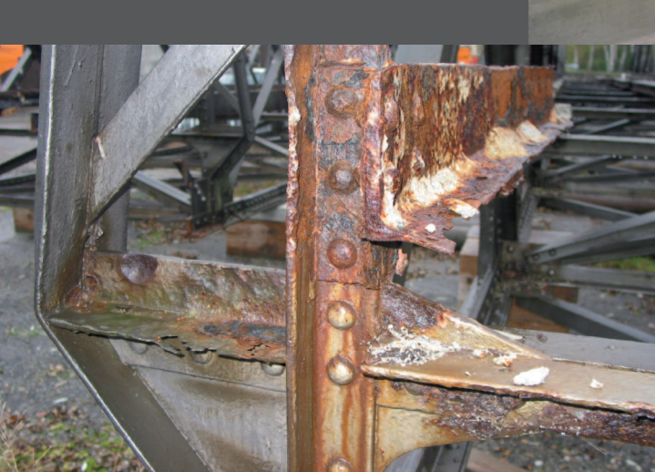
Knotenpunkt an der Fachwerkträgerkonstruktion des Escherstegs in Ravensburg. Die Brücke stammt von 1909 und zeigt unter der Laufebene deutliche Schädigungen durch Korrosion, die u.a. durch Belegung mit Tausalzen entstand.
