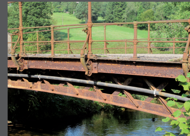
Teilansicht der Brigachbrücke bei Unterkirnach-Gropper.
