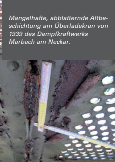
Korrosion und damit Volumenzunahme in Spaltbereichen (Stauäsebereiche mit wechselnder Feuchte) führt zur Aufbiegung der Spalten und Verformung der Konstruktion.
