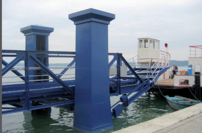
Ansicht der Fähre und des Fähranlegers von 1928 in Konstanz-Staad nach erfolgter Restaurierung (Reinigung nach DIN, Reinigungsgrad PSt 2, Beschichtung mittels restrostverträglichem Anstrichsystem, Farbfassung nach Befund).
