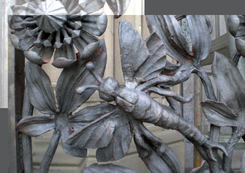
Detail mit Blüte und Libelle am Türgitter der Marienkirche in Stuttgart. Das Foto zeigt das Gitter nach einer Reinigung durch Strahlen mit Trockeneis.
