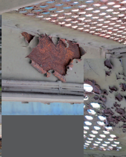
Korrosion und damit Volumenzunahme in Spaltbereichen (Stauäsebereiche mit wechselnder Feuchte) führt zur Aufbiegung der Spalten und Verformung der Konstruktion.
