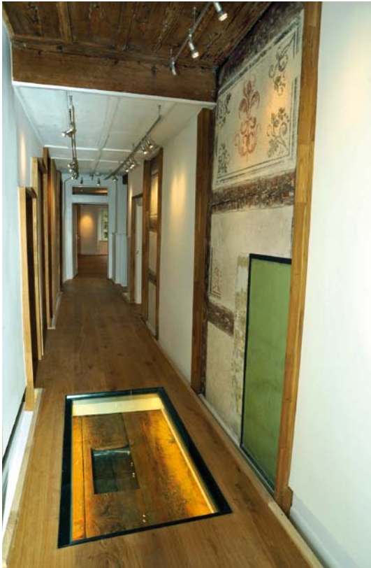
Abb. 109 Die unterschiedlichen Bodenniveaus wurden durch einen neuen durchgängigen Holzfußboden unter Erhaltung des Bestandes barrierefrei gestaltet. Wie groß die Höhenunterschiede im Bestand waren, kann man an kleinen „Schaufenstern“ in den neuen Flurböden betrachten.
