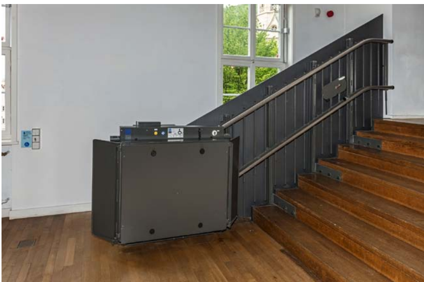
Abb. 73 Auch beim Treppenlift im Uracher Schloss ist die Traglast begrenzt. Neben einem hohen Wartungsaufwand muss sich jeder Bauherr darüber im Klaren sein, dass aus haftungsrechtlichen Gründen Bedienpersonal vorzuhalten ist.
