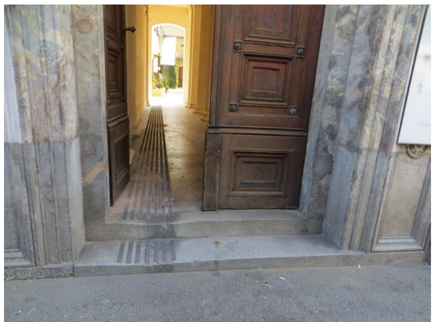
Abb. 29 Taktile Bodenstrukturen in Gebäuden können wie das Beispiel aus Graz (A) zeigt, sehbehinderten und blinden Menschen die selbstständige Orientierung ermöglichen.
