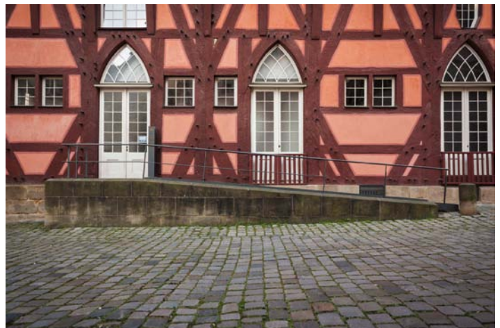
Abb. 36, 37 und 38 Rampe zur barrierefreien Erschließung und Andienung des Alten Esslinger Rathauses. Die Rampe verfügt über seitliche Radabweiser.
