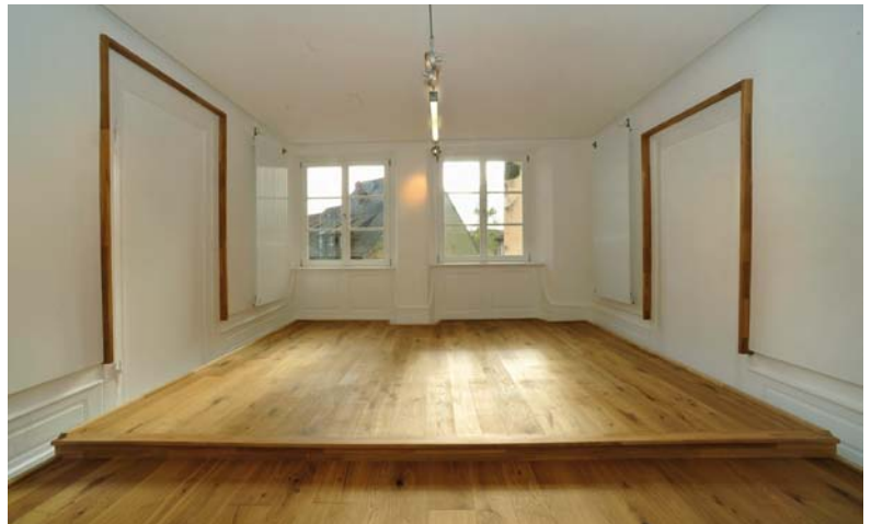
Abb. 110 Im großen Saal wurde der Boden ebenfalls durchgezogen, wodurch die hölzernen Lambrien nicht mehr vollständig wahrnehmbar sind.
