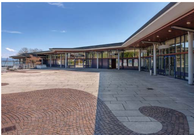
Abb. 143 Eingangsbereich mit ausladendem Vordach
