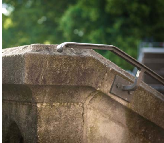
Abb. 67 Ergänzung der Brüstung aus Naturstein mit einem Handlauf auf der Inneren Brücke in Esslingen.
