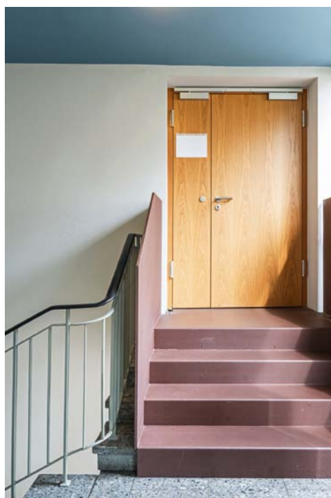
Abb. 135 und 136 Der heutige Gemeindesaal befindet sich auf der ehema- ligen Kirchenempore, deren Abtreppungen durch einen Überbau egalisiert wurden. Die neuen Höhen erforderten den alten Treppenlauf auszugleichen. Die ge- wünschte Barrierefreiheit führte zum Einbau eines Aufzuges, der in der Lage ist, ½-Geschosse anzufahren.
