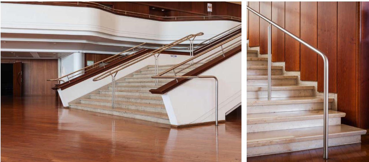
Abb. 148 und 149 Treppenanlagen mit barrierefreien Handläufen und rutschfesten Stufenkanten. Der nach DIN 18040-1, Ziffer 4.3.6.2 zulässigen Unterschneidungen der Treppenstufen von maximal 2 cm wurde bei diesem Bauvorhaben noch keine hinreichende Aufmerksamkeit geschenkt. Achtung – Unterschneidungen sind Stolperfallen.
