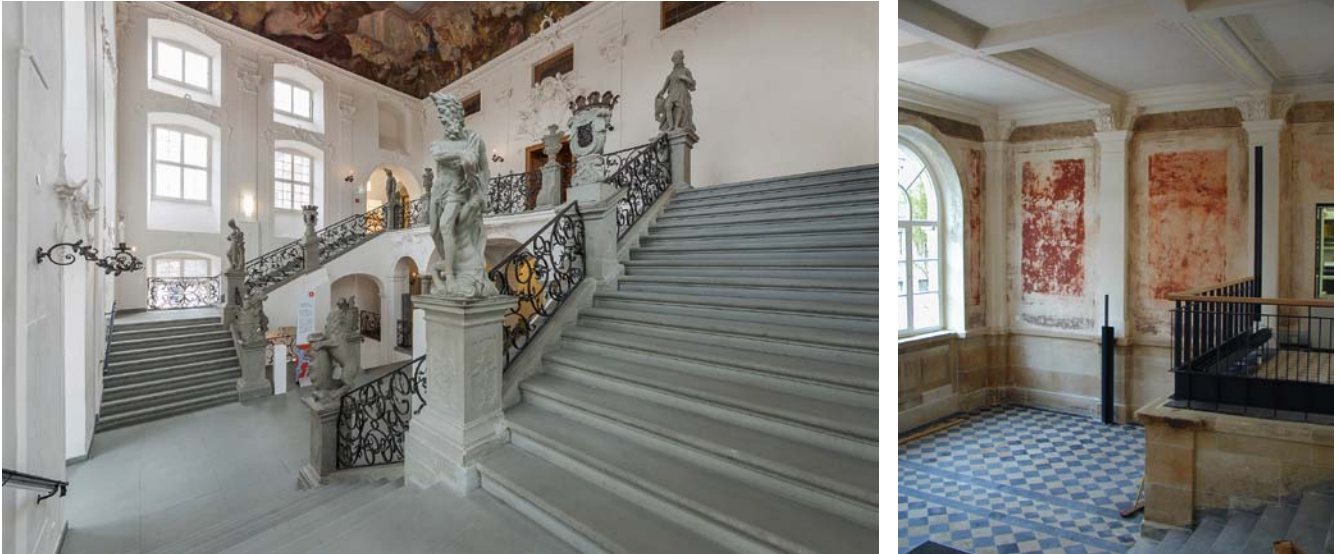
Abb. 61 und 62 Sind die Hauptzugänge wie im Neuen Schloss in Meersburg oder dem ehemaligen Schelztor-Gymnasium in Esslingen nicht barrierefrei herzustellen, so sollte jedenfalls bei der Planung der Gesamterschließung darauf geachtet werden, dass Menschen mit Rollstuhl oder Rollator die häufig aufwendig gestalteten Hauptzugangsbereiche und Treppenhäuser intern erreichen können.
