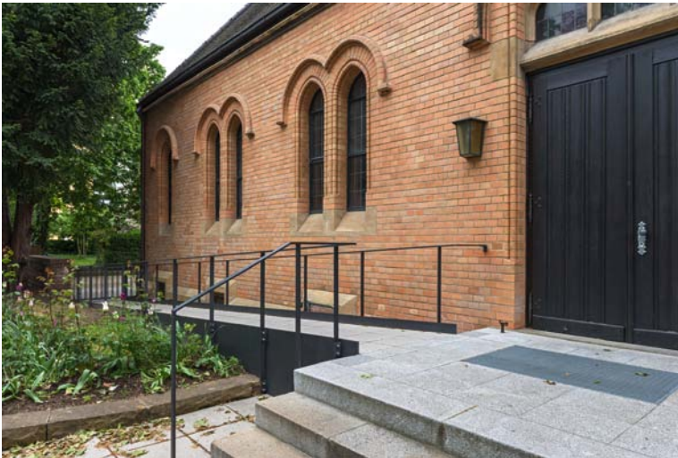
Abb. 35 Lutherkirche Bad Cannstatt, der barrierefrei Zugang wurde mit dem überwiegend genutzten Seiteneingang zusammengelegt.
