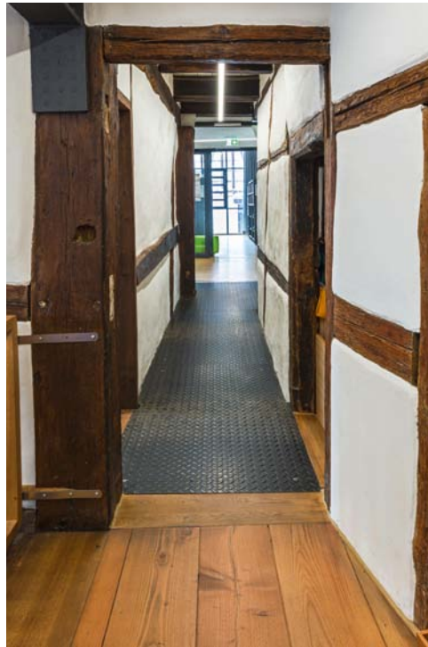
Abb. 60 Riffelblechrampe zum Niveausgleich zwischen den beiden Gebäudeteilen der Bücherei in Ehningen.
