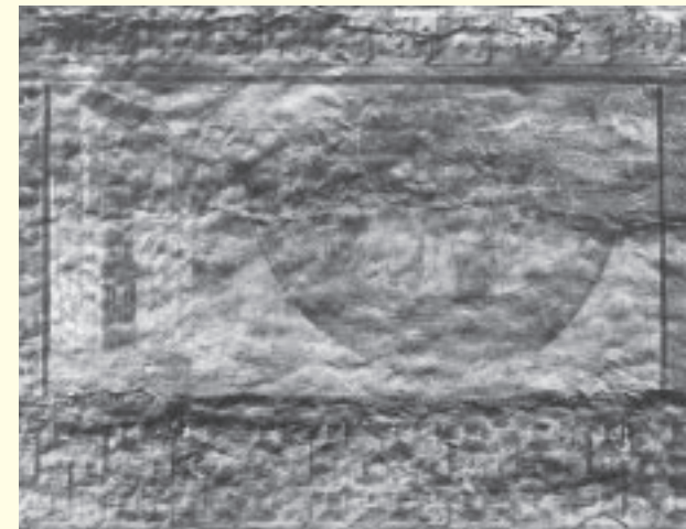
St. Georg, Mittelschiff, Nordwand, Detail der Bildszene der Beruhigung des Sturms auf dem See Genezareth. Das Bild wurde im Streiflicht aufgenommen, um die horizontalen Mörtelgrenzen zu verdeutlichen.
