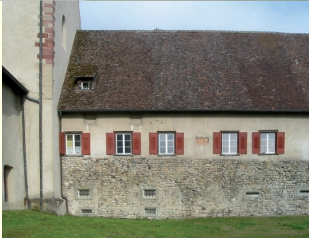
Mittelzell, Ostwand des älteren Klausurwestflügels, die im Erdgeschoss weitgehend zum ersten steinernen Gebäude aus dem 8. Jahrhundert gehört. Im Inneren des Gebäudes fanden sich Überreste einer Unterbodenheizung.
