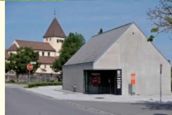
Oberzell, In diesem Museumspavillon erfahren Besucher Hintergründe über den Wandmalereizyklus von St. Georg und dessen groß angelegte Restaurierung.
