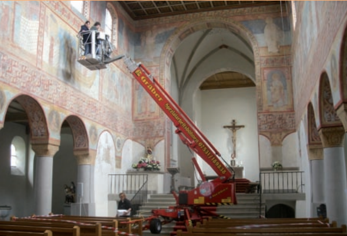
St. Georg, Mittelschiff, Wartung an der Nordwand mit der Hebebühne, Mai 2011.
