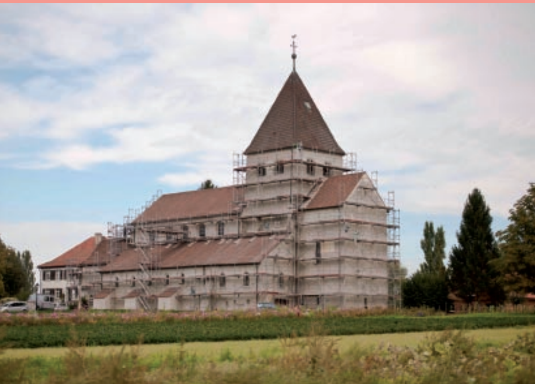
Oberzell, St. Georg, im Sommer 2012 wurde eine Fassadensanierung vorgenommen.
