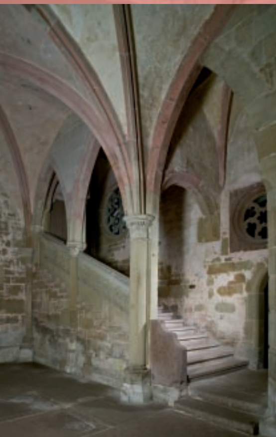
Dormitoriumstreppe, die so genannte Höllentreppe. Die östliche Nebentreppe dazu wurde in den 1930er Jahren ersatzlos abgebrochen.
