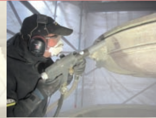
Restaurator bei der Reinigung der Oberflächen an der steinernen Brunnenschale.
