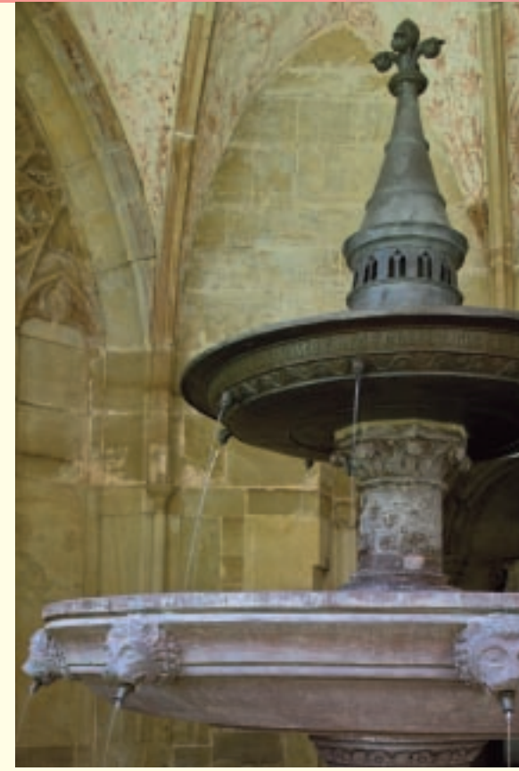
Nach Plänen von E. Paulus d.J. entstand 1879 der Dreischalenbrunnen aus einer unteren renovierten bzw. ergänzten Schale, einer zweiten neu angefertigten Steinschale mit Löwenköpfen und der bronzenen Schale samt Laterne des eigens dafür abgebauten gotischen Abtbrunnens.
