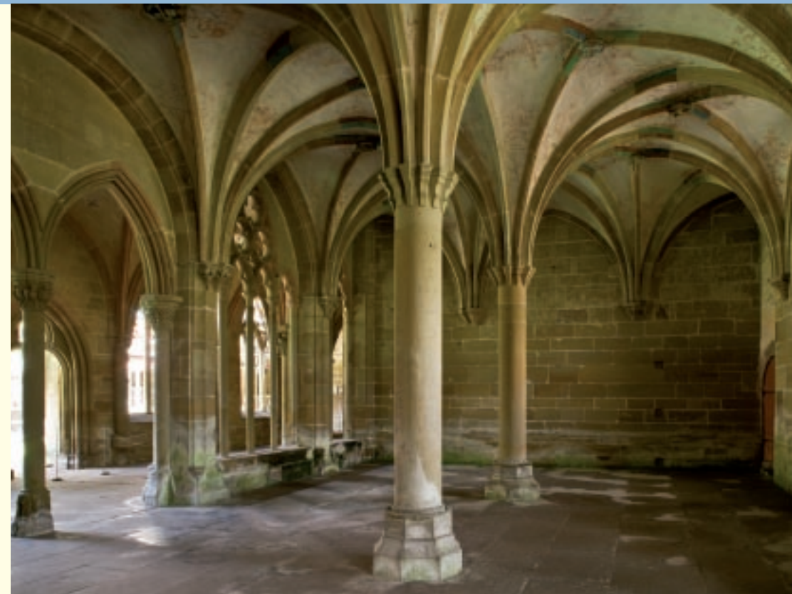
Kapitelsaal mit gotischem Sternengewölbe und weiten Fensteröffnungen zum Ostflügel des Kreuzgangs.
