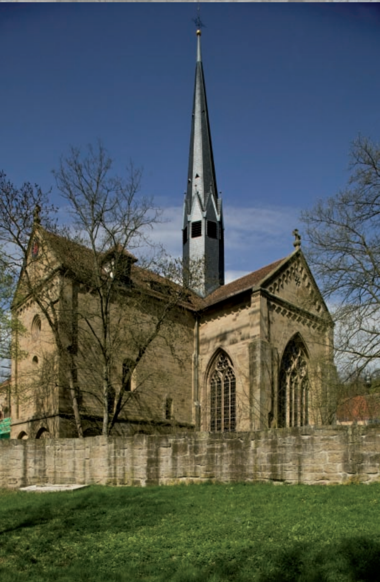
Choransicht der Kirche von Süden. Schon von weitem zieht der hohe, schlanke Dachreiter die Blicke auf sich, verweist auf den geistigen Kern des Konvents und versinnbildlicht gleichzeitig den Geltungsanspruch der Zisterzienser.
