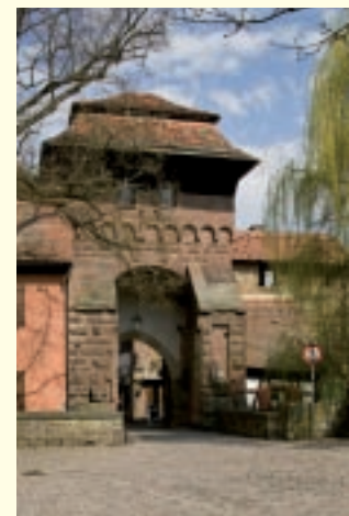
Der im 15. Jahrhundert verstärk- te Torturm demonstriert mit seinen Buckelquadern Wehr- haftigkeit und bildet heute den Hauptzugang zur Klosteranlage.
