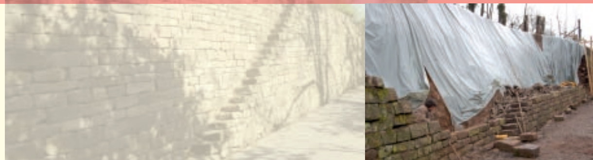
Im Januar 2011 wurde die schadhafte Trockenmauer des Klosterweinbergs instand gesetzt.
