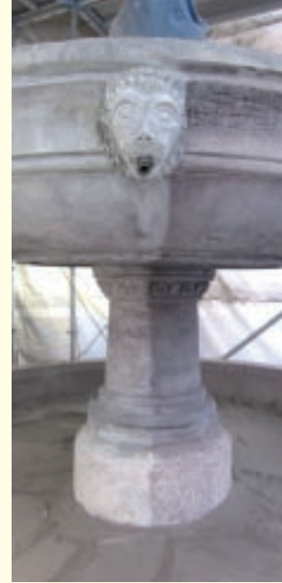
Die steinerne Brunnenschale während der Restaurierungsmaßnahme mit den Zuständen (rechte Seite) vorher und (links) nachher.
