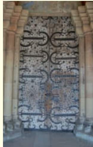
An den Türblättern des Hauptportals haben sich große Teile der originalen Pergamentverkleidung aus dem Mittelalter mit den dazugehörigen Metallbeschlägen erhalten.
