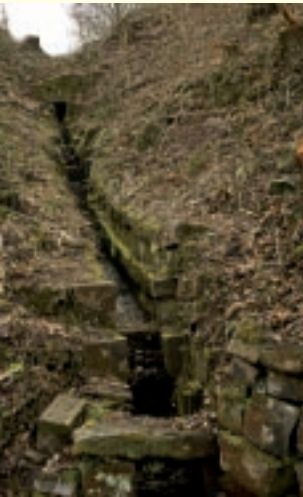
Ein ausgeklügeltes Grabensystem sammelte Oberflächenwasser in der Umgebung des Klosters und gewährleistete so ein verlässliches Frischwasserangebot.
