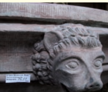
An einem Detail des Dreischalenbrunnens sind die Zustände vor und nach der Restaurierungsmaßnahme deutlich erkennbar.
