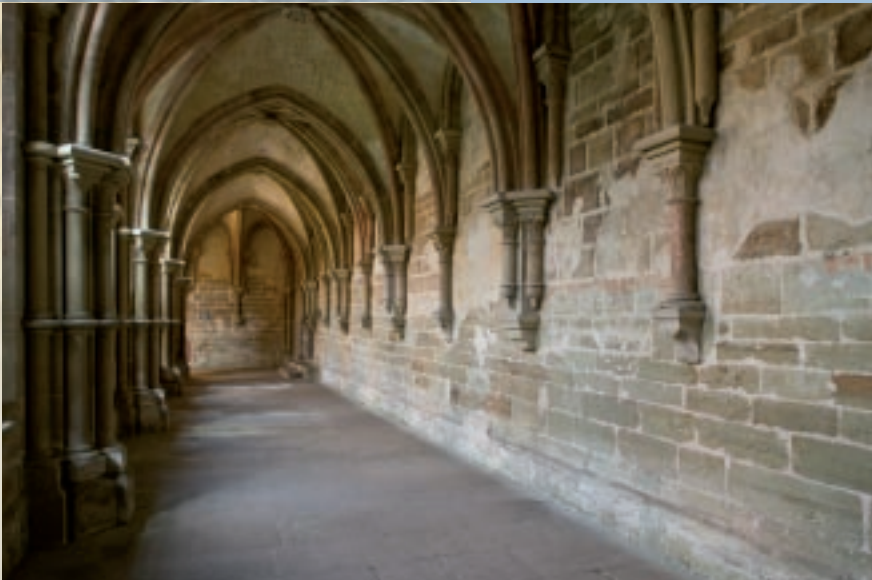
Im frühgotischen Südflügel des Kreuzgangs kamen die Mönche am Ende eines Tages noch einmal zu einer Andacht zusammen. Architektonisch trägt er die Handschrift des Paradiesbaumeisters, die Fenster sind noch ohne Maßwerk.
