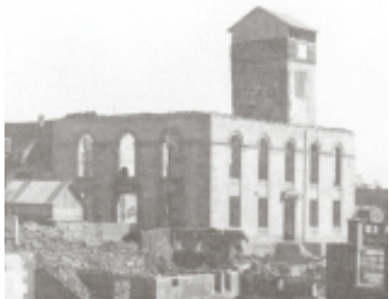
Die Kirchenruine 1945 mit dem Notdach über dem Kirchturm
