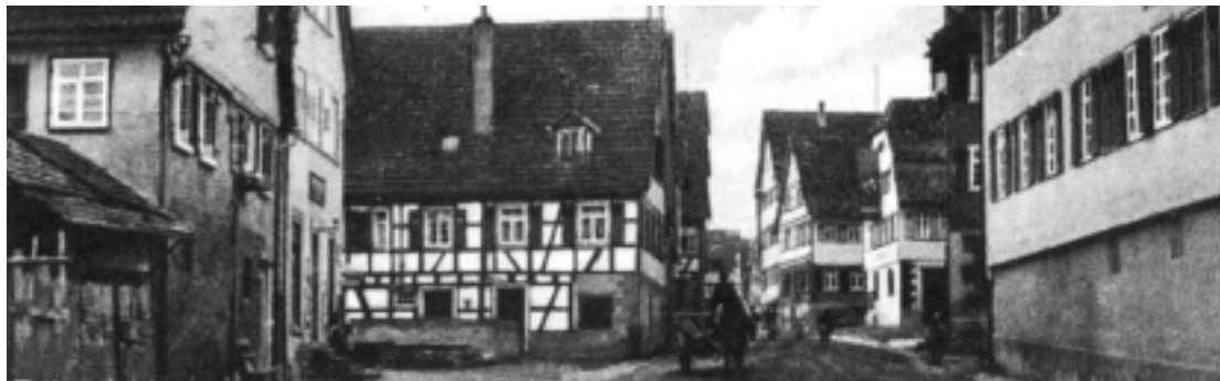
Die eng bebaute Ortsmitte in einer Fotografie der 1930er Jahre
