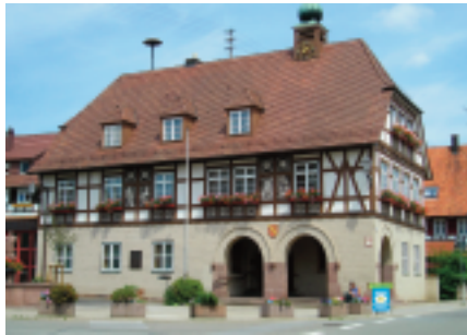
Das neue Rathaus in Stammheim
