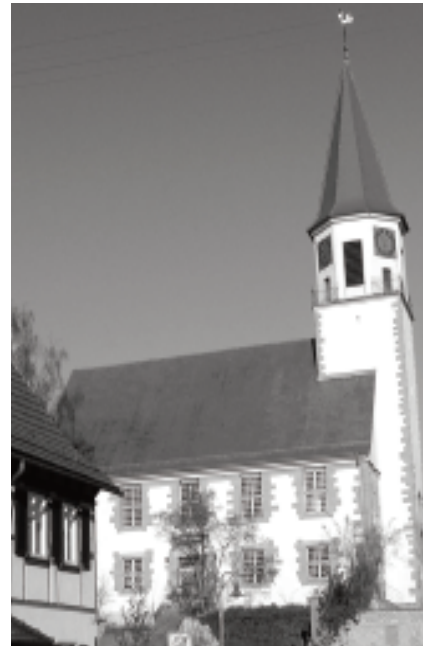
Das Ergebnis des Wiederaufbaus bis 1953. Auffälligster Unterschied zum Bauzustand vor 1945 war die in der Gemeinde umstrittene Absenkung der Traufe auf Kosten der Rundbogenfenster, das neue steilere Dach sowie der ganz neu gestaltete Turm.
