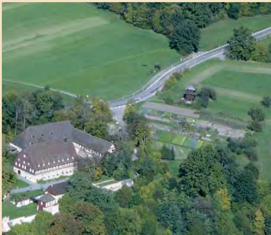
Abb. 23 | WP 12/14 in Nähe des Klosters Lorch, Holzturm in Block- bauweise, AA.
