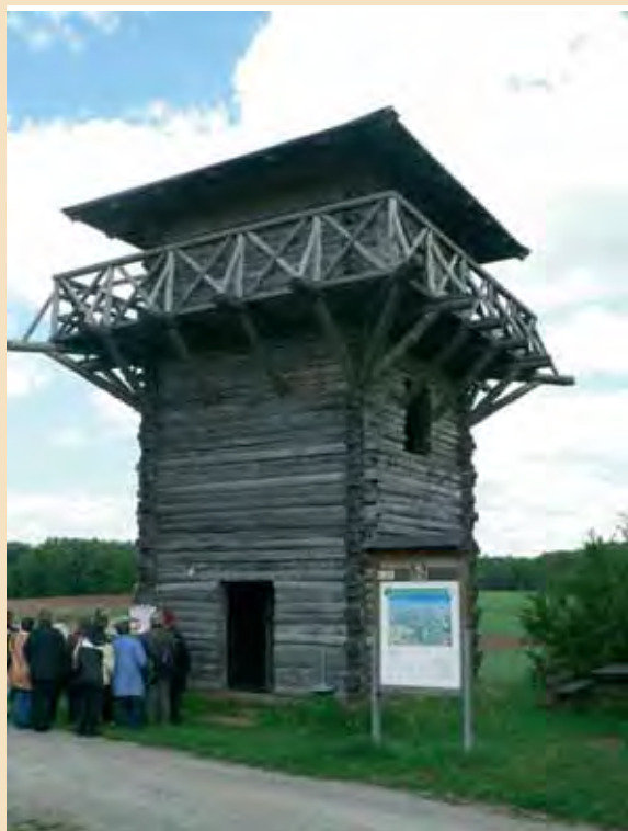
Abb. 22 | WP 9/64 bei Geißelhardt, Holzturm in Block- bauweise, SHA.
