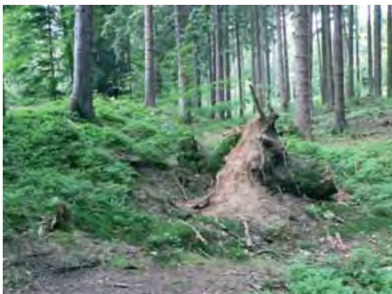
Abb. 5 | Beschädigung des erhaltenen Walles durch Ausriß eines Wurzeltellers beim Kleinkastell Ebnisee, WN.
