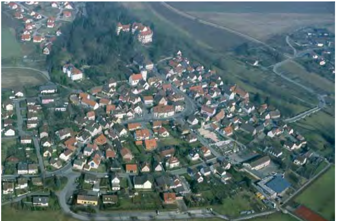
Abb. 64 | Jagsthausen mit dem konservierten Badegebäude in der Ortsmitte.
