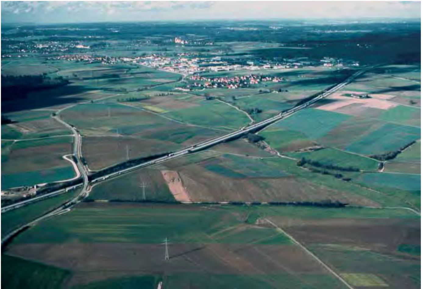
Abb. 83 | Ellwangen-Röhlingen, Limeshecke bei WP 12/86.
