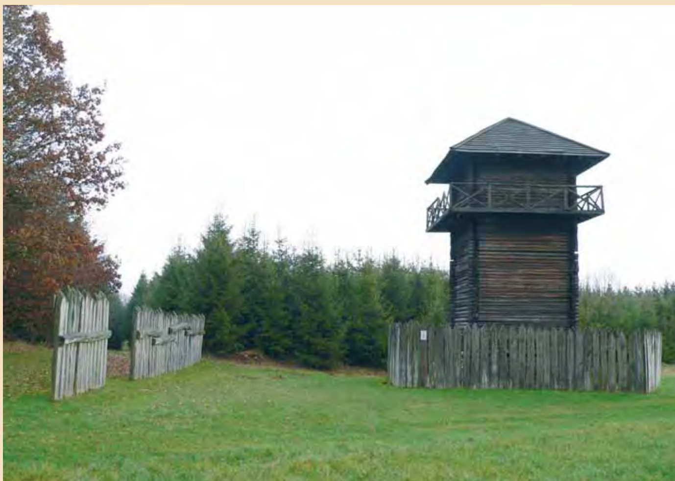
Abb. 24 | WP 12/77 in Rainau- Buch, Holzturm in Blockbauweise, erbaut 1966; wird 2007 erneuert, AA.
