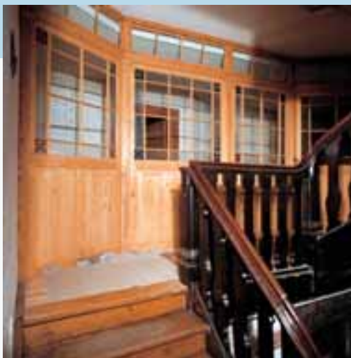
Schmuckverglaste Holzabschlüsse im prächtigen Barocktreppenhaus zeugen von der geschossweisen Wohnungsaufteilung im ausgehenden 19. Jh.
