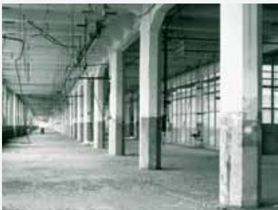
Hallenbau A 1 der IWKA. Obergeschoss. Rasterstruktur des Betonskelettbbaus.
