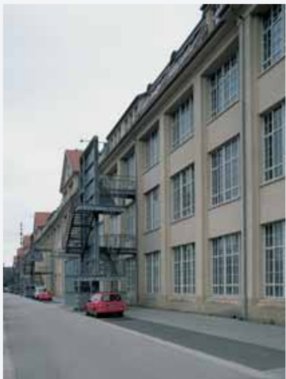
Der Westfront des Karlsruher Zentrums für Kunst und Medientechnologie (ZKM) wurden Fluchttreppen angefügt, die auf die ursprüngliche Architektur eingehen.
