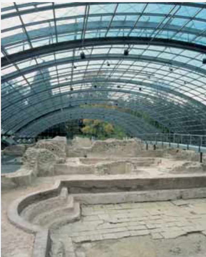
Eine dreischalige Glastonnenkonstruktion schützt seit 2001 die Ruine der römischen Therme von Badenweiler. Ungewöhnlich gut erhalten, gibt sie genauestens Auskunft über römische Baderituale.
