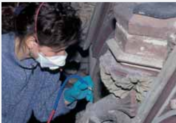
An diesem kleinen Wasserspeier kommt zur schonenden Reinigung das Microstrahlverfahren zum Einsatz.
