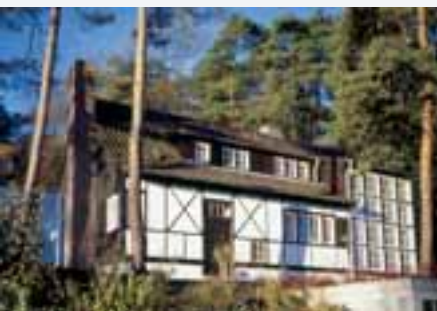
Vorderansicht des 1913 in Skelettbauweise für den Maler Erich Domes in Gerlingen erstellten Atelierhauses.
