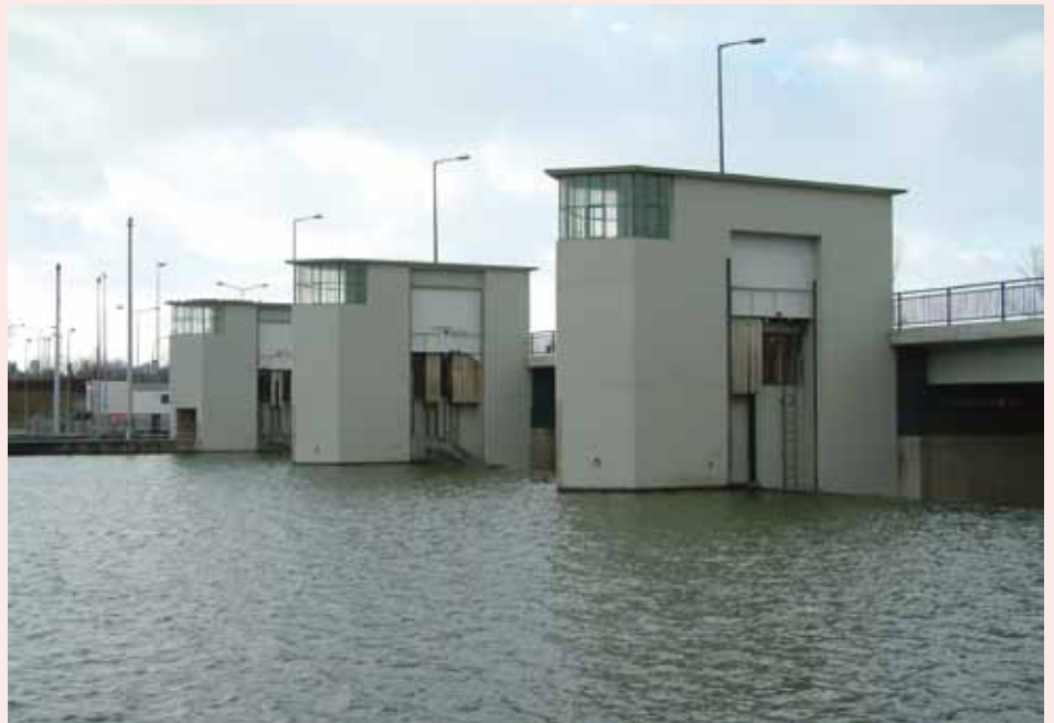
Die Staustufe Heilbronn wurde von 1950 bis 1952 als erste Weiterführung des Neckarkanal oberhalb von Heilbronn erbaut. Sie bildet den oberen Abschluss des 1935 im ersten Abschnitt eröffneten Kanalhafens. Die Sohlbreite des Kanals beträgt hier 80 m, drei Stauschütze weisen jeweils eine lichte Weite von 24 m auf. Mit Rücksicht auf ein älteres bestehendes Kraftwerk wurde hier kein Wehrkraftwerk ausgebaut.
