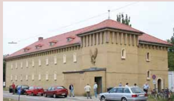
Luftschutzbunker beim Karlsruher Rheinhafen: 1942-43 errichtet, sollte er den Bewohnern der leicht gebauten Gartenvorstadt Schutz bieten. Der massive Betonbau versuchte seinen Zweck durch eine romantische Baurhetorik zu überspielen. Seine burgartige Gliederung mit Ziegeldach, Blindfenstern und einem Konsolgesims verleiht dem modernen Bunker ein mittelalterlich-trutziges Aussehen.
