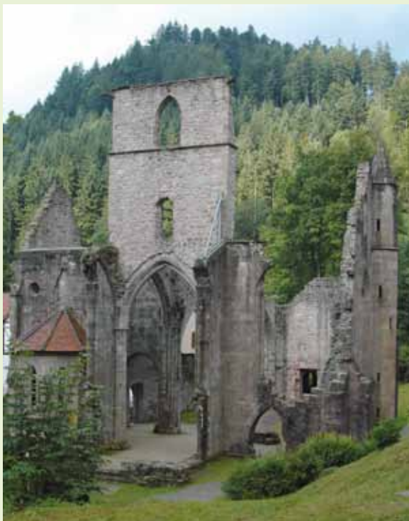
Aus dem 13. Jahrhundert stammen die Ostteile der Kirchenruine. Das Langhaus in spätgotischen Formen entstand nach einem Brand 1470 neu. Nach Einstellung der Abbrucharbeiten wurde seit 1844 durch den Konservator August von Bayer die Ruine vermessen und erste Restaurierungsmaßnahmen durchgeführt.
