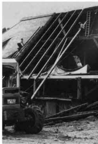
Abb. 231 Vollständige Erneuerung der Rafen. Schwarzbauernhof.
