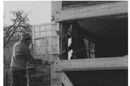
Abb. 258 Ein Fenster wird zwischen Brust- und Sturzriegel eingeschoben. Restaurierung am Bruckhof in Lauterbach.
