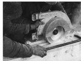
Abb. 198 Mobile Fräse beim Ausheben eines Schlitzes für eine Ständer-Bohlenwand.
