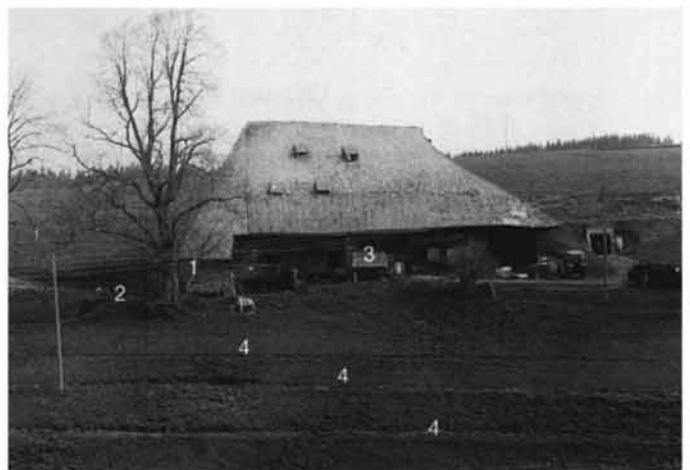
Abb. 119 Abwassersystem des Oberen Geschwendhofes vor der Sanierung. 1 Abtritt, 2 Weiher, 3 Brunnen, 4 Grabensystem.
