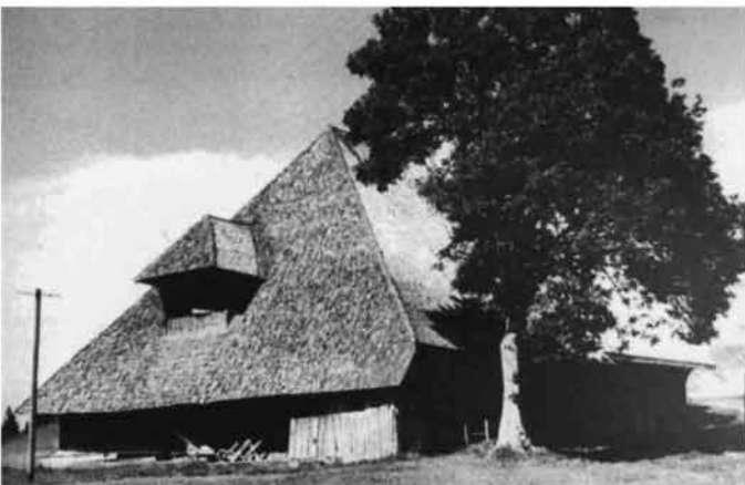
Abb. 73 Jockelhof in Furtwangen-Rohrbach mit nachträglich angebrachter Gaube zur Belichtung und Belüftung der Fahr.
