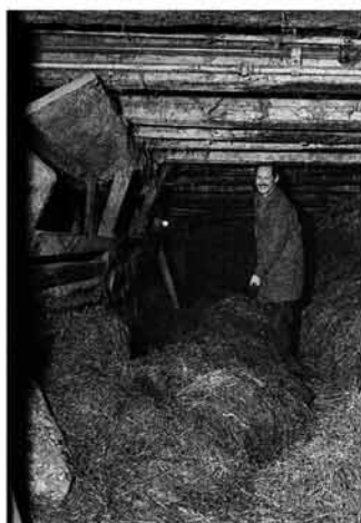
Abb. 212 Fehlende Kopfhöhe im Stall.
