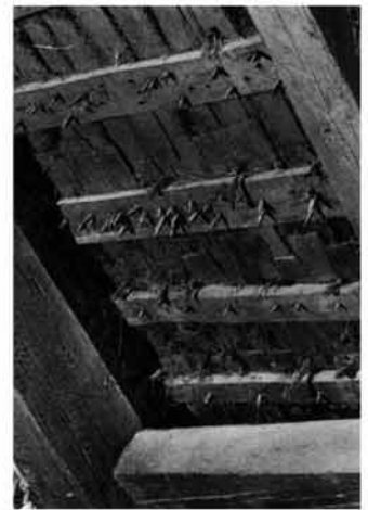
Abb. 232 Dachinnenseite mit Holznägeln und Binsenknoten. Reinertonishof.
