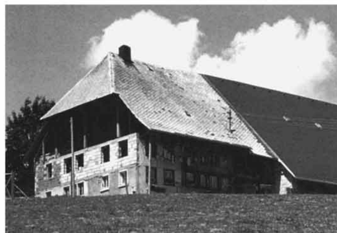
Abb. 185 Konsequenz der harten Anwendung von Brandschutzbestimmungen: Abriß und Wiederaufbau des Wohnteils in Massivbauweise.
