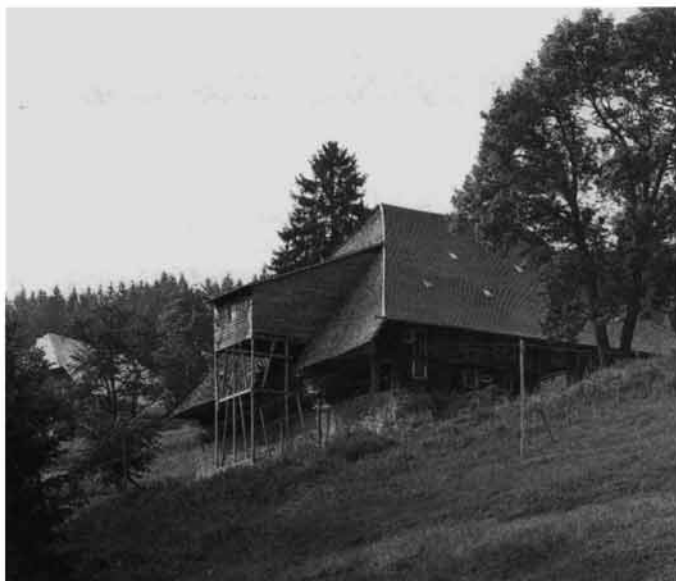
Abb. 415 Vor den Sanierungsarbeiten mit angebauter Überdachung eines inzwischen abgebrochenen Silos.
