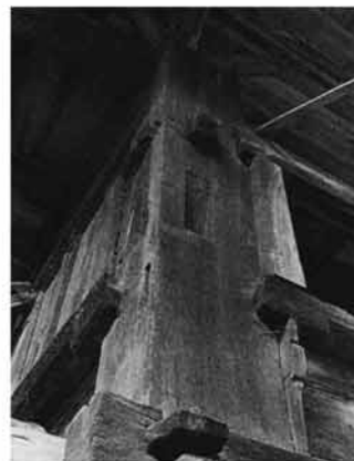
Abb. 258 Ein Fenster wird zwischen Brust- und Sturzriegel eingeschoben. Restaurierung am Bruckhof in Lauterbach.
