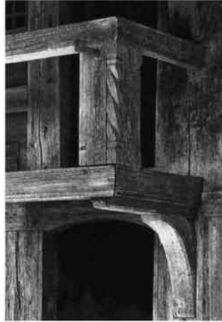
Abb. 222 Eckpfosten mit Leiterhaken und Geländer ohne Füllung am Reinertonishof.
