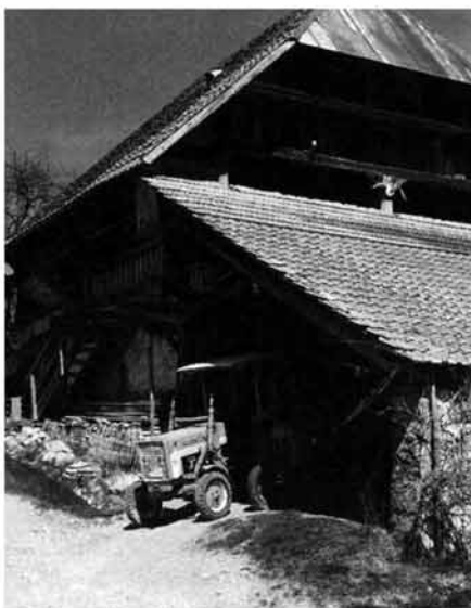
Abb. 324 Speicher in Welschensteinach mit häufig anzutreffendem Anbau eines Schopfes.
