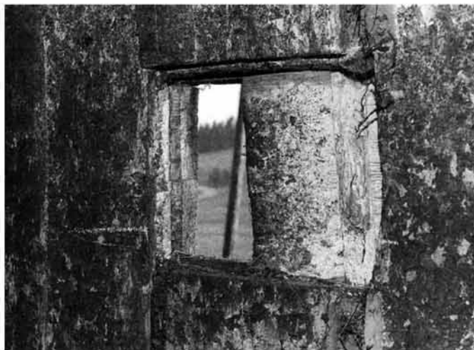
Abb. 271 Typischer Umbau aus dem 19. Jahrhundert: Fenstereinbau im Obergeschoß, Aufmauerung der Brüstung im Erdgeschoß, Fenster mit Drehflügeln, Außenwandverschalung und Brettfüllung der Gangbrüstung mit Zierschnitten.
