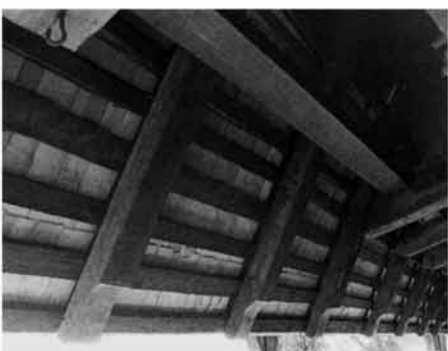
Abb. 230 Traufenuntersicht nach der Reparatur. Reinertonishof.
