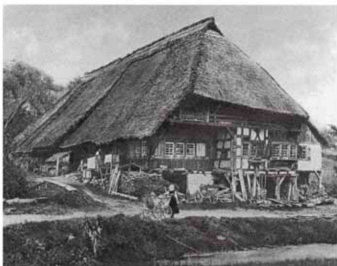
Abb. 48 Der eingeschossige Oberbauernhof in Gutach (1590) wurde nachträglich für zwei Familien längsgeteilt und die Küche bis zur Trippelflucht verlängert.
