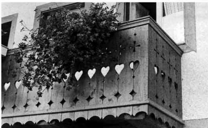
Abb. 224 Erneuerung eines Balkons unter Verwendung der alten Zierschnitte an einem Haus in Welschensteinach.
