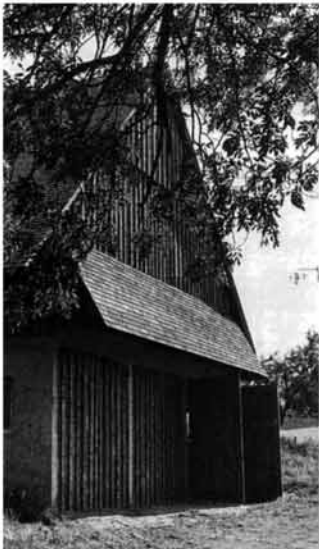
Abb. 327 und 328 1980 errichteter Schopf beim Oberen Geschwendhof.
