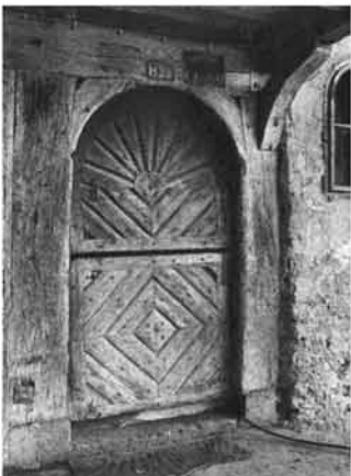
Abb. 248 Aufgedoppelte halbierte Tür am Hummelhof in Freiamt-Siegelau.
