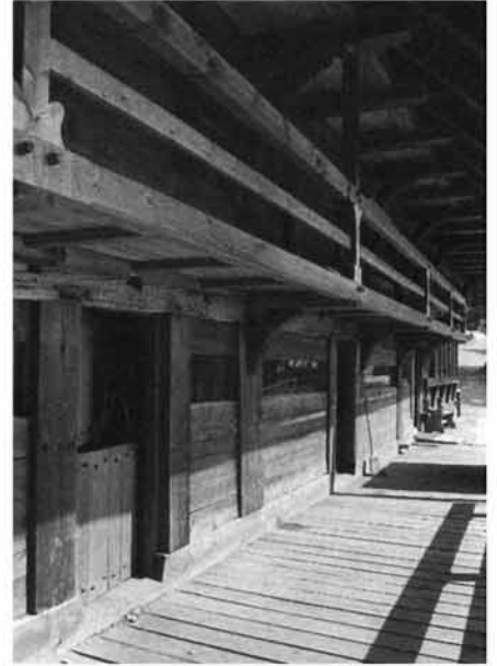
Abb. 358 Stallseite mit Bruck und »Gang« nach der Reparatur.
