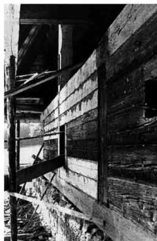
Abb. 217 Alte und neue Wandbohlen einer reparierten Stallaußenwand. Reinertonishof.
