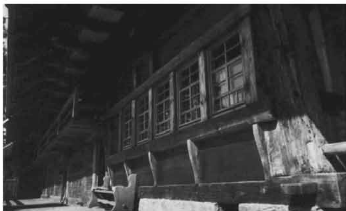
Abb. 273 Stubenfenster als Verbundfenster am Oberen Geschwendhof nach der Sanierung.
