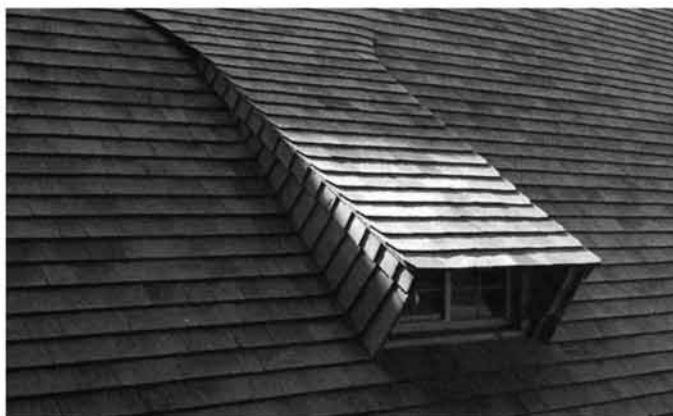
Abb. 242 Schleppgaube am Oberen Geschwendhof. ▼
