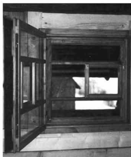
Abb. 275 Neues Kastenfenster mit Schiebeelementen ohne Sprossen in einer Gesindekammer. Hermeshof Vöhrenbach.
