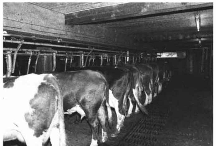
Abb. 126 Entmistung durch Treibmistkanäle unter Gitterrosten in Verbindung mit Kurzstand-Anbindehaltung. Oberer Geschwendhof.
