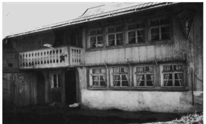
Abb. 271 Typischer Umbau aus dem 19. Jahrhundert: Fenstereinbau im Obergeschoß, Aufmauerung der Brüstung im Erdgeschoß, Fenster mit Drehflügeln, Außenwandverschalung und Brettfüllung der Gangbrüstung mit Zierschnitten.
