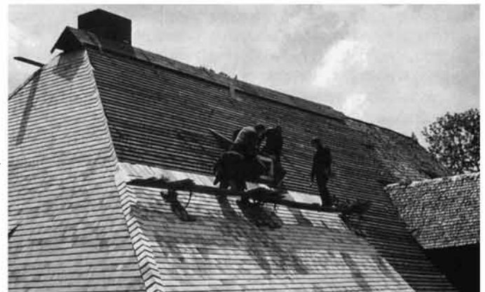
Abb. 244 Zweiseitiger Lüftungsfirst am Oberen Geschwendhof.
