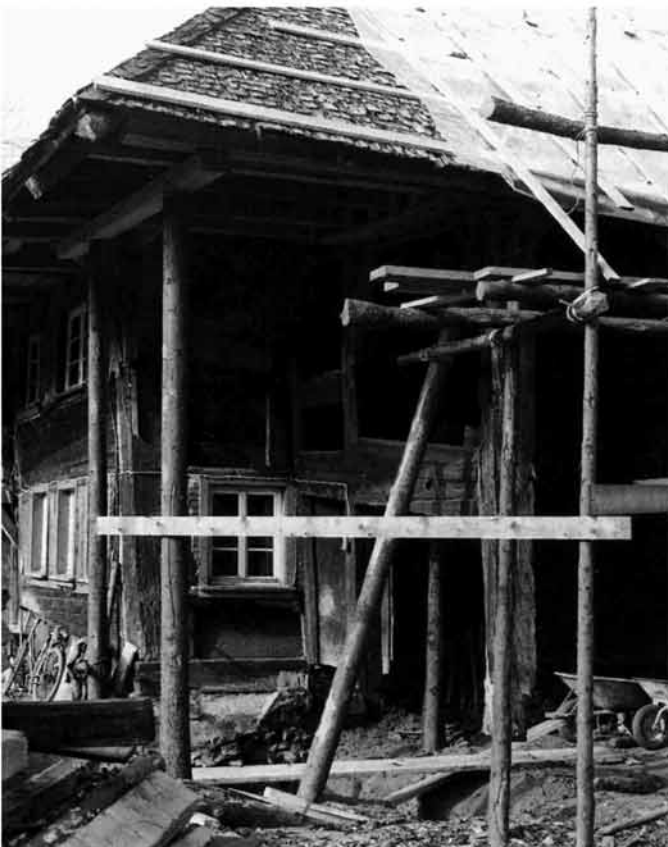
Abb. 155 Sprießarbeiten am Wohnteil des Oberen Geschwendhofes.
