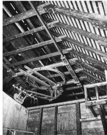
Abb. 339 Dachraum mit Greiferkran, Gärfuttersilo (links unten) und Heutrocknungskasten (unten).
