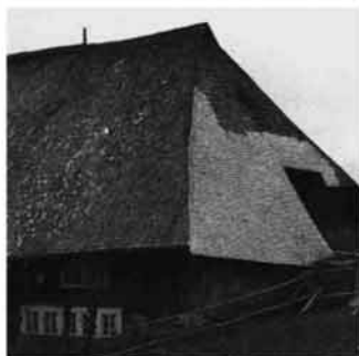
Abb. 56 Kippgauben und Ahnenstänge am Reinertonishof in Schönwald 1619.
