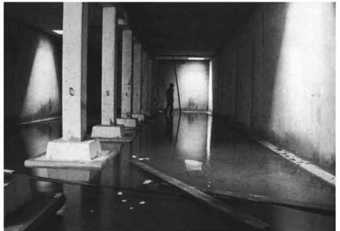
Abb. 124 Flüssigmistgrube des Oberen Geschwendhofes.
