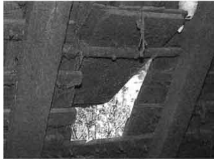
Abb. 241 Das einfache Prinzip der Kippgaube läßt sich auch bei der Sanierung wieder anwenden. Neue Kippgaube am restaurierten Reinertonishof.
