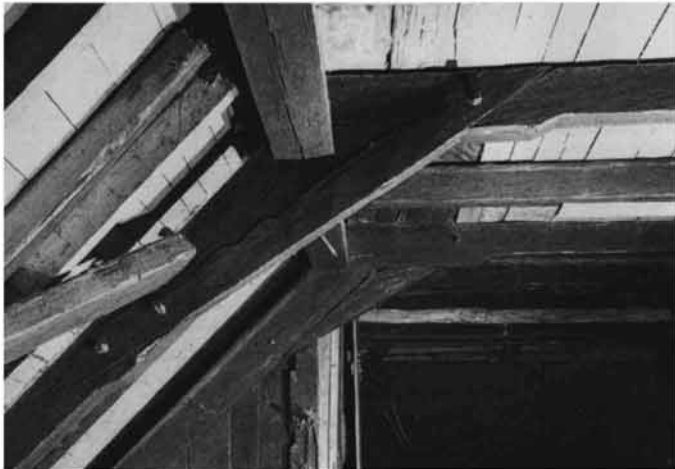
Abb. 67 Verblattetes Kopfbalken zwischen Kehlbalken und Bundstrebe im Danielshof in St. Märgen 1575.
