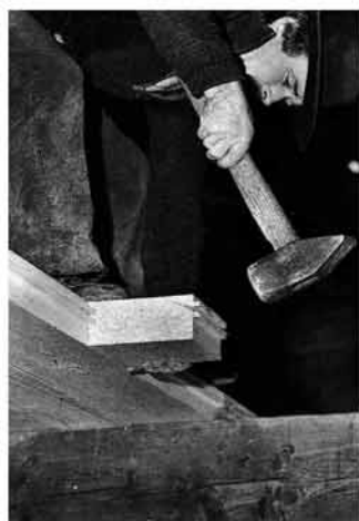
Abb. 213 Montage der freigespannten, 8 cm dicken Bohlendecke im Stall.
