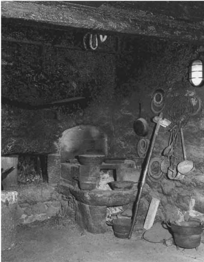
◀ Abb. 172 Herd, Feuerungsöffnung des Kachelofens und Rauchhurt im Reinertonishof.
