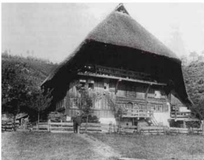
Abb. 47 Der zweigeschossige Hintere Schlauchbauernhof in Gutach (1914 abgebrannt) zeigt im Küchenbereich die ursprüngliche Holzbauweise mit Rauchgatter und vorgelagertem Küchenausgang.
