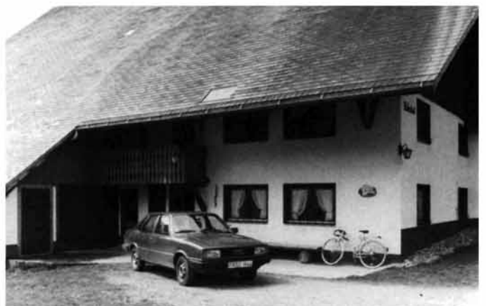
Abb. 272 Das Gebäude aus Abb. 271 nach einem weiteren Umbau: Verputzte Massivwand, liegende Fensterformate. Durch diese Veränderungen hat das Gebäude viel von seiner ursprünglichen Identität eingebüßt.
