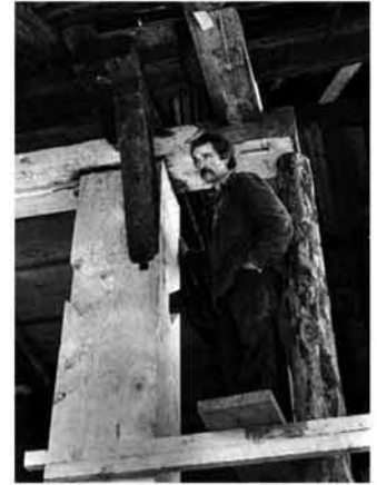
Abb. 204 Ausgewechselte Eckstütze an einem sanierten Hof in Bernau-Innerlehen.
