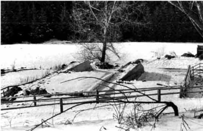
Abb. 134 Fahrsilos eines Betriebes im Brigachtal auf ca. 920 m Höhe.
