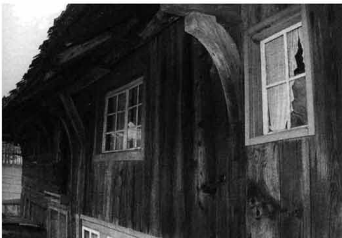
Abb. 359/361 Libdingsanbau vor der Sanierung.
