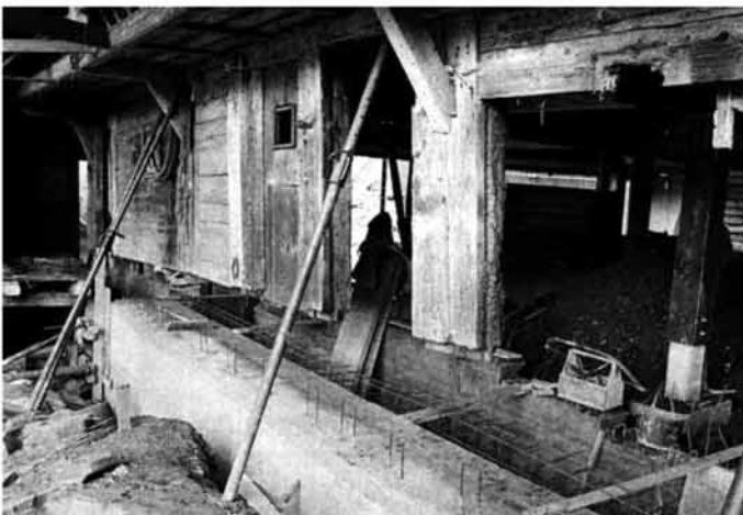
Abb. 123 Herstellung des Querkanals für das Treibmistsystem im Oberen Geschwendhof.
