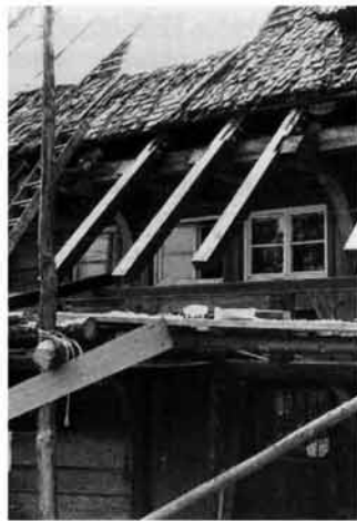
Abb. 228 Angesetzte Rafen. Reinertonishof.
