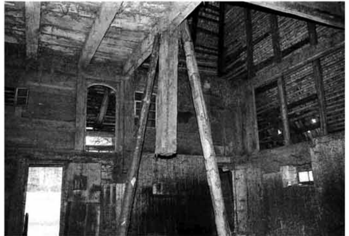
Abb. 156 Sprießung eines abgenommenen Stuhlständers im Stallteil des Oberen Geschwendhofes.
