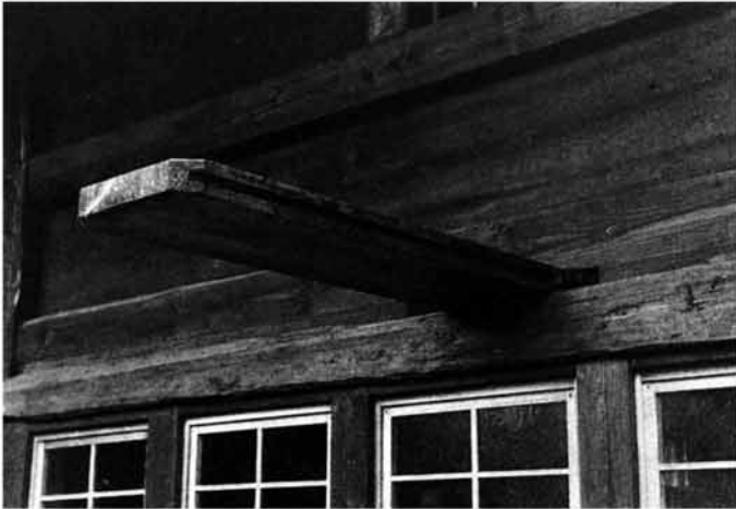
Abb. 210 Der »Schub«, die keilförmige Bohle zum Nachspannen der Stubendecke.
