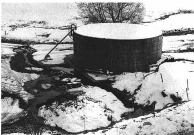
Abb. 128 Offener Flüssigmisthochbehälter bei einem Schwarzwaldhof: Falsche Bemessung oder Unwägbarkeiten der Niederschläge können zum Überlaufen und damit zu gravierenden Belastungen der Gewässer führen.
