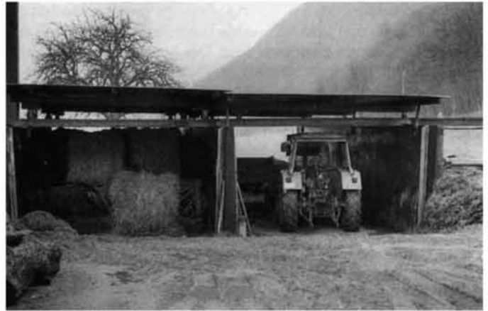
Abb. 137 Überdachte Fahrsilos. Zur Befüllung werden die Dächer auf Schienen seitlich weggeschoben.
