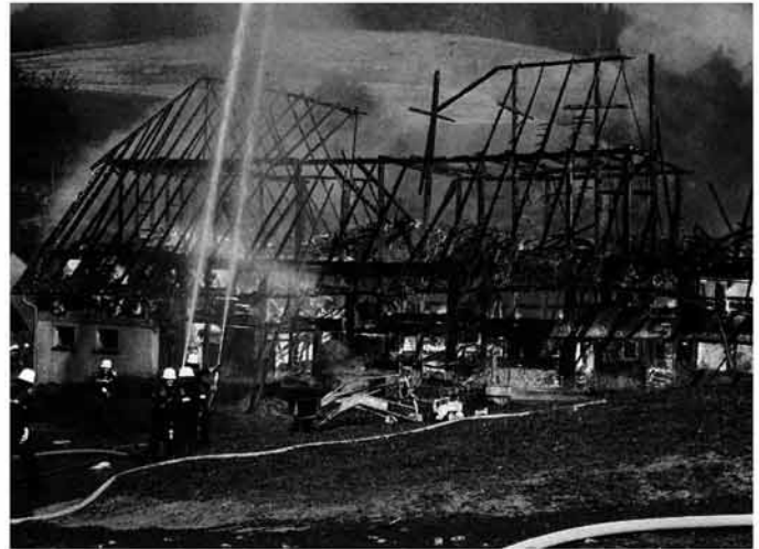
Abb. 189 Im Brandfall widerstehen die Holzstützen der Ständerkonstruktionen lange Zeit dem Feuer.
