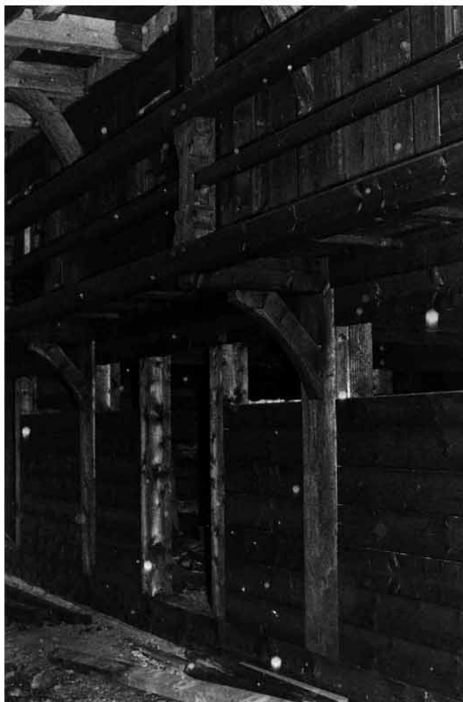
Abb. 402 Stallteil des Hermeshofes, Fassadenausschnitt nach der Maßnahme. Die ursprüngliche Erdgeschoßwand und der Gang vor den Gesindekammern waren bei einem früheren Umbau beseitigt worden.
