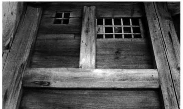
Abb. 266 Hausgangfenster am Reinertonishof.
