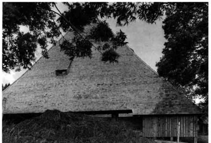
Abb. 344 Westseite nach der Sanierung.
