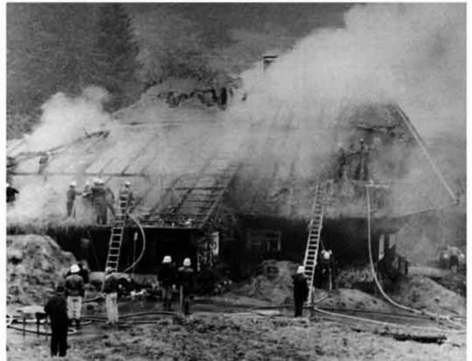
Abb. 187 Totalschaden durch Heu-Selbstentzündung.
