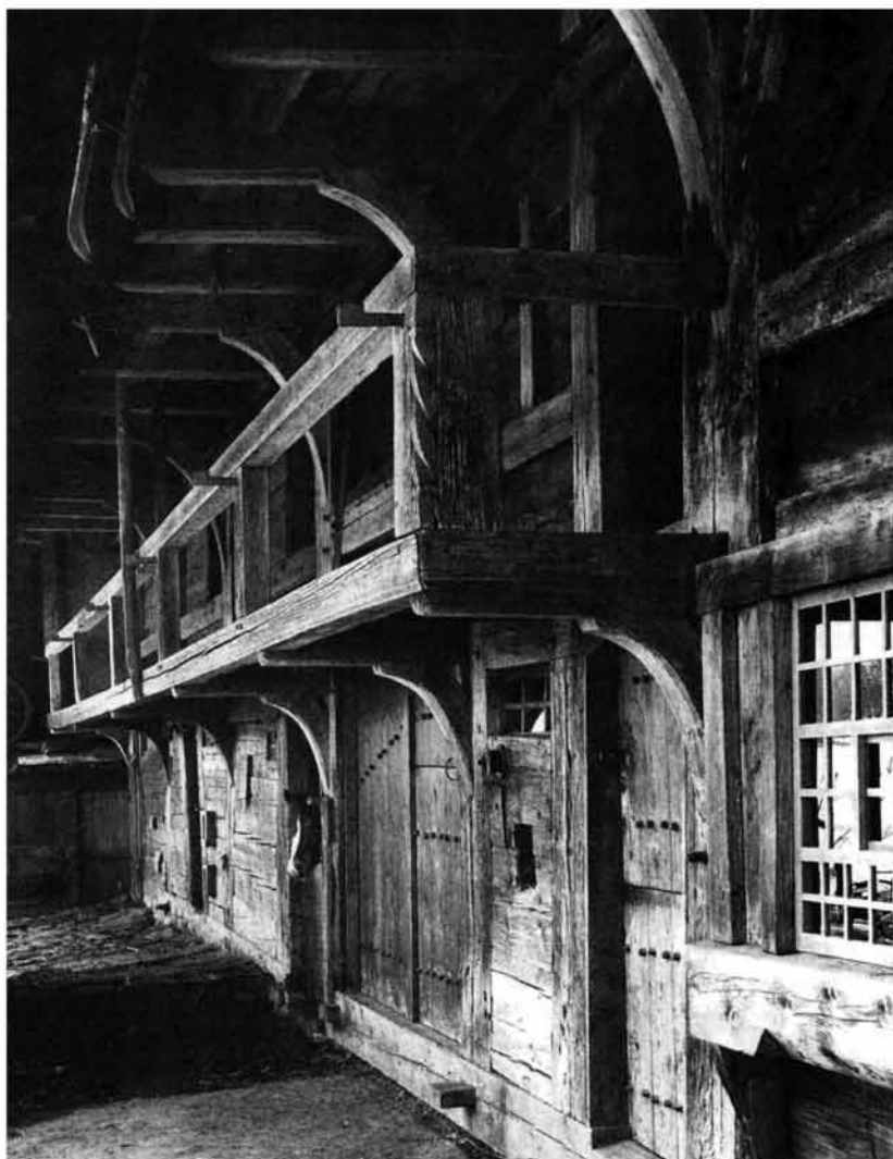
Abb. 399 Restaurierte Außenwand an der Eingangsseite.
