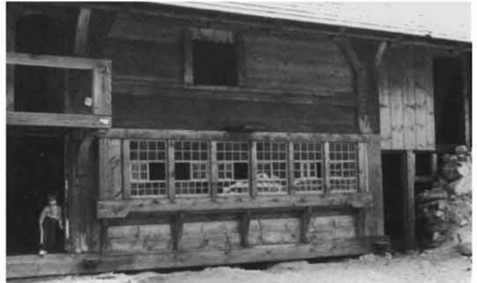
Abb. 270 Ursprüngliche Form des Fenstererkers. Reinertonishof während der Restaurierungsarbeiten.
