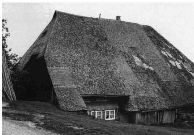
Abb. 68 Nachträglicher zweigeschossiger Leibgedingebau im Reinertonishof in Schönwald aus dem 18. Jh.
