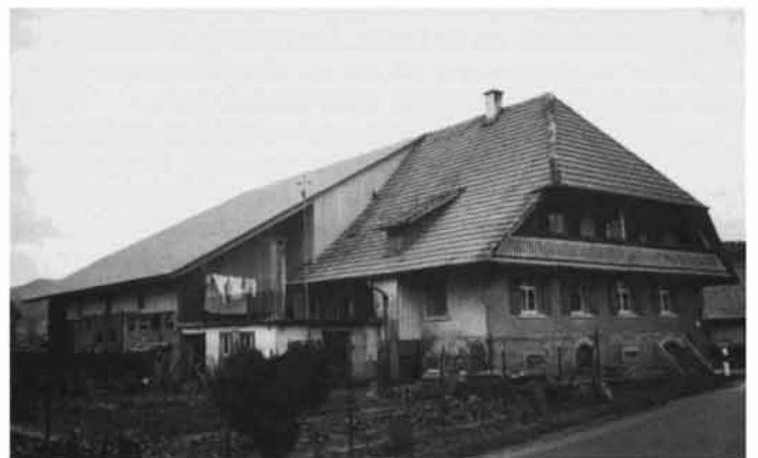
Abb. 5 Auch die Erweiterung mit großflächiger Aufklappung des Daches kann nicht befriedigen. (Hof in Zell a. H. Unterentersbach)
