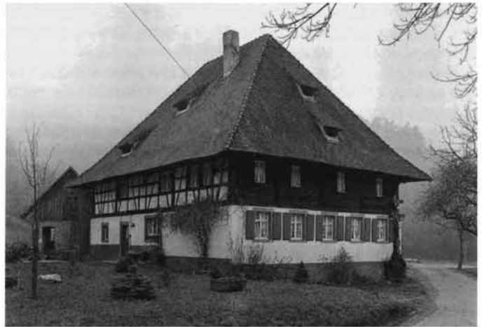
Abb. 74 Kreuzbauernhof in Glottertal-Föhrental 1784 mit massivem Erdgeschoß, dreiseitiger Ständer-Bohlen-Konstruktion und Fachwerkwand an der Rückseite des Obergeschosses.
