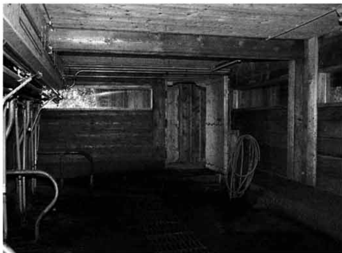
Abb. 211 Erneuerter Stallprofil und freigespannte Bohlendecke im Oberen Geschwendhof.
