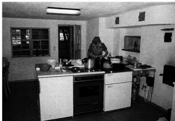
Abb. 107 Küche des Oberen Geschwendhofes nach der Sanierung mit Installationsblock. An der Wand zur Stube hin (rechts im Bild) die Durchreiche und die Feuerungstür des Kachelofens.
