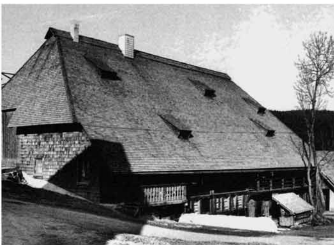
Abb. 379 Nach Fertigstellung. Die Wiederkehr ist beseitigt, das neue Leibgeding unter der Dachfläche untergebracht.
