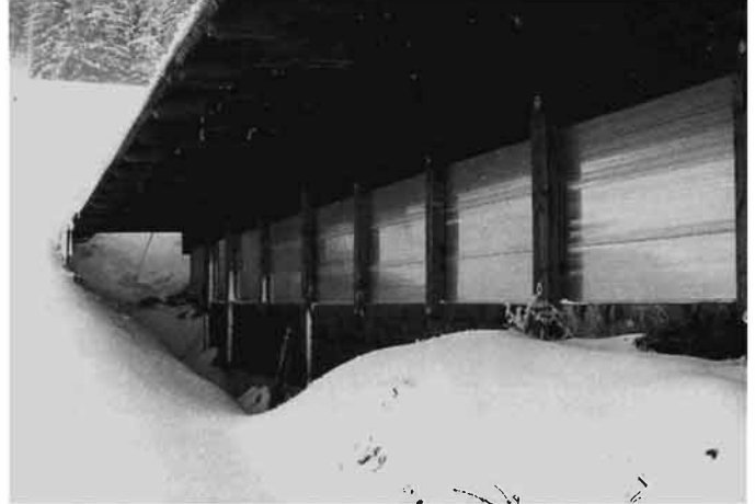
Abb. 338 Die Funktion der niederen, umlaufenden Traufe und des großen Dachüberstandes wird besonders im Winter deutlich.
