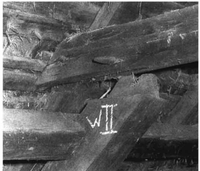
Abb. 85 Gelöster Knotenpunkt (siehe Abb. 84 Bundachse B).
