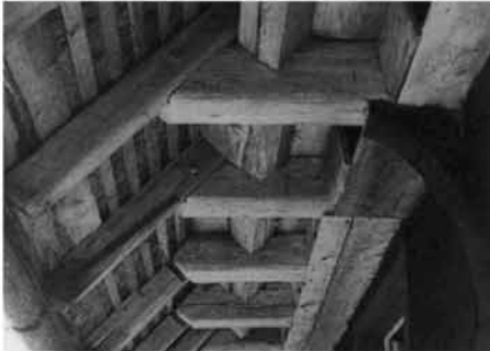
Abb. 225 In früherer Zeit gekürzte Rafenenden. Bühlhof in Gütenbach.
