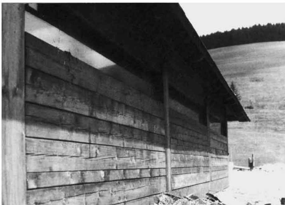
Abb. 282/283 Feststehende Verglasung mit Isolierglasscheiben am Stall des Oberen Geschwendhofes und des Schwarzbauernhofes.
