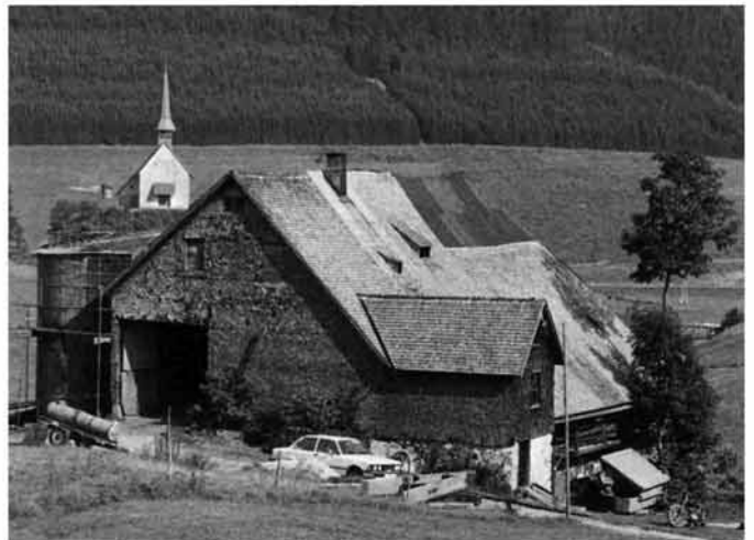
Abb. 378 Bergseite mit giebelförmiger Verlängerung und seitlicher Wiederkehr vor Beginn der Sanierungsarbeiten.
