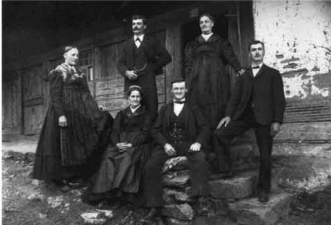
Abb. 71 Historischer Lehmputz auf Lattenrost vor der Ständer-Bohlen-Konstruktion des Wohnteils (im Bild rechts oben).
