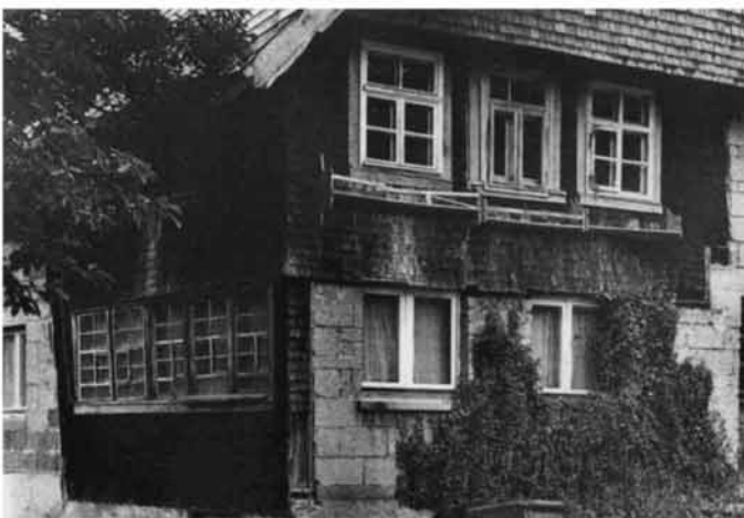
Abb. 8 Dieses Beispiel zeigt die allmähliche Zerstörung durch kleine Eingriffe: früher die Beseitigung des Walmes, dann Einbrechen neuer Fenster und Schindelanschlag, in jüngster Zeit Austausch der Bohlenwände durch Hohlblockmauerwerk.
