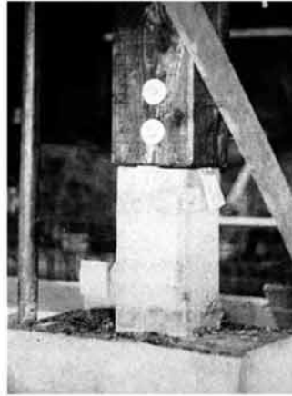
Abb. 203 Eingebauter Stützenfuß.
