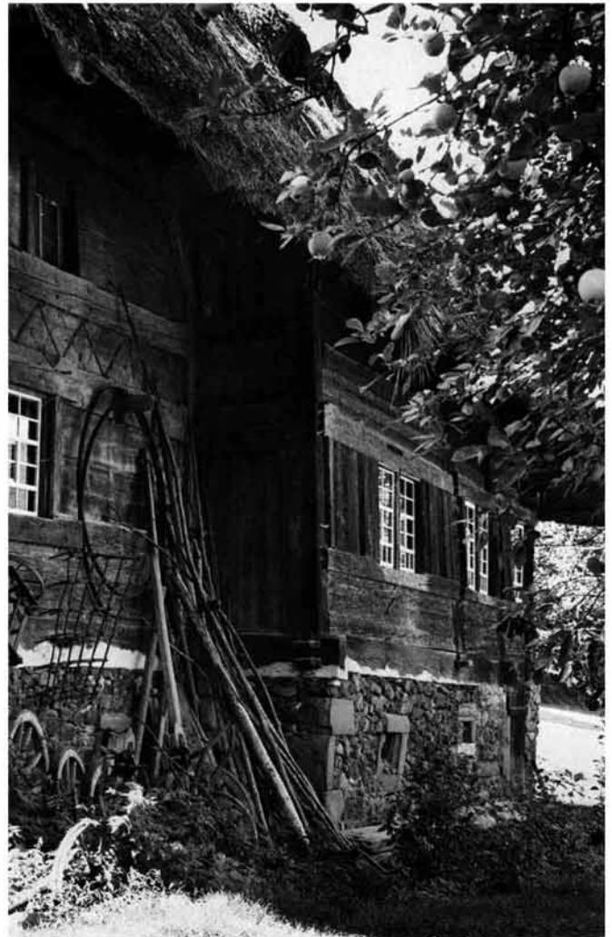
Abb. 220 Mauerwerkssockel am Flammhof 1713 in Glottertal.
