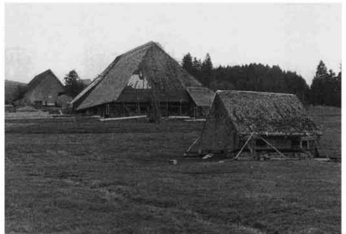
Abb. 396 Während der Sanierungsarbeiten.
