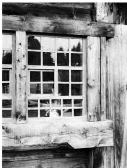
Abb. 273 Stubenfenster als Verbundfenster am Oberen Geschwendhof nach der Sanierung.
