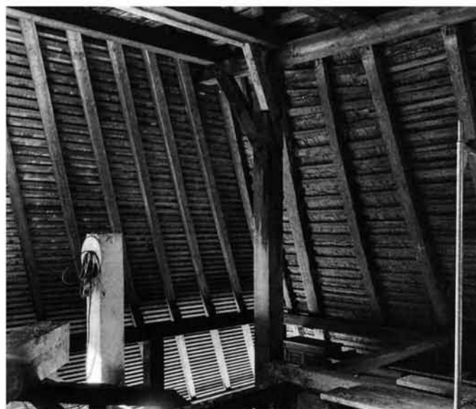
Abb. 418 Aus dem gleichen Blickwinkel wie Abb. 417 nach den Reparaturarbeiten.
