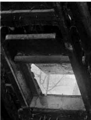
Abb. 241 Das einfache Prinzip der Kippgaube läßt sich auch bei der Sanierung wieder anwenden. Neue Kippgaube am restaurierten Reinertonishof.
