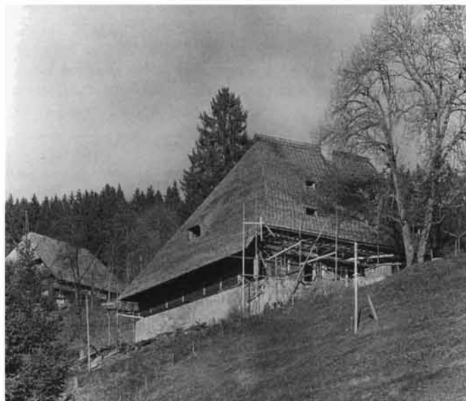
Abb. 416 Nach dem ersten Abschnitt der Sanierung.
