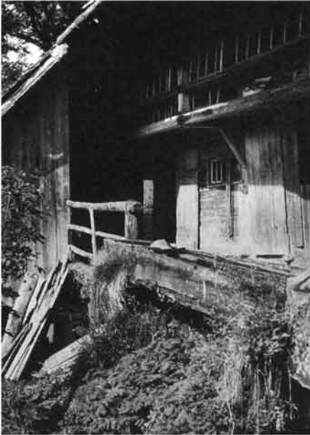
Abb. 357 Stallseite mit Bruck und Brunnentrog vor Beginn der Arbeiten.
