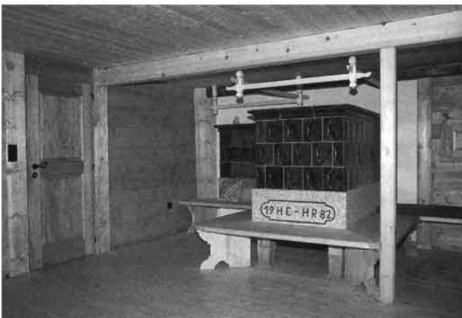
Abb. 177 Erneuerter Kachelofen mit Ofensteinen aus Granit. Die Ofenkacheln sind nachgefertigt. Stube des Oberen Geschwendhofes nach der Sanierung.
