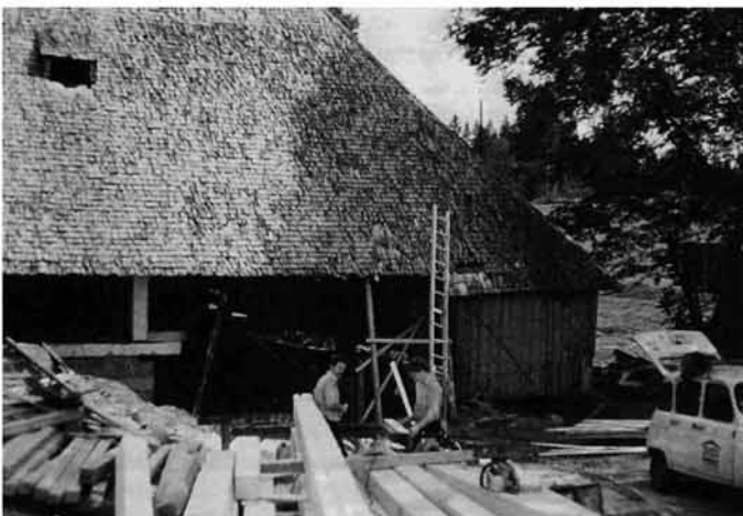
Abb. 343 Wetterseite während der Bauarbeiten.
