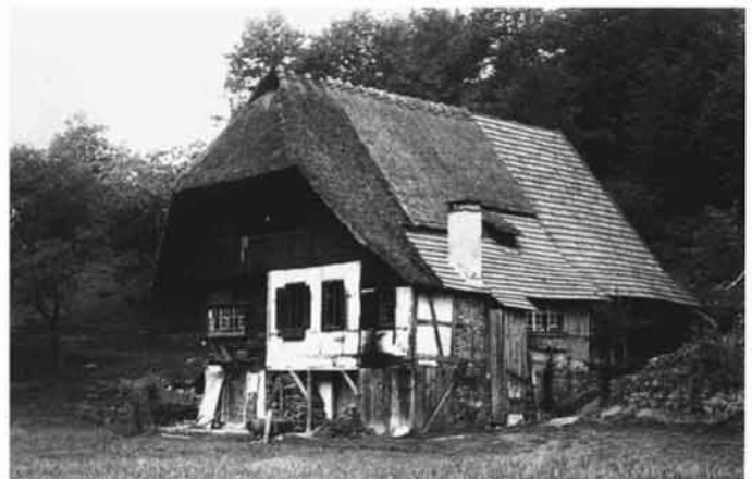
Abb. 35 Schlafkammererweiterung aus dem 19. Jh. im Bereich des ehemaligen Kammertrippels (Kinzigtäler Haus im Schapbachtal).
