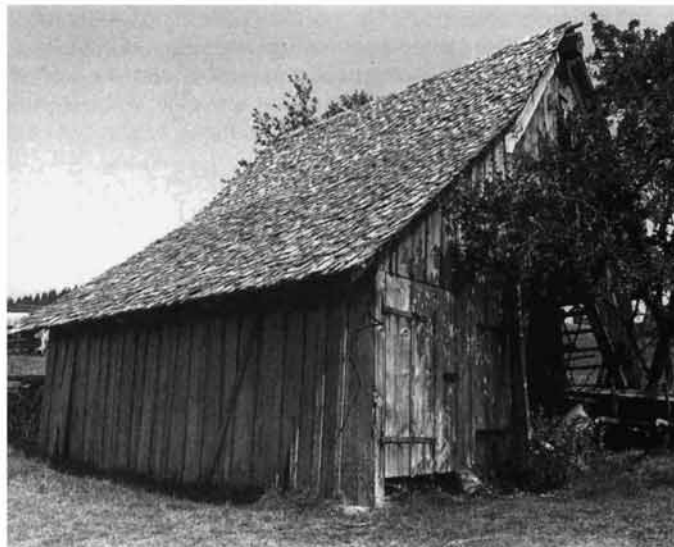
Abb. 401 Speicher beim Reinertonishof.
