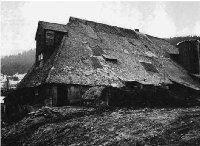
Abb. 377 Vor Beginn der Sanierungsarbeiten.
