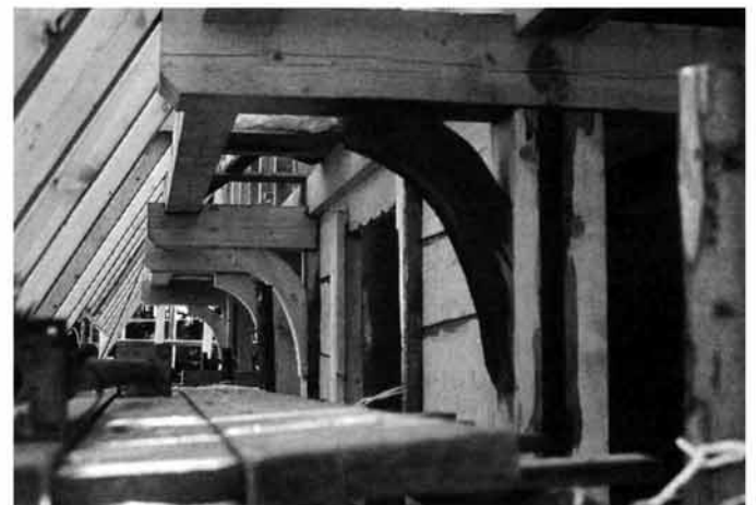
Abb. 362 Traufseite am Libding im Rohbau.
