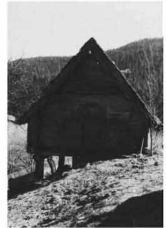
Abb. 301 Gefährdeter Speicher beim Hansjörgbauern in Vöhrenbach-Schwanenbach.
