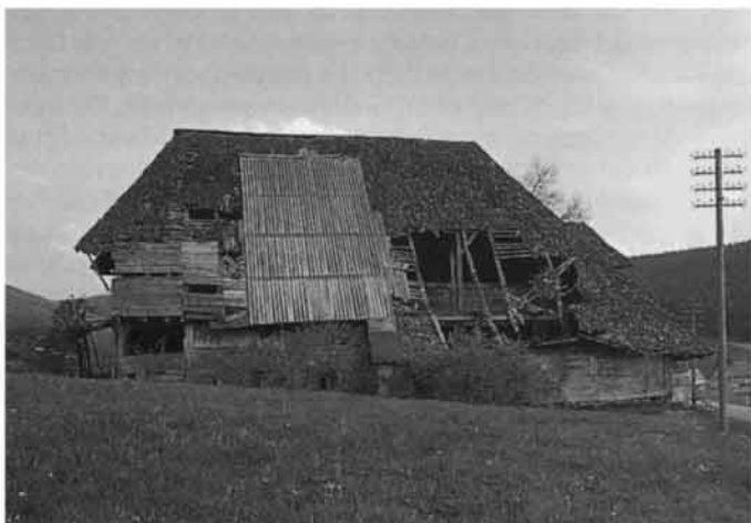
◀ Abb. 2 Typisches Bild eines über längere Zeit leerstehenden, dem Verfall preisgegebenen Schwarzwaldhauses. (Jockelhof in Rohrbach)
