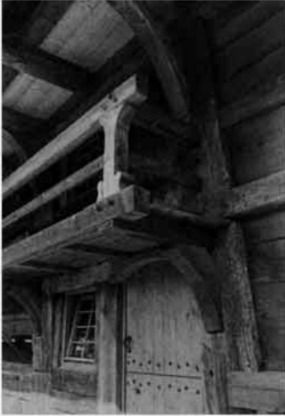
Abb. 221 Zusätzliche Sicherung des Geländers durch Zwischenholz am Oberen Geschwendhof.
