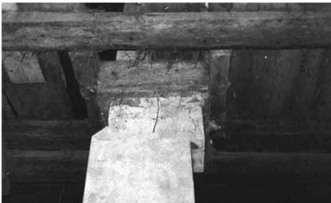
Abb. 181 Durch fehlerhafte Tragwerksausführung zerstörter Schornstein in einem Schwarzwaldhaus. Diese gefährliche Situation ist durch zwei Baufehler verursacht: 1. Das Holztragwerk ist nicht genügend aussteift. 2. Gebäude und Schornstein sind starr miteinander verbunden.
