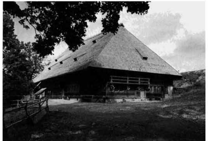
Abb. 342 Der Obere Geschwendhof nach Abschluß der Sanierung.
