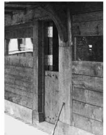
Abb. 251 Erneuerte Tür mit Wärmedämmung am Oberen Geschwendhof.
