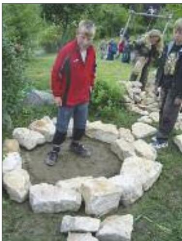
**3.** Das Fundament der Trockenmauer wird aus großen und möglichst flachen Steinen gebildet. Es ist durchaus möglich, die Mauer durch eine zweite Steinreihe breiter und somit stabiler zu machen.
