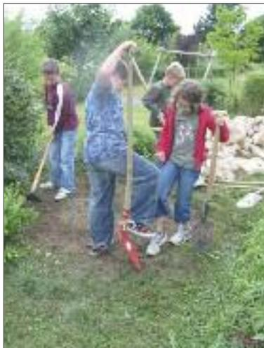
**2.** Anschließend wird die Grasdecke abgetragen und ein ungefähr 30 cm tiefes Loch für das Fundament ausgehoben. Um eine ebene und stabile Basis zu erhalten, kann man das Fundament zusätzlich mit einer Mischung aus Kies und Schotter aufschütten.
