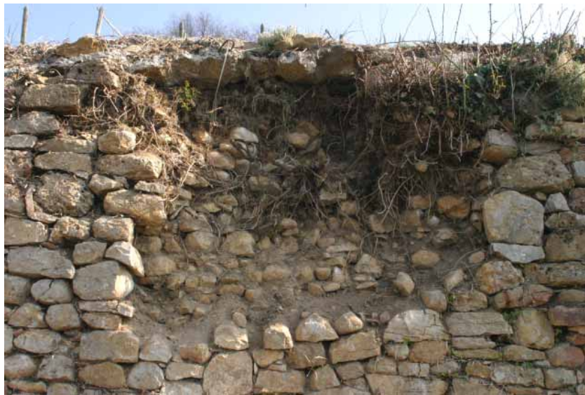
Eingestürzte Trockenmauer
