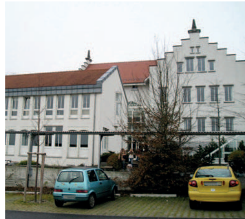
Die Realschule Altshausen (1870) mit angebautem Zeichensaal (1904)
