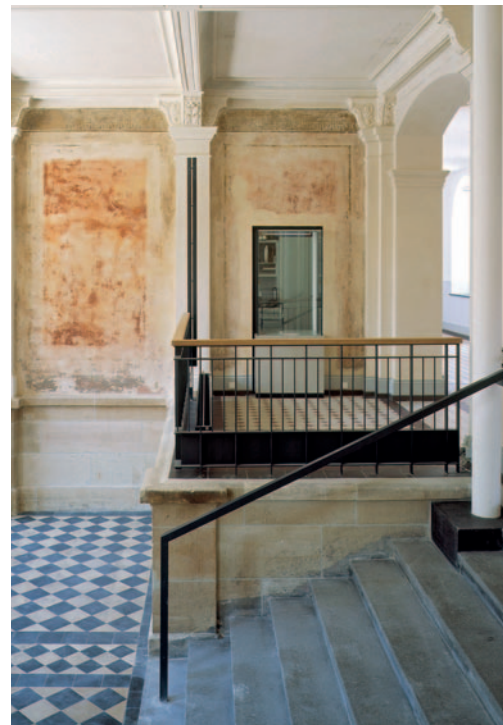
Der kunstvoll ausgestaltete Haupteingang mit Treppe im ehemaligen Schelztorgymnasium Esslingen (1876) beeindruckt.
