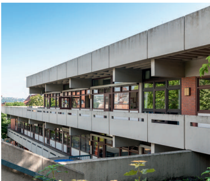
An den Fugen der Fassade deutlich ablesbarer Systembau an der Lehen- / Immenhoferschule, Stuttgart (1965). Ein Doppelschulhaus mit zwei Atrien des Architekturbüros Kammerer+Belz.
