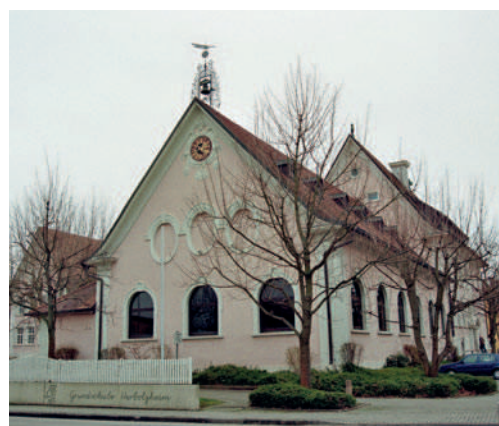
Turnhalle der Volksschule (heute Grundschule) Herbolzheim (1912)
