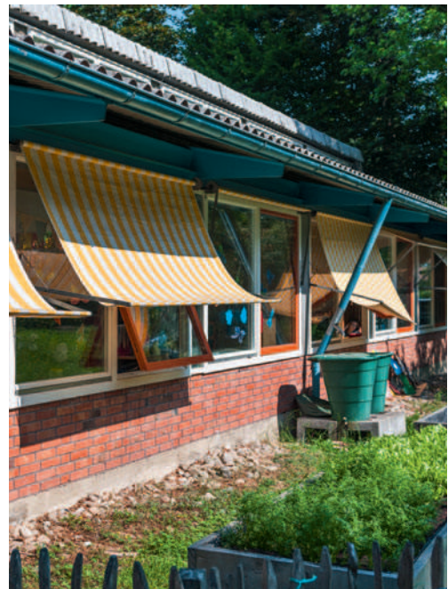
Die Pavillonbauten der Neuwiesenschule (1950-57) in Ravensburg und der Silcher-/Haldenrainschule (1952-54) in Stuttgart-Zuffenhausen entsprechen dem neuen Zeitgeist.
