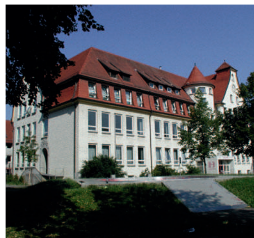
Eine Variante mit Putzfassade stellt die Bohlschule in Aalen (1906) dar.
