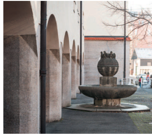
Heusteigschule Stuttgart (1905/06): Freibereich mit Brunnen und Laubengang zur Straßenseite, Klassenräume in Richtung Friedhof
