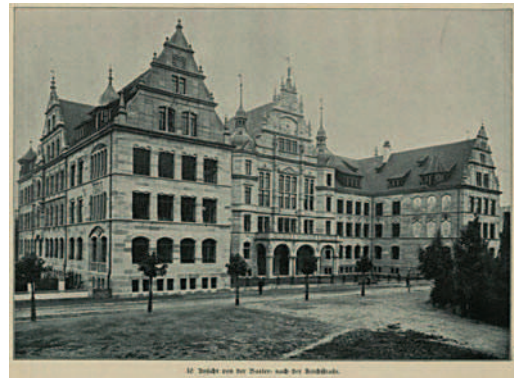
Die schmuckreiche Fassade der Gertrud-Luckner-Gewerbeschule (1902-05) in Freiburg
