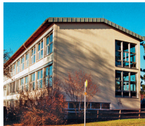
Die Volksschule am Goldenbühl in Villingen wurde nach der pädagogischen Konzeption, den Maßstab des Schulkindes zu berücksichtigen, ebenfalls als Pavillonschule angelegt (1961-1964 nach Plänen von Günter Behnisch und Lothar Seidel). Das ursprüngliche, für das Bauen der 1950er und frühen 1960er Jahre typische filigrane äußere Erscheinungsbild der Fassaden und Dächer wurde jedoch z. T. durch Umbauten der 1990er Jahre (wie etwa überdimensionierte Kupferblechstirnbänder an den Flach- und Pultdachbauten) überformt.
