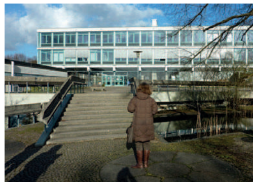
Das ehemalige Aufbaugymnasium in Schwäbisch Gmünd (1963-71) zeigt strenge, klare Formen.
