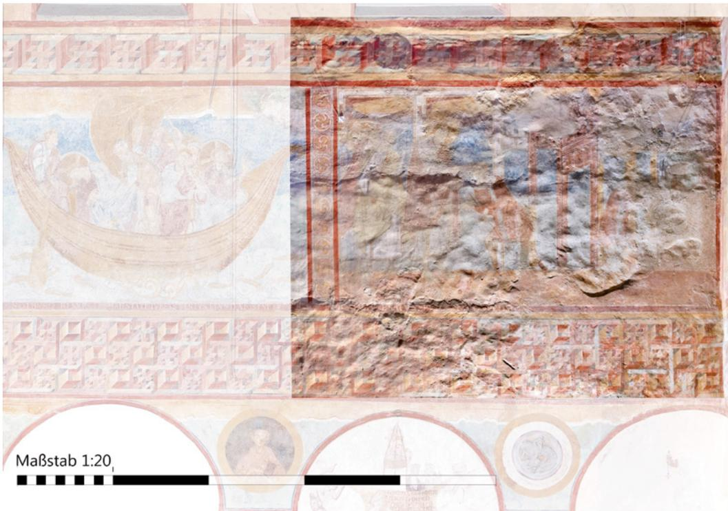
Abb. 15: Nordwand, Detail des neu erstellten Bildplans der Nordwand im Streifenlicht zur Verdeutlichung der Mörtelgrenzen im Verlauf der Gerüste, der Unebenheiten im Verlauf des Mauerwerks und der späteren Mörtelergänzungen (fokus GmbH, Leipzig), vgl. auch die Bildpläne im Anhang.
