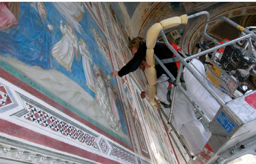
Maßnahmen, die bereits 2001 während der Restaurierung ausgeführt wurden, Dauerhaftigkeit. Für die Hohlstellen werden vorgemischte Mörtel und für die Schäden der Malschicht Festigungsmittel auf Acrylbasis verwendet (Abb. 12).
