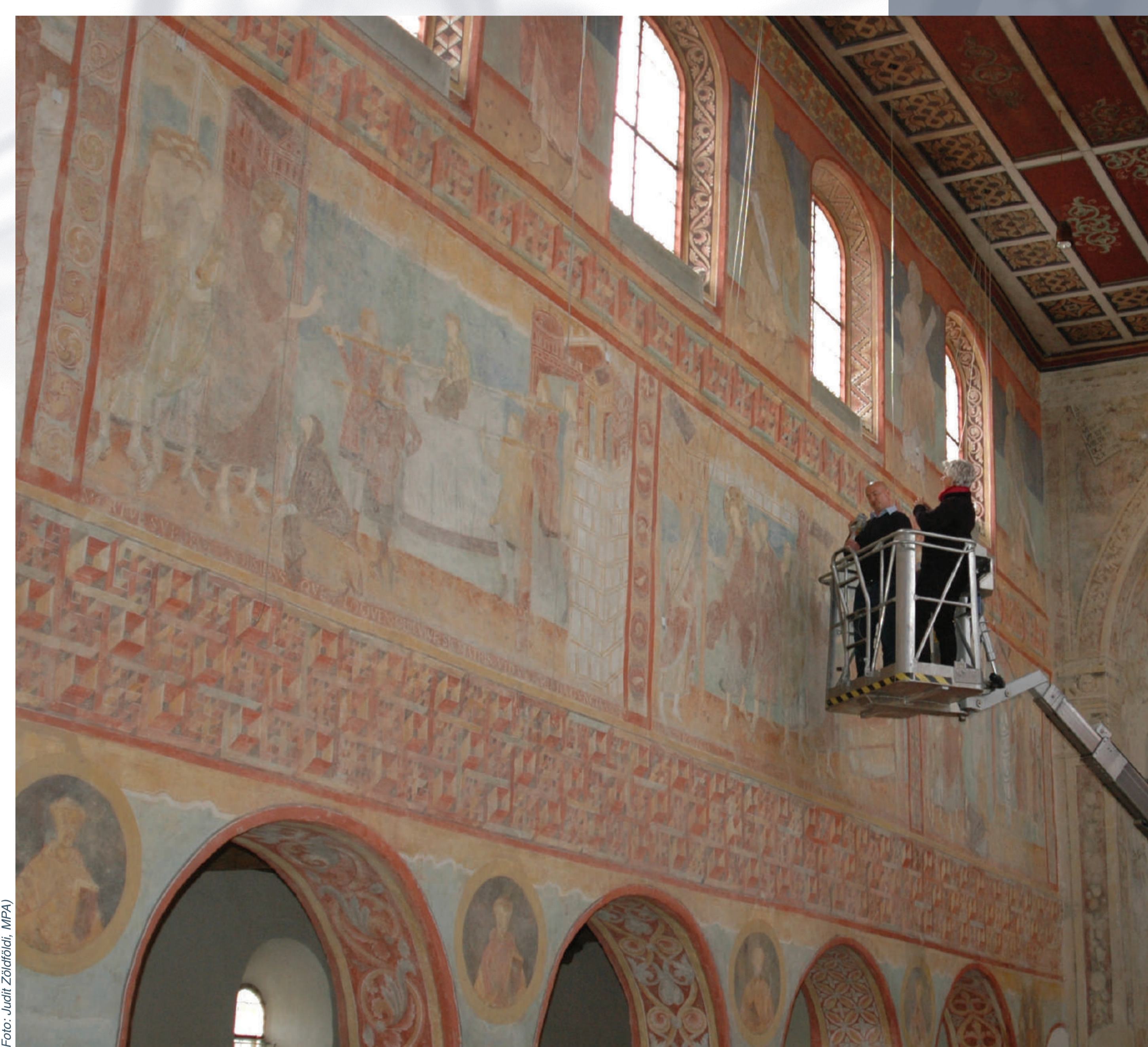
Die zerstörungsfreien vor-Ort-Untersuchungen konnten über eine Hebebühne erfolgen The nondestructive, onsite investigations were carried out by employing a hydraulic crane
