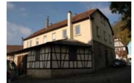
Rückansicht mit Kelterstubenanbau
