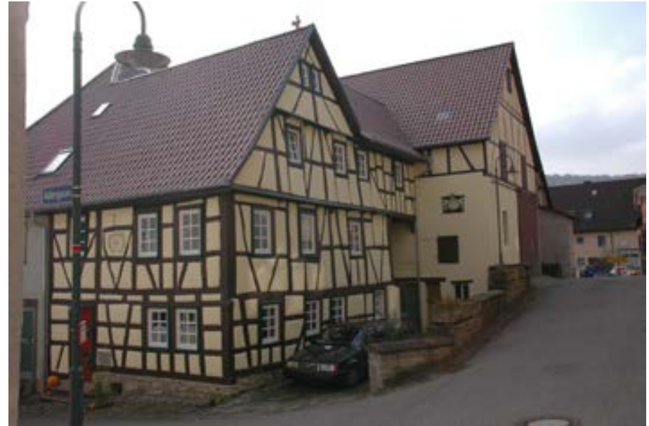
Eckansicht, Wohnhaus und Scheune von der Würzburger Gasse aus
