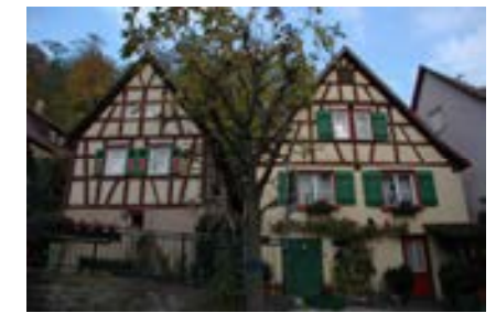
Ansicht mit Burggasse 8 (links)
