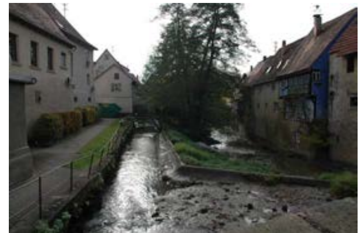
Kessach mit Mühlkanal und Streichwehr, Höhe Kessachbrücke
