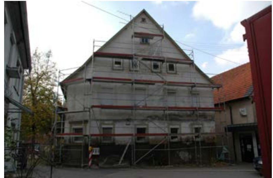
Ansicht gegen die Unterkessacher Straße
