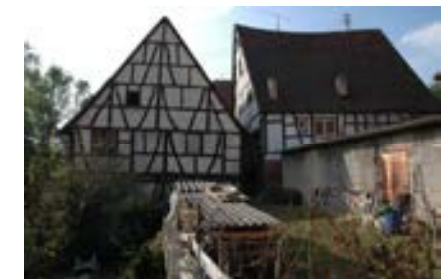
Ansicht von Nordost mit NG. (li)
