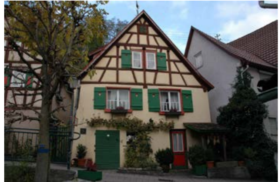
Ansicht von der Entengasse aus
