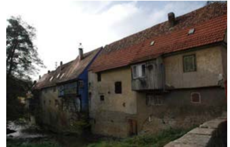
Rückfassaden der Mühlgassenbebauung, von der Kessachbrücke aus
