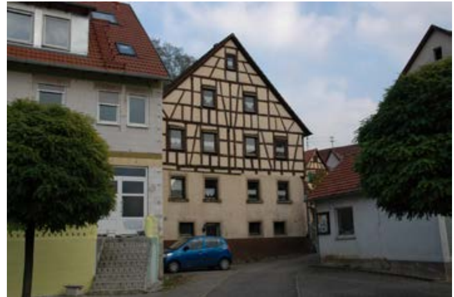
Ansicht gegen die Unterkessacher Straße
