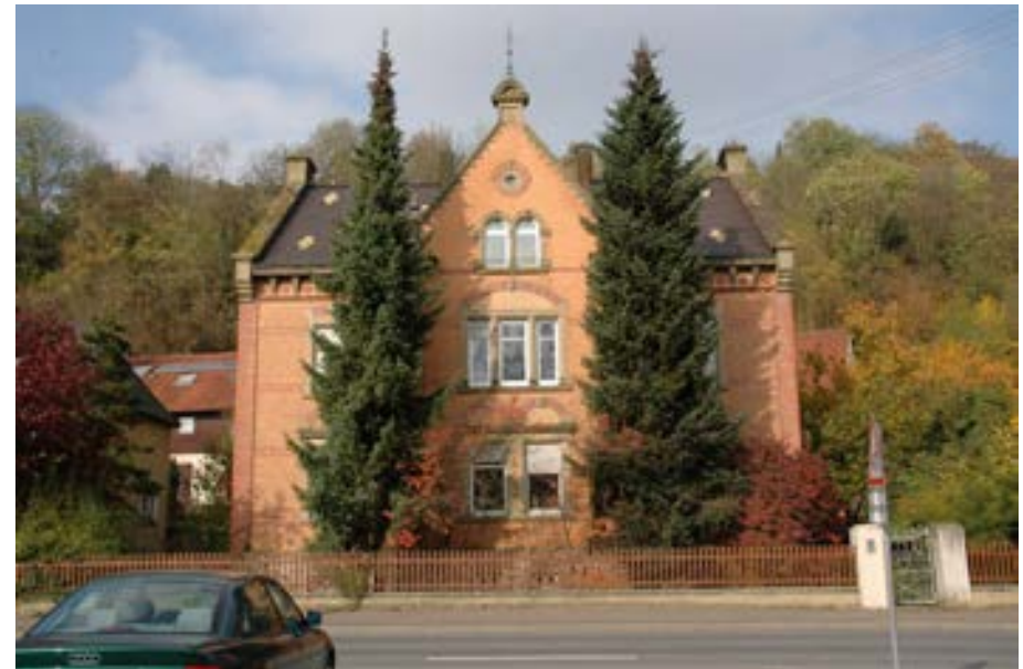
Ansicht gegen die Möckmühler Straße
