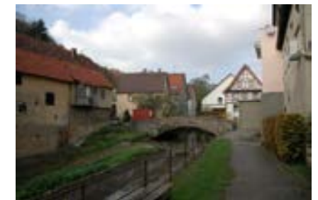
Brücke mit Weg unterhalb des Rathauses
