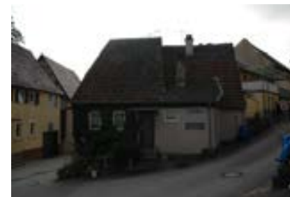
Blick auf die Nordfassade
