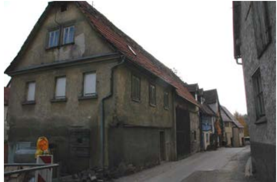
Blick von Höhe Kessachbrücke in Richtung Süden
