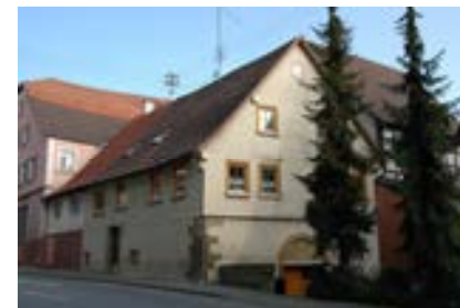
Giebelansicht mit Kellerbogen
