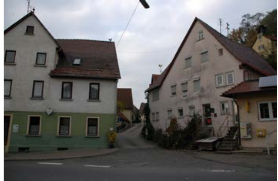
Blick in Richtung Norden, Höhe Hauptstraße
