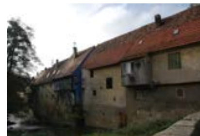
Rückfassaden Mühlg. 24-20 (v.r.)
