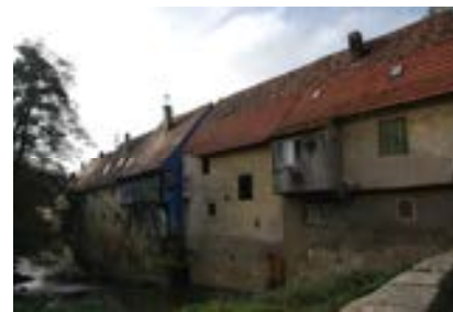
Rückfassaden Mühlg. 24-20 (v.r.)
