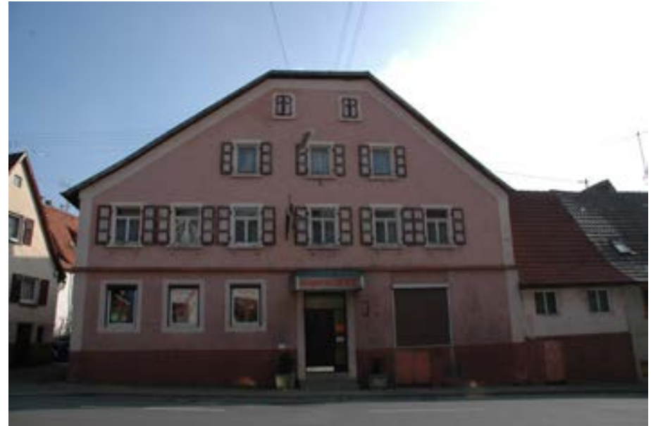
Ansicht gegen die Hauptstraße
