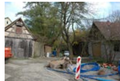
Blick auf die ehem. Waschküche (li)
