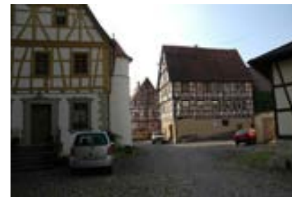
Blick von der Hauptstraße auf Kelterg. 6
