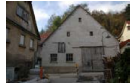
Scheune, Ansicht gg. die Kessachbrücke
