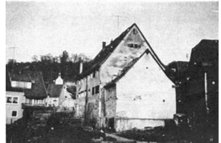
Der Bereich östlich des Zwingers vor der Flächensanierung...
