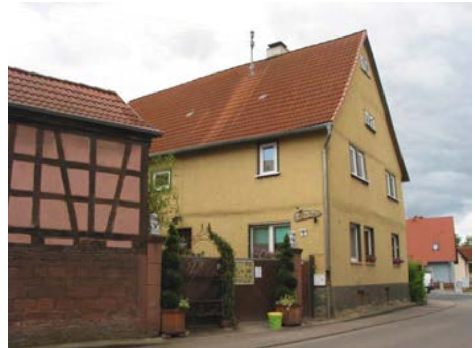
Ansicht des Wohnhauses von Nordosten
