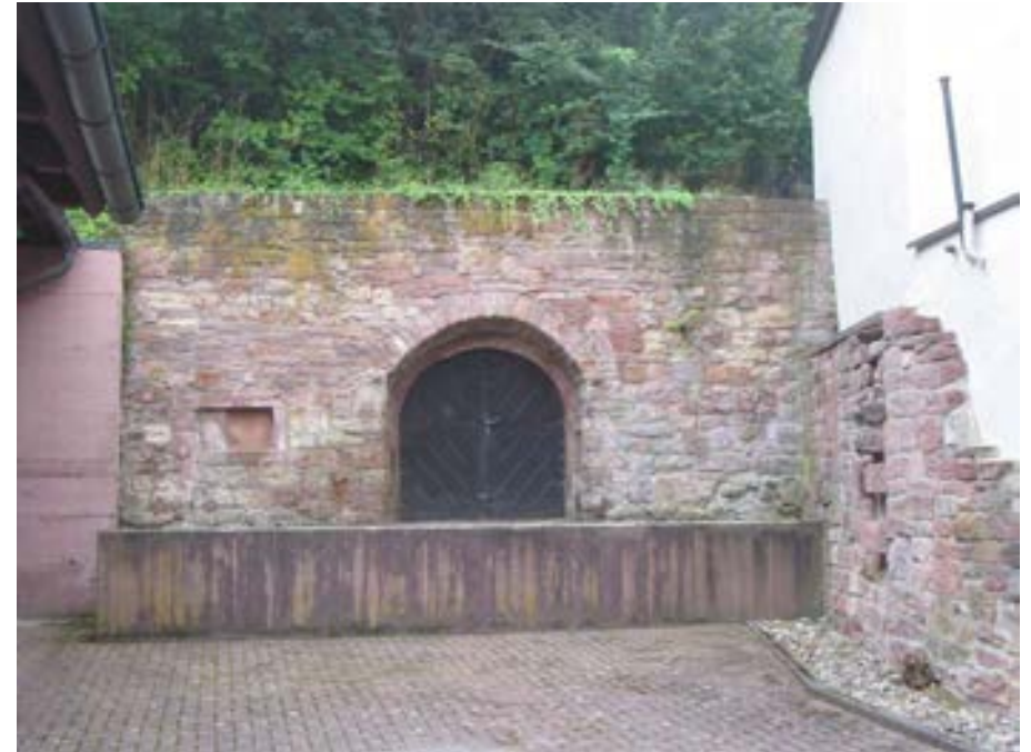
Ansicht des Kellereingangs von Norden
