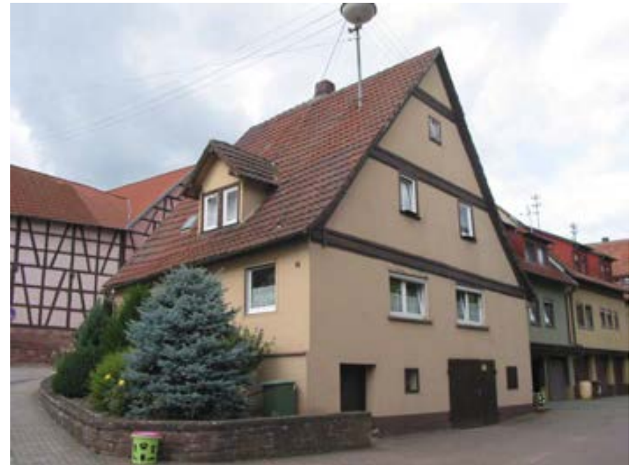
Ansicht des Wohnhauses von Nordosten
