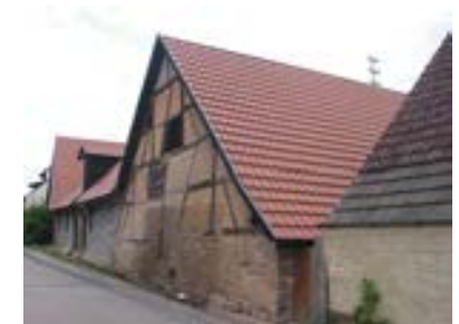
Ansicht der Scheune von Südosten
