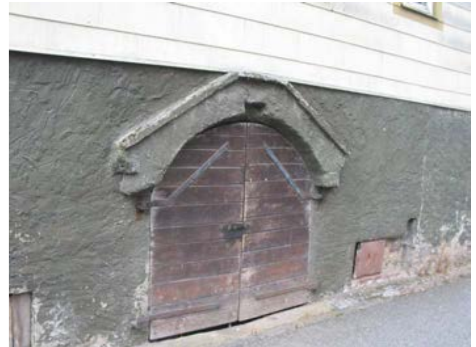
Ansicht des überdachten Kellereingangs und des Steinschiebefensters
