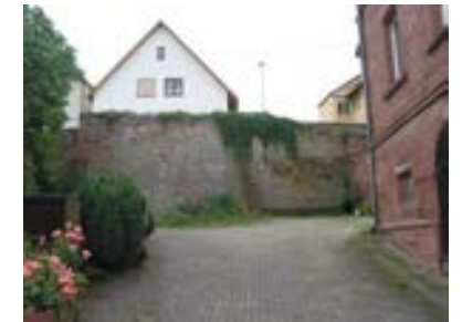
Stützmauern hinter Gebäude Obere Straße 10
