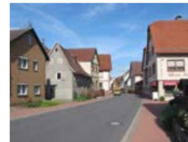
Blick nach Nordwesten auf Höhe von Hausnr. 29
