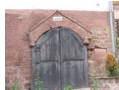
Ansicht des überdachten Kellereingangs
