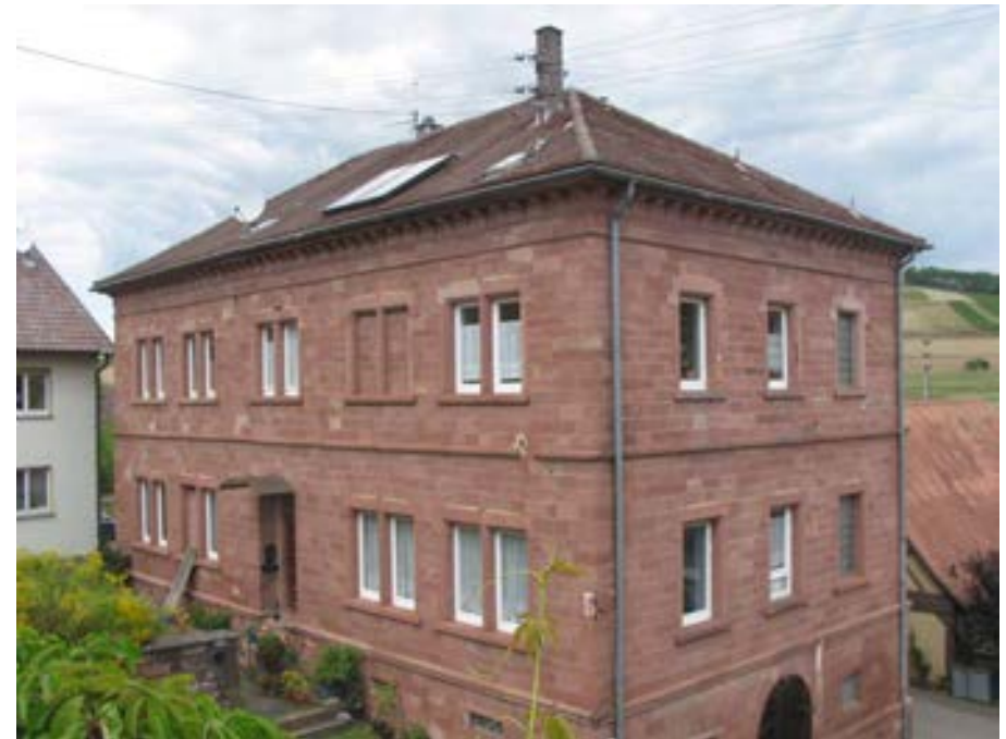
Ansicht des ehemaligen Schulhauses von Südosten
