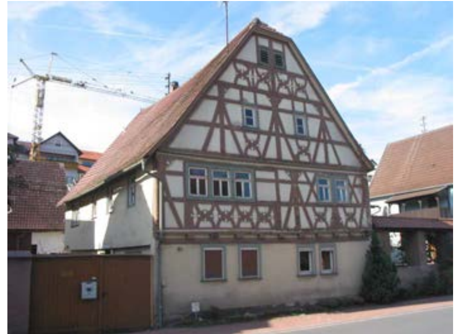
Ansicht des Wohnhauses mit dem prächtigen Zierfachwerkgiebel von Nordosten
