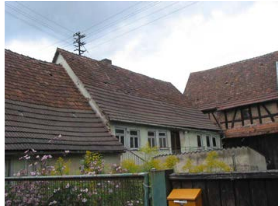
Ansicht der gut überlieferten Hofanlage von Südosten
