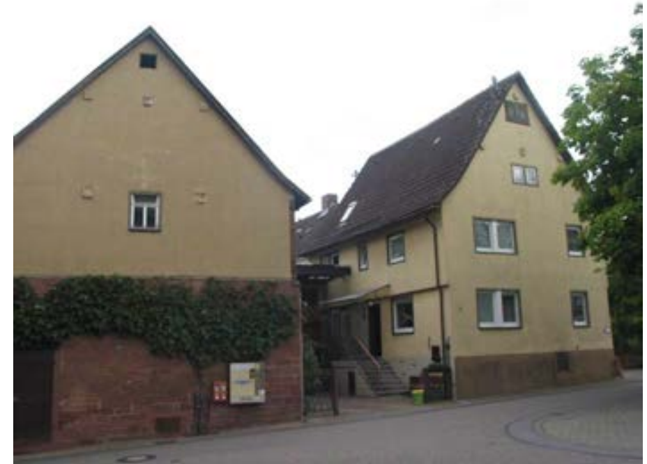
Ansicht der Hofanlage von Südwesten
