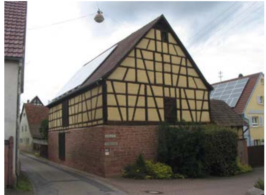
Ansicht der ortsbildprägenden Scheune von Südosten
