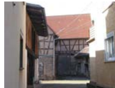
Ansicht der rückwärtig im Hof stehenden Scheune von Norden
