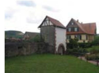
Blick von Südwesten auf die Kirchhofmauer und den Eingangsturm
