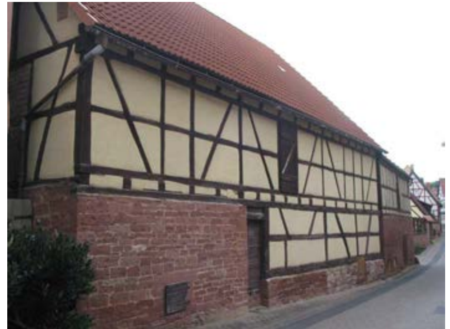
Ansicht der Scheune von Südwesten auf Höhe der Oberen Straße
