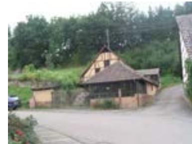
Ansicht des am südöstlichen Ortsrand stehenden Keltereigebäudes von Norden
