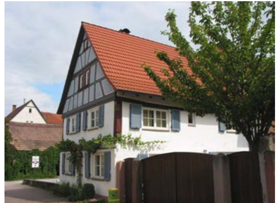
Ansicht des Gebäudes Südwesten
