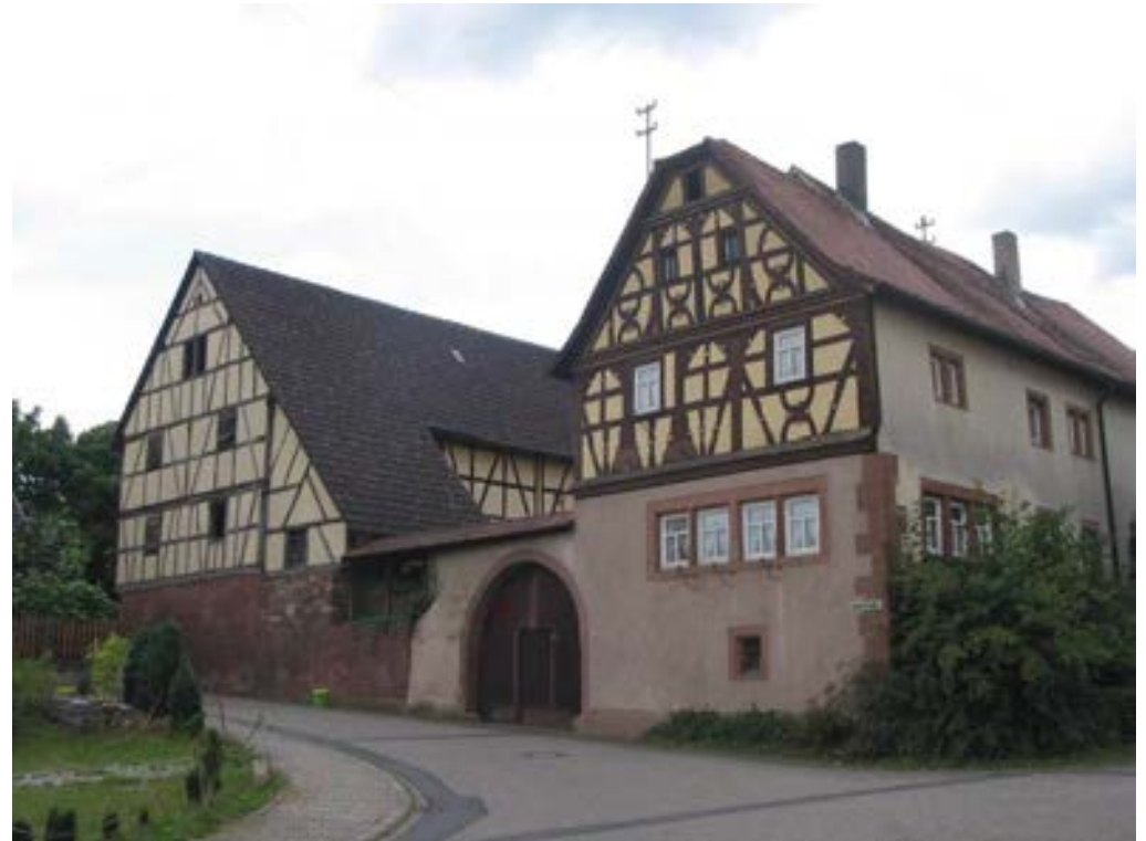
Abb. 8 - Ansicht der beeindruckenden Hofanlage des 16. Jahrhunderts in der Oberen Straße 2 (2008)
