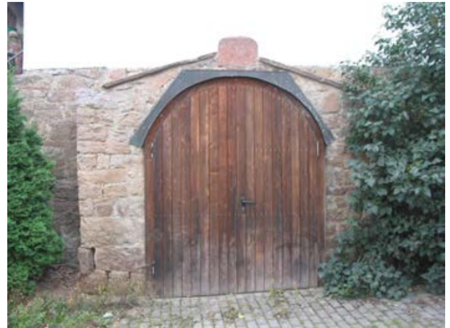
Ansicht des rundbogigen Kellereingangs mit dem darüber befindlichen Keilstein
