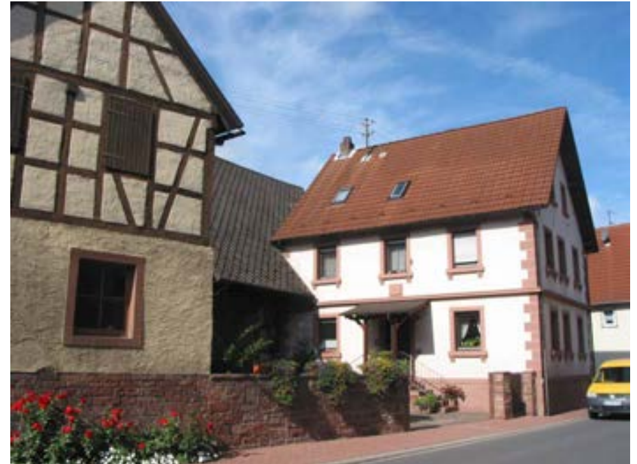
Ansicht des 1919 erbauten Dreiseitgehöfts von Nordosten
