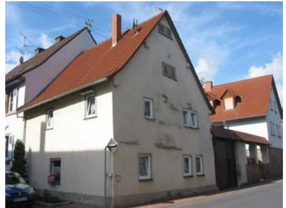
Ansicht des in Ecklage stehenden Wohnhauses von Nordosten
