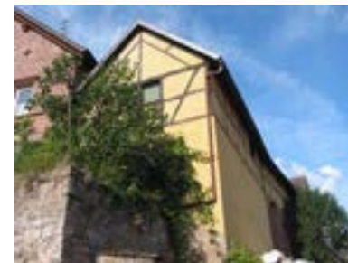
Ansicht des rückwärtigen Ökonomiegebäudes von Osten
