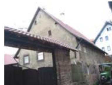
Ansicht der überdachten Hofeinfahrt
