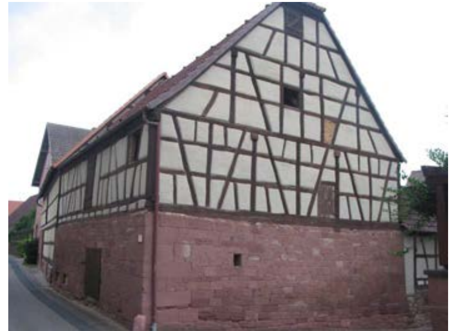
Ansicht der Scheune von der Oberen Straße aus.
