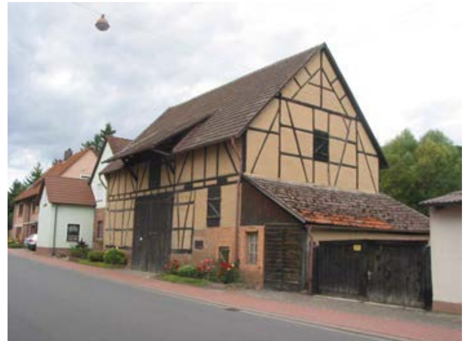
Ansicht der Scheune von Südosten
