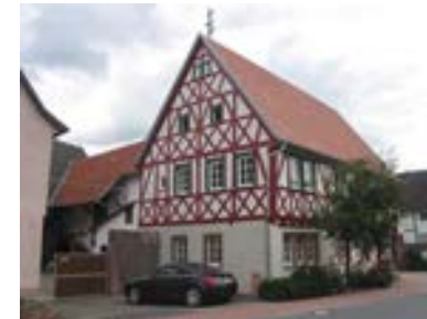
Ansicht des Zierfachwerkgiebels des Alten Rathauses von Westen
