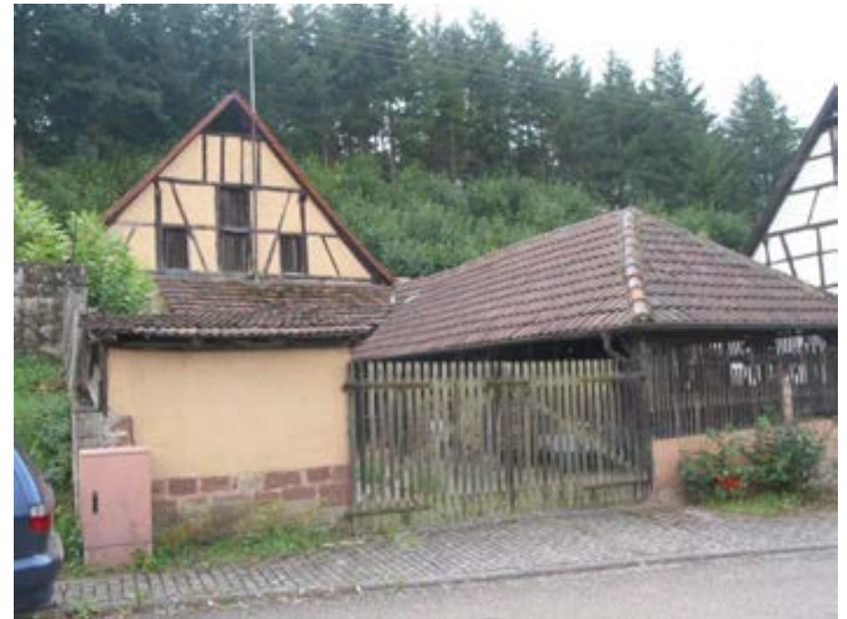
Ansicht des Keltereigebäudes von Nordosten
