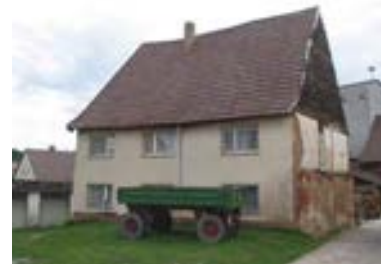
Ansicht des Gebäudes von Südwesten
