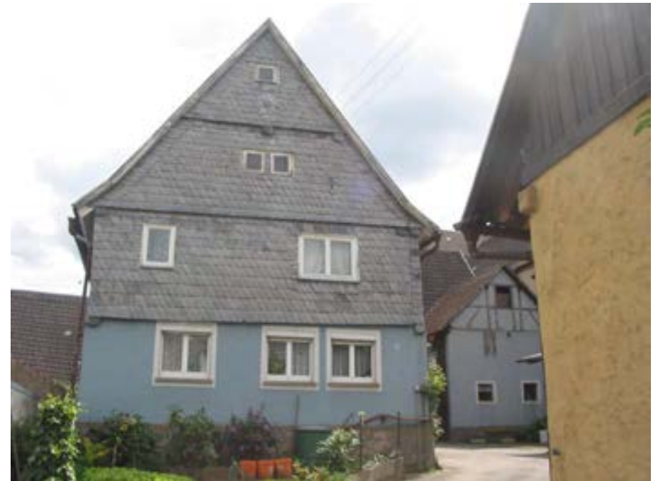
Ansicht von Nordwesten auf das Wohnhaus mit dem rechts davon gelegenen Hof
