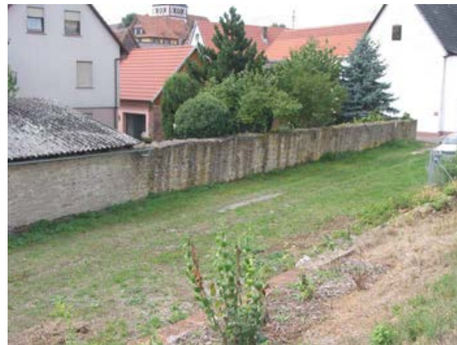
Ansicht der Dorfmauer und des davor liegenden Dorfgrabens nördlich hinter Aalbachstraße 39
