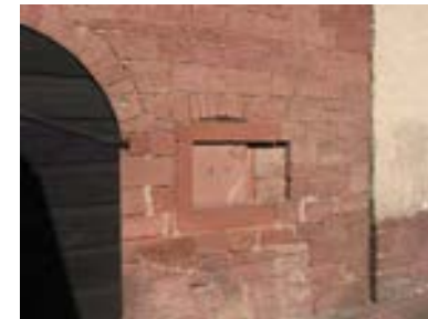
Detailansicht eines Steinschiebefensters im massiven Erdgeschoss
