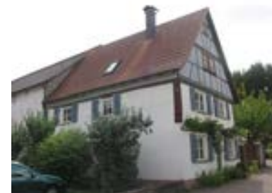
Ansicht des Gebäudes von Nordwesten
