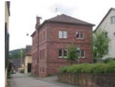
Ansicht des Schulhauses von Nordwesten
