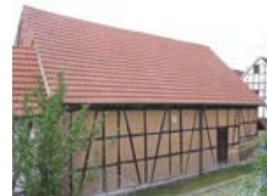
Ansicht der großen, rückwärtig stehenden Scheune von Nordosten
