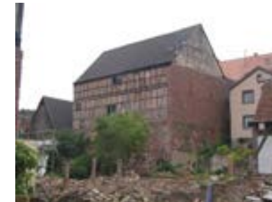
Ansicht des stattlichen Scheunengebäudes von Nordwesten
