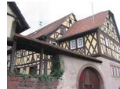
Ansicht des Wohnhauses von Nordosten
