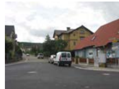
Blick nach Norden auf Höhe von Hausnr. 4
