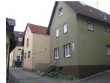
Ansicht des Gebäudes von Nordwesten
