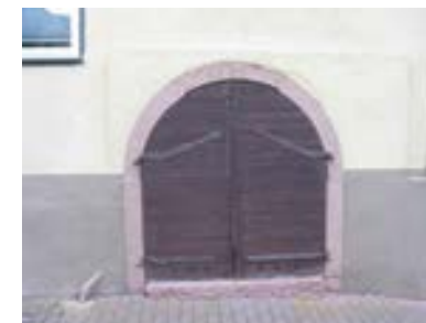
Ansicht des rundbogigen Kellereingangs mit der Inschrift 1691
