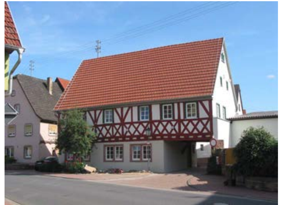
Ansicht des Alten Rathauses von Süden
