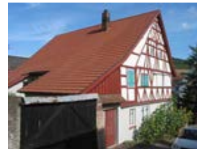
Ansicht des ehemaligen Pfarrhauses von Südosten
