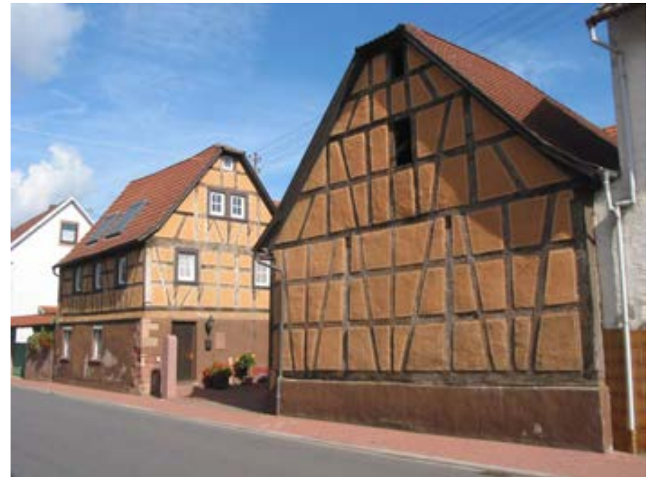
Ansicht des Dreiseitgehöfts von Südosten
