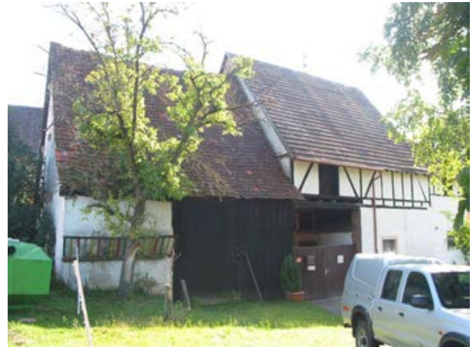
Ansicht der zur einstigen Mühle gehörigen Ökonomiegebäude von Südwesten
