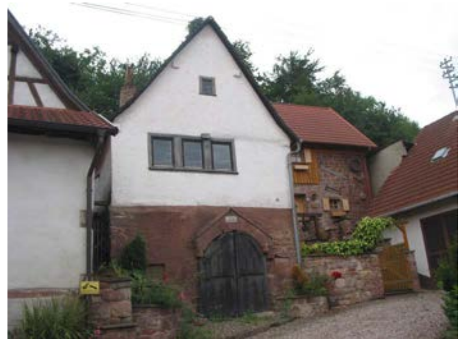
Ansicht des Weingärtner- und Kellerhauses von Nordosten
