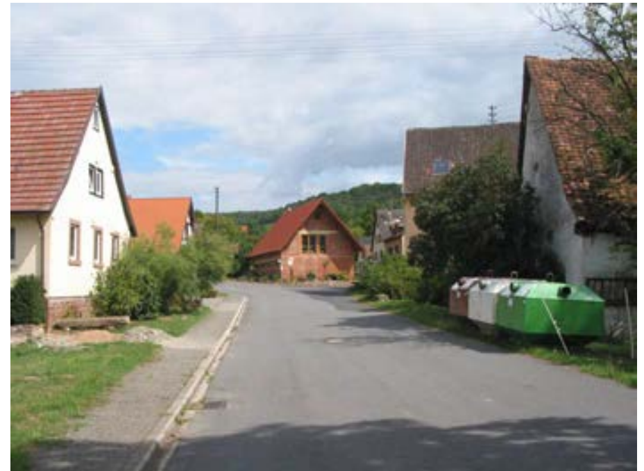
Blick nach Nordosten auf Höhe der Brücke über den Aalbach
