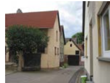
Blick nach Westen auf Höhe von Gebäude Am Berg 1
