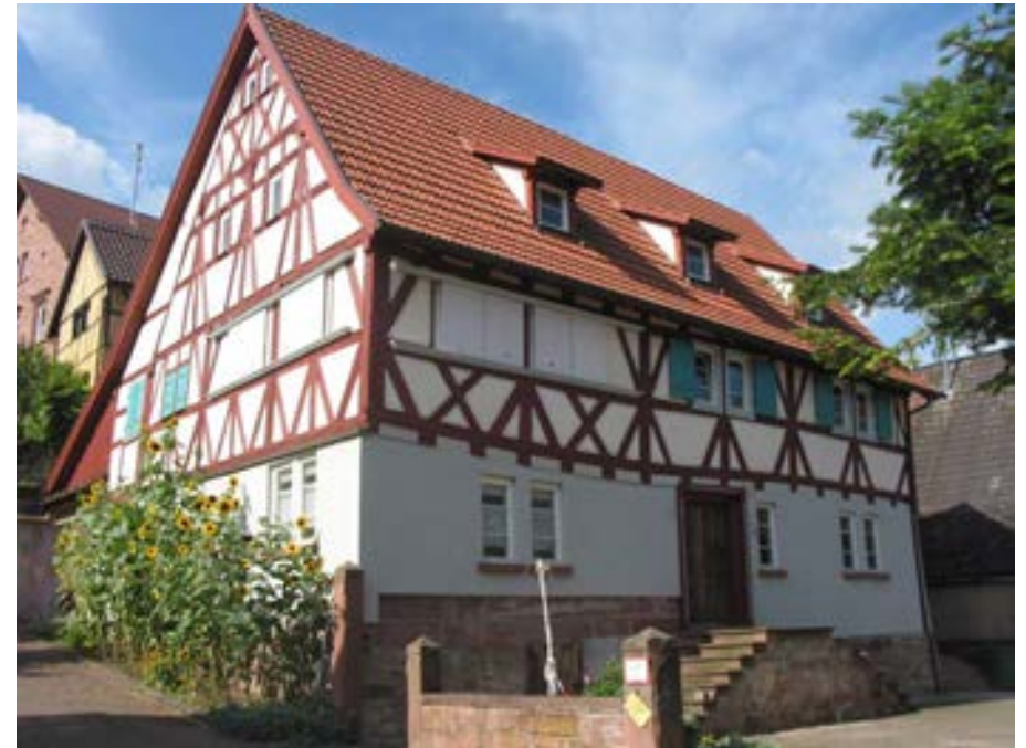
Ansicht des kürzlich sanierten Pfarrhauses von Nordosten
