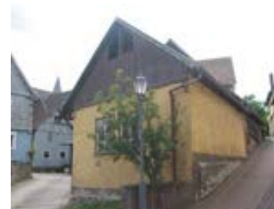
Ansicht der Nebengebäude, welche den Hof nach Westen abschließen
