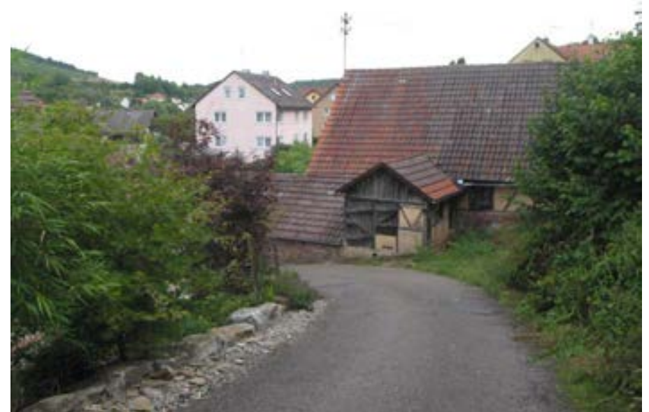
Blick nach Osten auf das Keltereigebäude Am Oberen Tor 12
