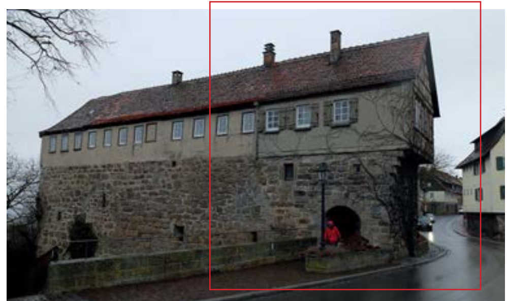
Hauptstr. 50 mit Fußgängerdurchgang, Mauerbebauung (oben), Innenhof (unten)
