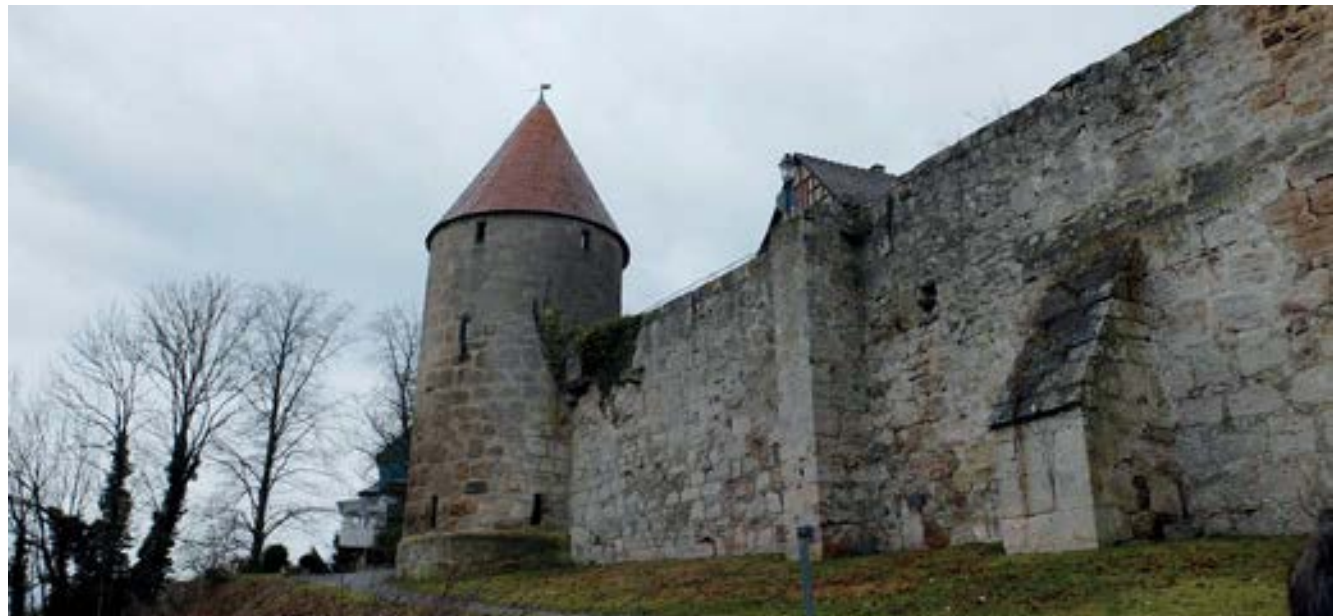
Hauptstraße 51 - Nachtwächterturm, Blick aus Stadtgraben (unten)
