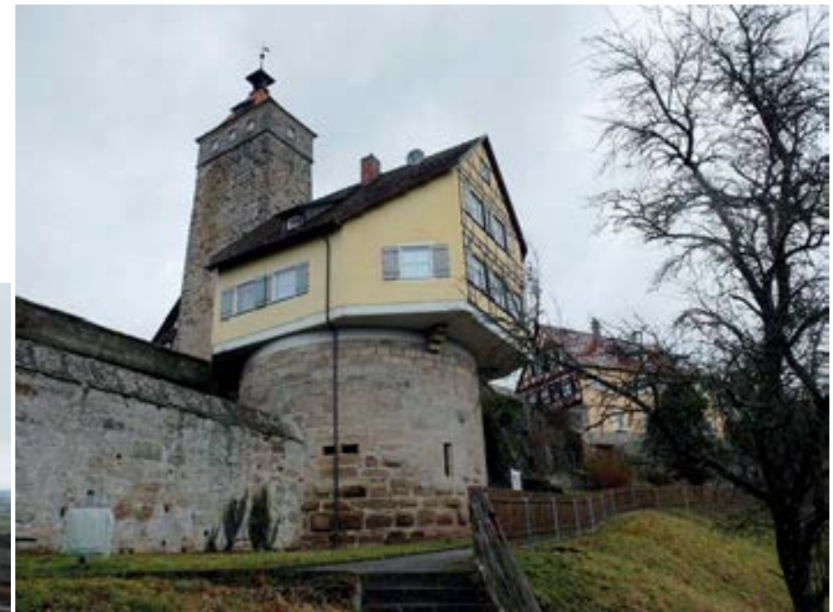
Hauptstraße 35 - überbauter Batterieturm, Sicht aus Stadtgraben (rechts) und Straßenseitig (links)
