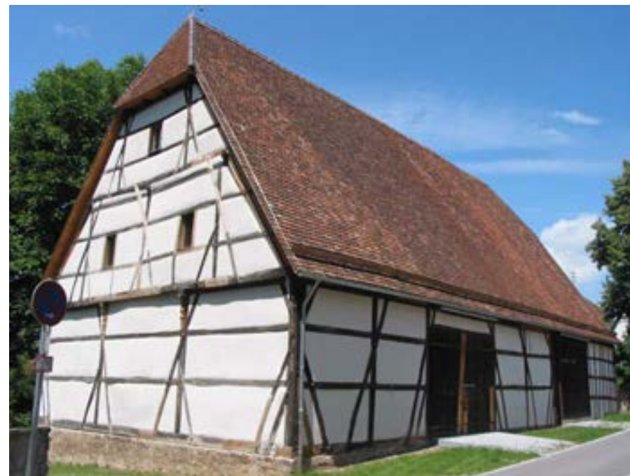
Ansicht der ehemaligen Zehntscheune von Süden
