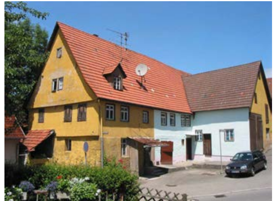
Ansicht der ortsbildprägenden Hofanlage von Süden.
