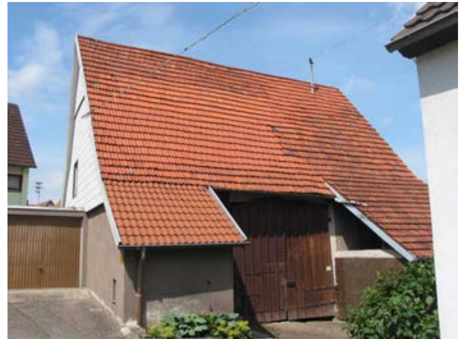
Ansicht des Scheunengebäudes von Südosten
