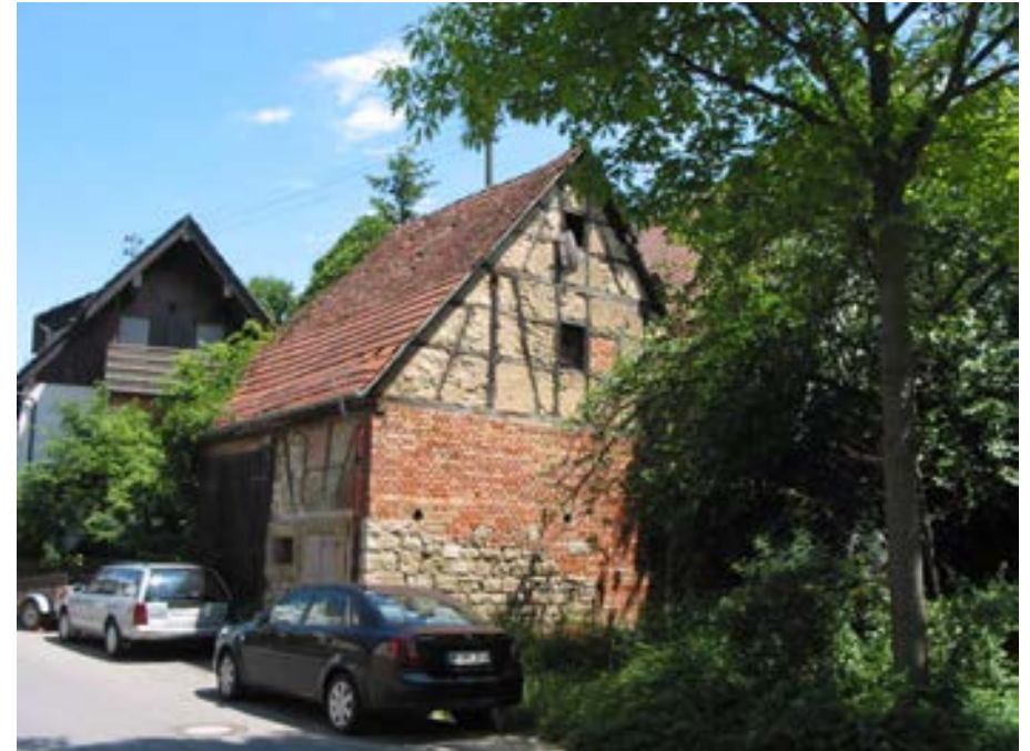
Ansicht des Scheunengebäude von Westen
