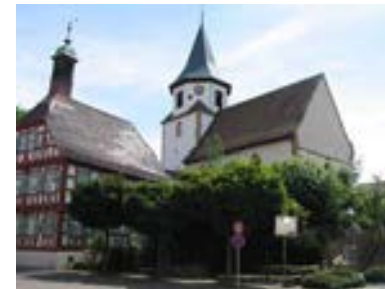
Ansicht der erhöht gelegenen Pfarrkirche von Nordwesten
