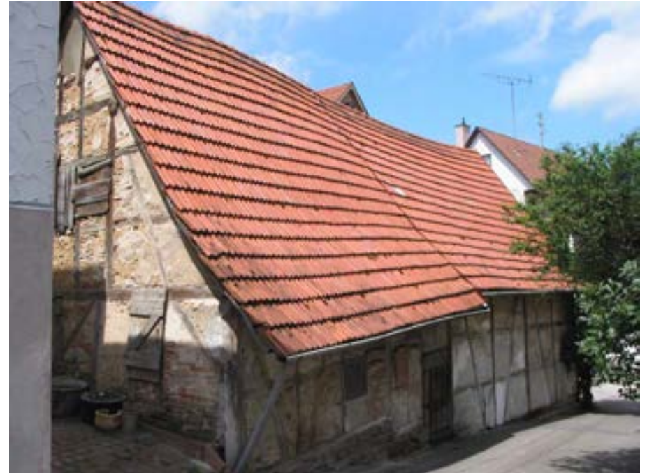
Ansicht der traufständigen Scheunen von Südosten
