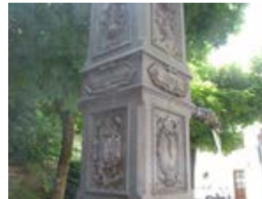
Detail der gusseisernen Brunnensäule mit Verzierungen
