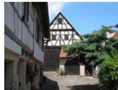
Blick in den Hof von Schillerstraße 109 mit Ansicht der rückwärtigen Scheune Nr. 113
