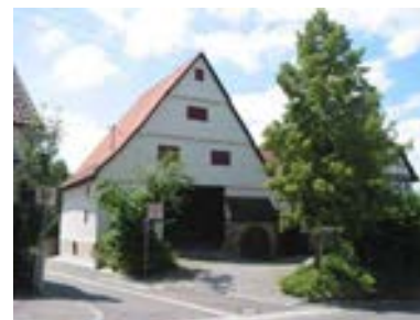
Ansicht der Pfarrscheune von Nordosten
