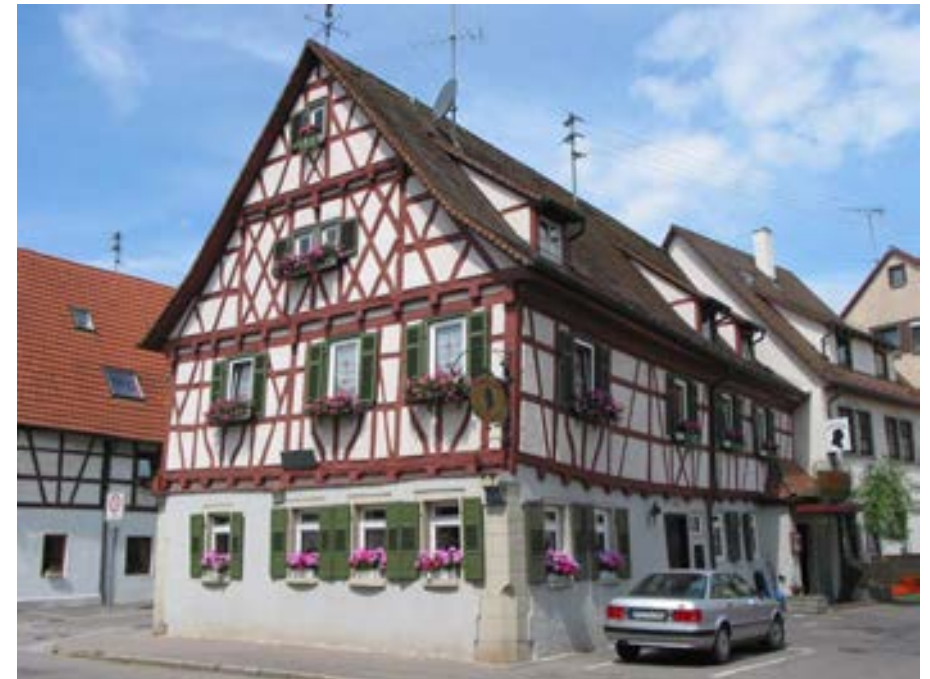
Ansicht des ortsbildprägenden Schillerhauses von Südosten
