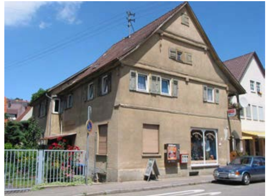
Ansicht des Wohnhauses von Südwesten
