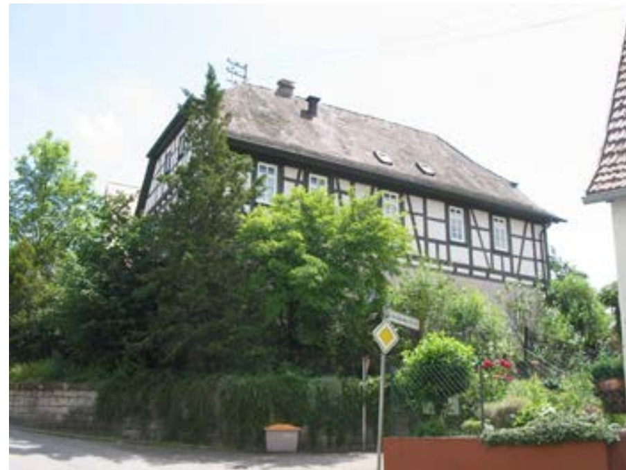
Ansicht des erhöht stehenden Pfarrhauses von Nordwesten
