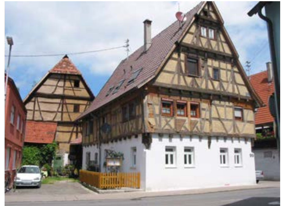
Blick in den Hof von Schillerstraße 99 mit Ansicht der rückwärtig stehenden, stattlichen Scheune
