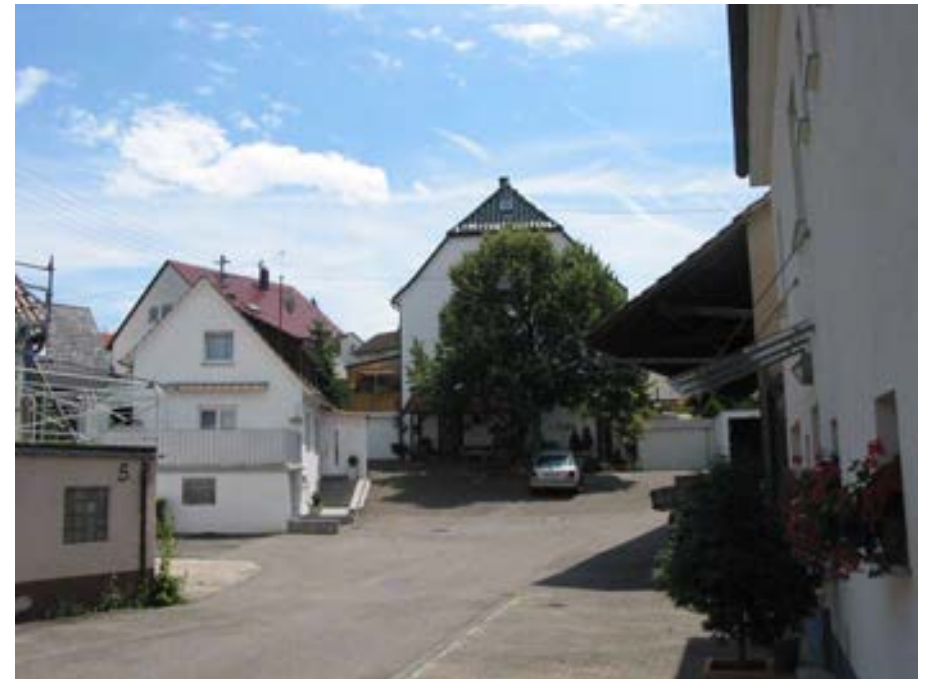
Blick über die südöstliche Aufweitung der Schlossgasse von Nordwesten
