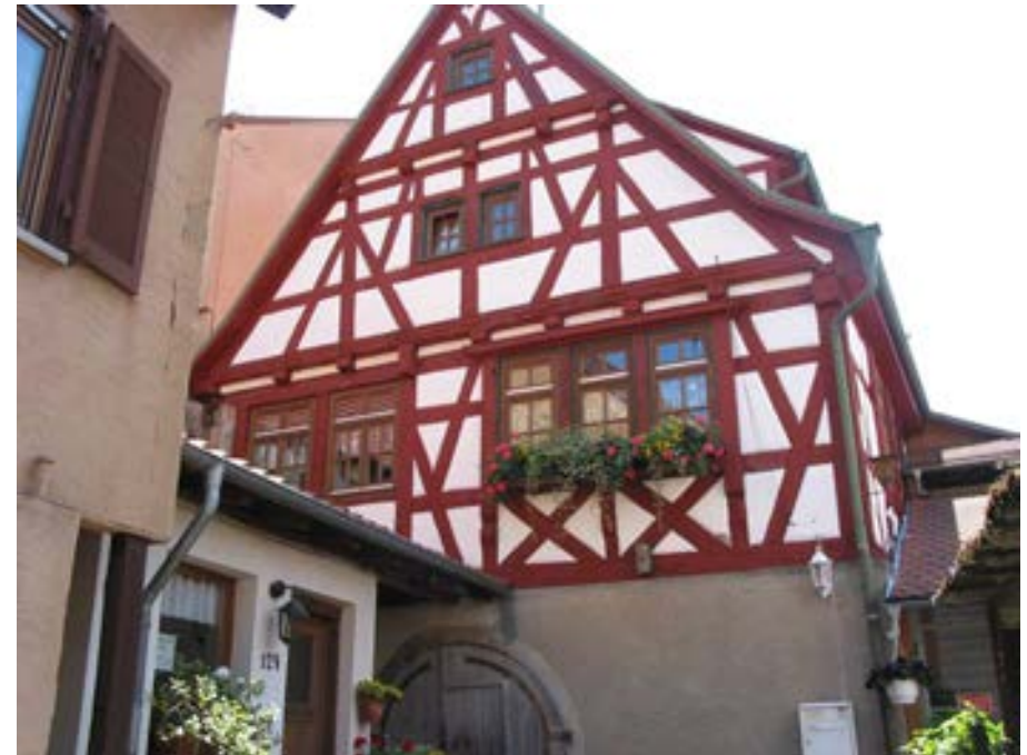
Ansicht des Weingärtnerhauses von Norden
