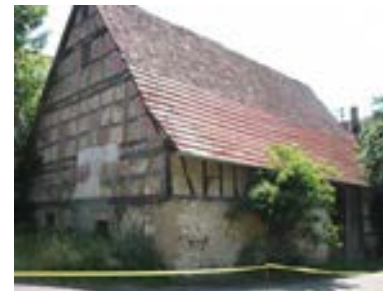
Ansicht der nordöstlich zum Wohnhaus stehenden Scheune von Norden
