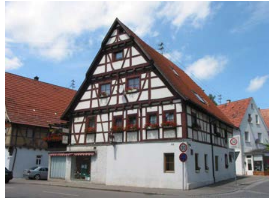
Ansicht des ortsbildprägenden Wohnhauses von Südosten
