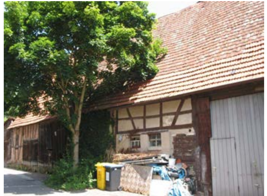
Ansicht der Scheunenreihung von Südwesten
