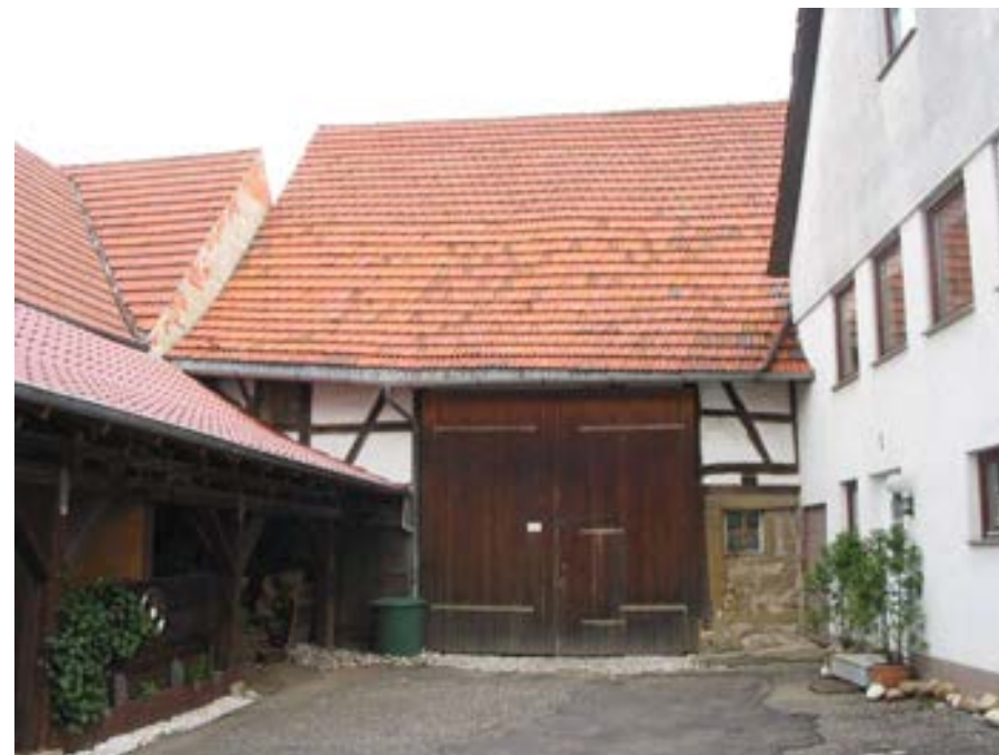
Ansicht der Scheune von Westen
