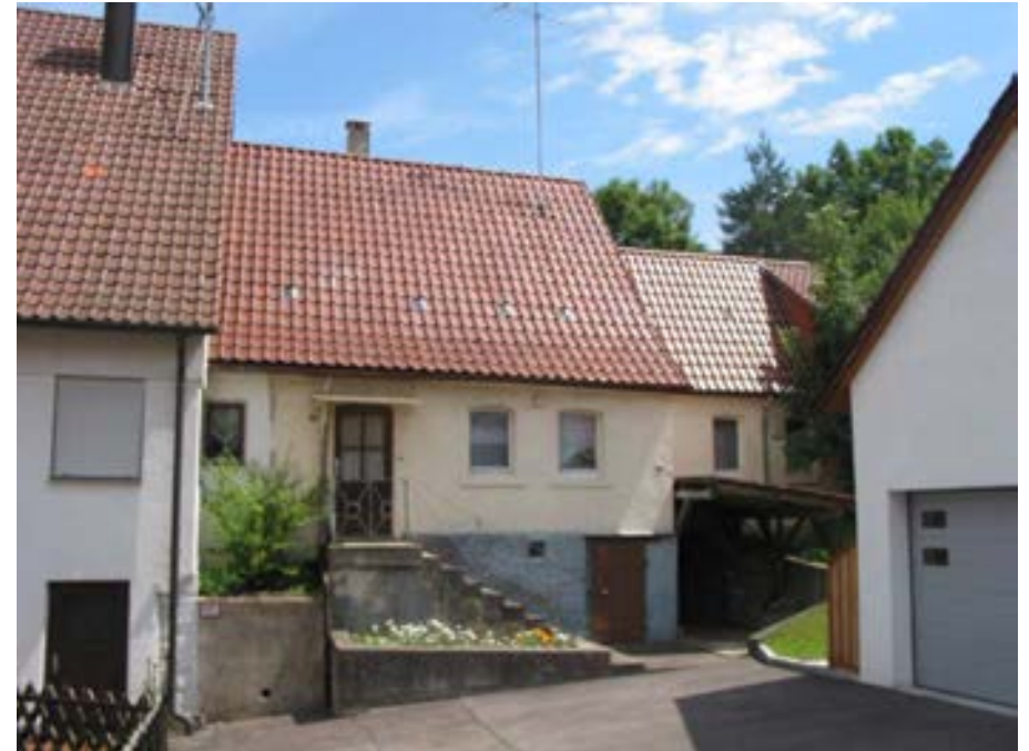
Ansicht des Wohnhauses mit südlichem Anbau von Westen
