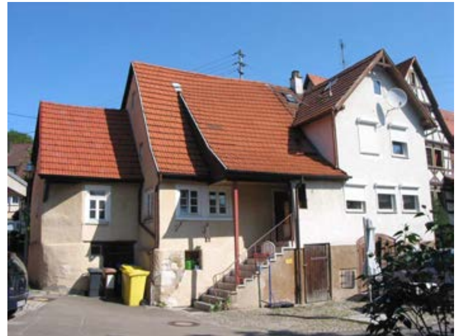
Ansicht des gestelzten Wohnstallhauses von Süden
