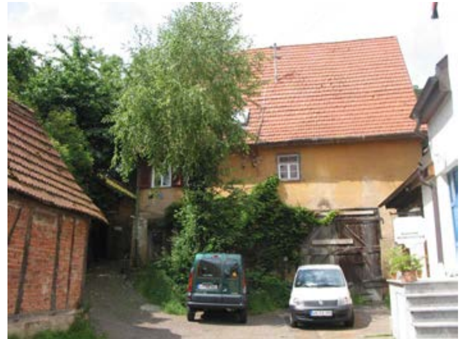
Blick in den Hof mit Ansicht des gestelzten Einhauses von Nordosten
