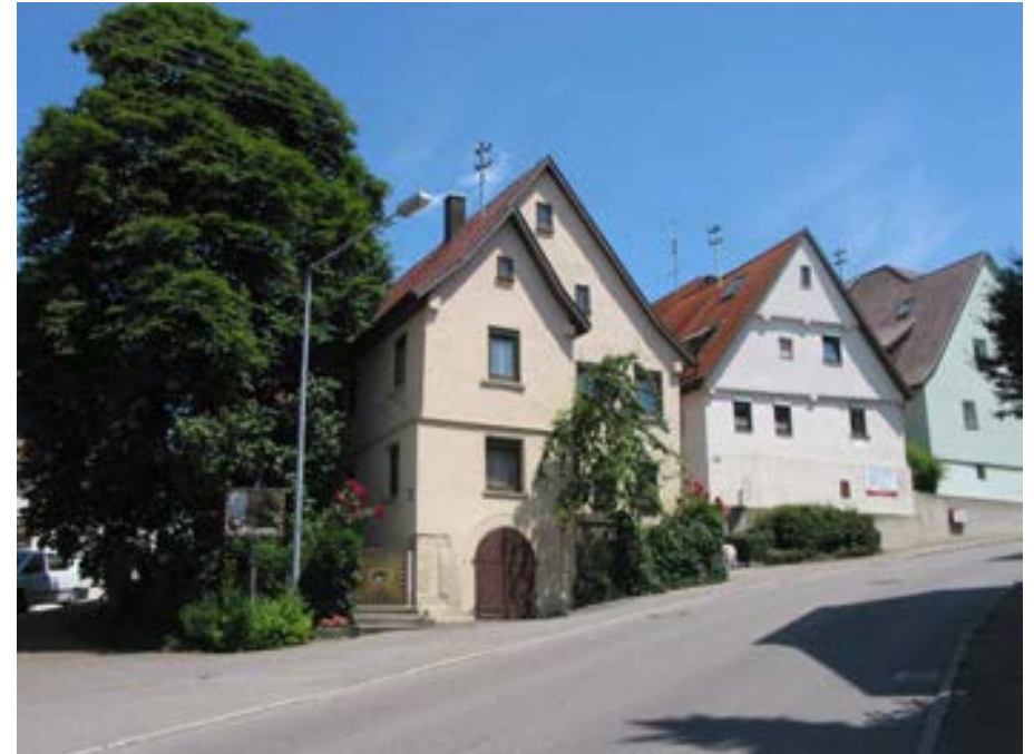
Ansicht des Weingärtnerhauses von Westen
