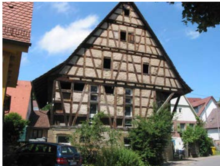
Ansicht des zur Schmiedgasse 2 gehörigen, stattlichen Scheunengebäudes von Süden
