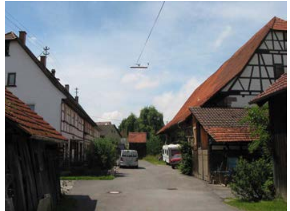
Blick in den ehemaligen Schlosshof von Nordosten
