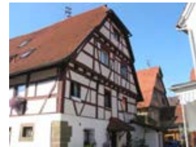
Ansicht des nördlichen Giebels
