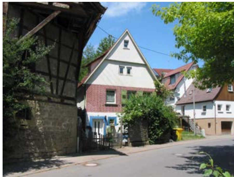
Ansicht des Wohngebäudes von Süden
