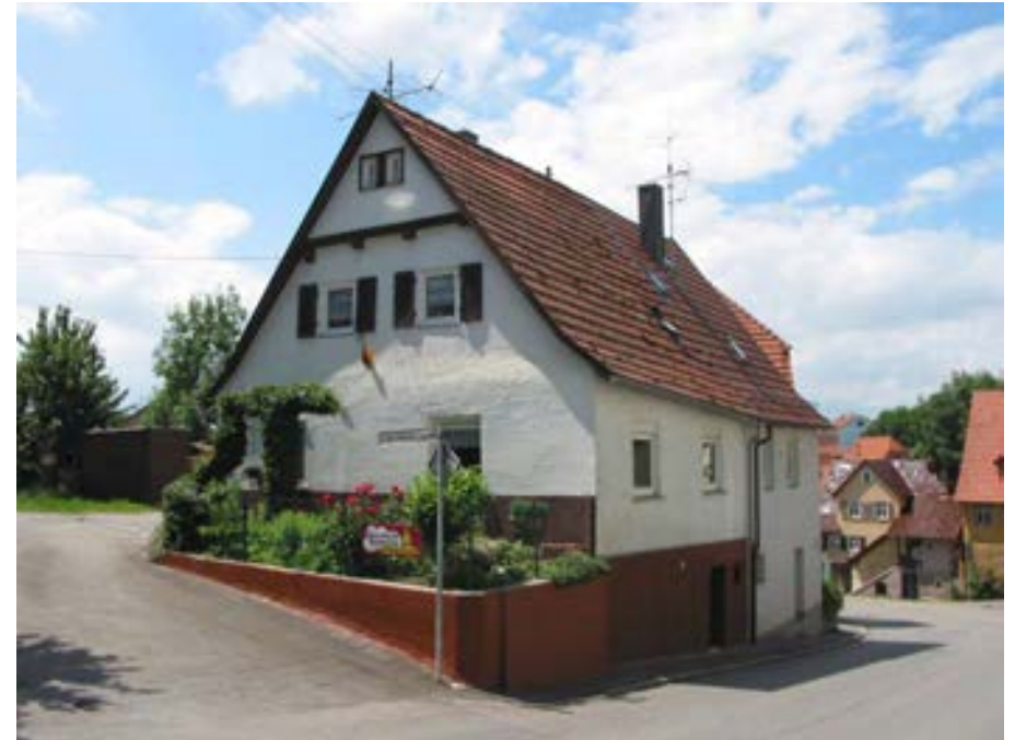
Ansicht der östlichen Doppelhaushälfte von Osten
