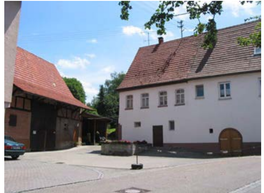
Ansicht der Hofanlage und des rundbogigen Kellereingangs von Nordwesten
