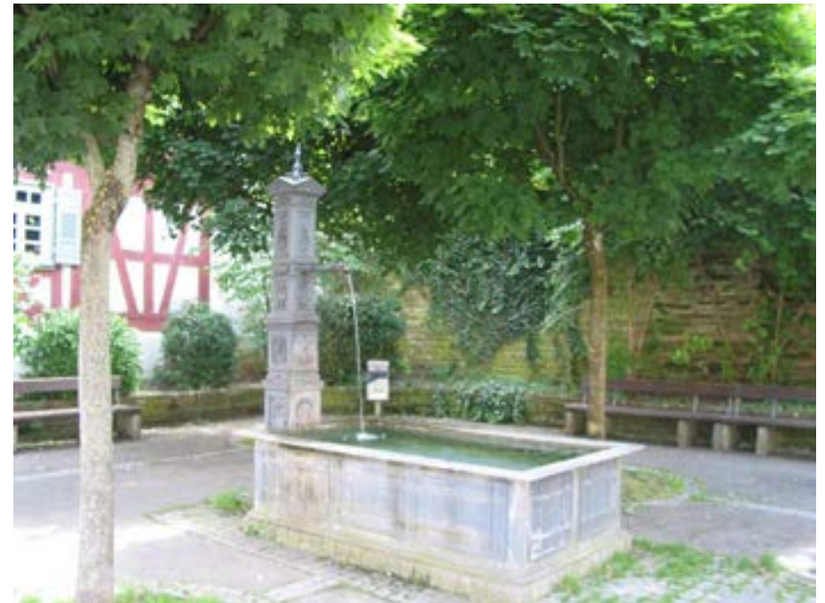
Ansicht des gusseisernen Brunnens mit rechteckigem Brunnentrog von Nordwesten
