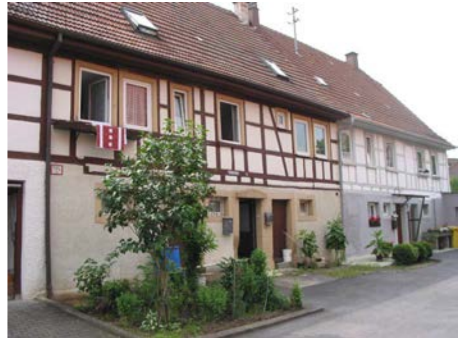
Ansicht der drei Hofhäuser in Form eines Reihenhauses von Nordosten
