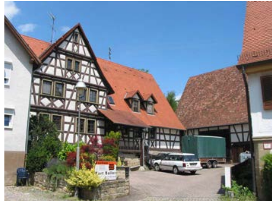
Ansicht der stattlichen Hofanlage von Südwesten
