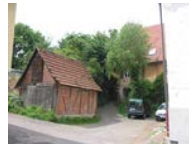
Ansicht des kleinen Nebengebäudes (Hausnr. 10) von Nordosten
