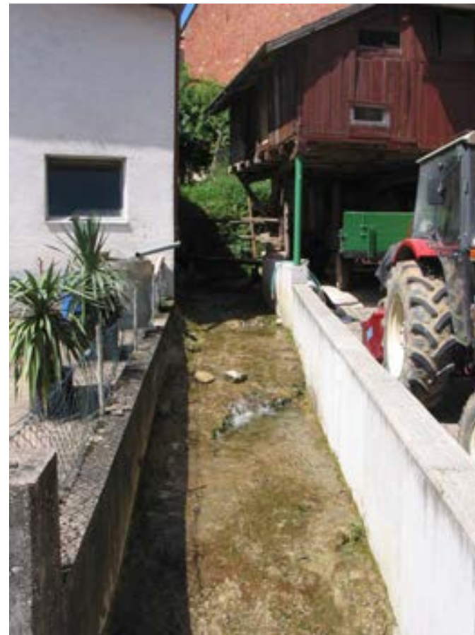
Dorfbach im Bereich Aschhäuser Straße 1
