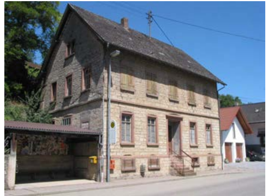
Ansicht des Rat- und Schulhauses von Südwesten
