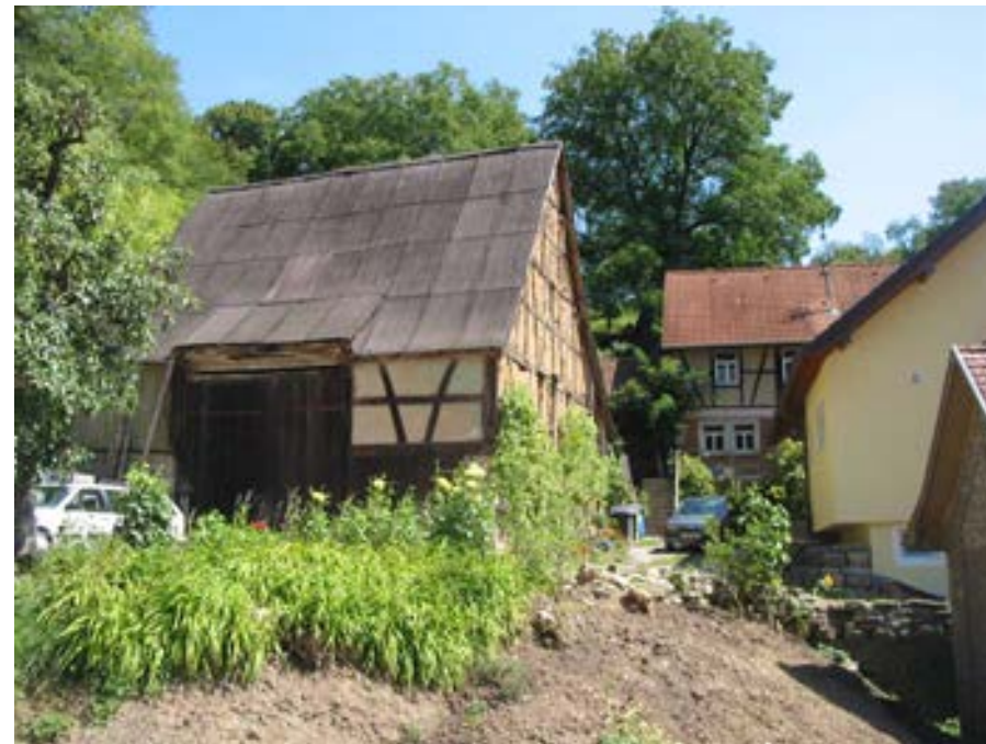
Ansicht der Scheune mit rückwärtigem Wohnhaus von Westen
