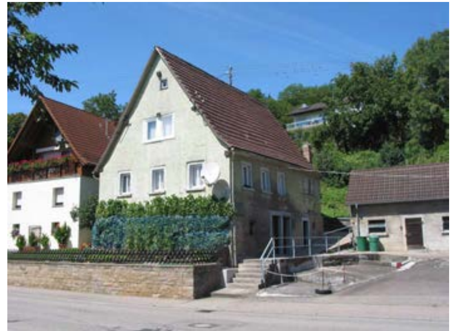
Ansicht eines ehemaligen Weingärtnerhaus von Südosten
