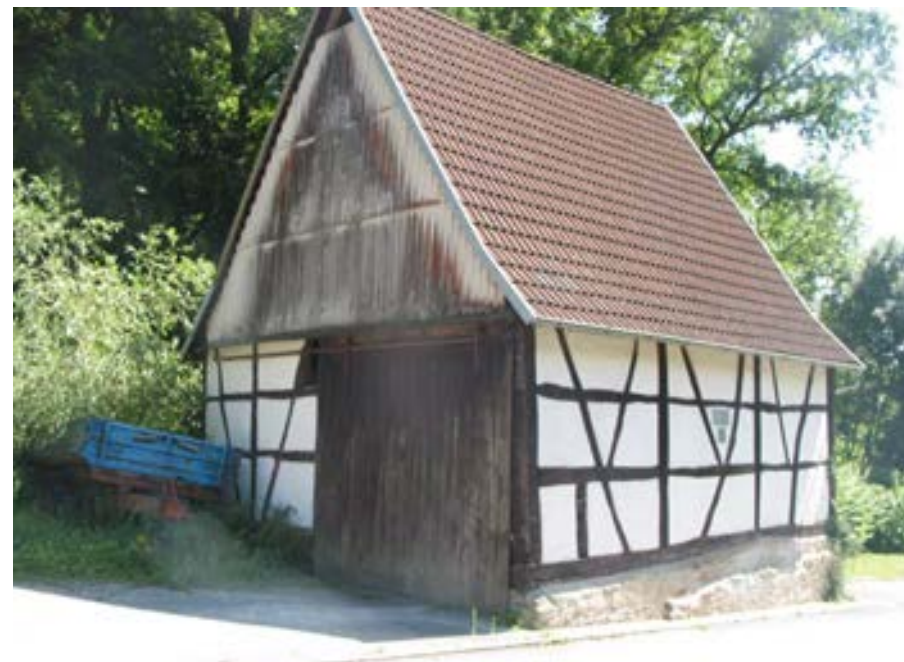
Solitär stehendes Scheunengebäude; Blick von Nordwest
