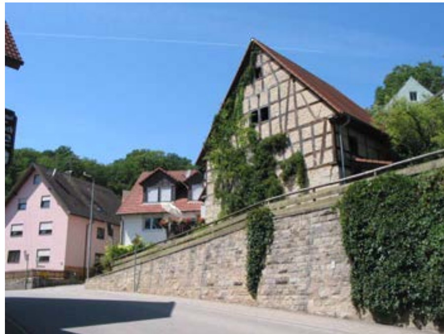
Die Scheune prägt in ihrer erhabenen Lage die Ortsdurchfahrt; Blick von Südosten
