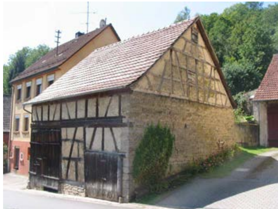
Ansicht des Scheunengebäudes von Nordosten
