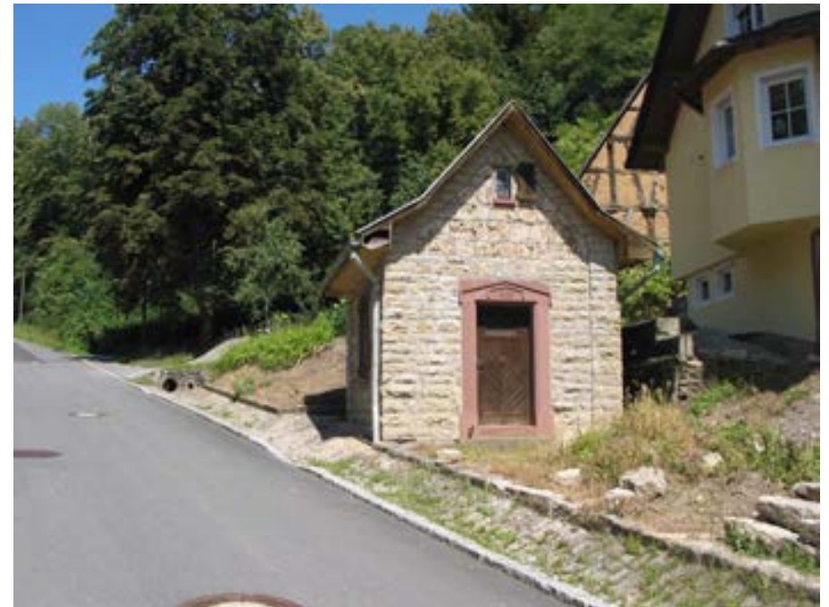
Ansicht der Pumpstation von Süden
