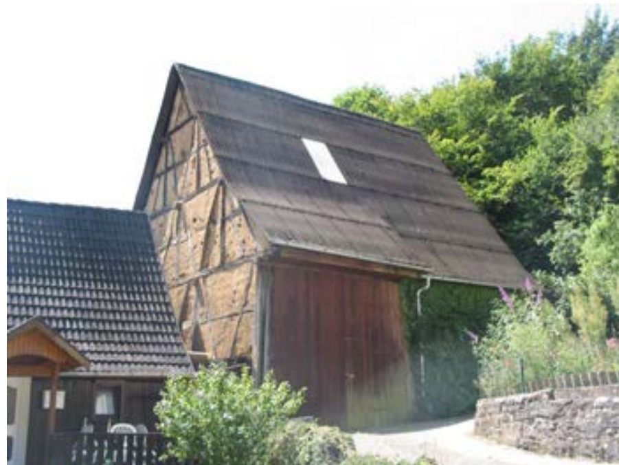
Ansicht des Scheunengebäudes von Nordosten
