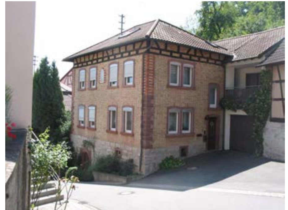
Ansicht des Wohngebäudes von Norden
