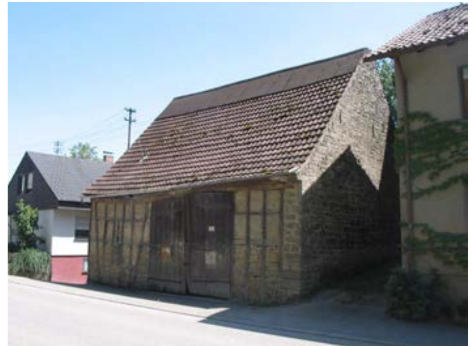
Ansicht des Scheunengebäudes von Westen
