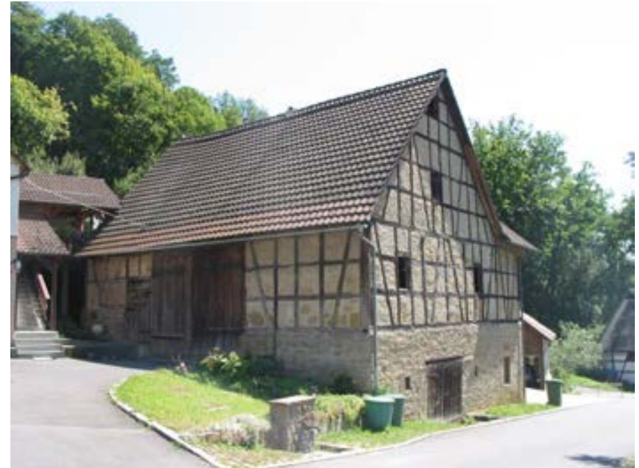
Ansicht des Scheunengebäudes von Nordwesten
