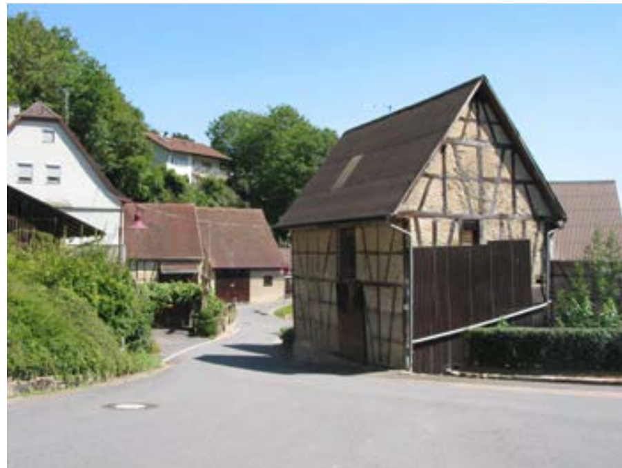
Zentral stehendes Scheunengebäude; Blick von Nordwesten
