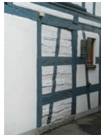
Ansicht von Norden, Detail Fachwerk
