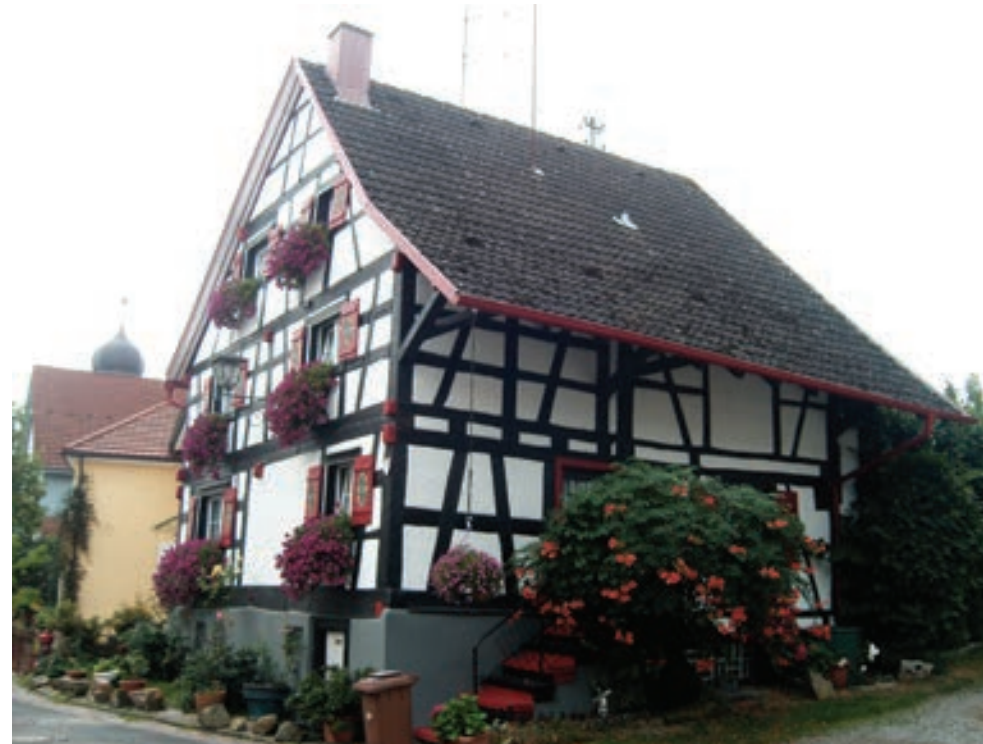
Ansicht von Nordosten
