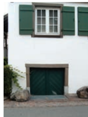
Ansicht von Westen, Detail Kellertür
