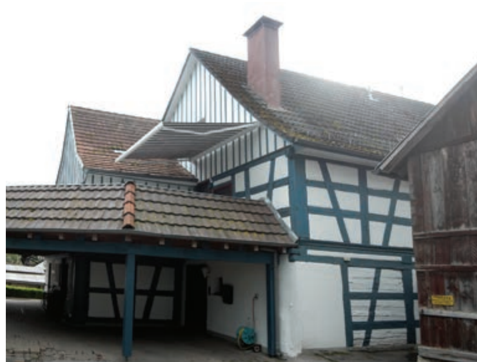
Ansicht von Nordosten
