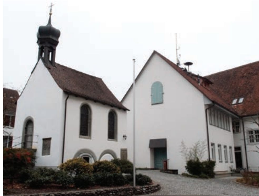
Ansicht der Hofseite von Südwesten
