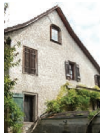
Ansicht von Süden, Detail Fenster
