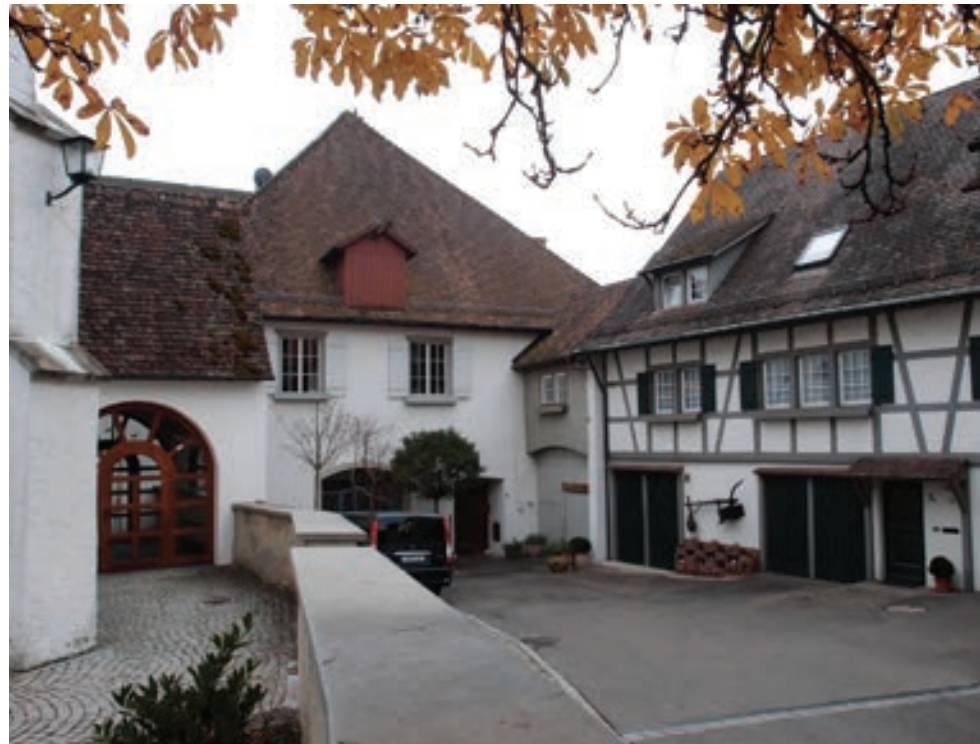
Ehemaliger Wirtschaftshof des Stifts, Blick nach Südwesten
