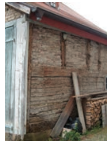
Ansicht von Südwest , Detail Wand
