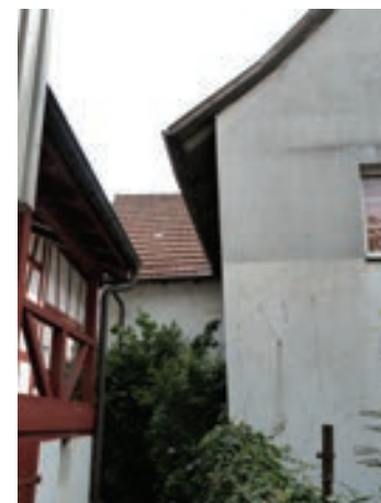
Ansicht von Westen, Detail Fachwerk unter Putz
