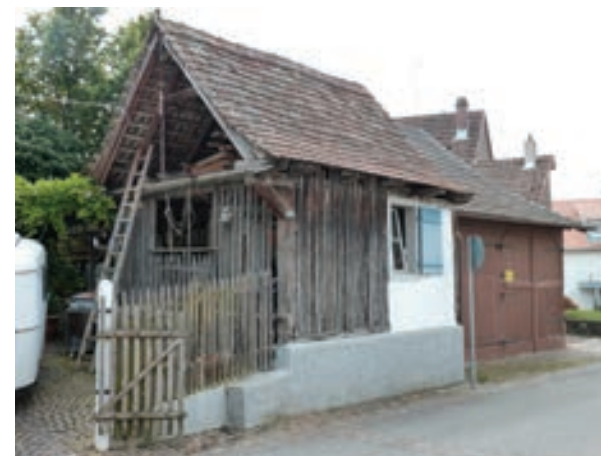
Ansicht von Westen, Schuppen
