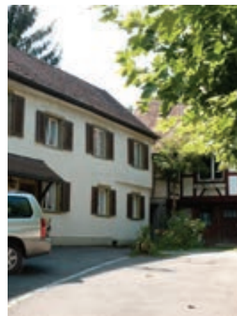
Ansicht von Osten, Sackraum
