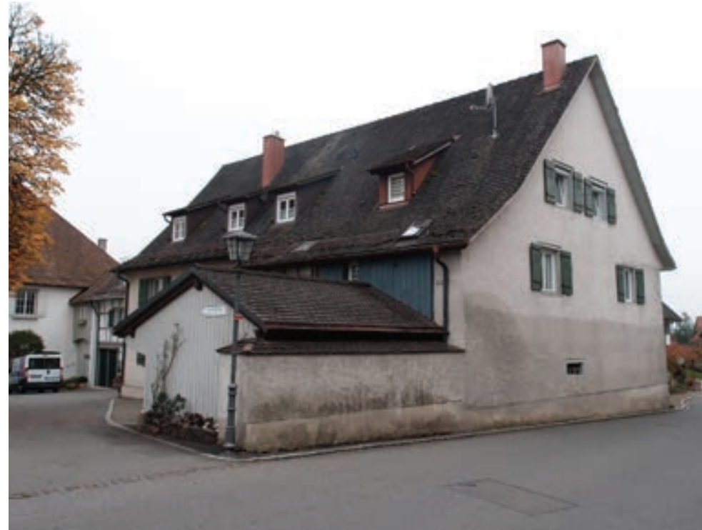
Blick auf Nr. 7 und 7a von der Straße An der Stalden nach Südwesten
