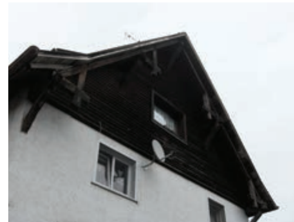
Ansicht von Süden, Detail Fluggespärre
