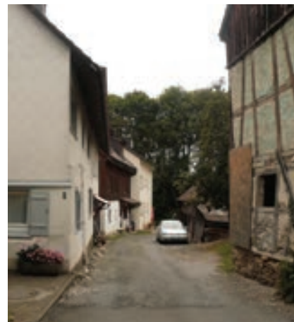
Blick Richtung Ortsrand ( Höhe Nr. 2 ) nach Westen
