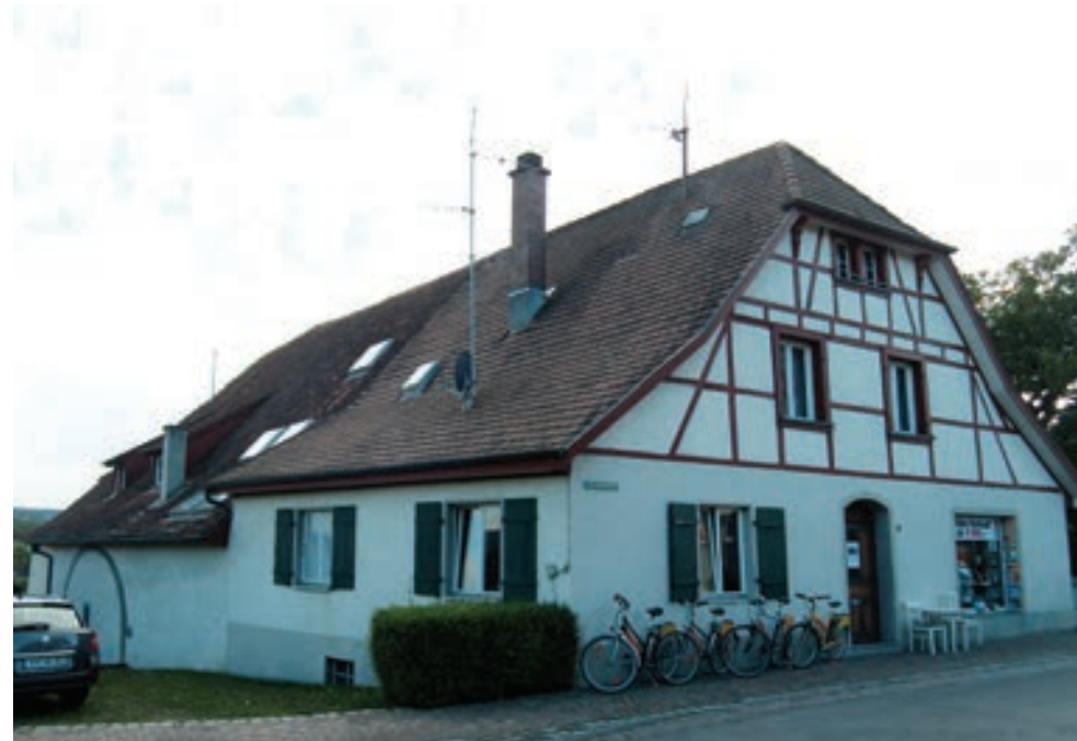
Ansicht von Nordosten
