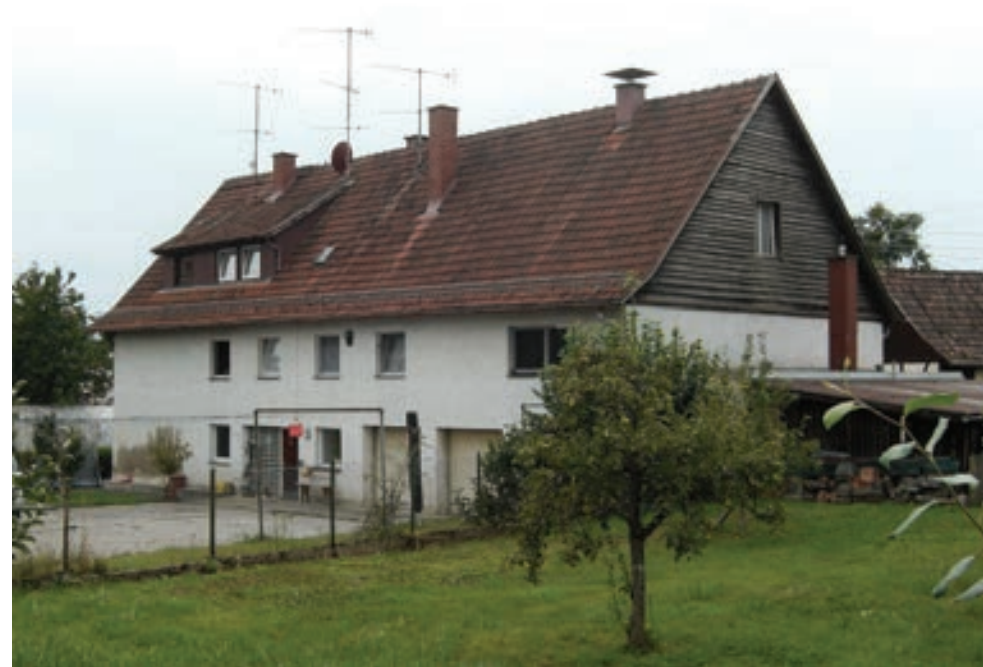
Ansicht von Nordosten
