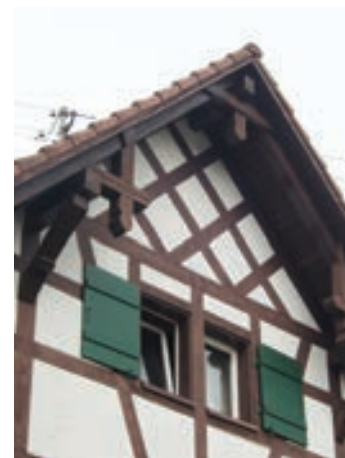
Ansicht von Südwesten, Detail Fluggesperre
