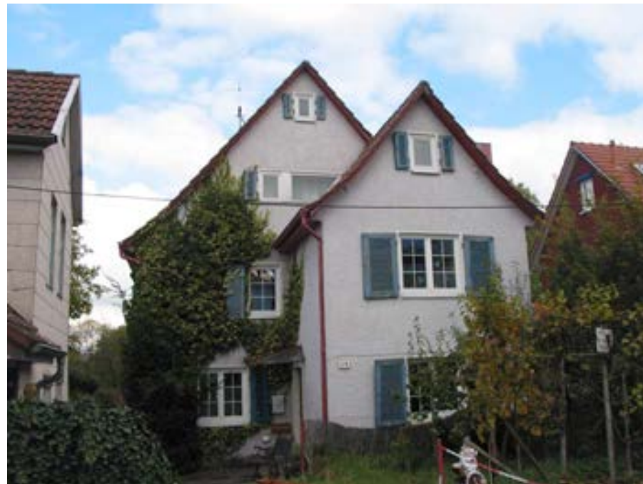
Ansicht des Wohngebäudes von Süden
