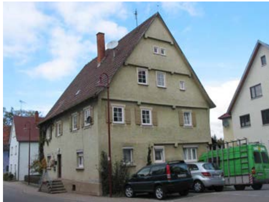
Ansicht des zentral stehenden Wohngebäudes von Südosten
