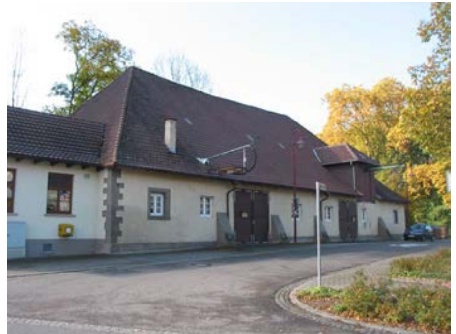
Ansicht der Kelter von Norden
