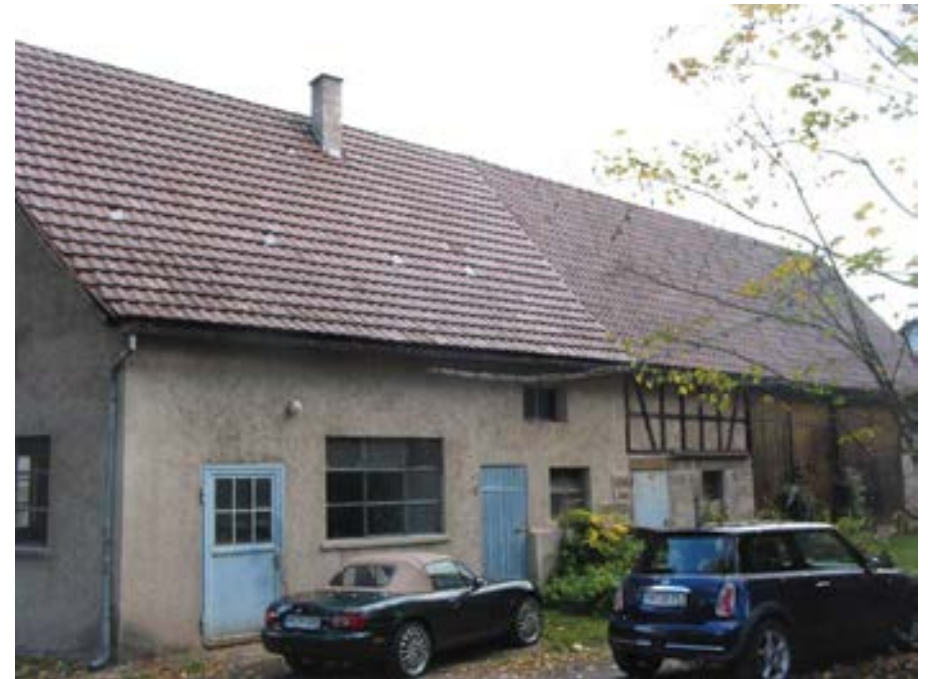
Ansicht des Werkstatt- und Scheunengebäudes von Südwesten
