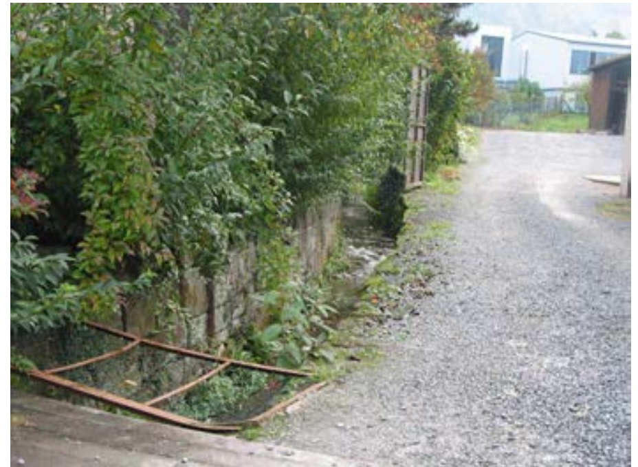
Blick auf den Schlierbach südöstlich der Hinteren Gasse
