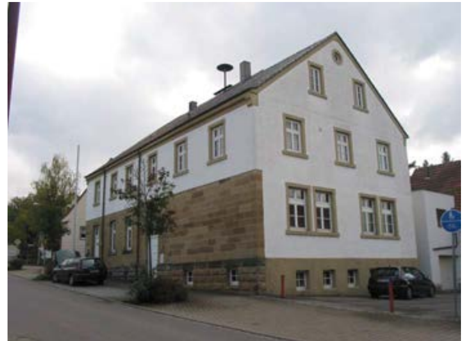
Ansicht des „neuen“ Rat- und Schulhauses von Nordwesten
