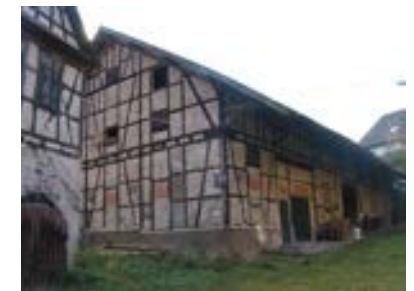
Ansicht der südöstlichen Scheune
