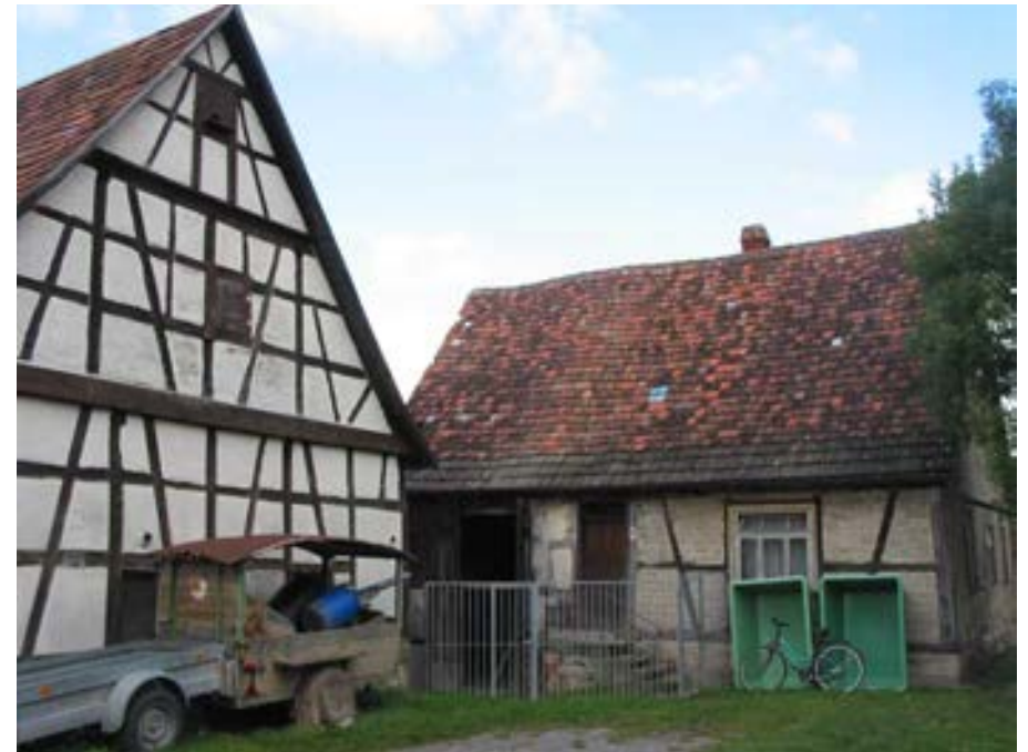
Ansicht des ehemaligen Armenhauses von Süden mit nebenstehender Scheune
