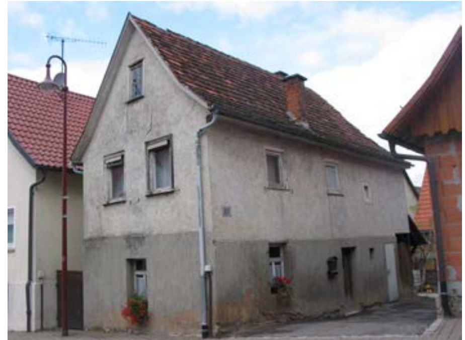
Ansicht des Wohngebäudes von Südosten
