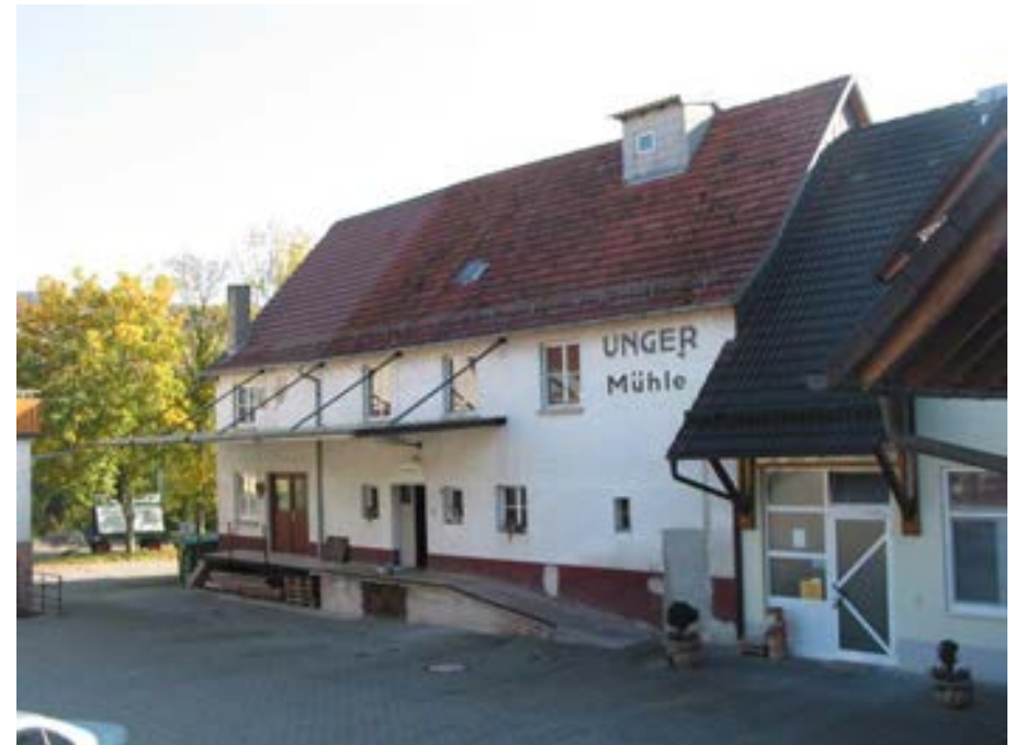
Ansicht des Mühlengebäudes von Westen
