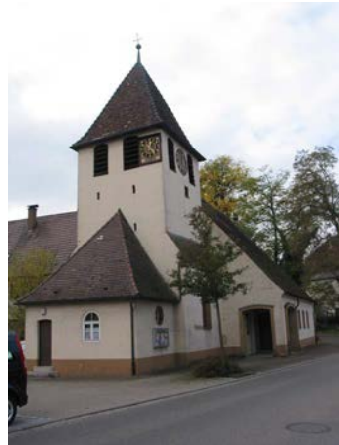
Ansicht der Pfarrkirche von Osten
