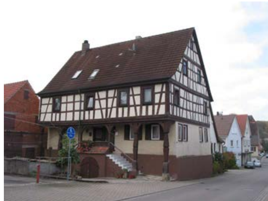
Ansicht des stattlichen Wohngebäudes am östlichen Eingang in den historischen Ortskern
