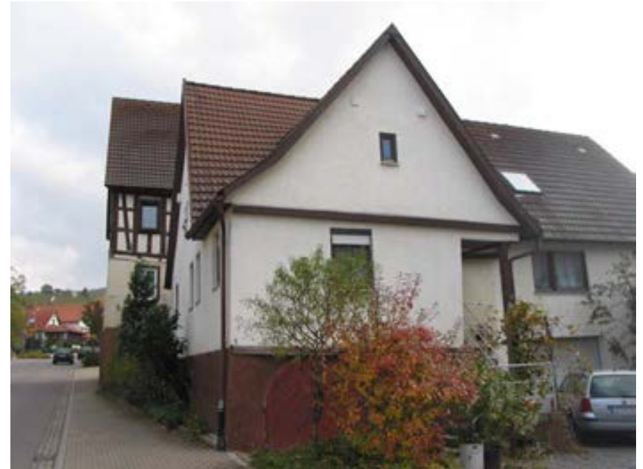
Ansicht des Weingärtnerhauses von Westen
