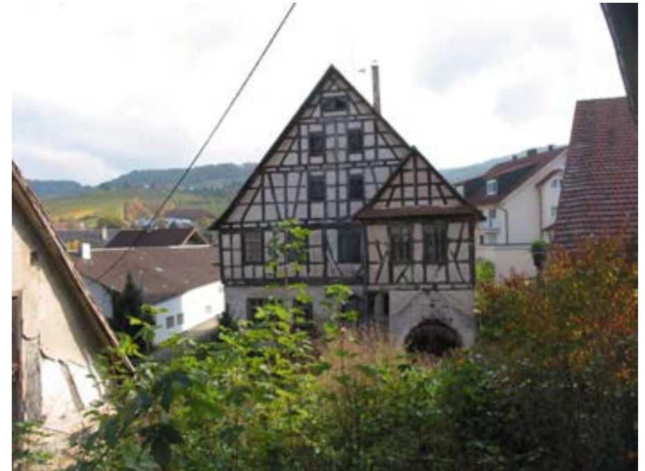
Blick vom Meiereigebäude in Richtung Osten auf die Rentamtei
