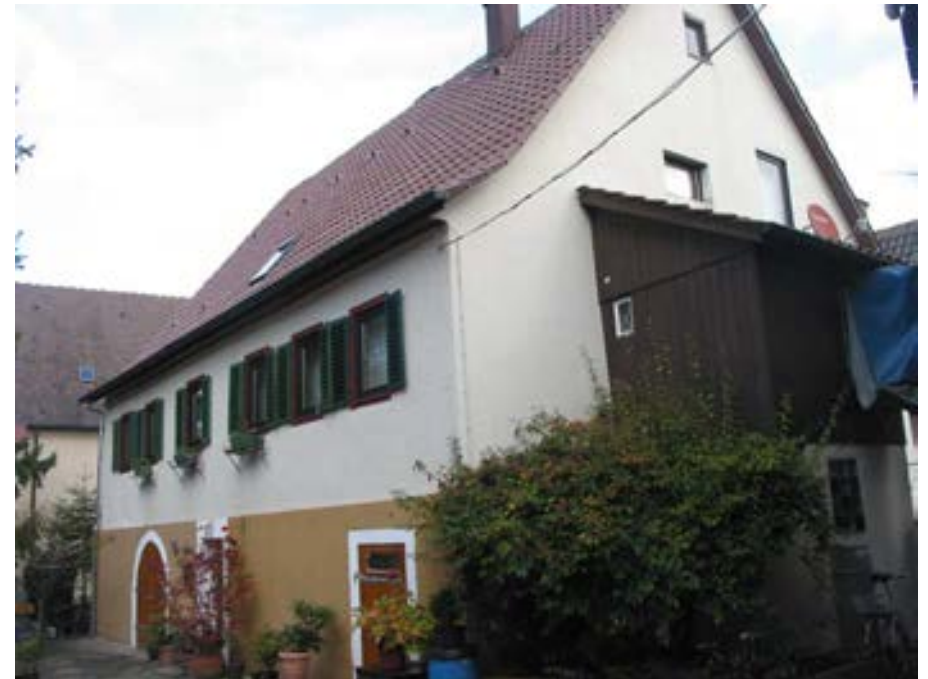
Ansicht des Pfarrhauses von Süden
