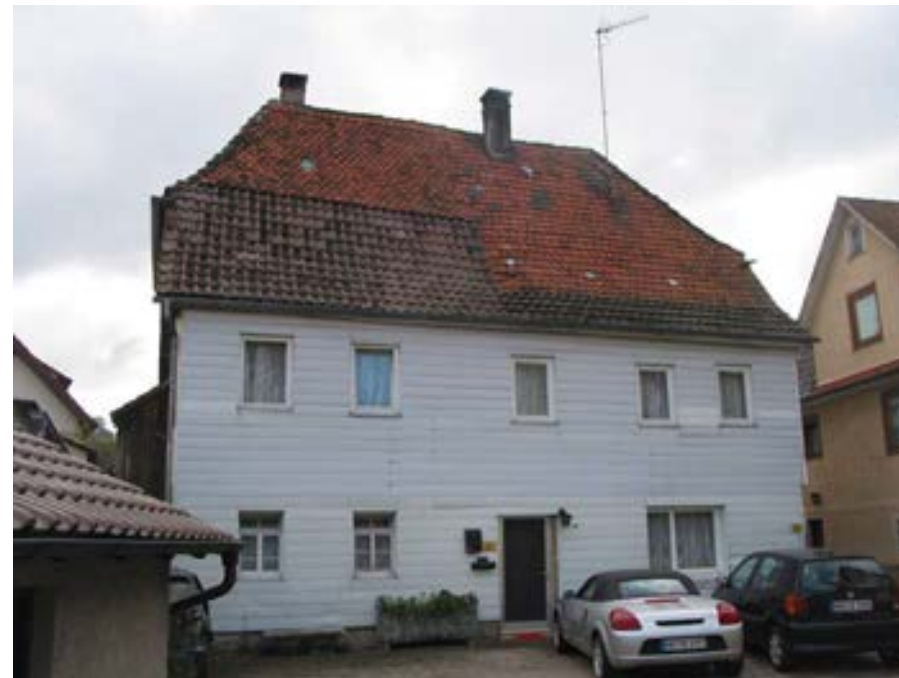
Wohngebäude in direkter Nachbarschaft zur Pfarrkirche; Blick von Norden
