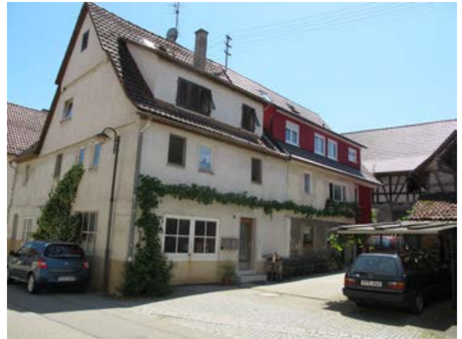
Ansicht des Hakengehöfts von Nordwesten
