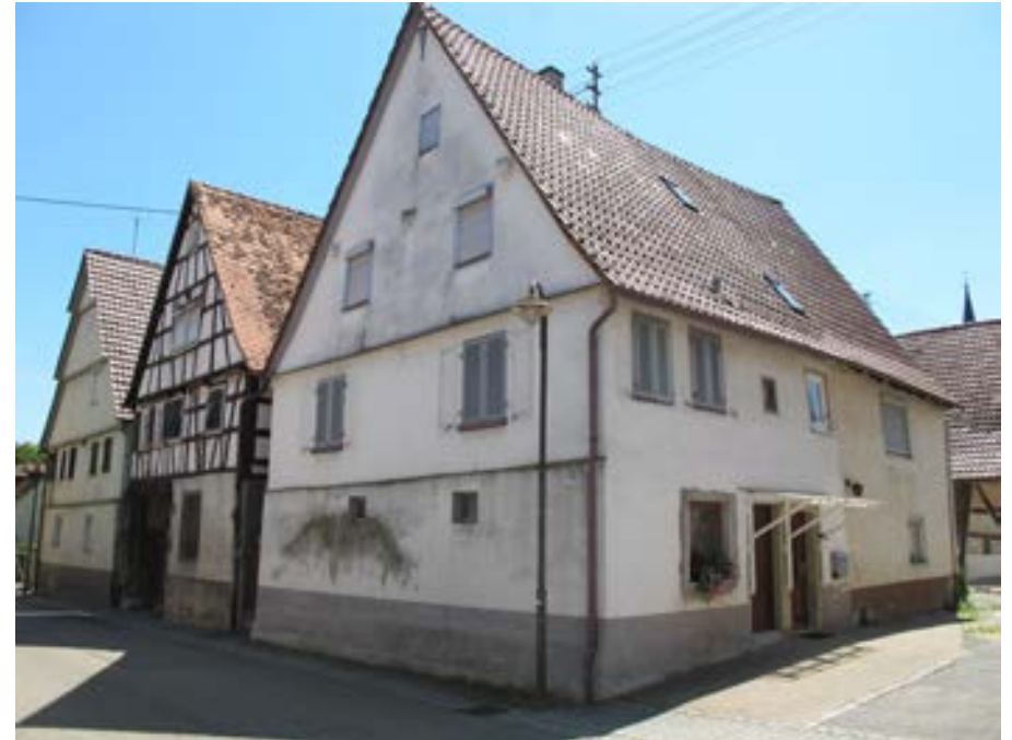
Ansicht des Hakengehöfts von Nordwesten
