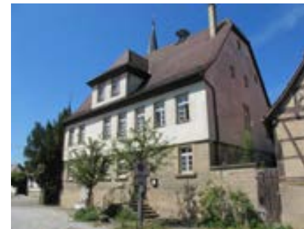
Ansicht des Pfarrhauses von Nordosten
