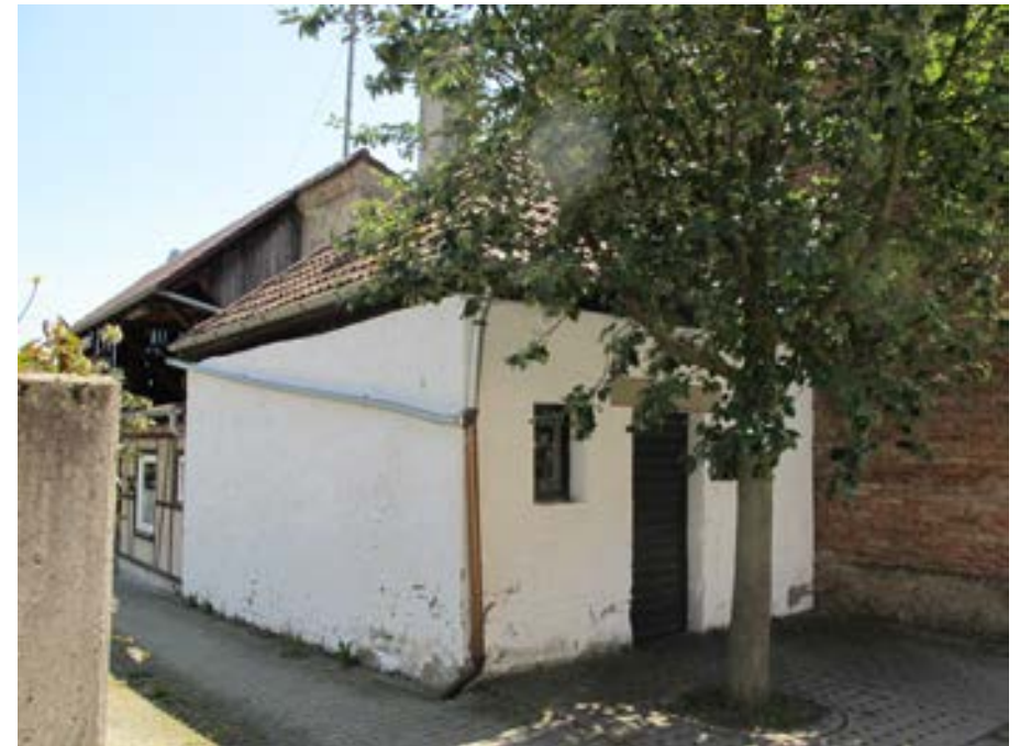
Ansicht des Backhauses von Nordwesten
