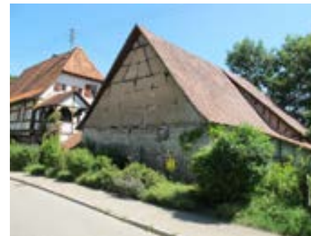
Ansicht der Scheune von Südwesten
