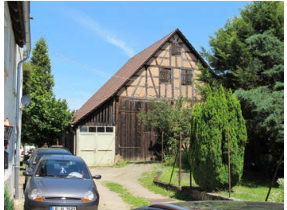
Ansicht der Scheune von Süden
