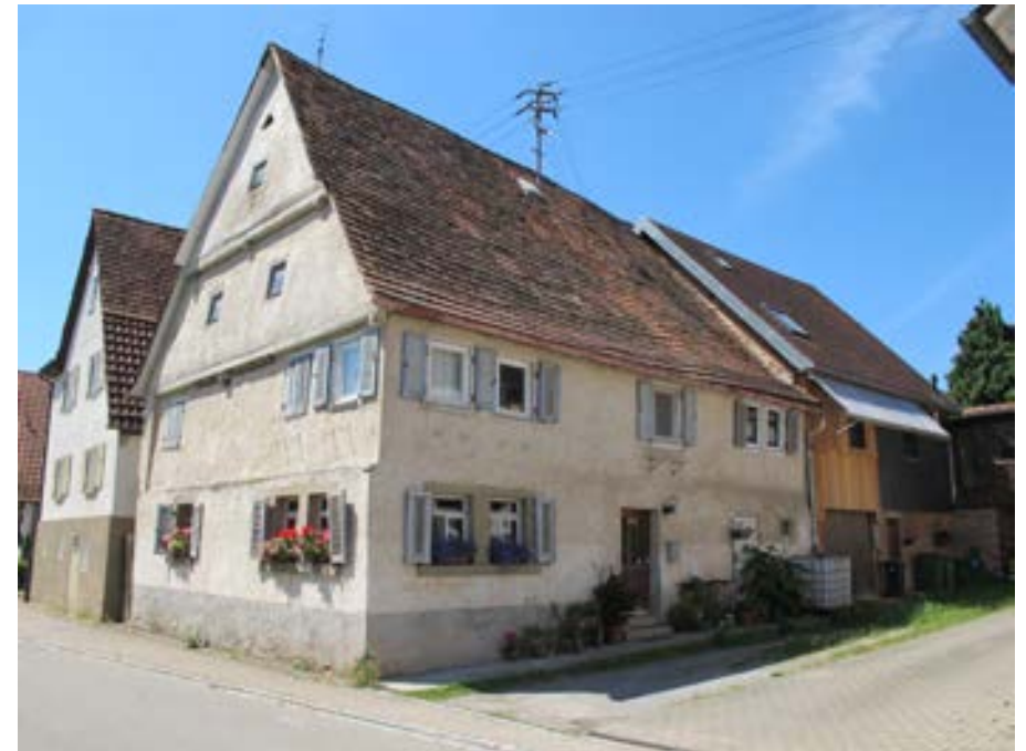
Ansicht des Wohnhauses von Nordosten
