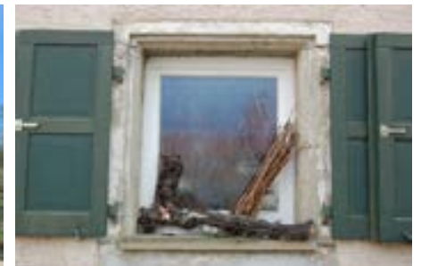
Ansicht eines historischen Fenstergewändes
