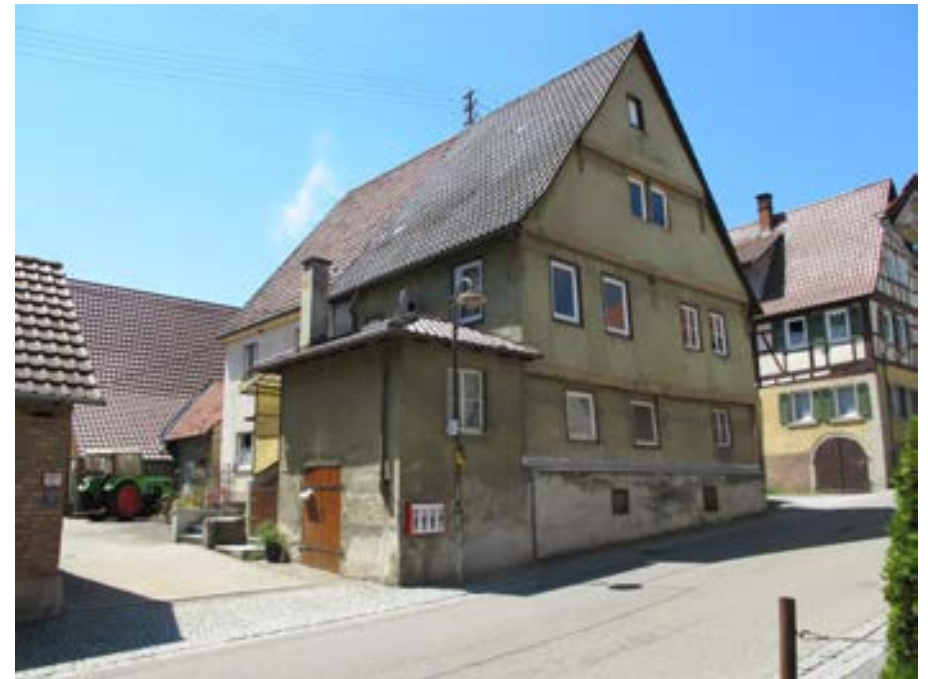
Ansicht des Wohnhauses von Nordosten
