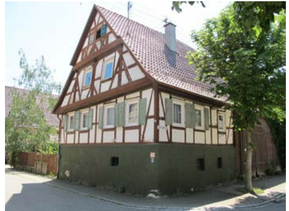
Ansicht des Streckgehöfts von Nordwesten
