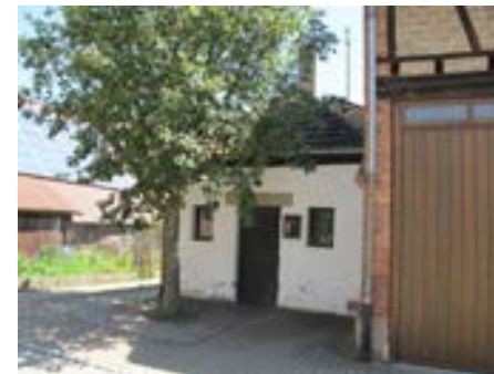
Ansicht von Westen
