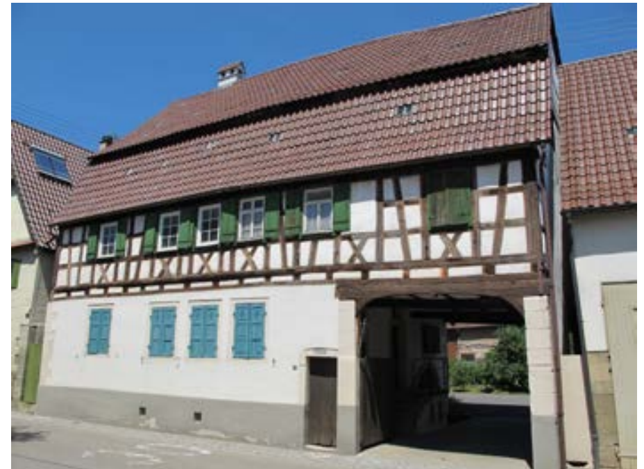
Ansicht des Weingärtnerhauses von Süden
