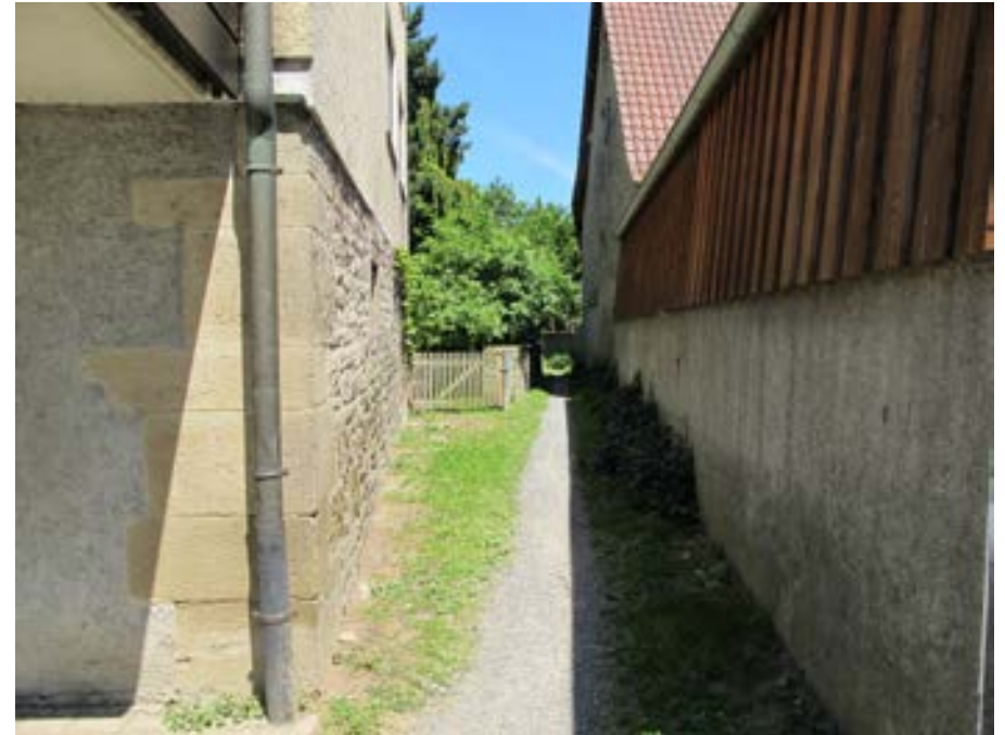
Blick nach Norden auf Höhe von Schloßstraße 15
