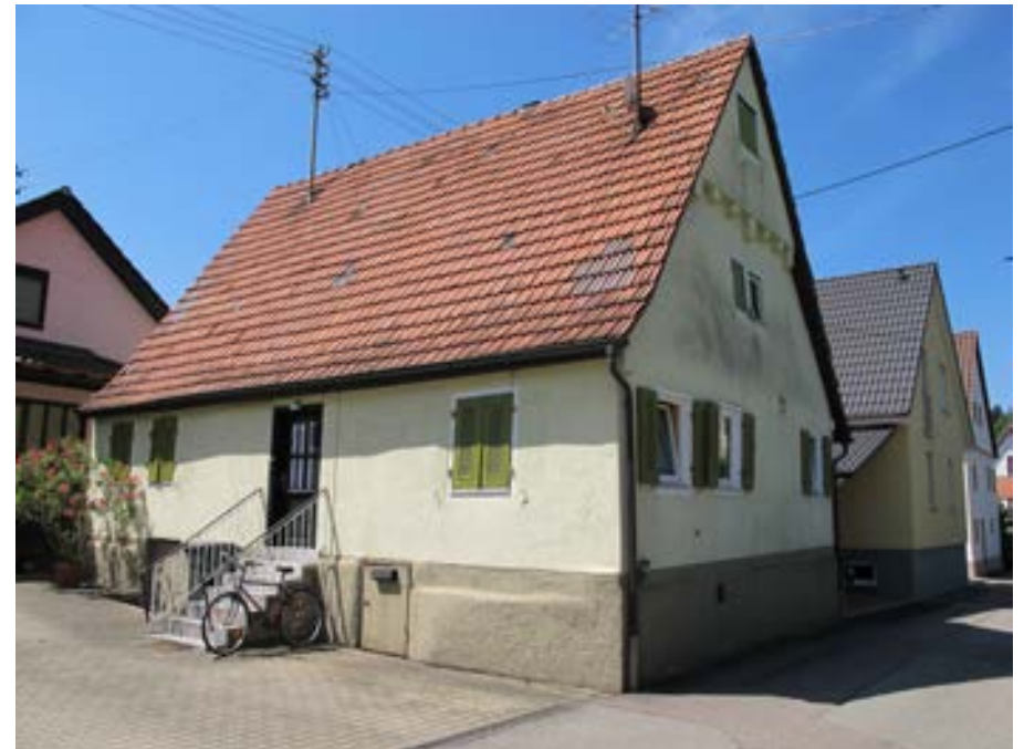
Ansicht des Wohnhauses von Nordosten
