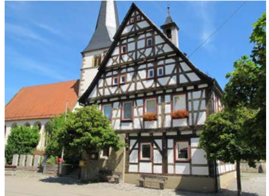
Ansicht des Rathauses von Süden
