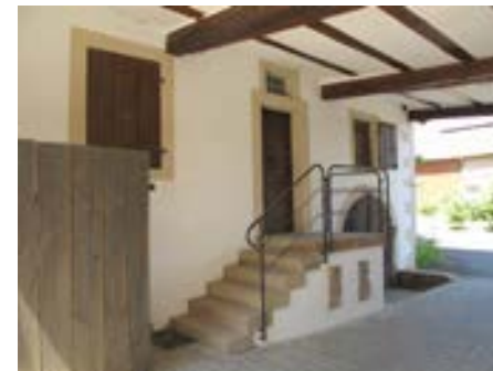
Blick in die Hofdurchfahrt
