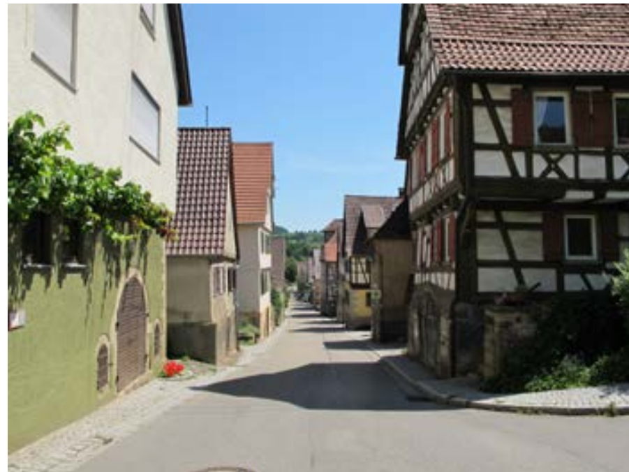
Blick nach Osten auf Höhe der Parkstraße
