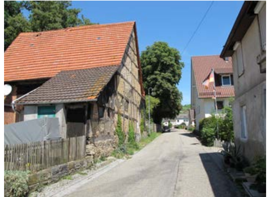
Blick nach Norden auf Höhe von Hausnr. 2
