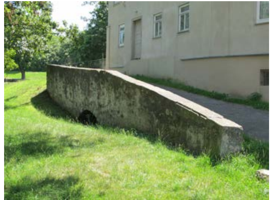
Ansicht der Steinbrücke von Nordwesten
