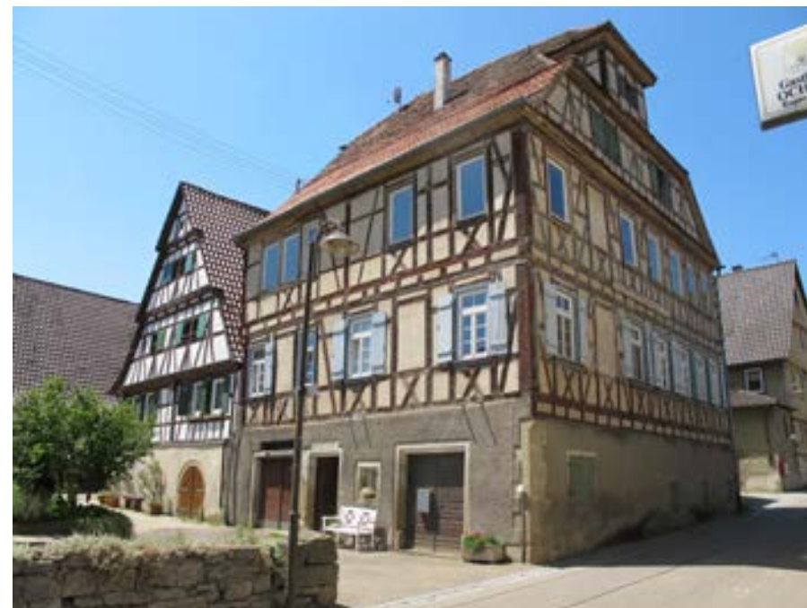
Ansicht des Gasthauses von Nordosten
