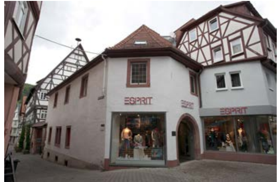
Eckansicht gegen die Hauptstraße, links im Hintergrund das ehem. Hospital
