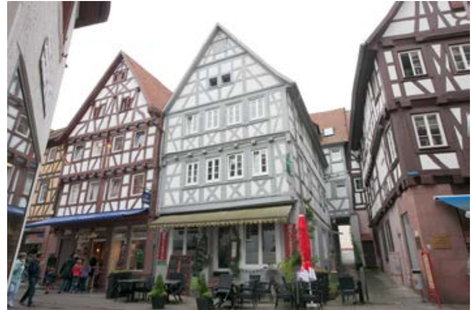
Ansicht gegen die Hospitalgasse
