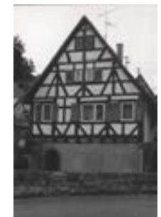
vor Ausbau des Gartenweges, 1980er Jahre (Quelle: LDA)
