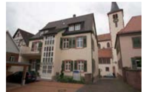
Blick auf die Rückfassade
