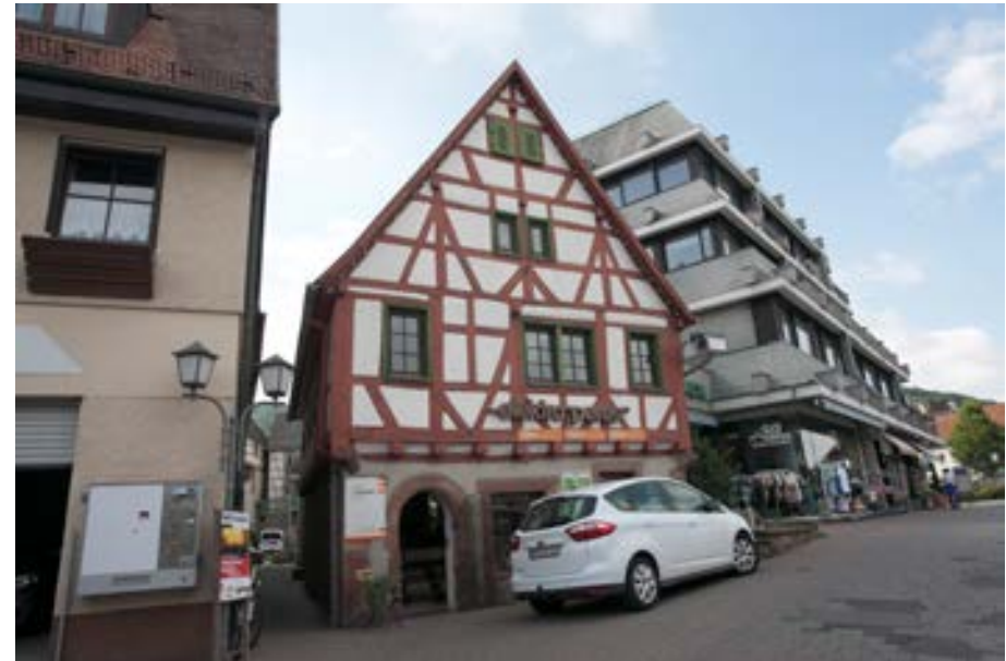
Ansicht gg. Nordosten
