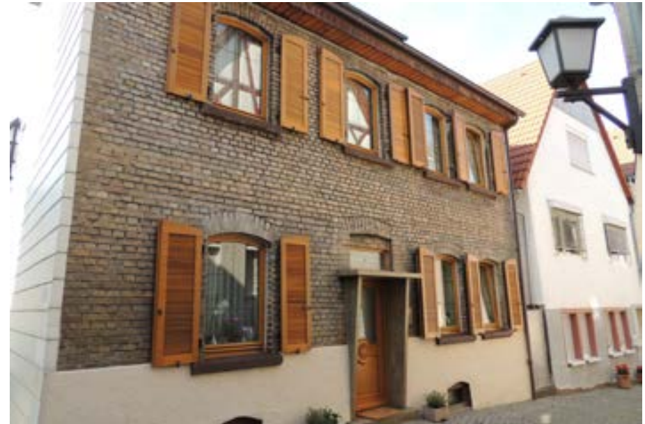
Ansicht gegen Südwesten
