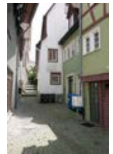
Blick auf die Nordfassade
