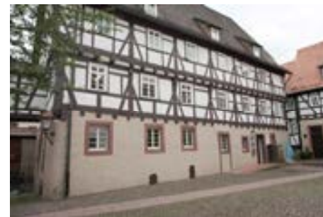
Blick auf die Rückfassade
