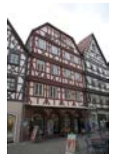
erhaltenswertes Wohn- und Geschäftshaus
