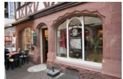
Jugendstilfassade aus Rotsandstein
