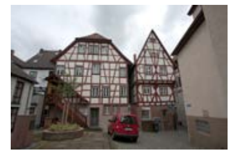
Blick auf die Rückfassade
