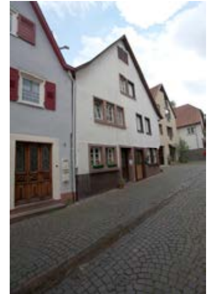
Ansicht gegen Südwesten
