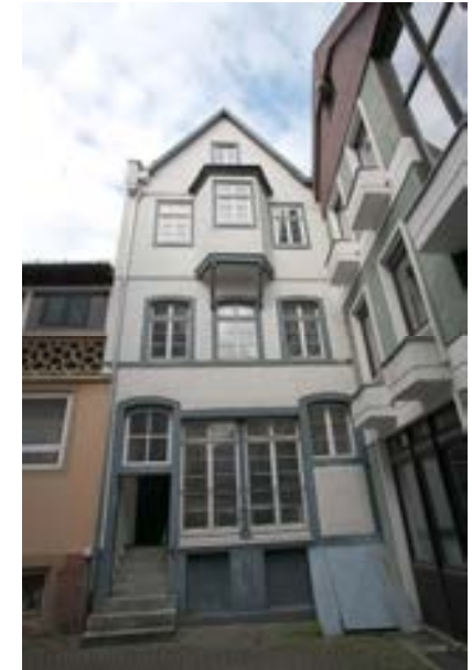
Ansicht gegen Osten, in der Blickachse der Hauptstraße
