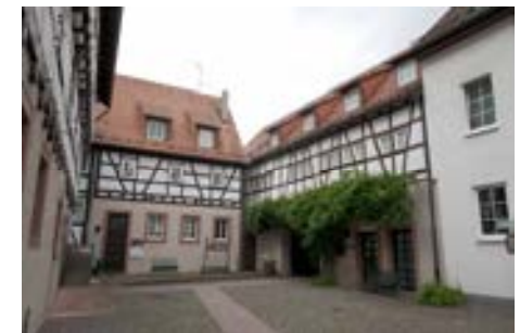
die ehem. Durchfahrtsscheune (re)
