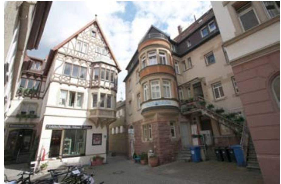
Ölgasse 2, rechts im Bild, Ansicht gegen die Hauptstraße
