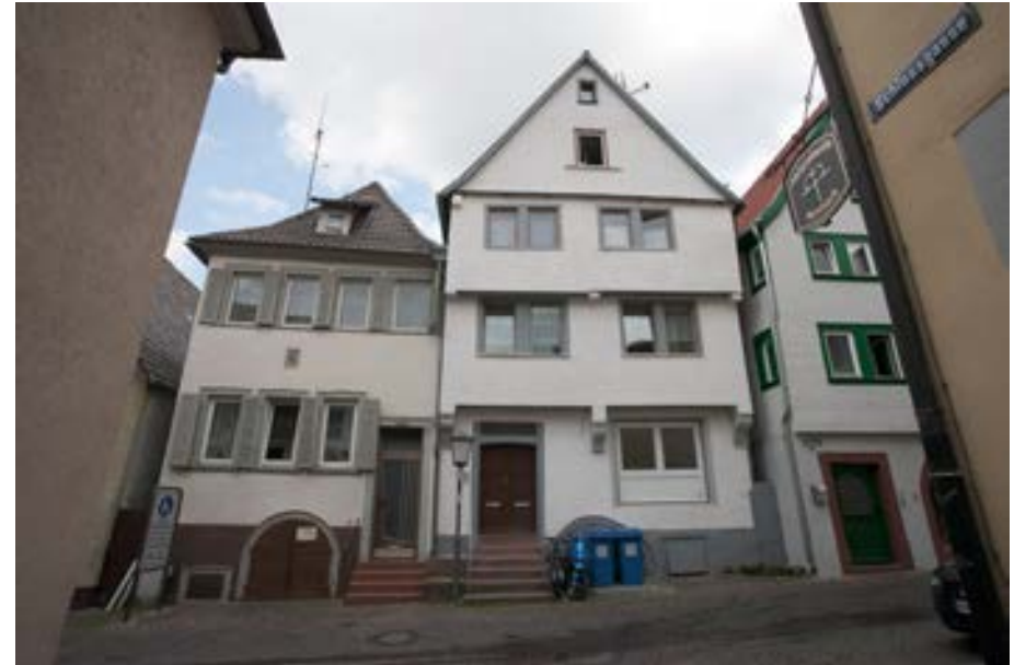
Ansicht gegen Südwesten, gegen die Schlossgasse
