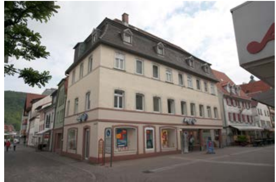
Ansicht gegen Südwesten, links der Blick in den Gartenweg
