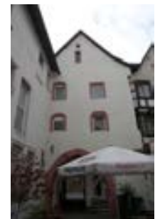
Blick auf die Rückfassade
