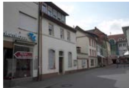
Blick auf die erhaltenswerten Gebäude
