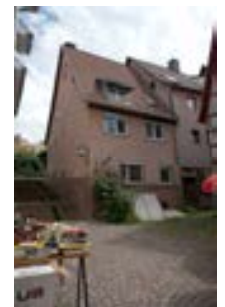
Rückfassade gg. die Badgasse
