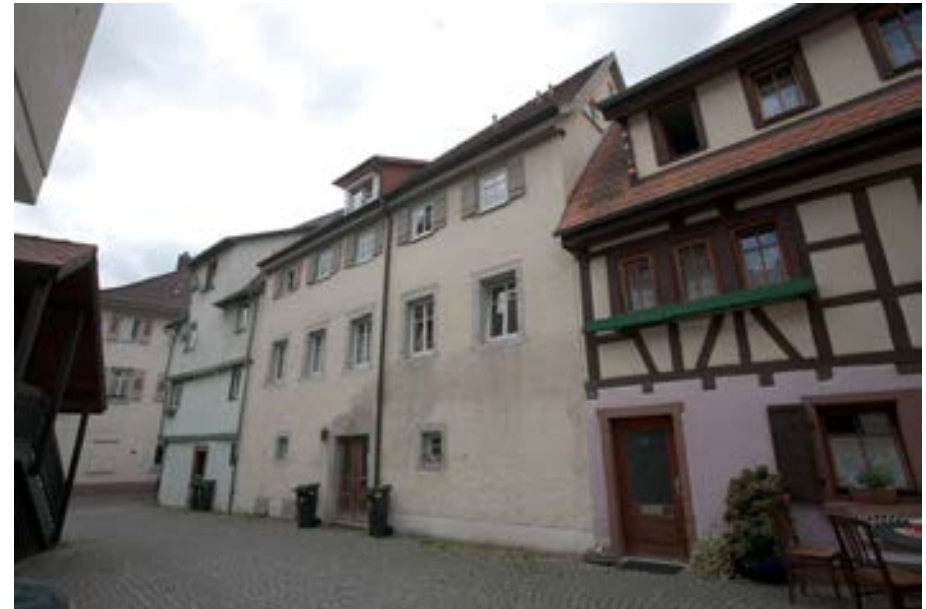
Ansicht gegen Nordosten
