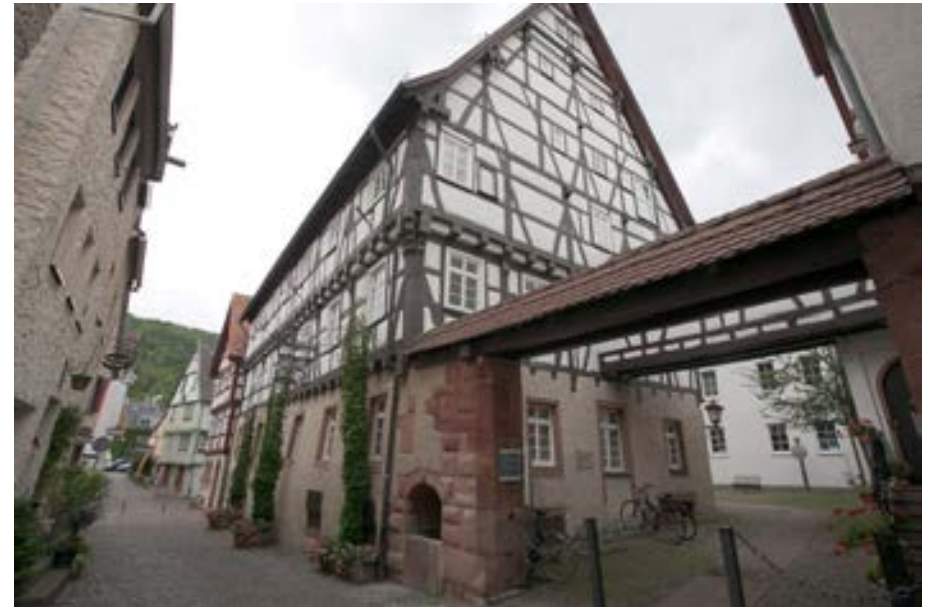
Ansicht von Süden mit Toreinfahrt und Fachwerkübergang (angeschnitten)
