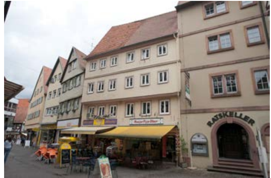
Ansicht gegen Südwesten
