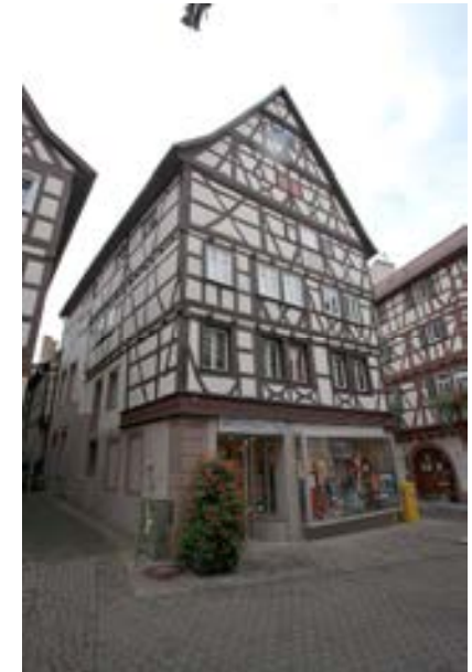
Hauptgebäude an der Hauptstraße, Ansicht gegen Nordwesten
