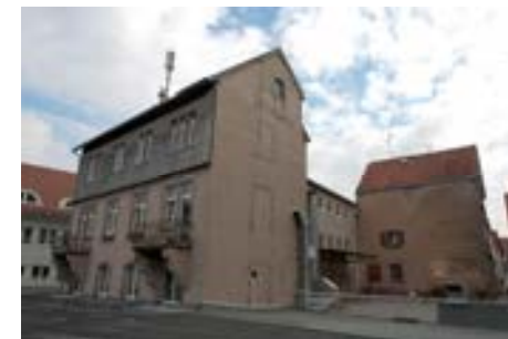
Blick von SW
