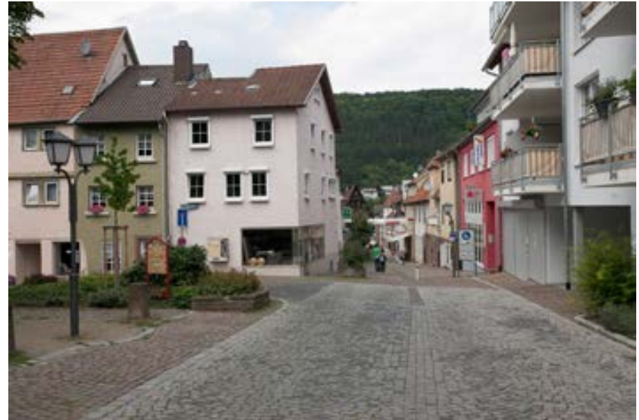
Blick von Osten in die Straße, auf Höhe des ehem. Eselsturm
