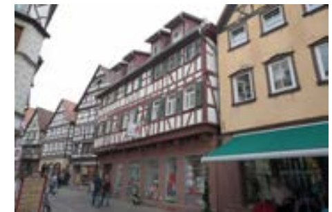
Ansicht gegen die Hauptstraße
