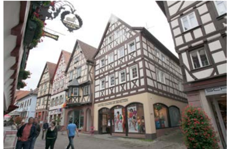
Ansicht gegen Westen mit Hauptstraße 82, 84, 86 (von rechts)
