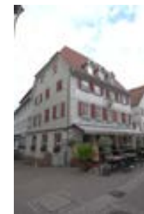
Ansicht gegen Südwesten
