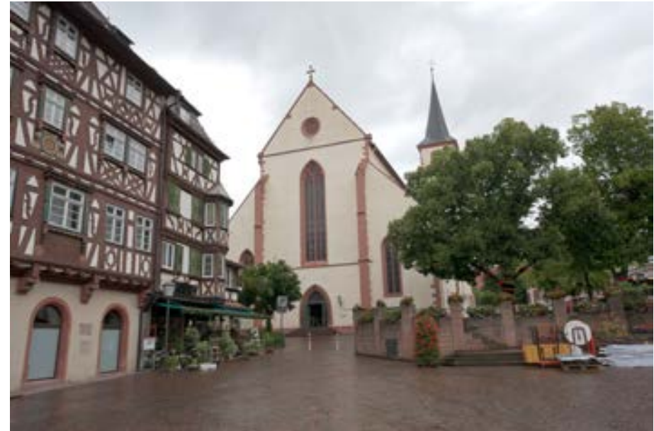
Blick auf das Westportal vom Marktplatz aus
