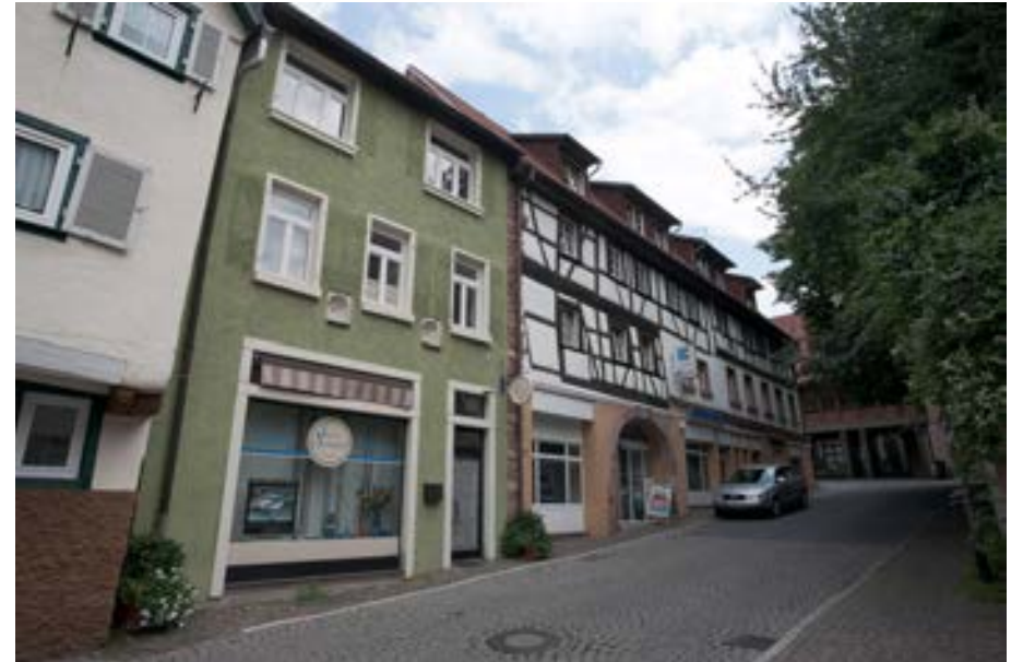
Nr. 7 mit grünem Fassadenanstrich
