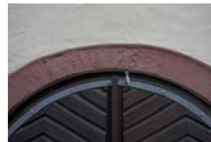
Detail, Kellerbogen bez. 1585
