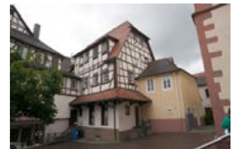
Blick auf das NG (gelb verputzt)
