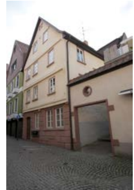
Ansicht gegen Nordwesten, rechts der Durchgang zur Hauptstraße
