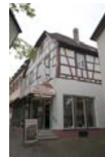
Blick auf die Südfassade
