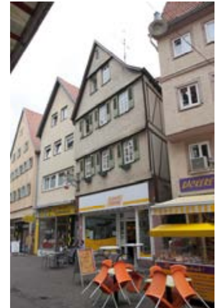
Ansicht gegen Südwesten
