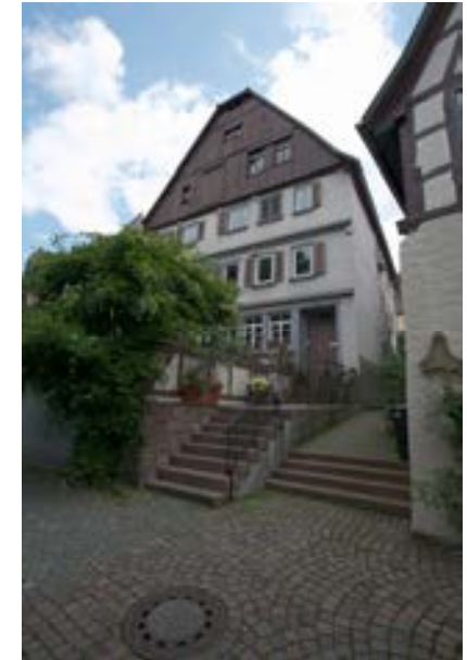
Ansicht gegen Südwesten
