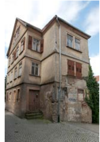
Ansicht gegen Nordosten
