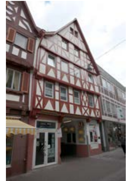
Ansicht gegen die Hauptstraße
