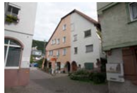
Ansicht gegen die Hospitalgasse
