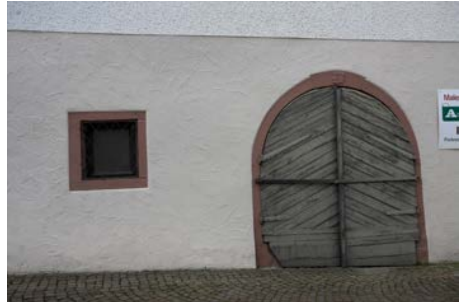
Hanggeschoss mit Kellerbogen
