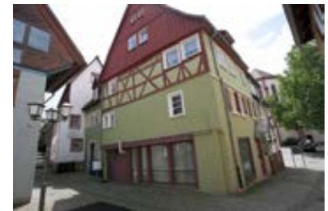
Blick auf die Rückfassade
