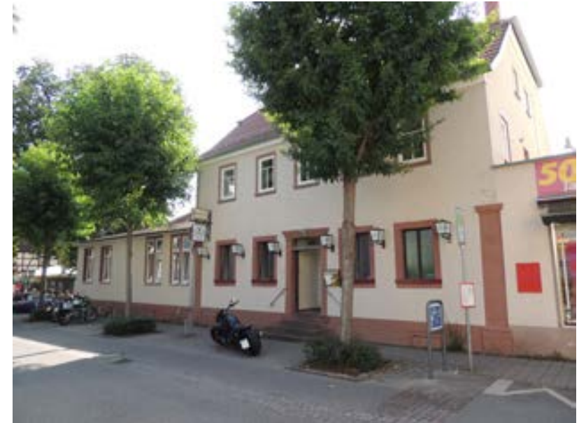
Ansicht gegen Nordosten, im Hintergrund der Ludwigsplatz (Quelle: Stadt)
