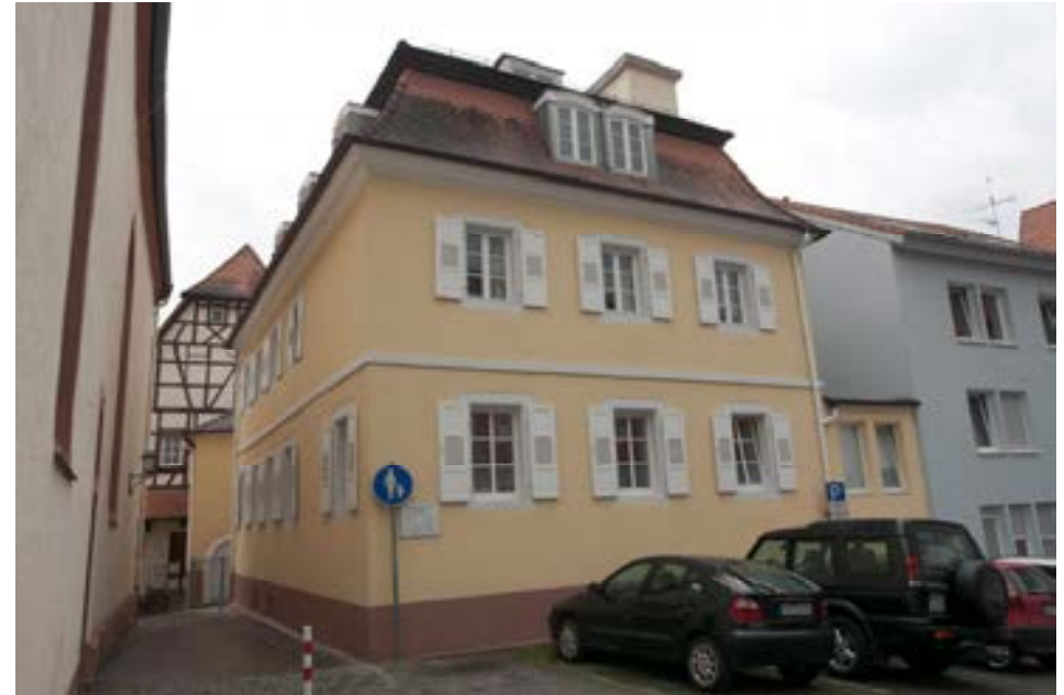
Blick auf die Nordfassade
