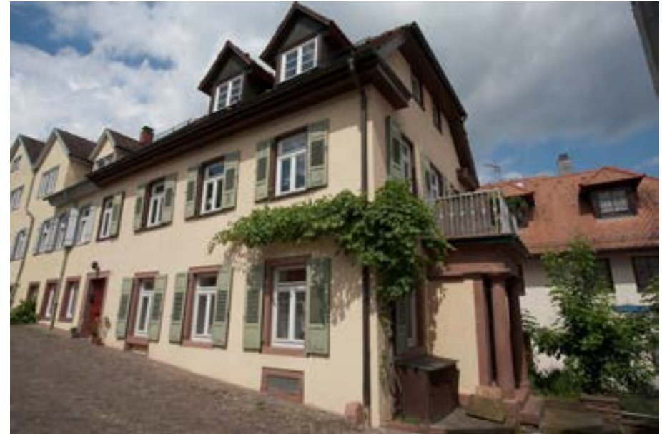
Blick auf die Südfassade
