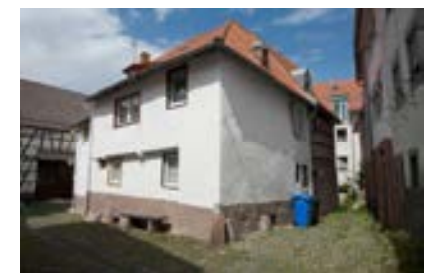
Blick auf den südl. Gebäudeteil
