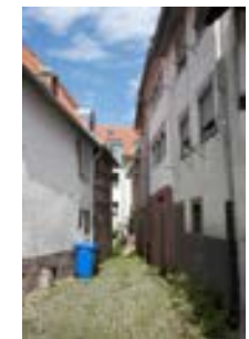
Rückfassade (ganz rechts)
