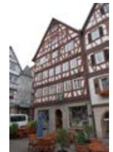
Ansicht gg. Nordosten
