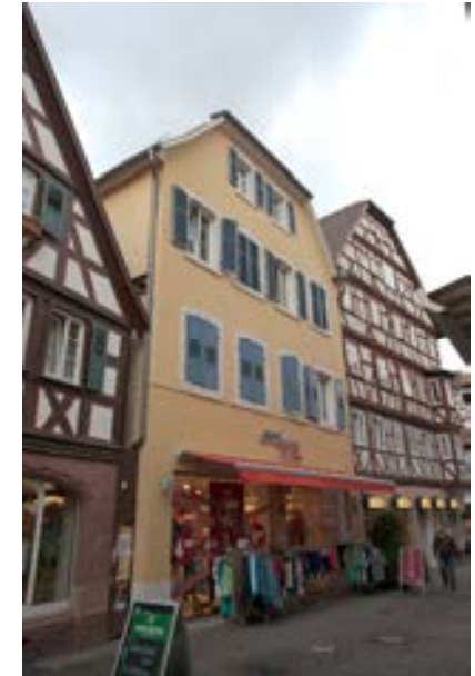
Ansicht gegen die Hauptstraße
