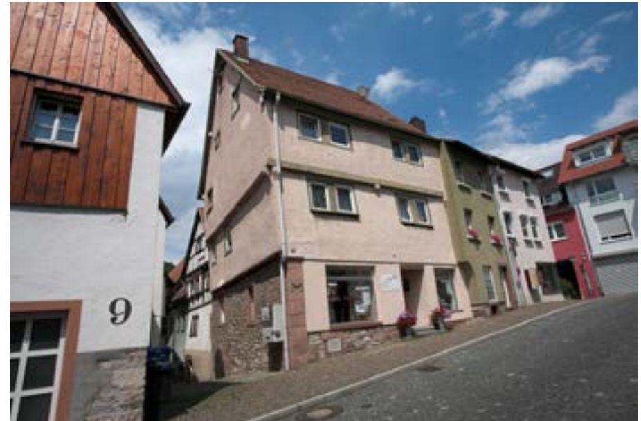
Ansicht gegen Südwesten, die Giebelseite grenzte einst unmittelbar an den Kandelbach
