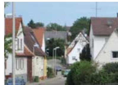
Giebelansicht des Wohnhauses von Süden im Hintergrund des Bildes
