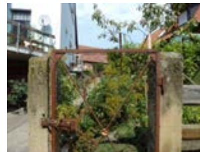
Detail – Einfriedung mit Datierung auf 1848
