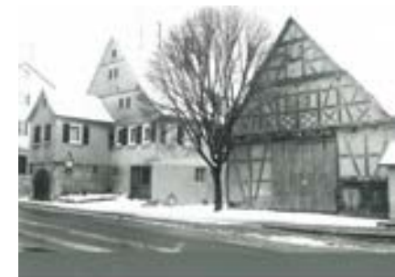
Nordansicht des Gebäudes mit zugehöriger Scheune (abgehangen)
