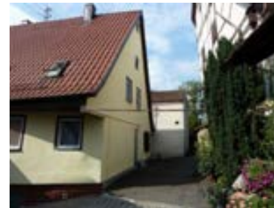
Ansicht Gebäudes von Nordosten
