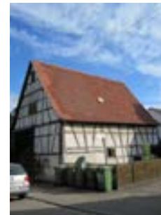
Ansicht der Scheune von Westen
