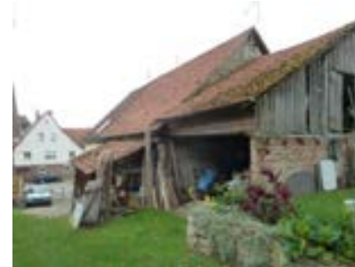
Ansicht der Scheune von Nordosten
