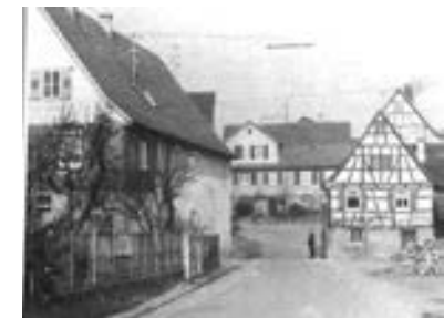
Historischer Straßenraum, im Hintergrund das Wohnhaus an der Hauptstraße von Süden
