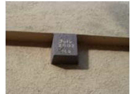
Detail – Inschrift auf dem Balkenkopf datiert letzte Renovierung auf 2002
