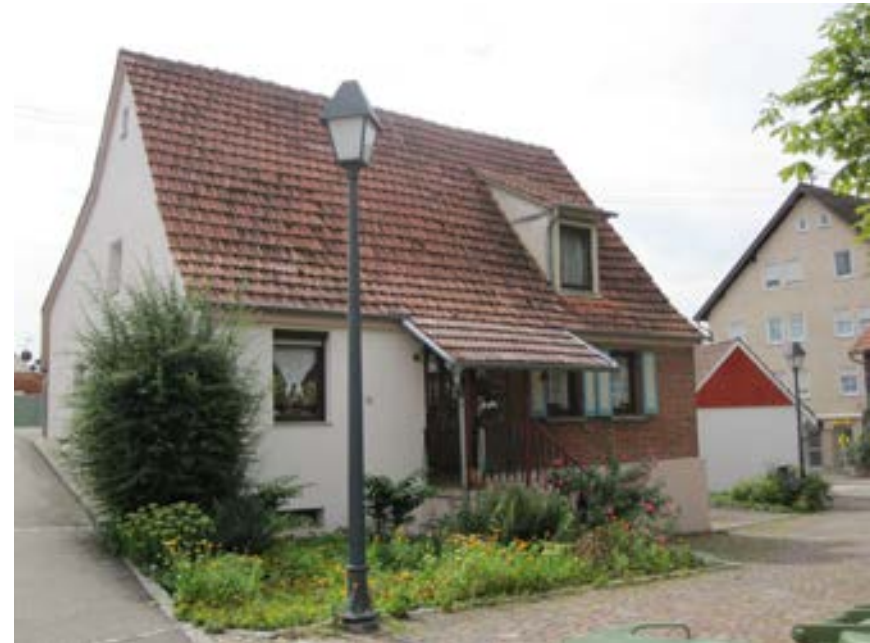
Ansicht der ehemaligen Bäckerei von Nordosten
