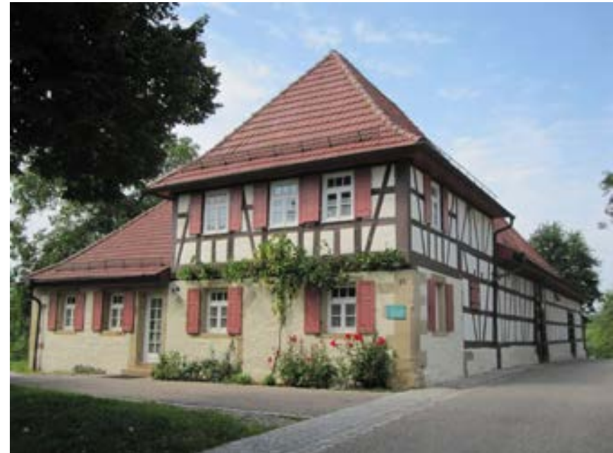
Ansicht der Kelter von Südosten
