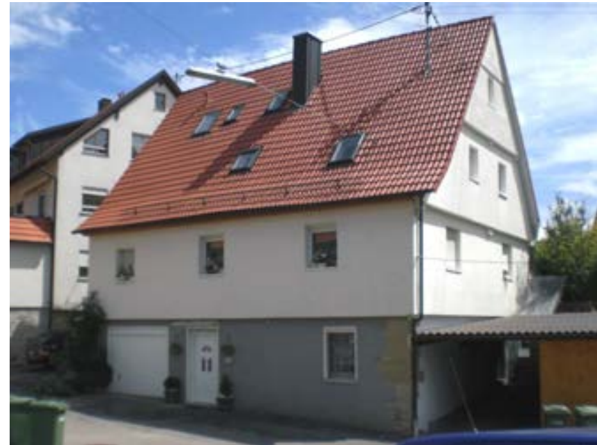
Ansicht des Wohnhauses von Nordwesten
