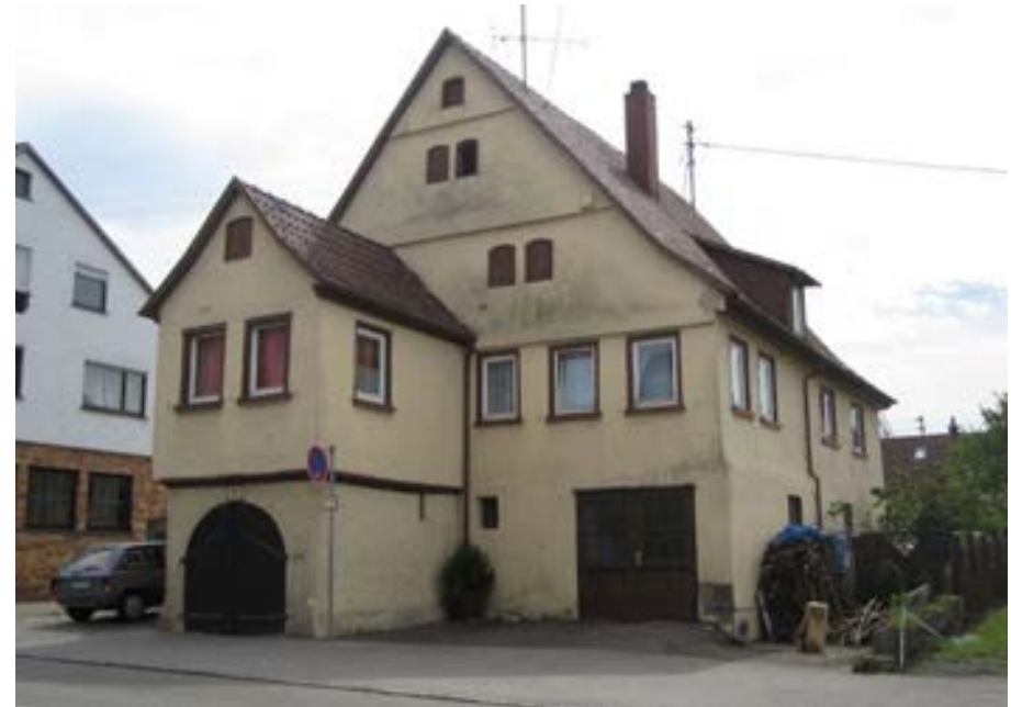
Ansicht des Wohnhauses von Nordwesten
