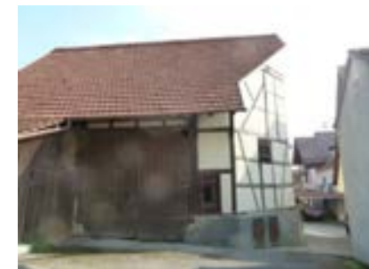
Ansicht des Gebäudes von Südwesten mit Scheunentor
