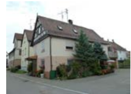
Ansicht des Wohnhauses von Nordwesten
