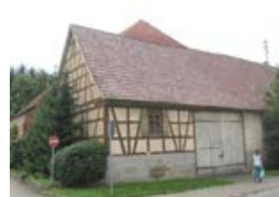
Ansicht des Scheunenanbaus von Nordosten
