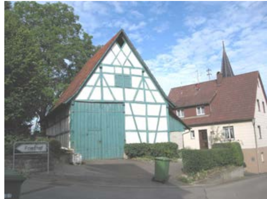
Ansicht der Scheune von Osten
