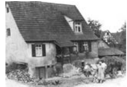
Nordansicht Haus Nr. 39 um 1930
