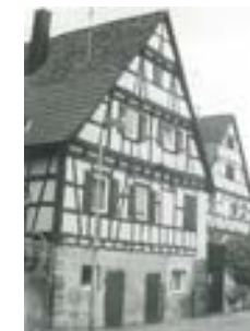
Ansicht des Hauptgebäudes von Südwesten 2. Hälfte des 19. Jh
