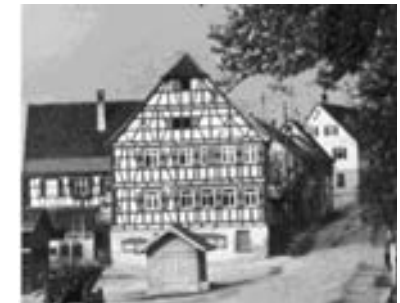
Ostansicht mit Viehwaage im Vordergrund in der 1. Hälfte des 20. Jh.
