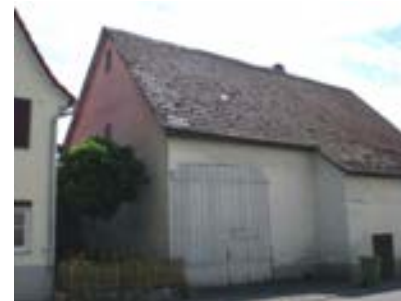
Ansicht des Scheunentracts von Nordosten
