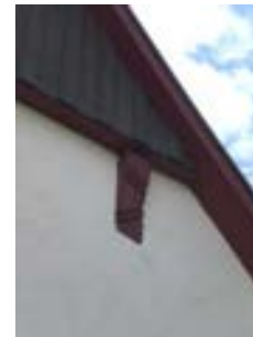
Detail – Zierknagge am Giebel der Scheuer
