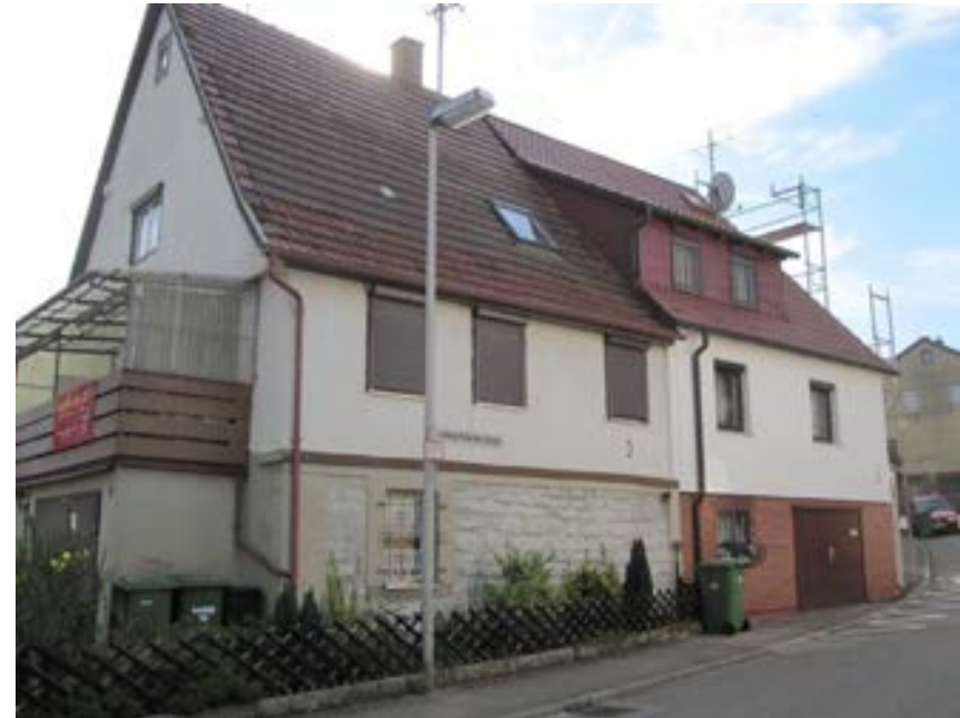
Ansicht des Wohnhauses von Nordwesten
