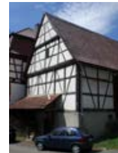
Ansicht der Scheune von Südosten
