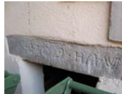
Detail – Inschrift am rückwärtig gelegenen Treppenaufgang mit Datierung auf 1709
