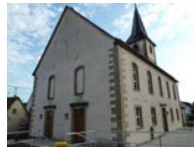
Ansicht der Kirche von Südwesten
