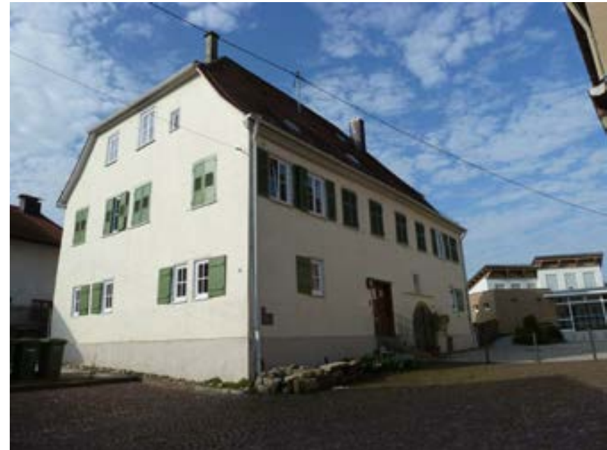
Ansicht des Pfarrhauses von Nordosten
