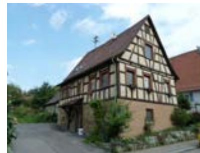
Ansicht des Ausgedinghauses von Südwesten
