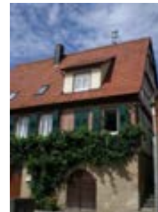
Ansicht des Wohnhauses mit Rundbogentor von Südosten
