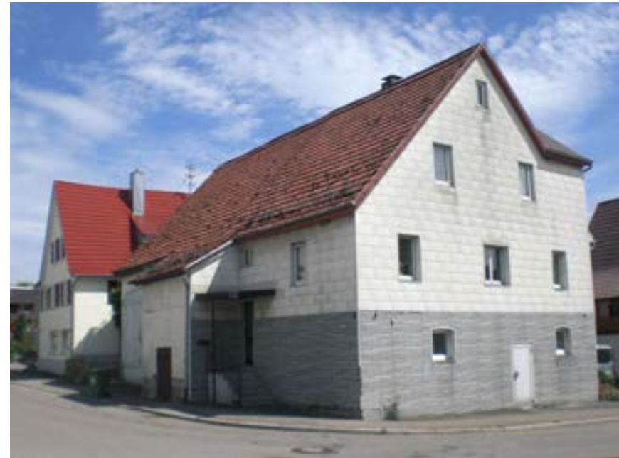
Ansicht des stark überformten Gebäudes von Nordwesten
