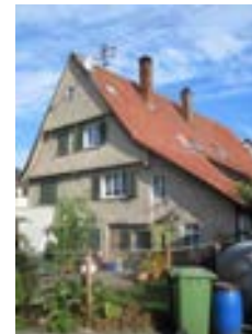
Ansicht des Gebäudes von Südosten
