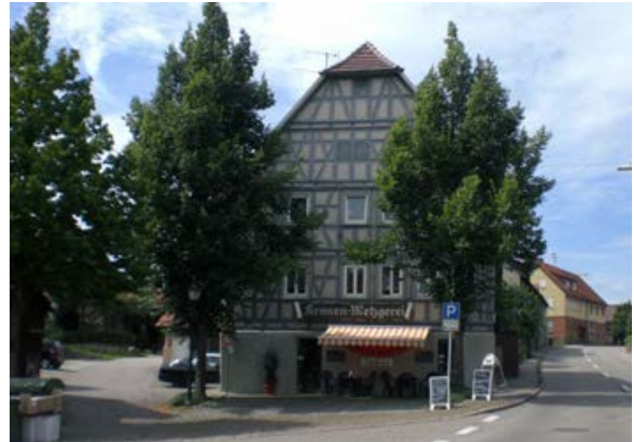
Ansicht des Gasthauses von Osten
