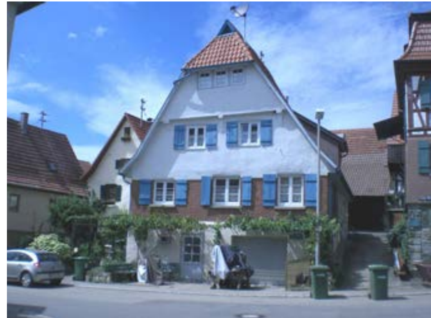
Ansicht des Wohnhauses von Südosten
