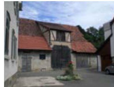
Südansicht des rückwertigen Stallgebäudes
