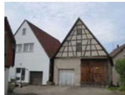
Ansicht der Scheune von Osten
