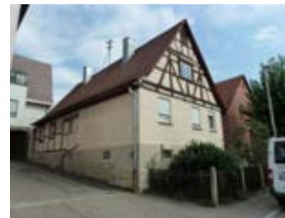
Ansicht Gebäudes von Südwesten
