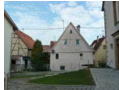
Ansicht des Wohnhauses von Süden, rechts der Eingang zur Ludwig-Hofacker-Kirche
