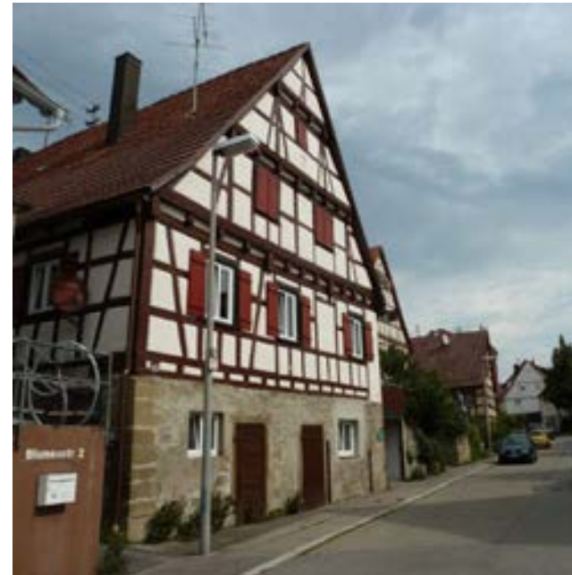
Ansicht des Hauptgebäudes von Südwesten
