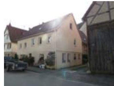
Ansicht des Wohnhauses von Nordwesten
