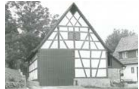
Ostansicht der Scheune neben dem Wohnhaus
