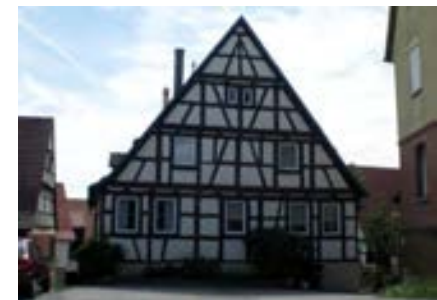
Links im Bild der Fußweg von der Hauptstraße aus gesehen.
