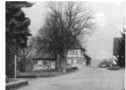
Südansicht der 1718 erbauten Kelter um 1960
