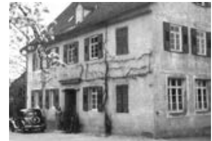
Ansicht der 1837 erbauten Grundschule nach dem zweiten Weltkrieg
