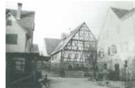
Südansicht des Gebäudes von der Lindenstraße aus
