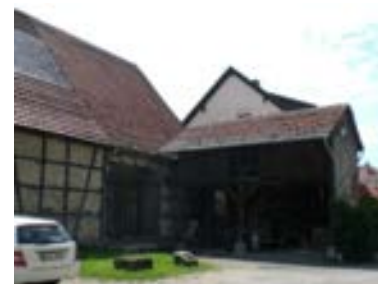
Ansicht der rückwärtigen Scheune von Nordosten
