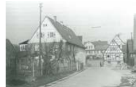
Blick nach Nordwesten auf Höhe von Hausnummer 6
