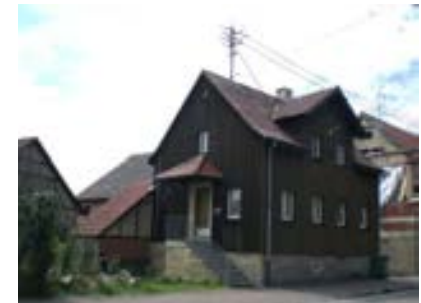
Ansicht des Wohnhauses mit Nebengebäude von Nordosten
