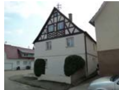
Ansicht des Wohnhauses von Nordwesten
