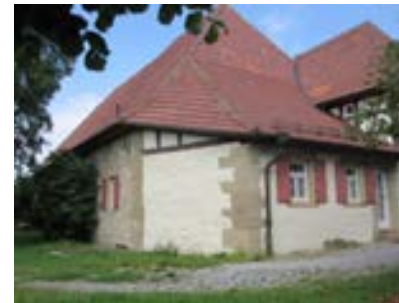
Ansicht der Kelter von Südwesten
