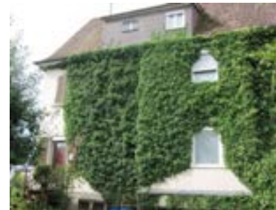
Ostansicht des Wohngebäudes von 1923
