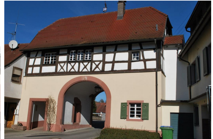
Hauptstraße 7, Ansicht von der Stadtseite
