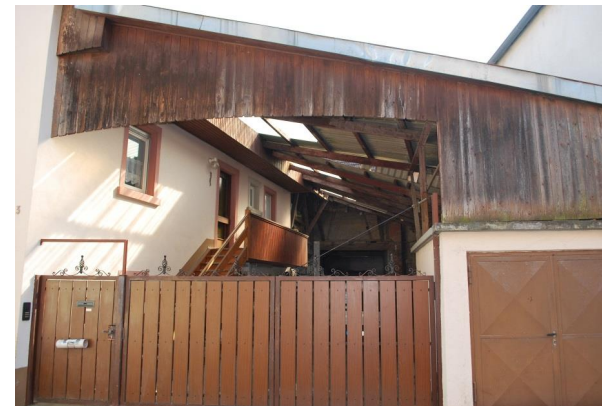
Fischergasse 3, Hof und Scheune
