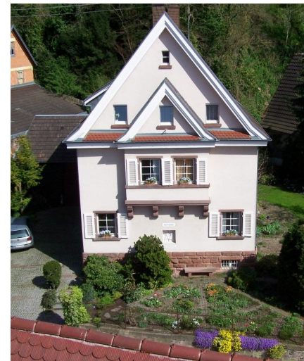
Blick auf Haus Breithaupt von W
