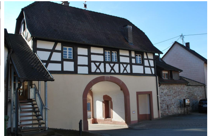
Hauptstraße 7, stadtauswärtige Ansicht
