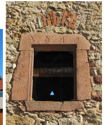
Fenster im Anbau Suppengasse
