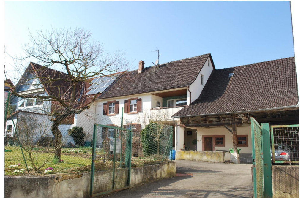
Kochgasse 2 nach NW, links daneben Kochgasse 4
