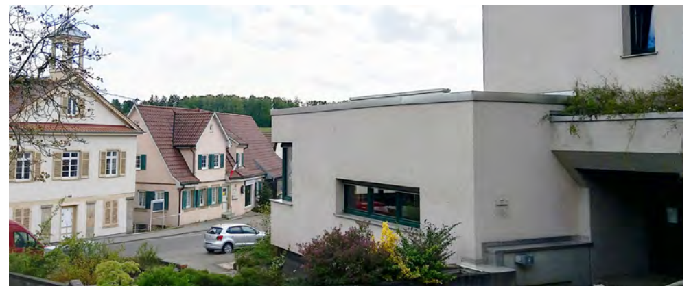
Heutiger Blick auf Filderstraße durch Gemeindehaus verstellt
