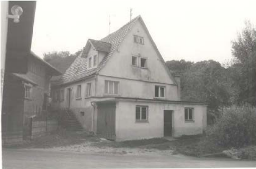
Abb. 51 Objekt: Kirchhofweg 13, ehem. Wohnstallhaus
