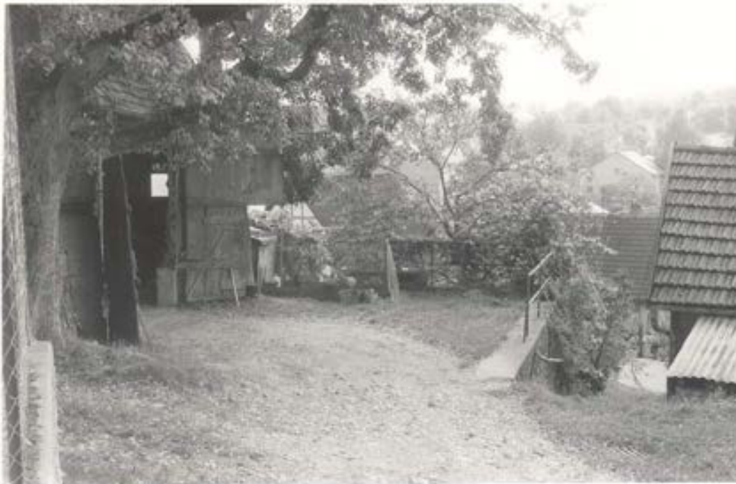
Abb. 29 Objekt: westlicher Vorplatz vor der ehem. Zehnscheuer Status: erhaltenswert
