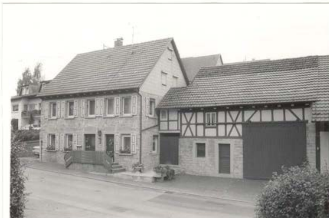
Abb. 60 Objekt: Krautheimer Str. 52, Wohn- und Geschäftshaus Status: erhaltenswert
