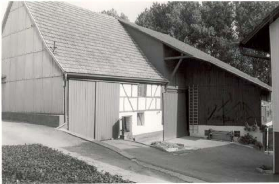
Abb. 31 Objekt: Römerweg 9, Scheune
