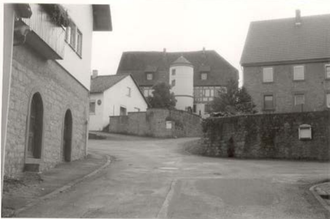
Abb. 14 Objekt: Götzgasse, Blick von Nordosten in das Schloßareal
