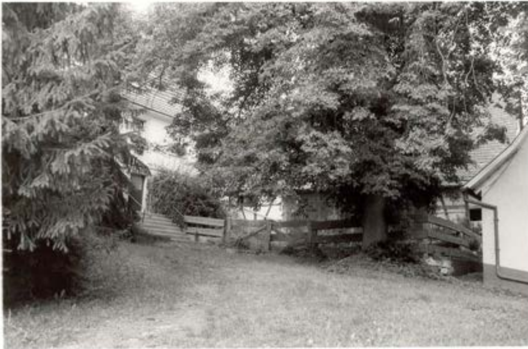
Abb. 39 Objekt: Am Berg 32, unversiegelte Hofstelle
