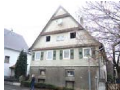
Ansicht des Gebäudes von Süden
