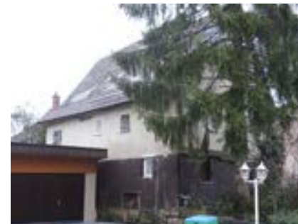
Ansicht des Gebäudes von Südwesten
