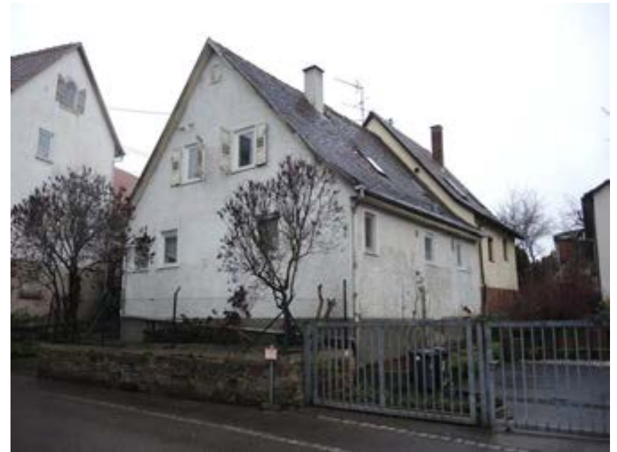
Ansicht des Wohnhauses von Nordosten
