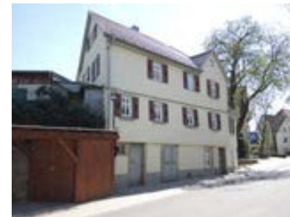
Ansicht des Gebäudes von Nordwesten
