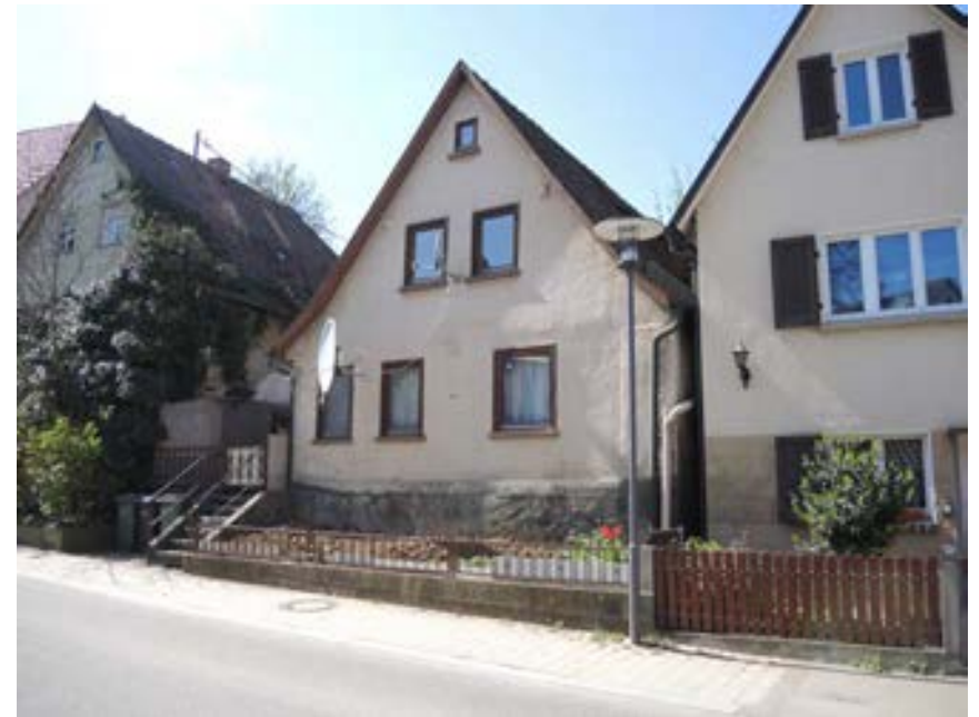
Ansicht des Wohnhauses von Nordosten
