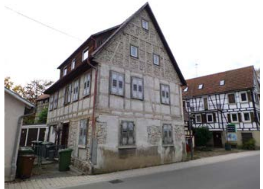
Ansicht des Wohnhauses von Nordosten
