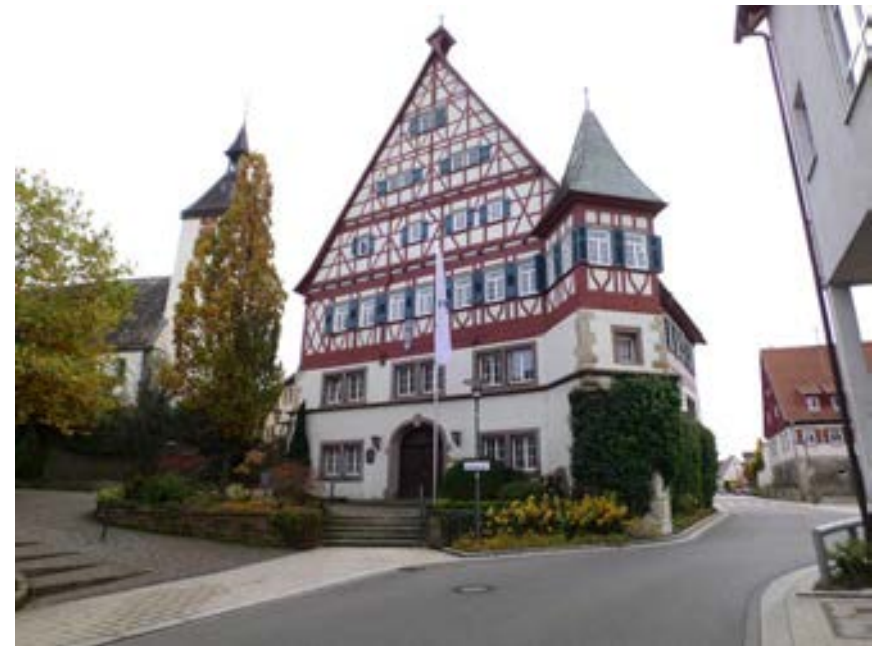
Ansicht des Rathauses von Norden
