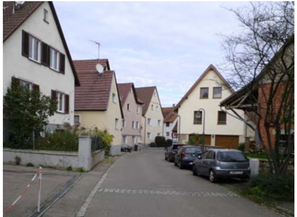
Abb. 6 - Das innere Erscheinungsbild von Münchingen wird durch giebelständige, zweigeschossige, zumeist verputzte Fachwerk-Wohnhäuser mit Satteldach bestimmt (2013)
