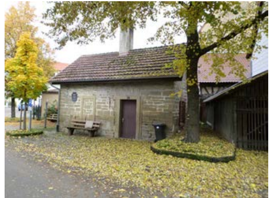
Ansicht des Backhauses von Westen
