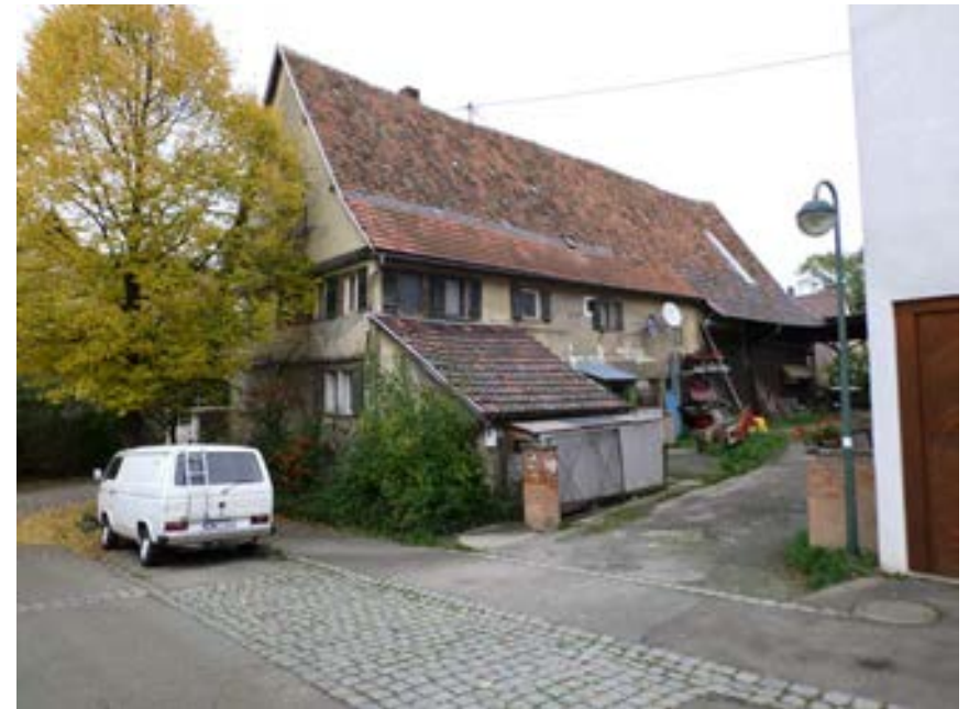
Ansicht des Einhauses von Südwesten
