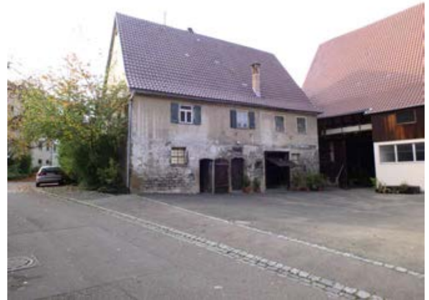
Ansicht des Wohnstallhauses von Südosten
