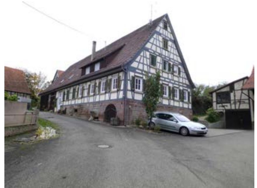
Ansicht der Hofanlage mit Wohnhaus und Scheunen von Nordosten
