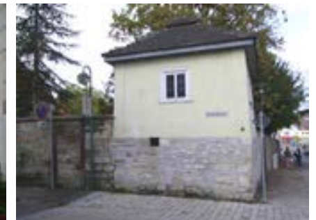
Ansicht des Gartenhauses von Süden
