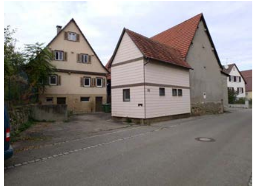
Ansicht der Hofanlage mit Wohnhaus und Scheune von Südosten
