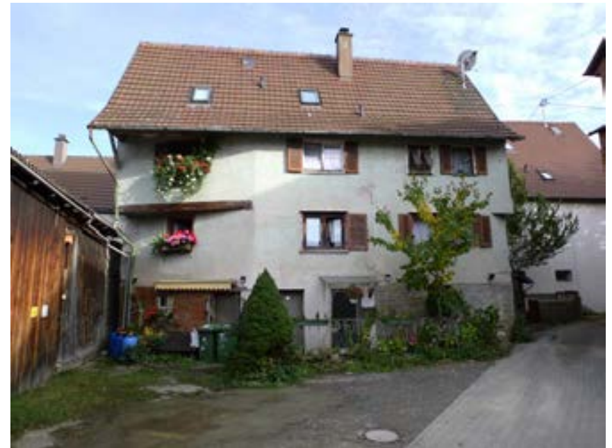
Ansicht des Wohnhauses von Westen
