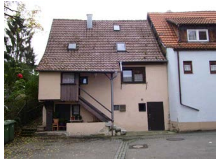
Ansicht des Wohnstallhauses von Norden
