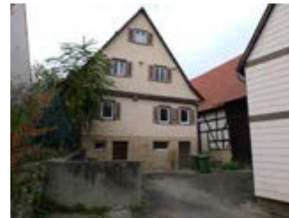
Ansicht des Wohnhaus von Südosten
