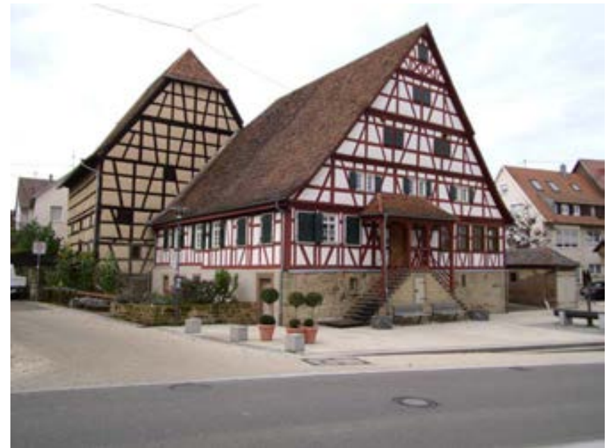
Ansicht des ehemaligen Gasthofes von Südosten
