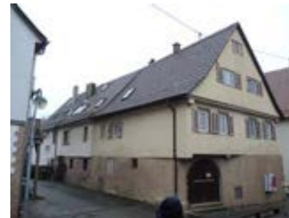
Ansicht des Gebäudes von Südwesten
