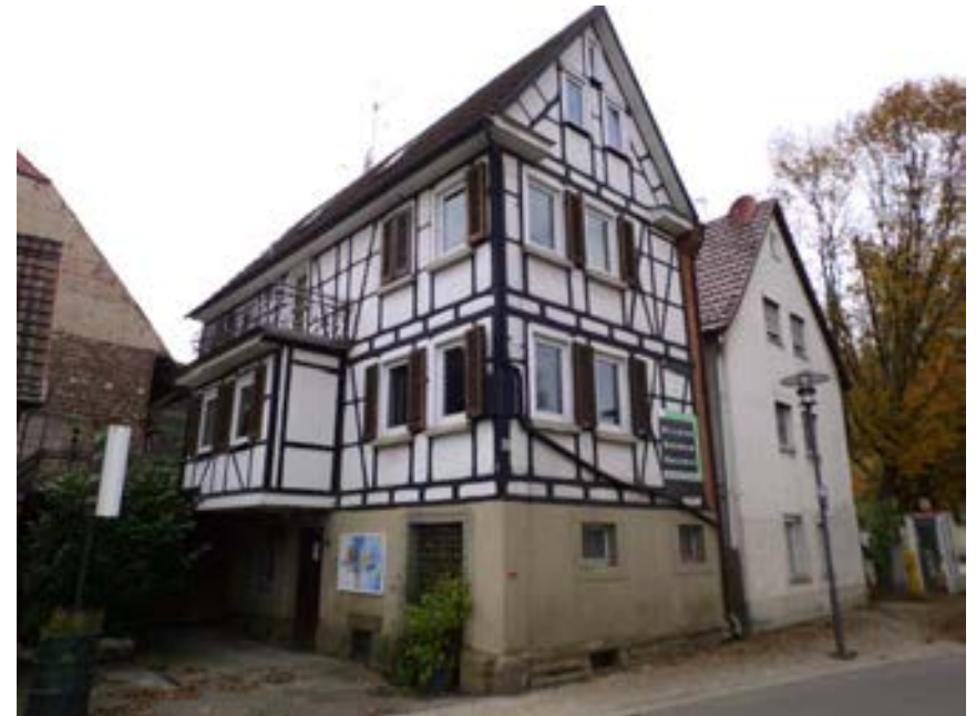
Ansicht des Wohnhauses von Nordosten
