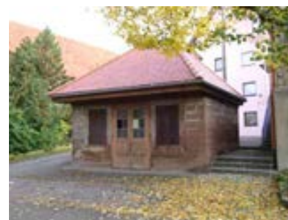
Ansicht des Backhauses von Nordwesten
