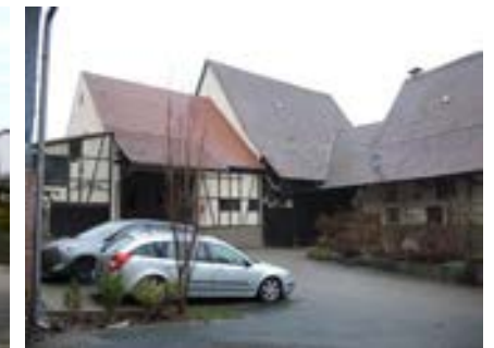
Ansicht der Scheune von Südosten
