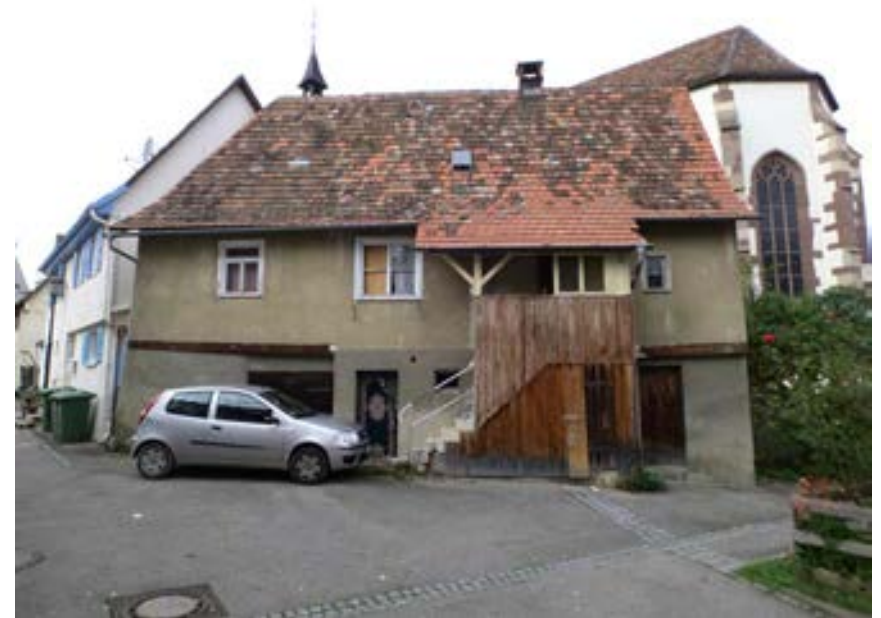
Ansicht des Wohnstallhauses von Südosten
