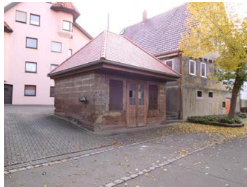
Ansicht des Backhauses von Nordosten
