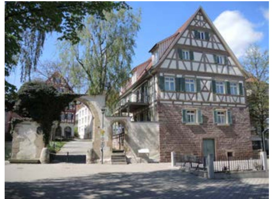
Ansicht der Hofanlage mit Wohnhaus, Nebengebäuden und Hoftor von Osten
