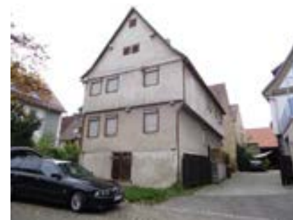
Ansicht des Wohnhaus von Nordosten
