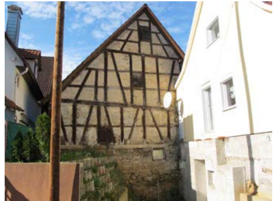
Ansicht des Fachwerkgiebels der Scheune von Osten
