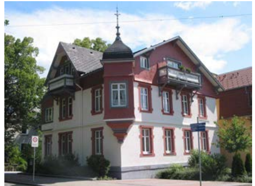
Ansicht des Gebäudes von Südwesten
