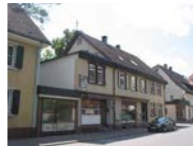
Ansicht des Gebäudes von Nordwesten
