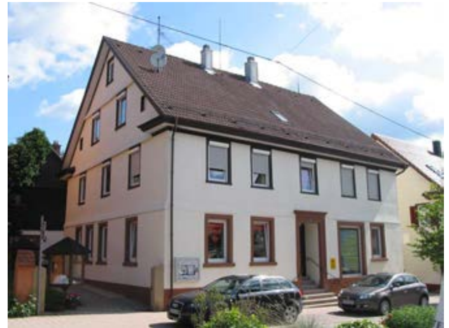
Ansicht des Gebäudes von Südwesten
