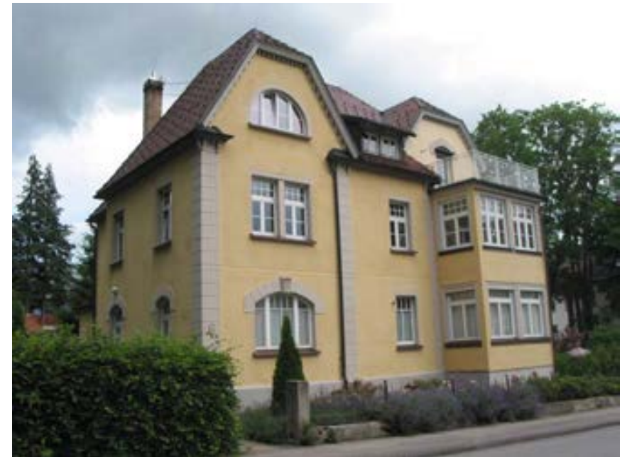
Ansicht des Gebäudes von Südwesten
