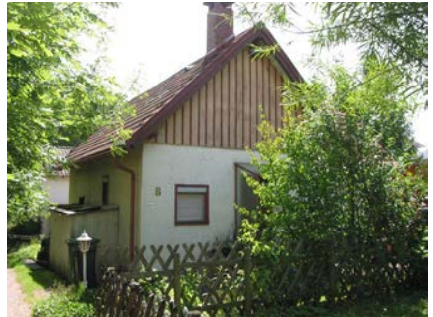
Ansicht des Gebäudes von Nordwesten
