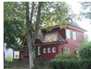
Ansicht des Gebäudes von Nordwesten
