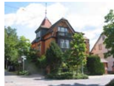
Ansicht des Gebäudes von Südwesten
