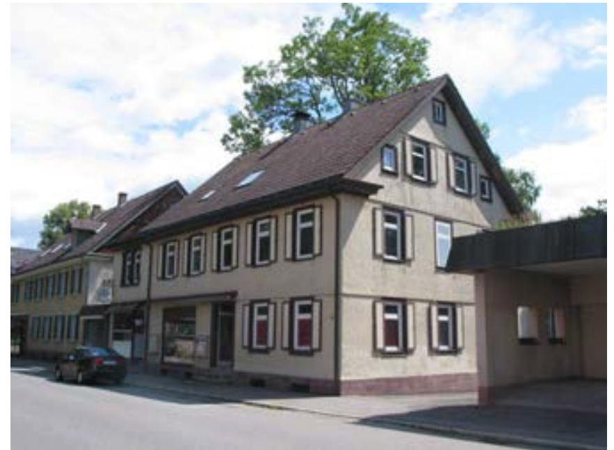
Ansicht des Gebäudes von Südwesten
