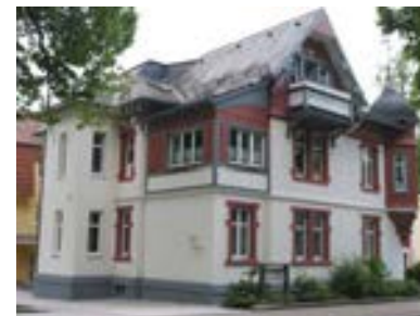
Ansicht des Gebäudes von Nordwesten
