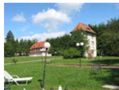
Ansicht der Gebäude 3 und 5 von Südosten
