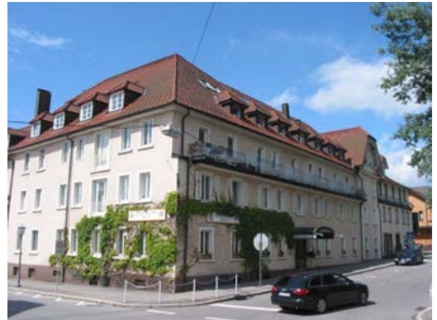
Ansicht des Gasthofes von Nordosten
