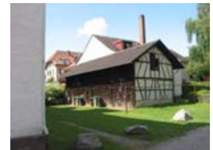
Ansicht des Nebengebäudes von Nordosten
