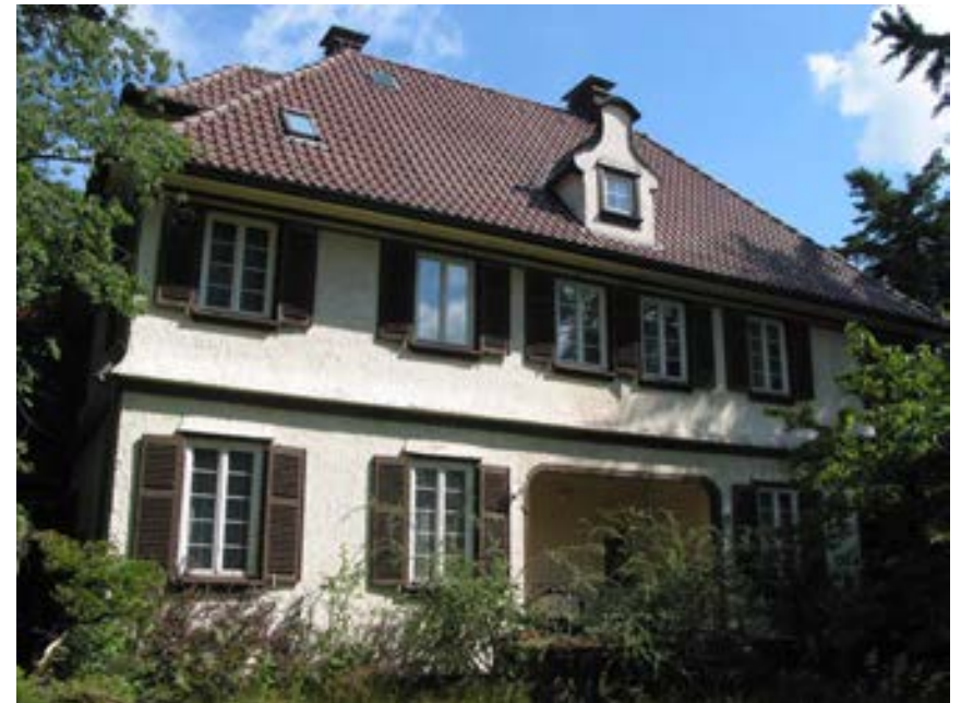
Ansicht des Gebäudes von Südwesten
