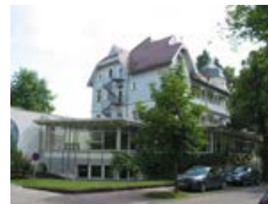
Ansicht des Gebäudes von Südwesten
