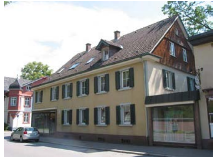
Ansicht des Gebäudes von Südwesten
