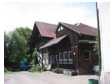
Ansicht der rückwärtigen Werkstatt
