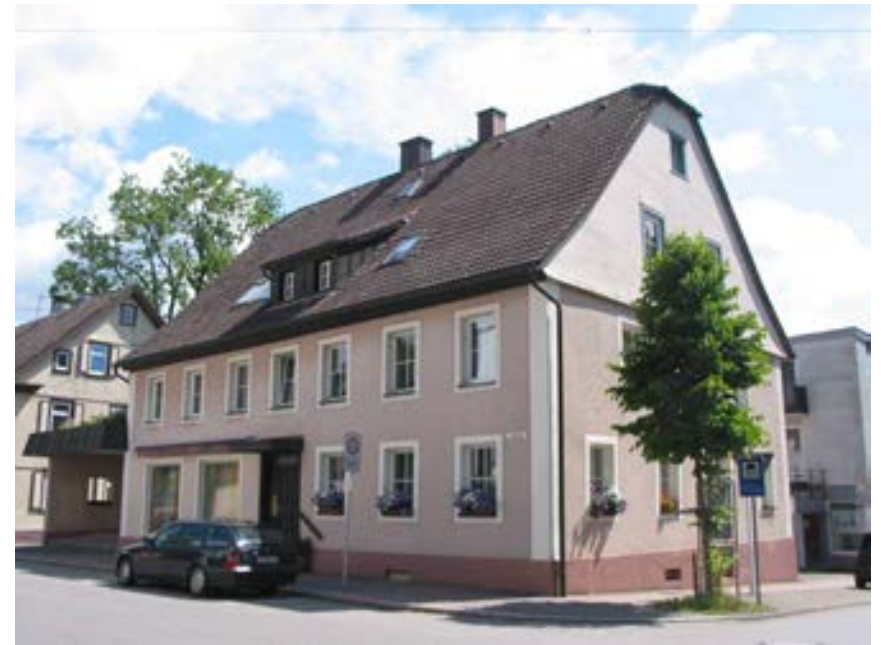
Ansicht des Gebäudes von Südwesten
