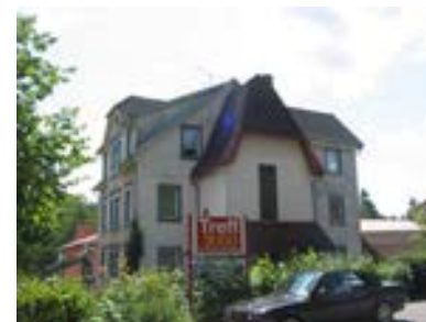
Ansicht des Gebäudes von Nordwesten
