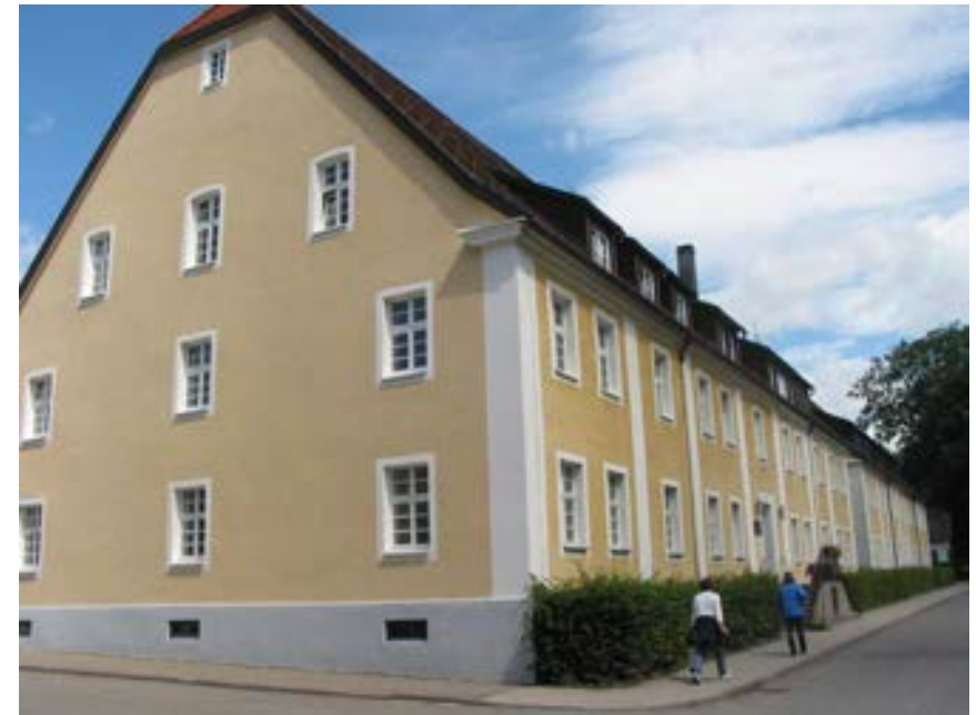
Ansicht des Gebäudes von Südosten
