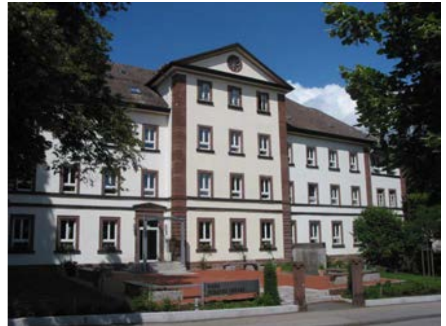
Ansicht des Gebäudes von Südwesten
