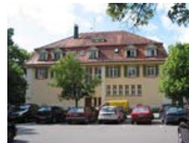
Ansicht des Gebäudes von Norden
