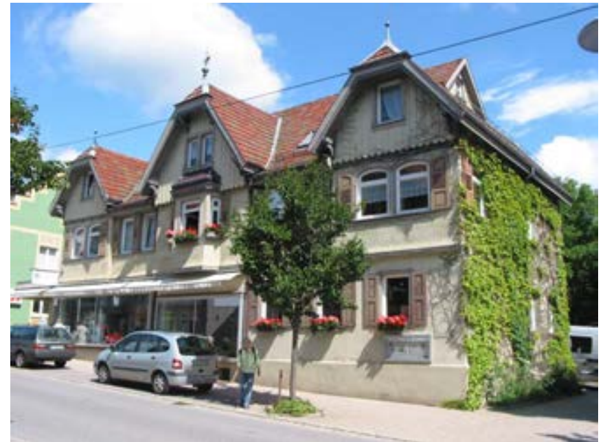
Ansicht des Gebäudes von Südosten
