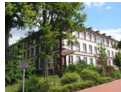
Ansicht des Gebäudes von Südwesten
