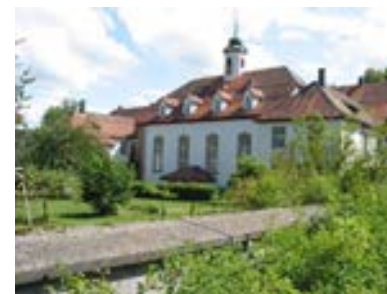
Ansicht der Kirche mit Garten von Nordwesten
