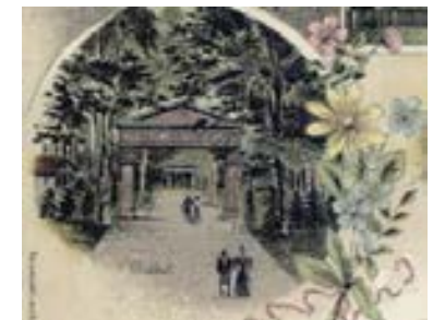
Ansicht des Friedhofeingangs 1908
