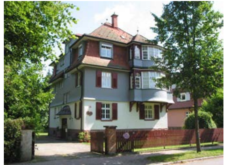
Ansicht des Gebäudes von Südwesten
