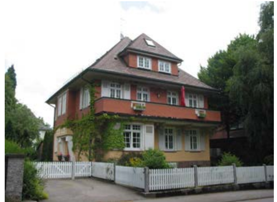
Ansicht des Gebäudes von Südwesten
