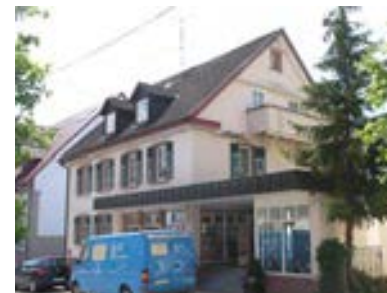
Ansicht des Gebäudes von Nordwesten
