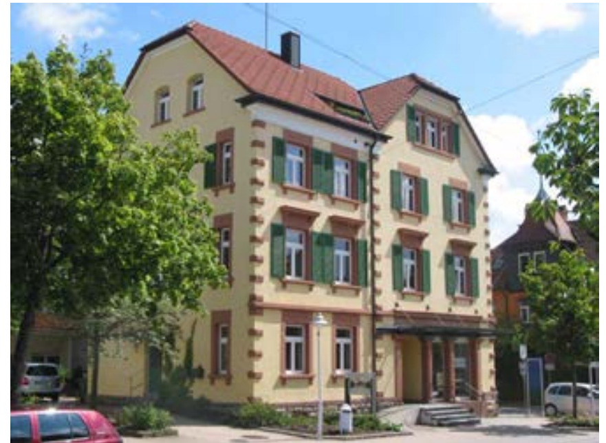
Ansicht des Gebäudes von Südwesten
