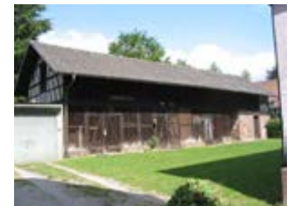
Ansicht des Nebengebäudes von Südosten
