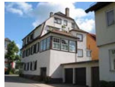
Ansicht des Gebäudes von Südwesten
