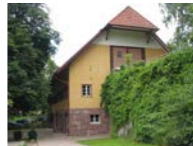
Ansicht des Hörnlishofs von Nordosten
