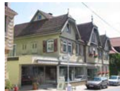
Ansicht des Gebäudes von Südwesten
