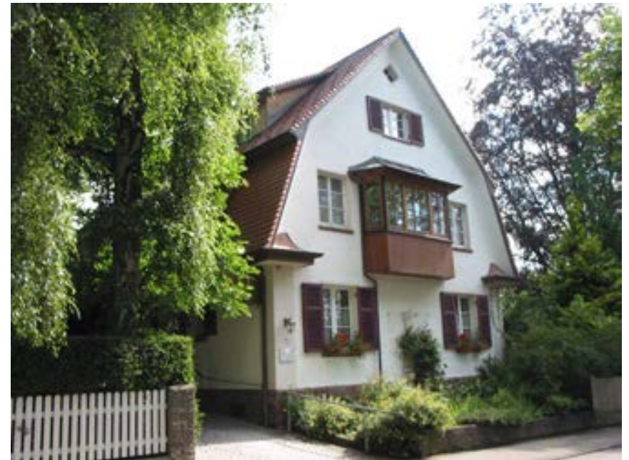
Ansicht des Gebäudes von Südwesten
