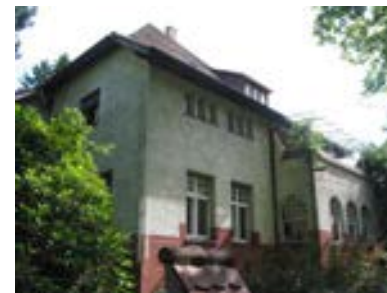
Ansicht des Gebäudes von Südwesten
