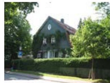
Ansicht des Gebäudes von Nordwesten
