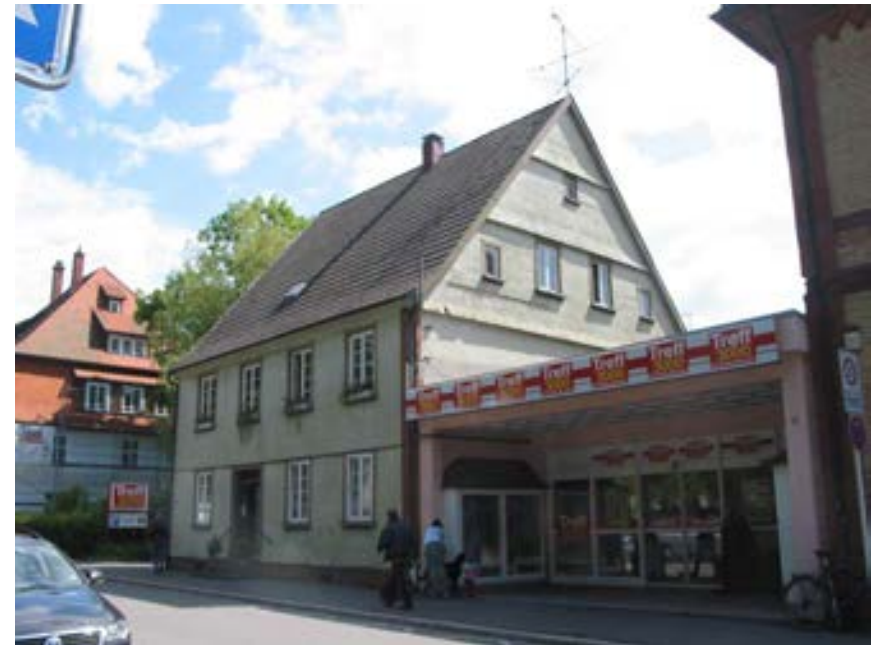
Ansicht des Gebäudes von Südwesten
