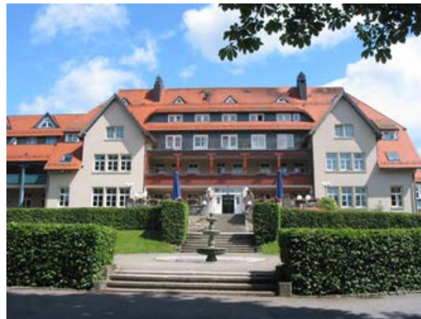
Ansicht des Haupthauses Nr. 1 von Süden
