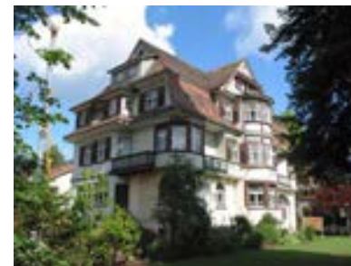
Ansicht des Gebäudes von Südosten
