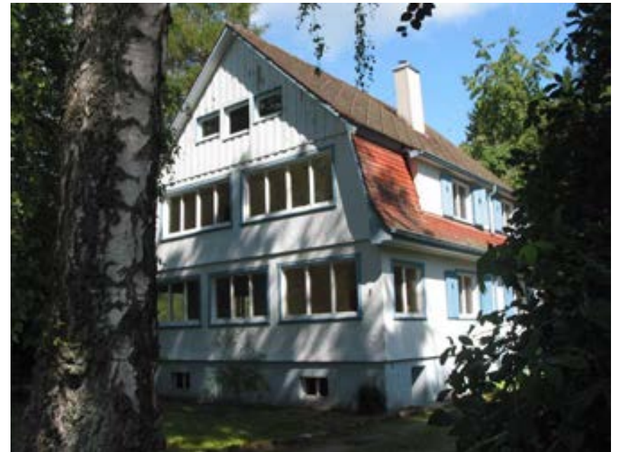
Ansicht des Gebäudes von Südosten
