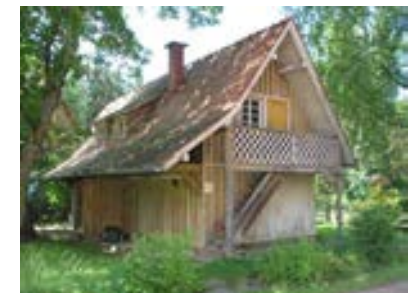
Ansicht des Nebengebäudes von Südosten
