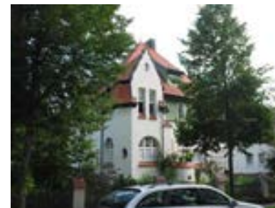
Ansicht des Gebäudes von Südwesten
