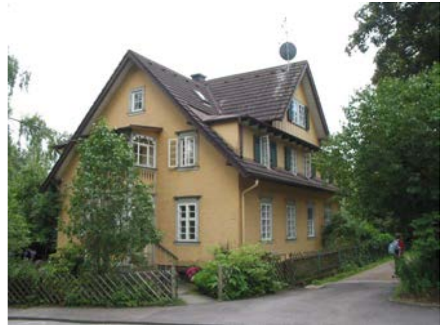
Ansicht des Gebäudes von Nordwesten
