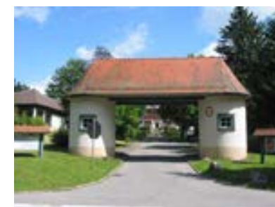
Ansicht der Pforte von Süden
