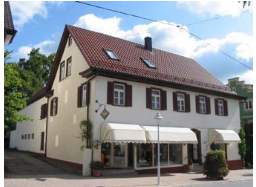
Ansicht des Gebäudes von Südwesten
