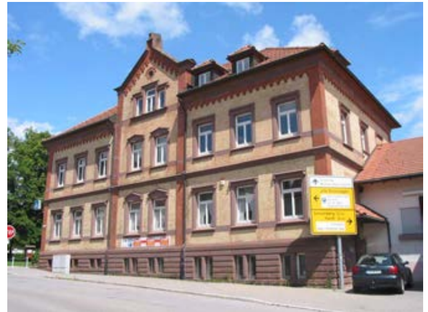
Ansicht der Handlung von Südosten
