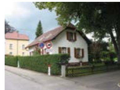
Ansicht von Hausnr. 4 von Südwesten
