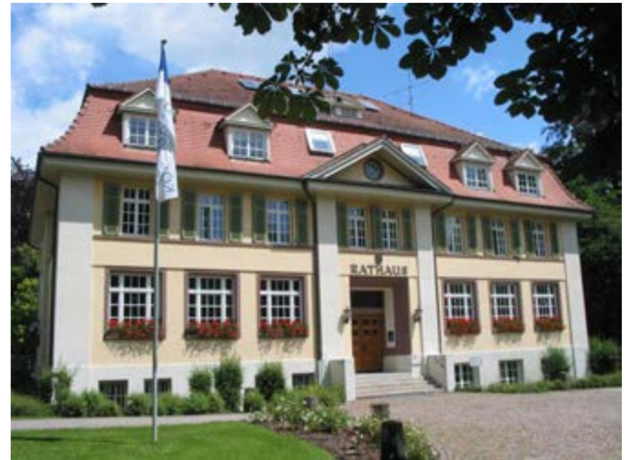
Ansicht des Gebäudes von Südwesten
