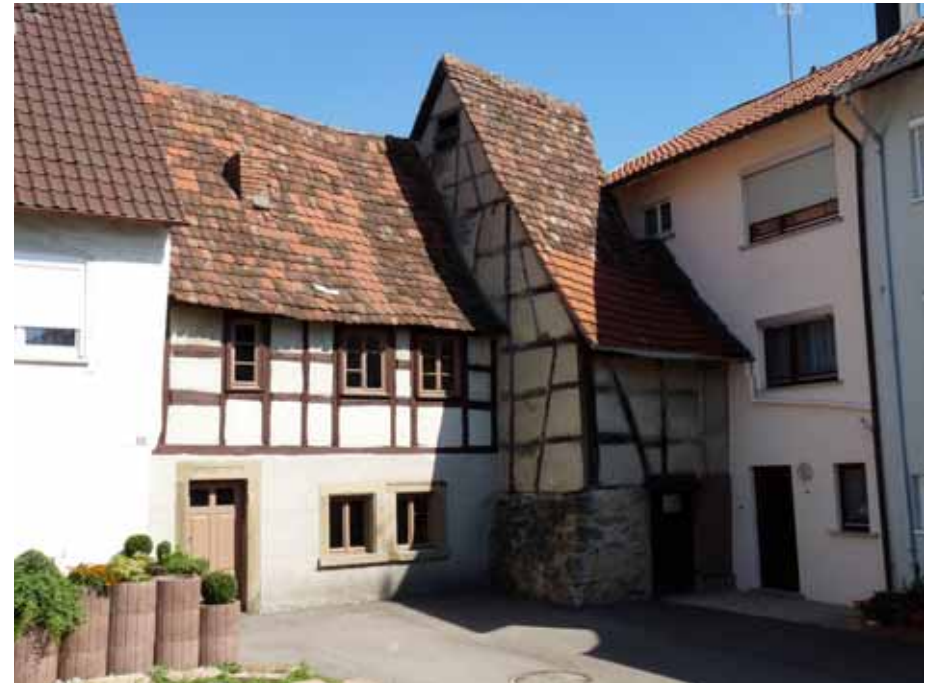
Ansicht von Westen (Nr. 37 links, Nr. 41-2 rechts)
