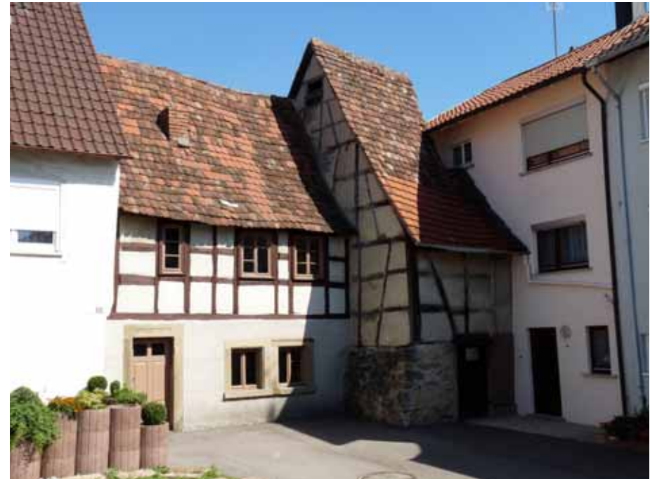
Ansicht von Westen (Nr. 37 links, Nr. 41-2 rechts)
