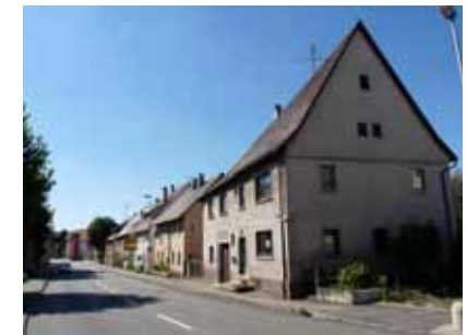
Blick nach Südwesten
