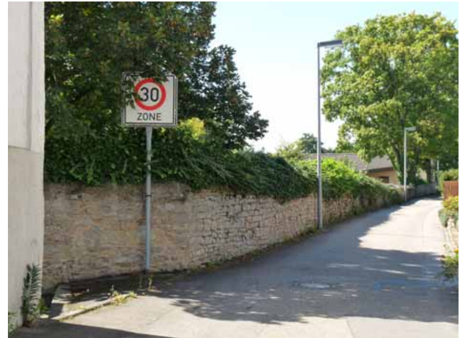
Mauerabschnitt an der Friedhofstraße
