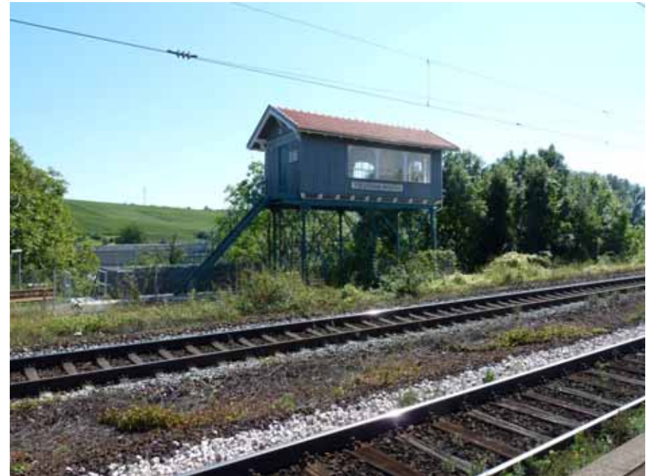
Ansicht des Bahngebäudes
