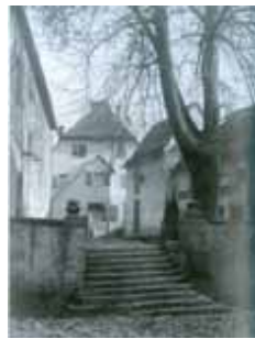
Ehem. Bebauung südlich der Kirche (historisches Foto)
