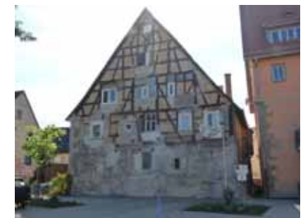
Ansicht von Nordosten
