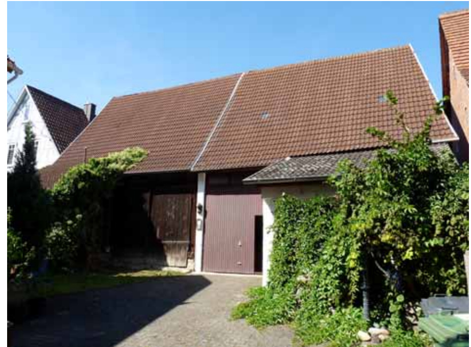
Gesamtansicht Nr. 13 (li.) und 15 (re.) von Süden
