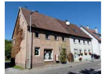
Besigheimer Straße 12 (re.) und 14 (li.) von Südwesten
