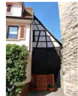
Detail Einfahrt im Süden
