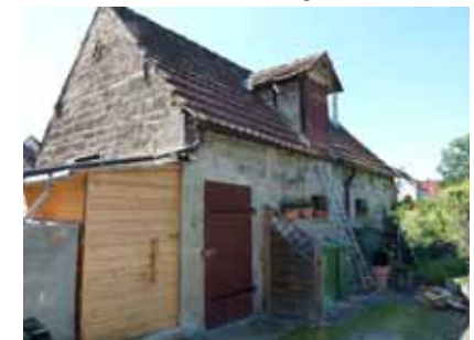
Besigheimer Straße 16 Nebengebäude
