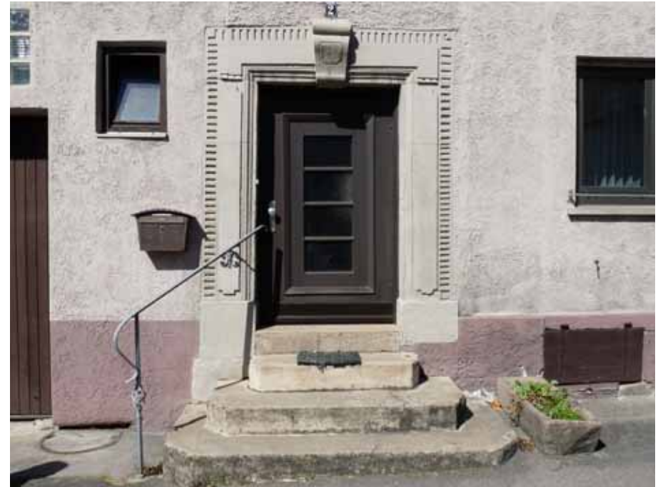
Detail der Eingangstür
