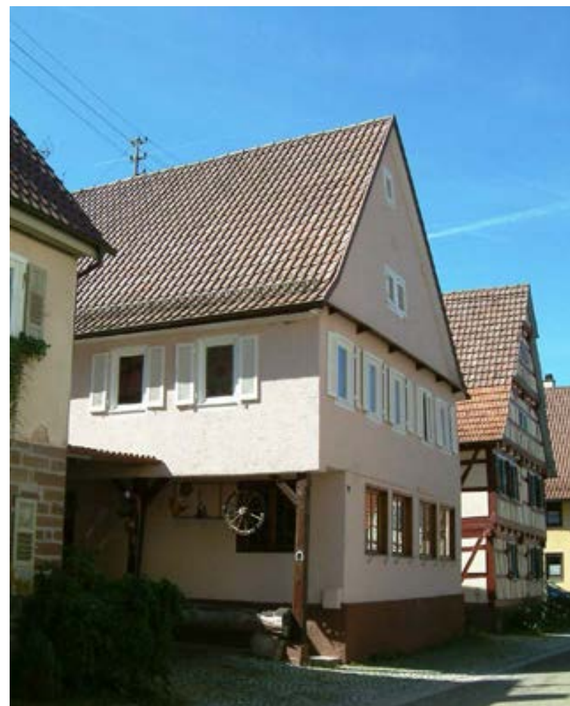
Ansicht Wohnhaus von Nordosten heute ↑ und 1973 ←
