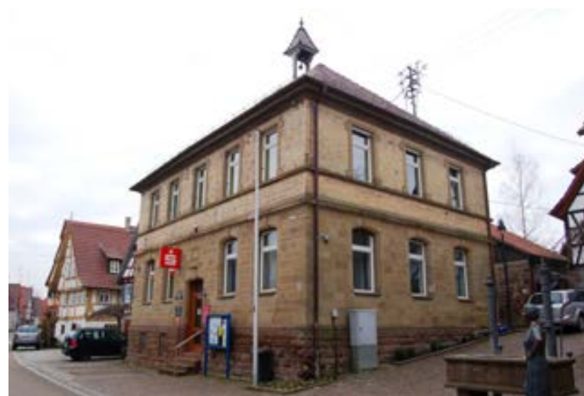
Ehemaliges Rathaus und Back- haus (rechts) von Nordwesten heute ↑
