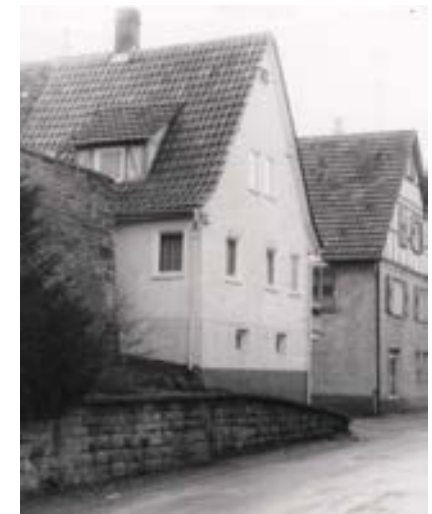
Ansicht Vorderhaus von Nordosten 1973 (links Kirchhofmauer) →
