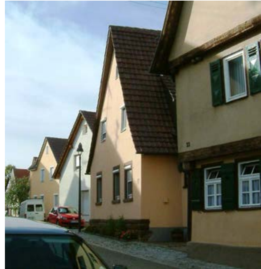
Ansicht von Südosten heute ↑
