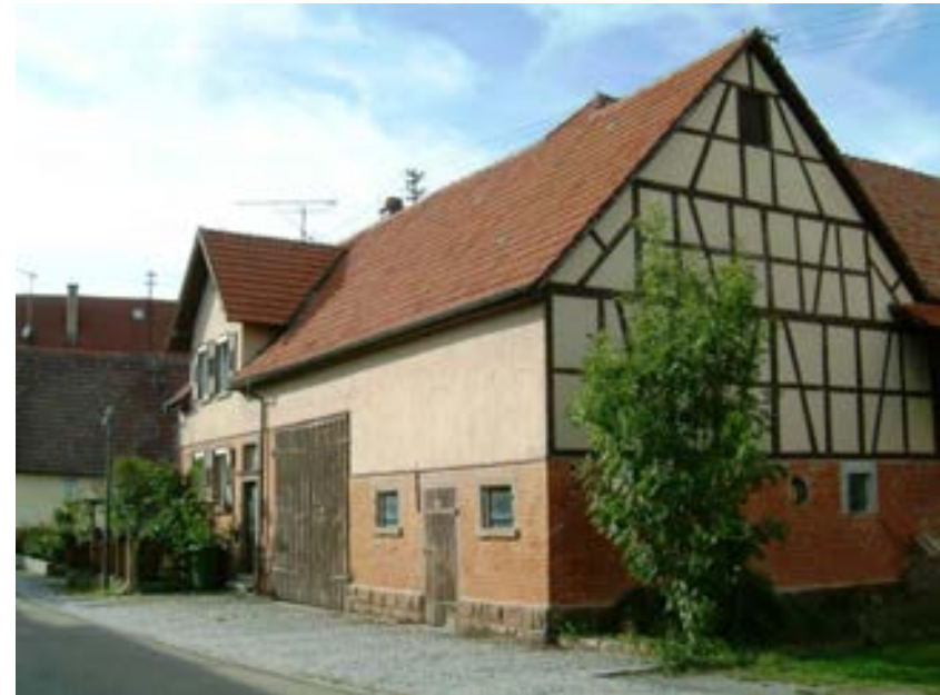
Ansicht von Südosten heute ↑
