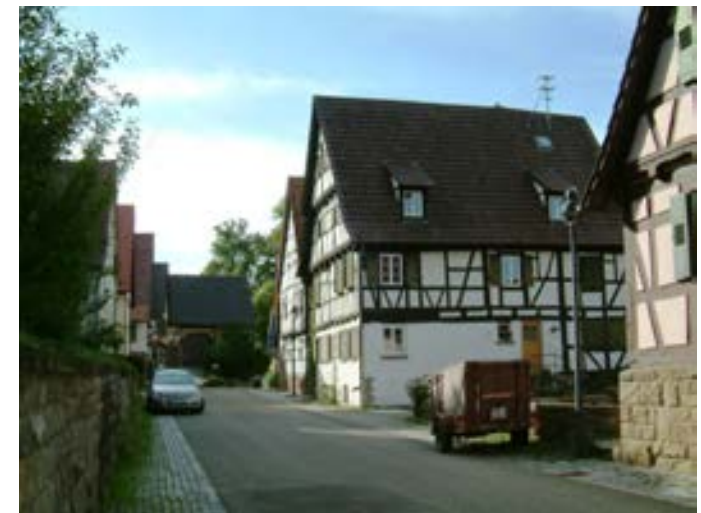
Ansicht Hofanlage von Südosten heute ↑
