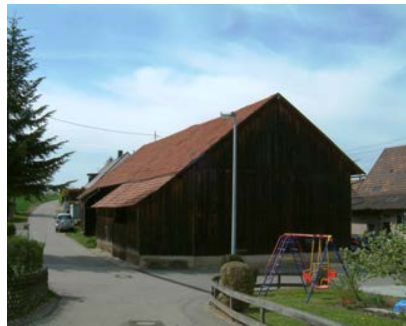
Ansicht von Südosten heute ↑
