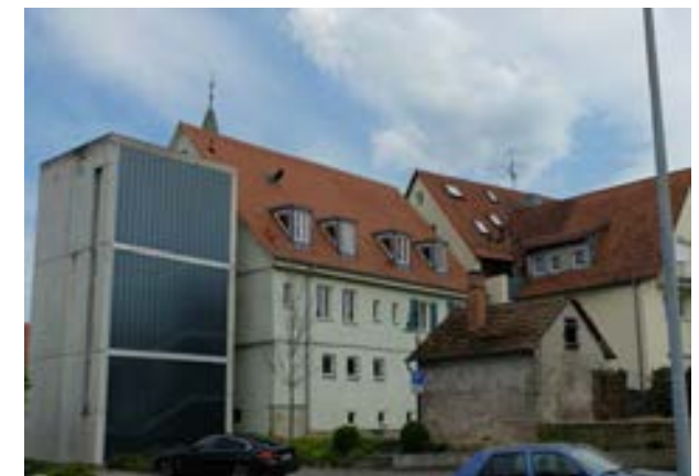
Ehemaliges Försterhaus - Westfassade
