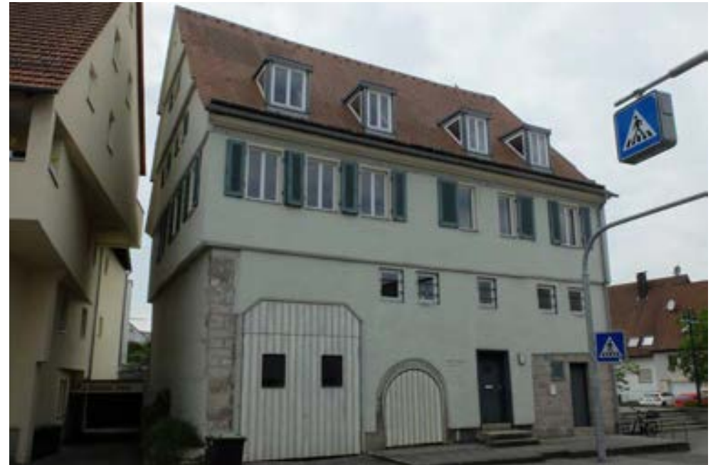
Ehemaliges Försterhaus - Ostfassade
