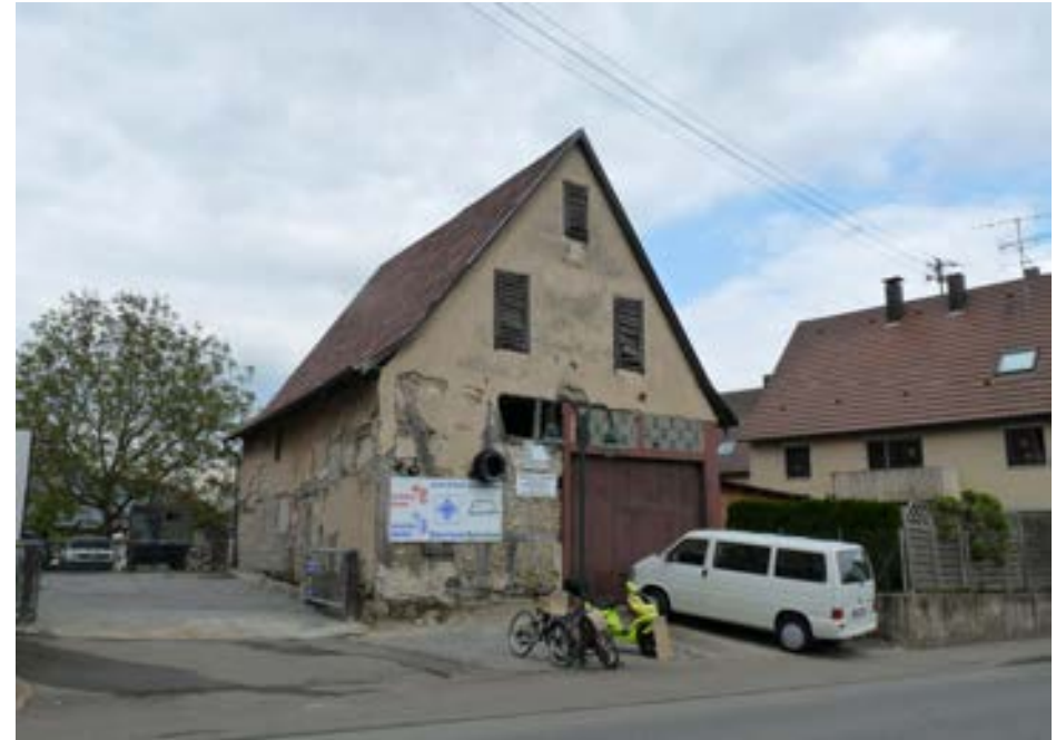
Scheune, Blick von Süden
