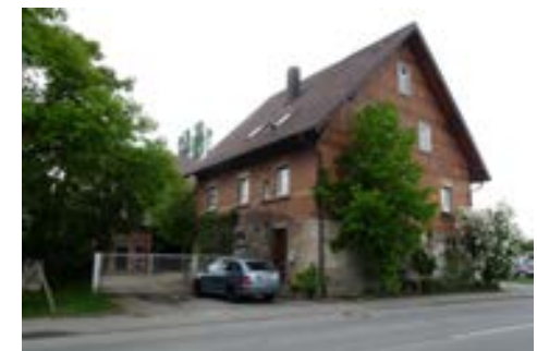
Ansicht von Nordosten
