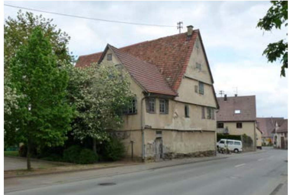
Kuppinger Straße 8 mit Ausgeding, Blick nach Osten
