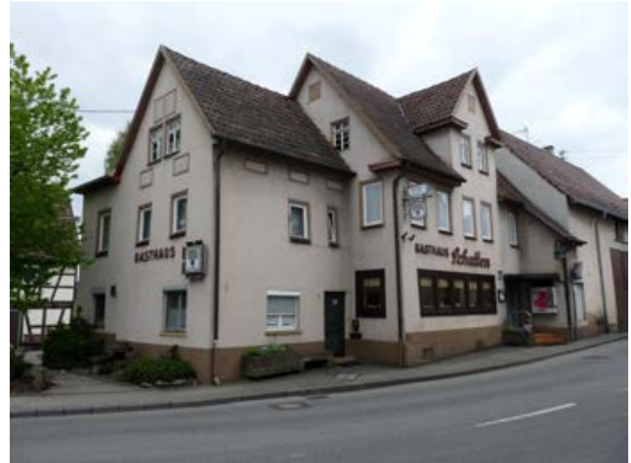
Ansicht von Nordosten
