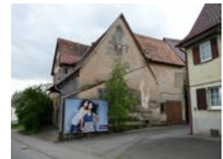
Ansicht von Nordosten
