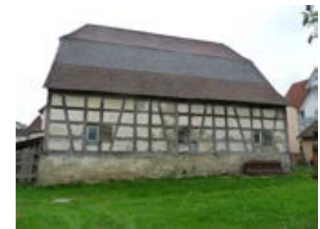
Ansicht von Norden Norden
