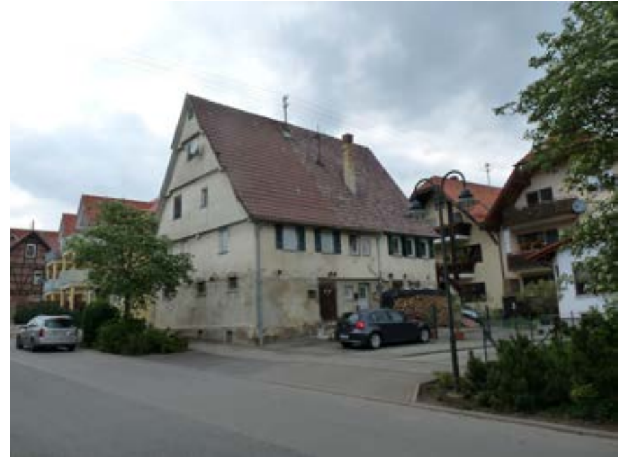
Conrad-Weiser-Straße 11, Blick von Süd-Osten
