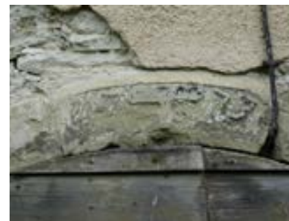
Türsturzdetail des Kellereingangs
