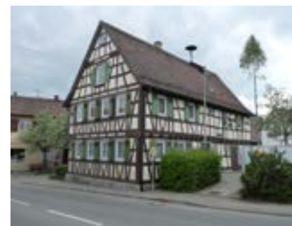
Ansicht von Nordosten
